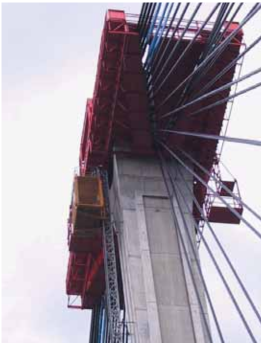
Photo 9 Passerelle tête de pylône en place Tower-head foot bridge in place
