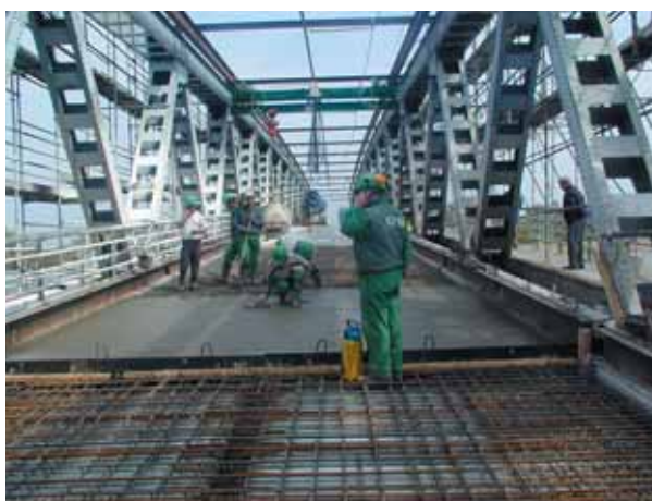
Photo 7 Le bétonnage se fait à l'aide du pont roulant. Le ferrailage est essentiellement composé de barres droites
