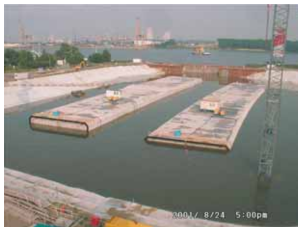
Mise en flottaison Putting afloat
