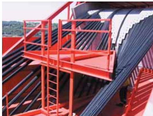
Photo 1 L'ouvrage en travaux : deux ateliers d'enfilage sur le tablier, capotes bleues de protection lors des injections de cire pétrolière The structure during the works : two jacking plants on the deck, blue protective coats during injection of paraffin wax
