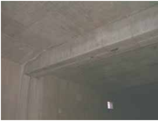
Photo 10 Poutre de retombée Downstand beam
