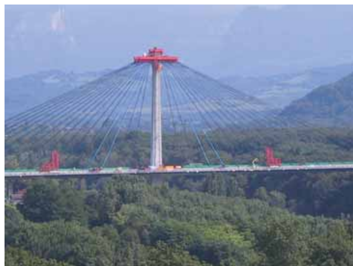
Photo 1 L'ouvrage en travaux : deux ateliers d'enfilage sur le tablier, capotes bleues de protection lors des injections de cire pétrolière The structure during the works : two jacking plants on the deck, blue protective coats during injection of paraffin wax
