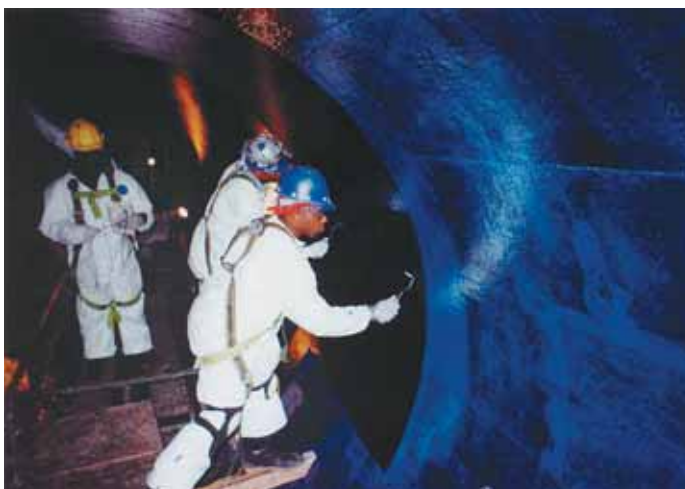
Exemple 2 Revêtement composite en fibre de carbone pour réparer un collecteur d'eau en béton précontraint
