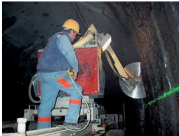
Sciage de maçonnerie à l'aide de scie auréolaire spécialement étudiée pour ce type de travaux Sawing masonry with a ring saw specially designed for this type of work
