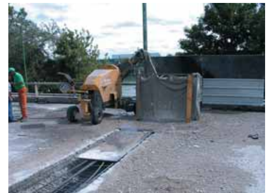
Photo 5 Robot d'hydrodémolition Hydrodemolition robot
