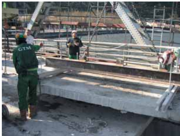
Photo 4 La trame de 10 m de la dalle (entre pièces de pont) est sciée en quatre éléments qui sont enlevés avec le pont roulant puis évacués
