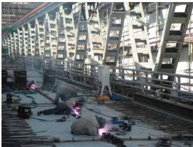
Photo 6 Les connecteurs sont soudés sur la poutraison métallique après la pose du coffrage perdu et des éléments de rive préfabriqués
