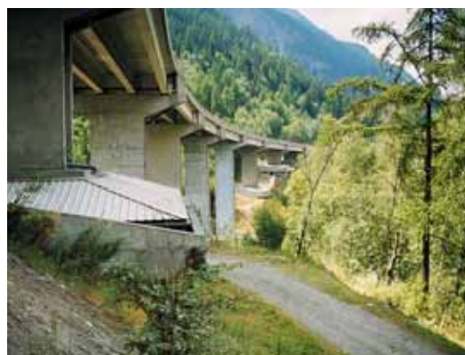
Vue des piles du viaduc View of the viaduct piers
