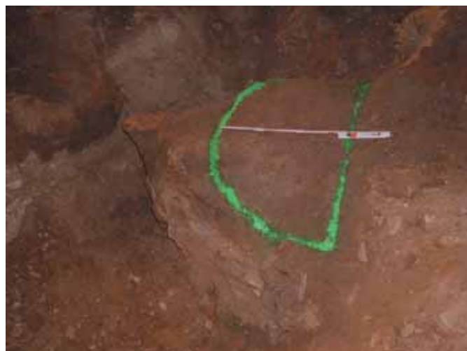
Demi-colonne d'essai dégarnie Stripped test half-column
