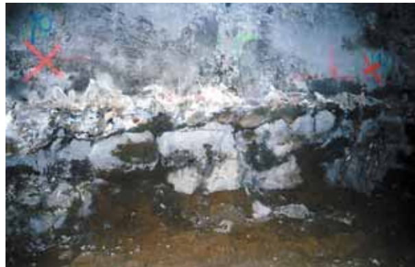
Dégarnissage de colonnes de jet grouting sous mur existant Stripping of jet grouting columns under existing wall
