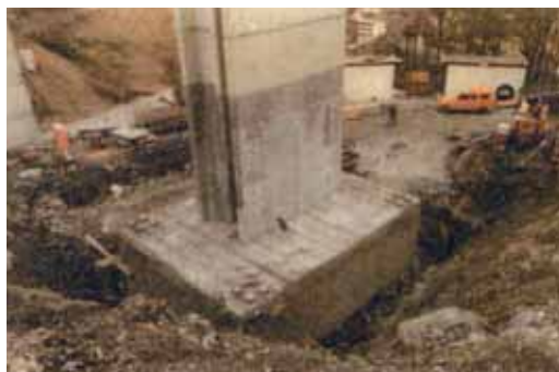
Travaux sur la pile n° 5. Dégagement de la fondation Work on pier No. 5. Clearing the foundation
