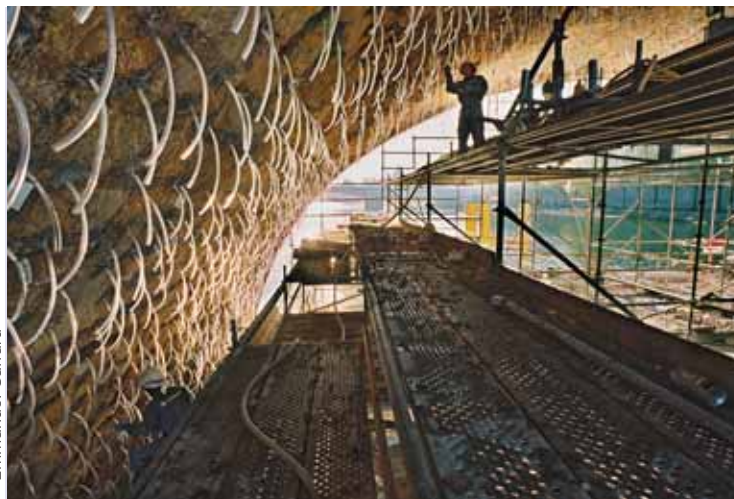
Les canules d'injection, une à l'angle de chaque pierre
