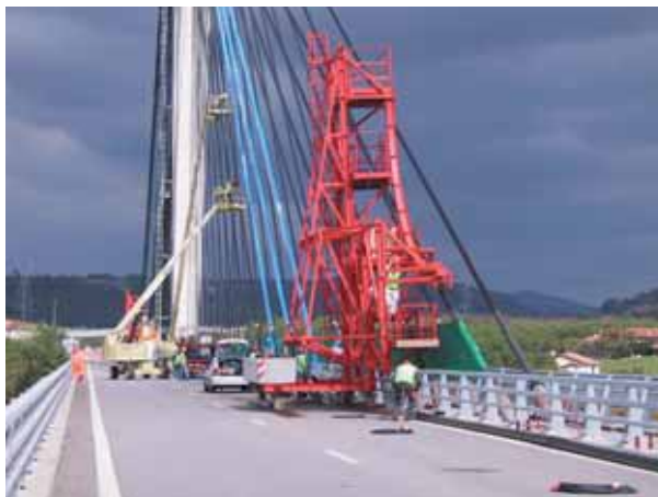
Photo 14 Vue d'ensemble de l'outil d'enfilage, avec en arrière plan des opérations d'injection Overall view of the jacketing tool, with injection moulding operations in the background
