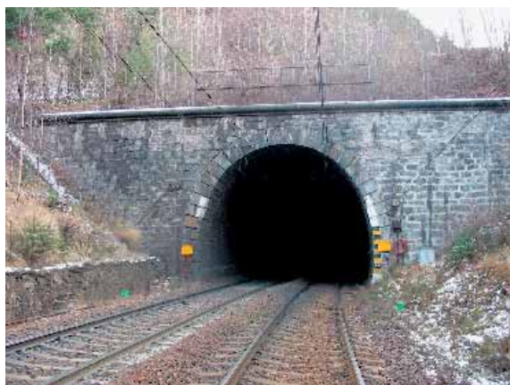
Vue de la tête de tunnel côté Modane View of the tunnel portal on the Modane side
