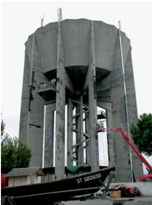
Photo 2 Vue générale et échafaudage General view and scaffolding
