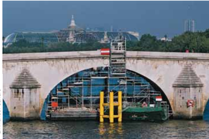
Plan rapproché sur l'installation flottante sous l'arche centrale
