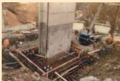
Travaux sur la pile n° 5. Ferrailage de la contre-semelle Work on pier No. 5. Reinforcing the counter-footing
