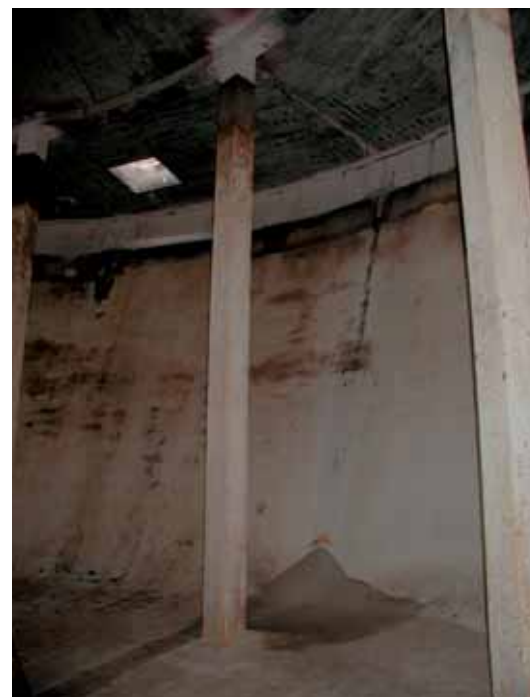
Photo 7 Intérieur de la cuve avant travaux
