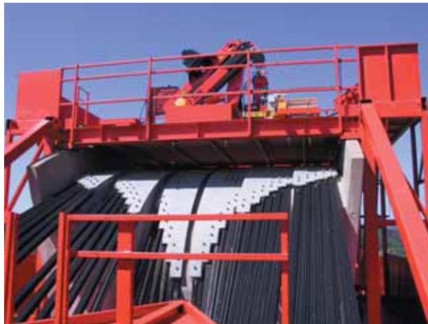
Photo 12 Podium de la passerelle tête de pylône The tower-head foot bridge podium
