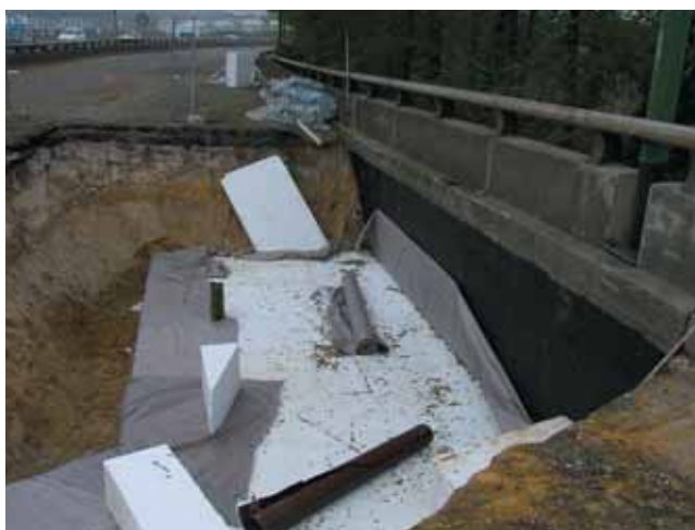
Photo 7 Remblais allégés Light-weight embankment
