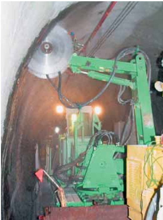
Sciage de maçonnerie à l'aide de scie auréolaire spécialement étudiée pour ce type de travaux Sawing masonry with a ring saw specially designed for this type of work
