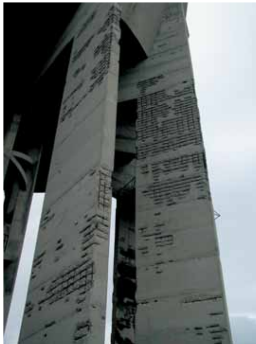
Photo 4 Repiquage des bétons Repairing concretes
