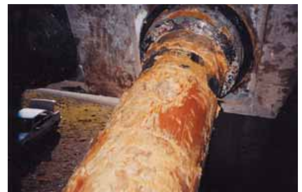
Photo 3 Aspect hétérogène de la cire dans les capots des ancrages Heterogeneous appearance of the wax in the anchorage covers
