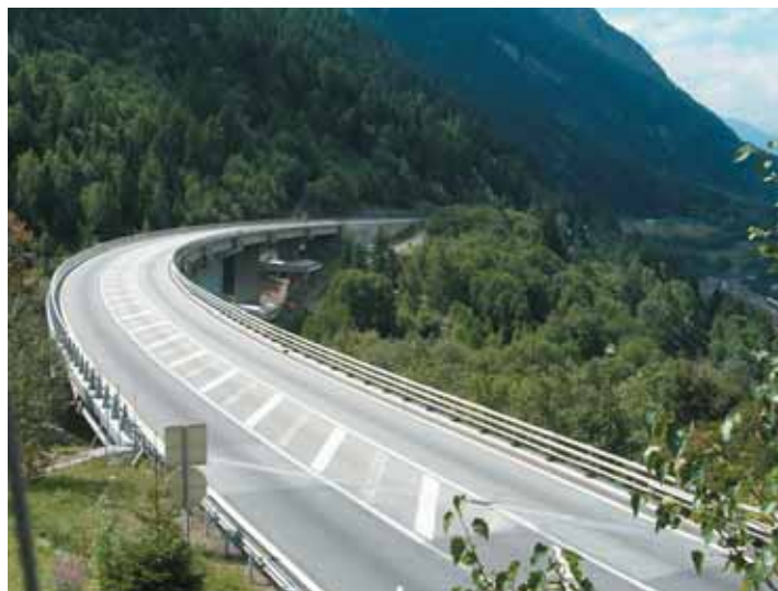
Vue générale du viaduc General view of the viaduct
