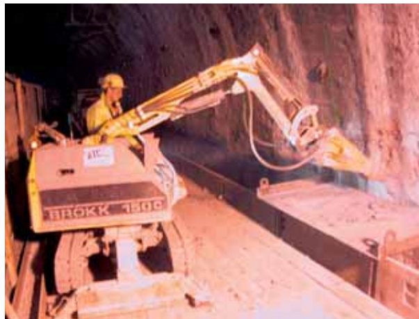
Réalisation de raidisseur à l'aide d'un engin télécommandé muni d'un BRH Construction of stiffeners using a remote controlled machine fitted with a hydraulic rock breaker
