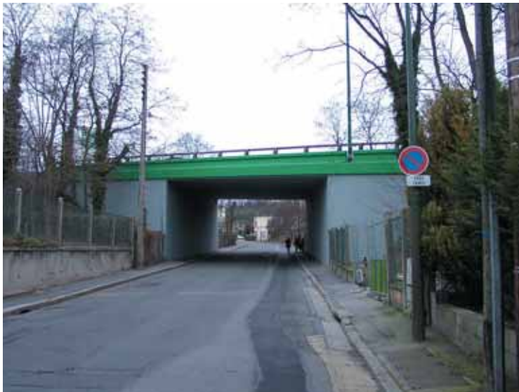
Photo 11 Le pont d'Epinay après travaux Epinay bridge after the works
