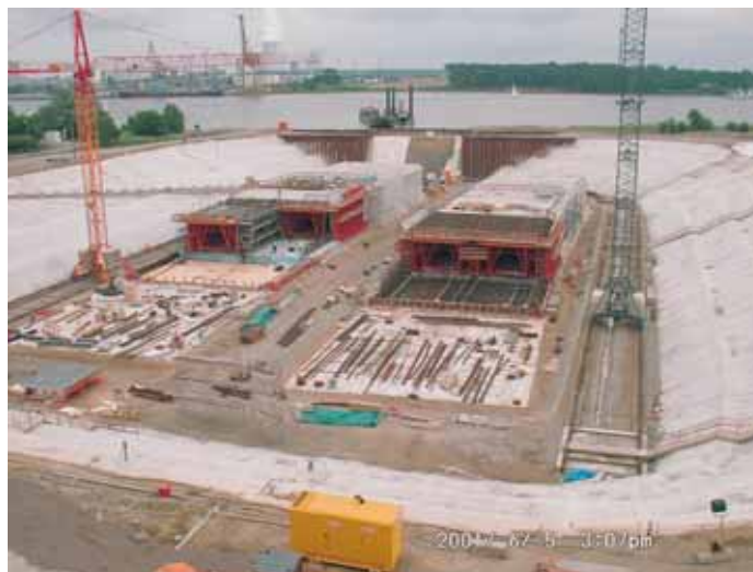
Réalisation des caissons Construction of the caissons
