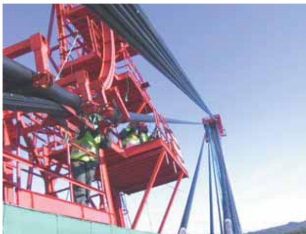
Photo 15 Enfilage des gaines : de gauche à droite, guidage et ouverture du profil PEHD, enfilage, resserrage du profil PEHD, dépolissage des surfaces à souder, pointage, fermeture du profil en soudant par extrusion Sheath jacketing : from left to right, feeding and opening the high-density polyethylene section, jacketing, tightening the HD polyethylene section, ull-grinding of surfaces to be welded, tack welding, closing the section by extrusion welding
