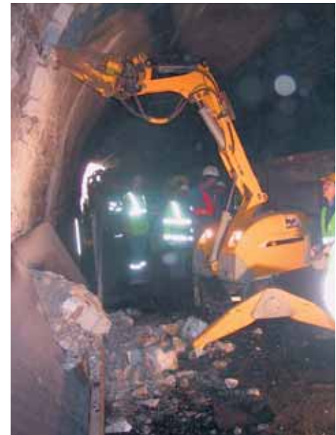
Réalisation de raidisseur à l'aide d'un engin télécommandé muni d'un BRH Construction of stiffeners using a remote controlled machine fitted with a hydraulic rock breaker
