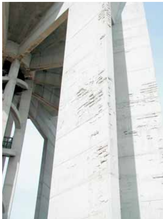
Photo 1 État initial Original condition
