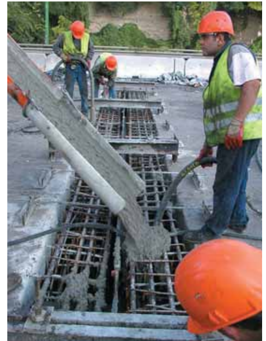
Photo 9 Bétonnage de la poutre de retombée Concreting of the downstand beam
