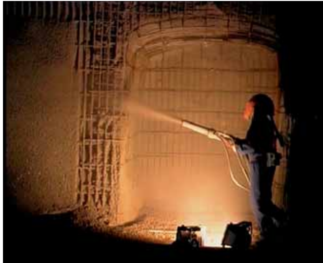
Réalisation de niches supplémentaires Construction of additional recesses
