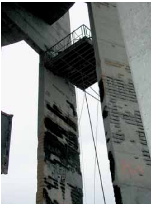
Photo 5 Traitement des aciers et ravalement Steel treatment and resurfacing
