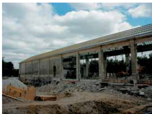
Photo 2 Ouverture des façades Opening the facades
