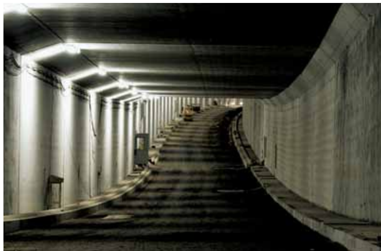
Les caissons reliés entre eux pour former la traversée sous-fluviale
