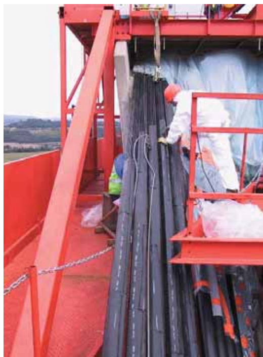
Photo 17 Mise en place des thermorétractables Installing heat-shrinkable elements
