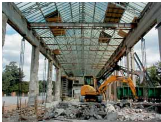
Photo 1 Démolition intérieure aile ouest Interior demolition of the western wing
