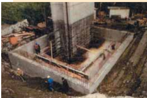
Travaux sur la pile n° 5. Ferrailage de la culasse précontrainte Work on pier No. 5. Reinforcing the prestressed abutment
