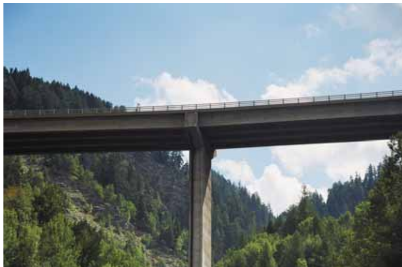
Vue du tablier du viaduc View of the viaduct deck
