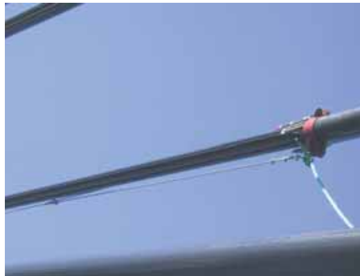
Photo 16 Système d'accrochage du tube PEHD au treuil System for attaching the HD polyethylene tube to the winch
