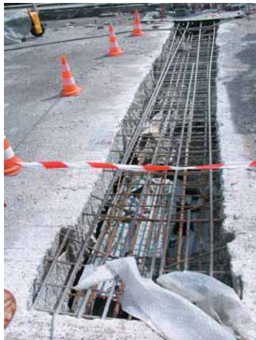
Photo 4 Résultat de l'hydrodémolition Result of hydrodemolition
