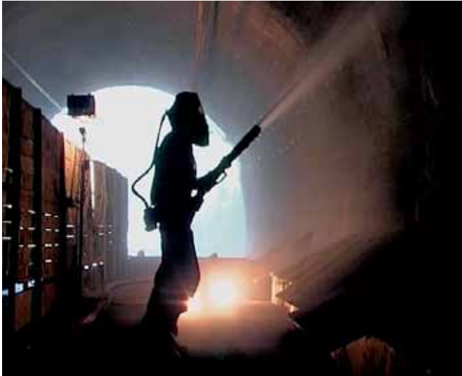
Atelier de béton projeté Shotcrete plant
