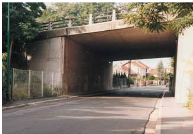
Photo 1 Le pont d'Épinay Epinay bridge
