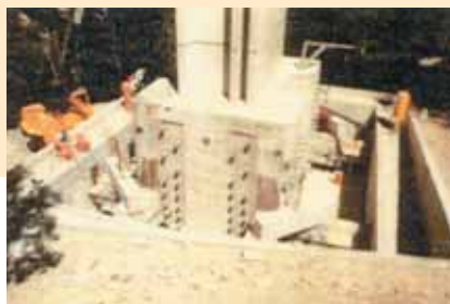
Travaux sur la pile n° 5. Culasse précontrainte Work on pier No. 5. Prestressed abutment
