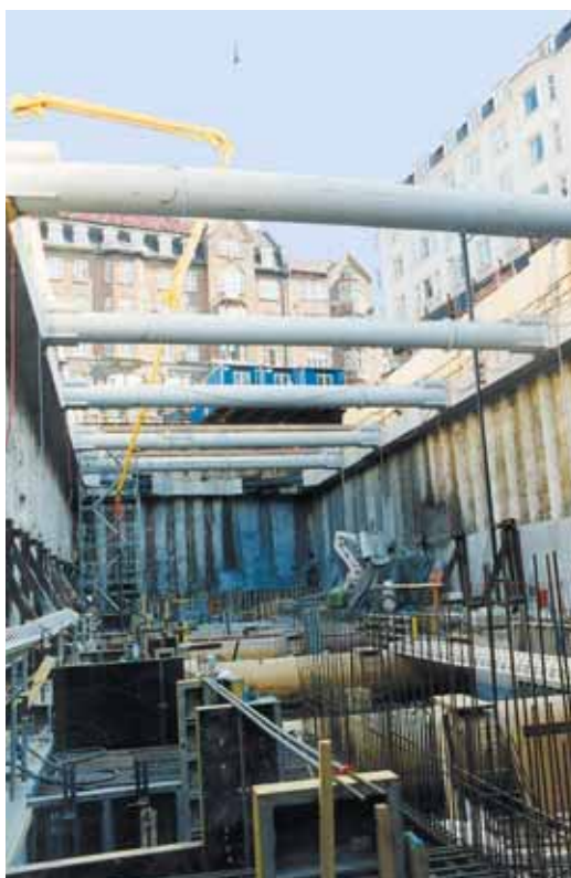
Construction de la boîte de la station Christianshavn, dont le soutènement est formé de pieux sécants butonnés
