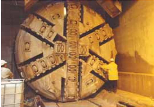
Tunnelier débouchant dans la station Kongens Nytorv
