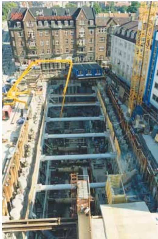
Vue de la station Christianshavn, la seule qui soit butonnée et à ciel ouvert
