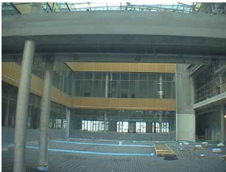
Photo 6 L'atrium depuis le portique d'entrée The atrium from the entry portico
