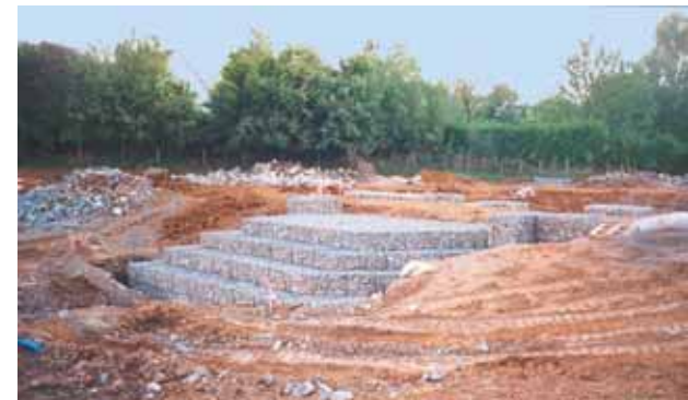
Partie amont d'un des cinq déversoirs Upstream part of one of the five weirs
