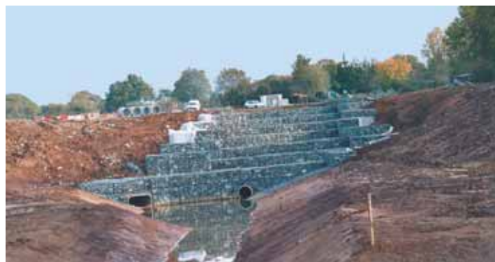
Partie aval d'un des cinq déversoirs
