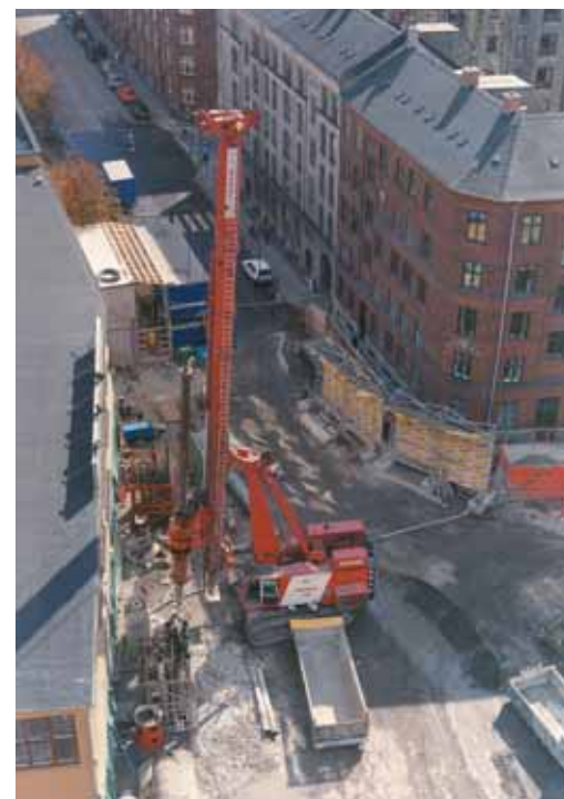
Foreuse en cours d'exécution de pieux sécants sur le chantier de la station Amagerbro
