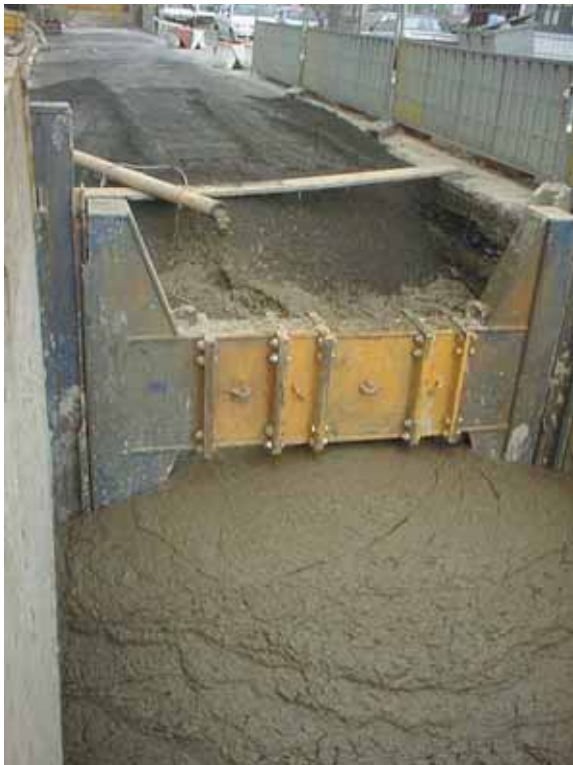
Photo 6 Remblaiement de la tranchée Trench backfilling
