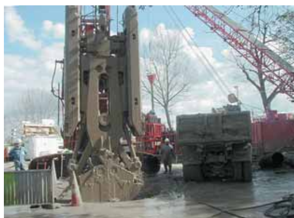
La benne KS2 au travail The KS2 bin at work
