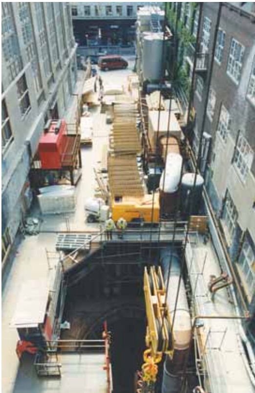
Puits elliptique à Sjaelleboderne pour accès du tunnelier, soutenu par des pieux sécants
