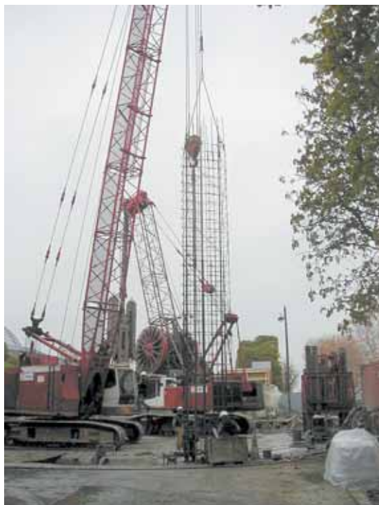
Mise en place d'une cage d'armature Installation of a concrete reinforcing cage
