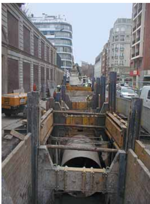
Photo 4 Vue de la tranchée View of the trench
