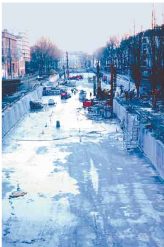
Travaux de micropieux sur le bassin des Récollets Micropile work on the Récollets Basin
