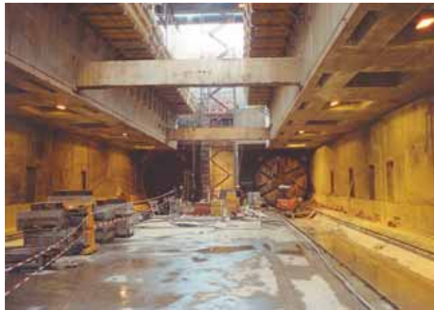
Station Norreport, radier en construction au point de transfert de tunnelier
