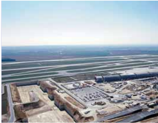
Vue d'avion. La fouille en cours de terrassement Aerial view. The excavation site during the earthworks
