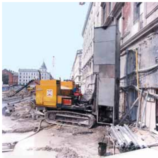
Foreuse pour injection équipée d'un boîtier antibruit
