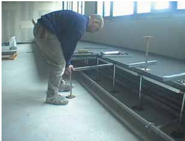
Photo 9 Mise en place du faux plancher Laying the raised flooring
