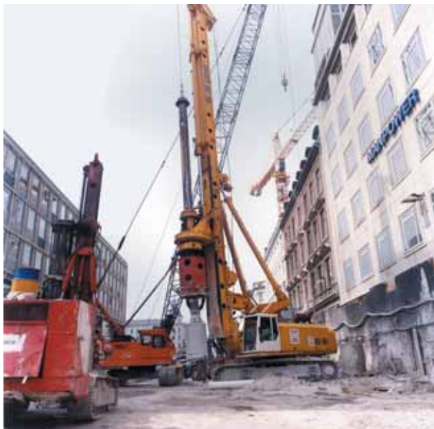
Foreuse de pieux pour mur en pieux sécants
