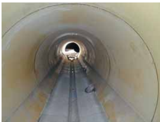
Photo 3 Cunettes en béton de synthèse Synthetic concrete gutters
