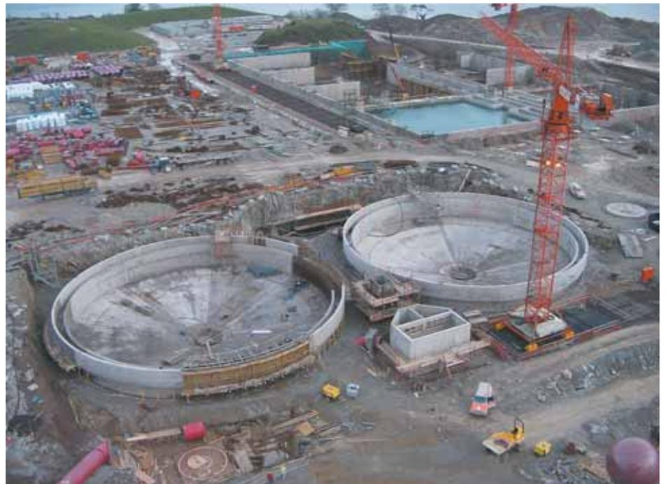
tégrante des panneaux, assure la stabilité et le réglage de l'ensemble. La grande rigidité de ces panneaux réduit le nombre de tiges de coffrage à seulement quatre par panneau. Le risque de fuites des bassins dû à un mauvais rebouchage des trous, est aussi limité.
