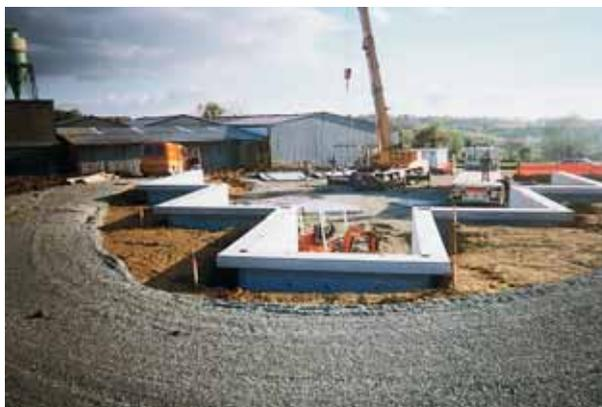
Murs de soutènement par éléments préfabriqués
