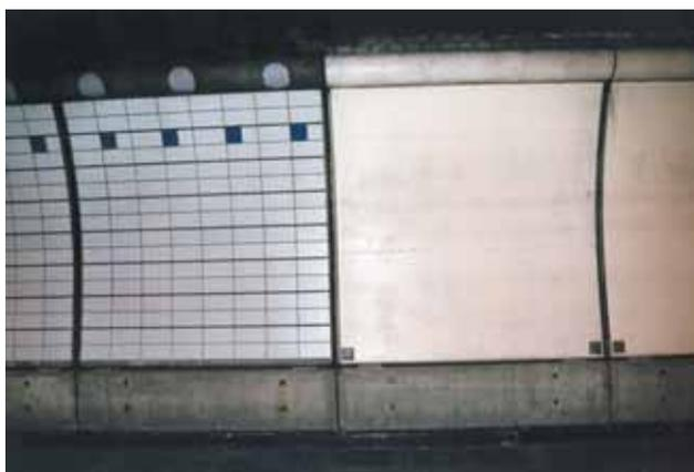
Le revêtement des piédroits d'un tunnel par des coques en composite ciment-verre (CCV)
