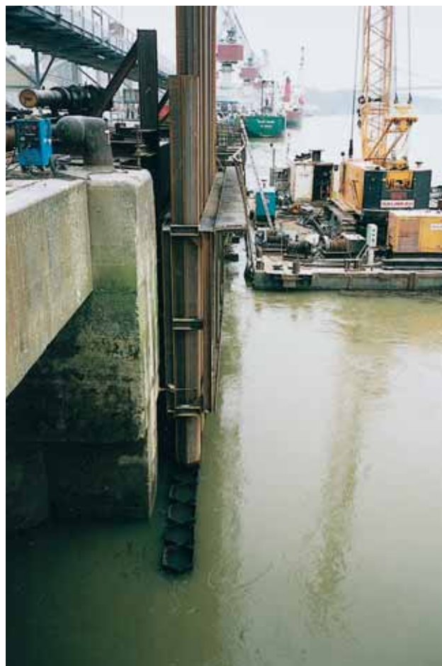
Photo 4 Battage des caissons
