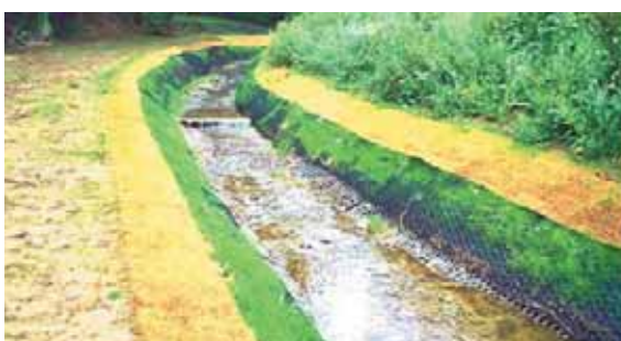
Photo 8 Après travaux pose des matelas + Macmat et recouvrement de terre végétale. Début végétalisation After the work, laying of mattresses + Macmat and covering with top soil. Start of revegetation
