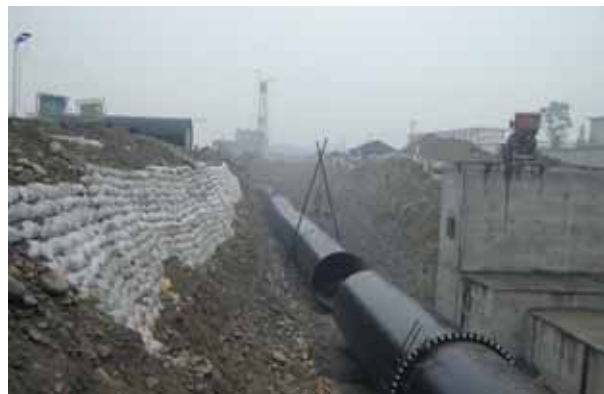
Photo 6 Connexion de la tuyauterie d'eau potable en diamètre 2400 mm avec la conduite de distribution de La Sade
