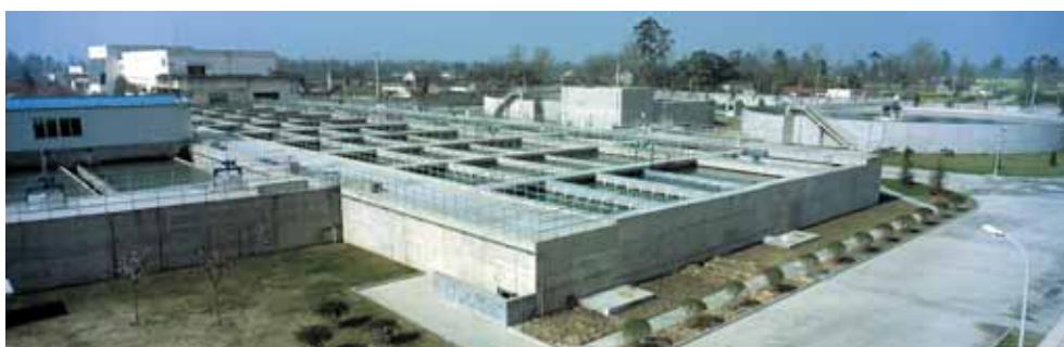
Photo 8 De droite à gauche dans le sens de traitement de l'eau les décanteurs à boue, les multiflo settlers, les filtres et la galerie centrale From right to left in the direction of water treatment, the sludge clarifiers, the multiflo settlers, the filters and the central gallery
