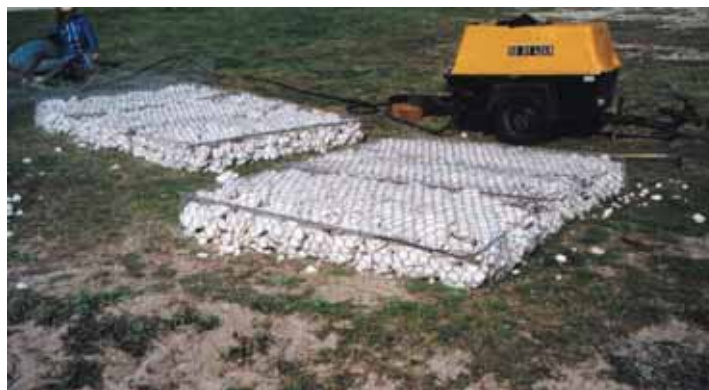
Photo 11 Vue des matelas Reno® remplis, prêts à être posés en eau
