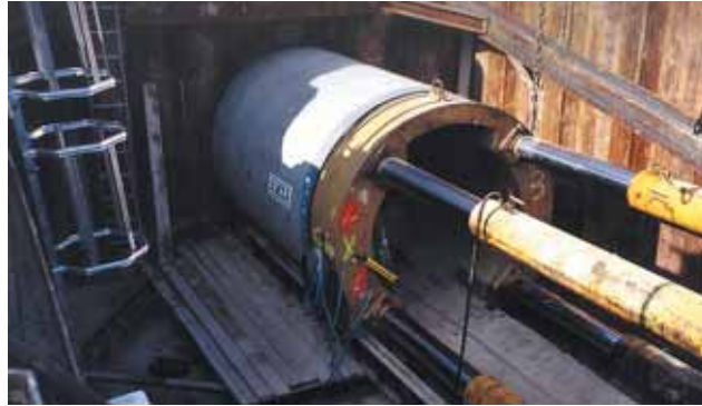
Vue du fonçage du collecteur de rejet D 2200 View of driving of the main discharge drain, dia. 2200 mm
