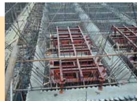
Photos 12 à 15 a : Coffrage perdu en "pebble" maçonné - b : Coffrage intérieur métallique - c : Les sludges bétonnés - d : L'ouvrage fini a : Lost shuttering in pebble masonry - b : Interior steel shuttering - c : Concrete sludge clarifiers - d : The completed structure
