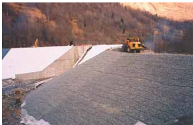
Photo 3 Après remplissage des matelas Reno® After filling the Reno® mattresses
