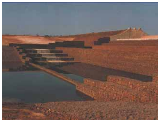
Photo 12 Vue aval du déversoir du barrage d'Al Bassam
