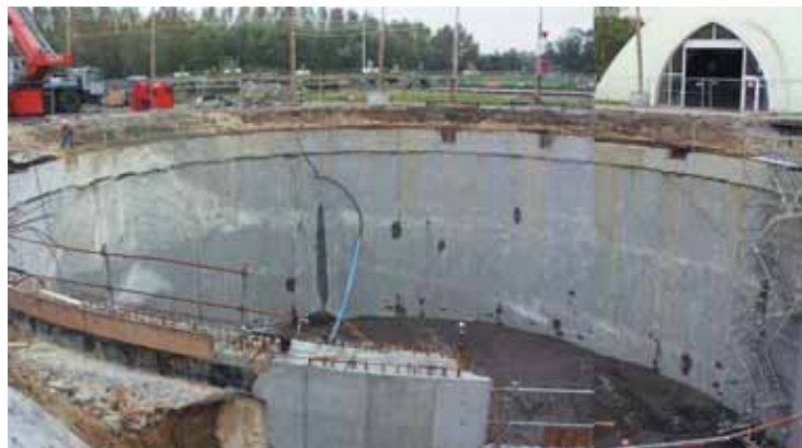
Photo 2 Bassin de stockage d'Houplin-Ancoisnes - Lille Métropole Communauté urbaine
