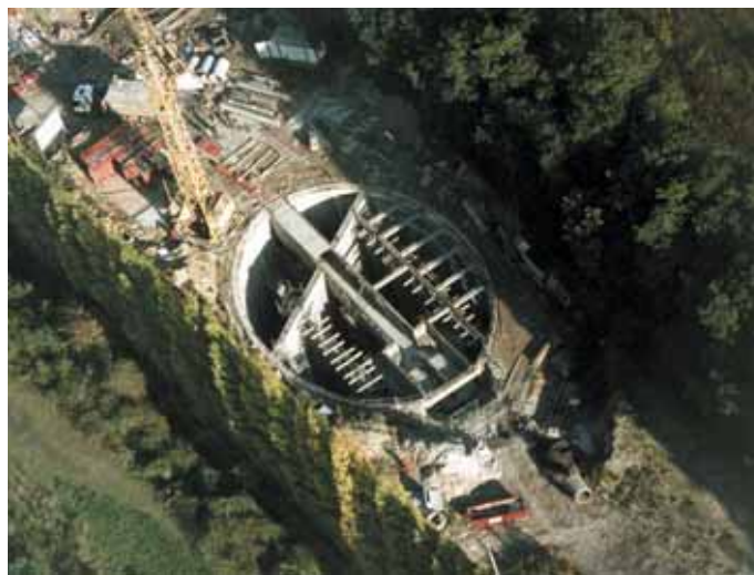
Photo 3 Bassin de stockage elliptique - Communauté d'agglomération de Lens-Lievin - Bassin de Méricourt. 1 er Prix de l'innovation FNTP 2001 - Projet PIBOP (Puits Intégré pour Bassin d'Orage Profond) Elliptical storage tank - Lens- Lievin inter-municipal association ("Communauté d'agglomération") - Méricourt tank. FNTP 1st prize for innovation 2001 - PIBOP Project (integral well for deep stormwater tank)
