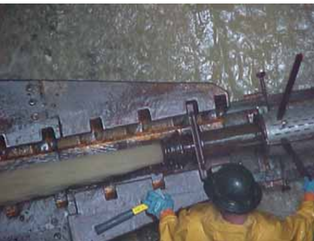
Photo 6 Havage d'un tambour Cutting a drum
