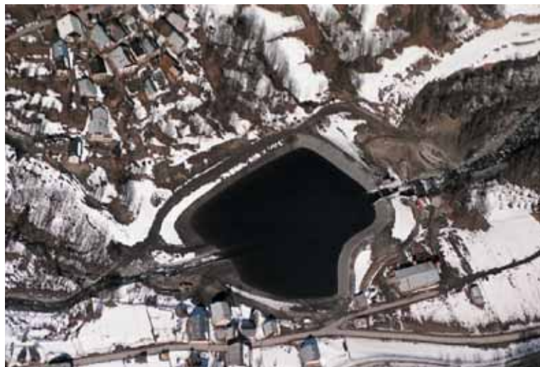
Photo 1 Vue aérienne du barrage mis en eau après travaux Aerial view of the dam filled with water following the works
