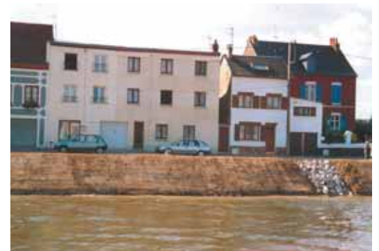
Photo 10 Vue de la berge après recouvrement de terre végétale et hydroensemencement pour que l'intégration de cette nouvelle structure se fasse plus rapidement dans son environnement
