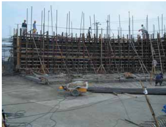
Photo 9 Voiles extérieur et intérieur réalisés en cinq phases. Ici une phase coffrée prête pour le bétonnage Exterior and interior shells constructed in five stages. Here a shuttered phase ready for concreting
