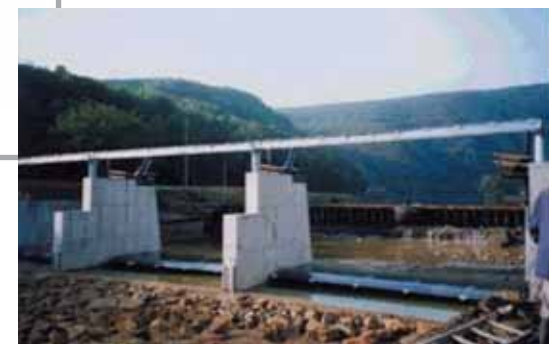
Photo 4 Monthermé : construction du nouveau barrage Monthermé : construction of the new dam
