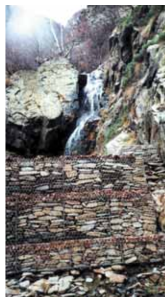
Photos 4 et 5 Vue des ouvrages transversaux après travaux
