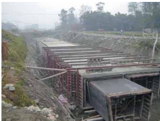
Photo 4 Le coffrage outil permettant la réalisation du dalot d'amenée d'eau par éléments de 18 m en double cellule
