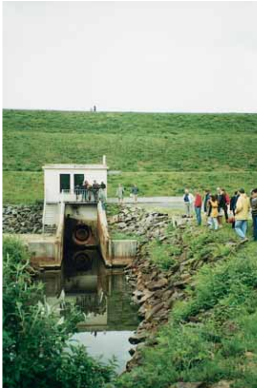
Barrage en terre pour un réservoir dédié à l'irrigation (visite dans le département parrain)
