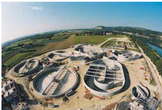
Vue d'ensemble de l'usine - Août 2002 Overall view of the plant - August 2002
