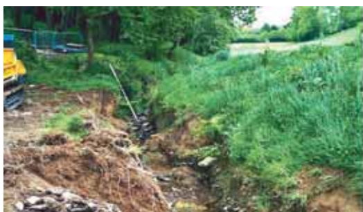
Photo 6 Site avant réalisation des travaux Site before execution of the works
