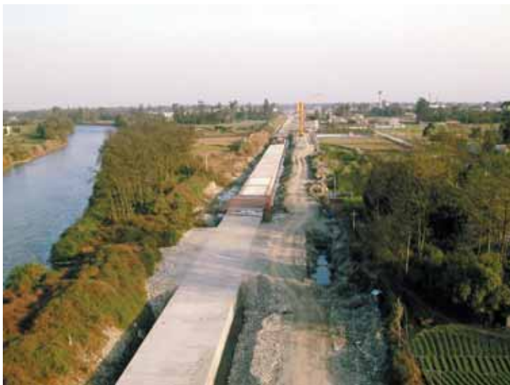
Photo 6 Connexion de la tuyauterie d'eau potable en diamètre 2400 mm avec la conduite de distribution de La Sade
