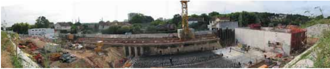
Vue panoramique du chantier
