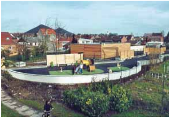
Photo 6 Traitement architectural et paysager du bassin de stockage Pasteur - Communauté d'agglomération de Lens-Lievin (architecte Eric Bail)
