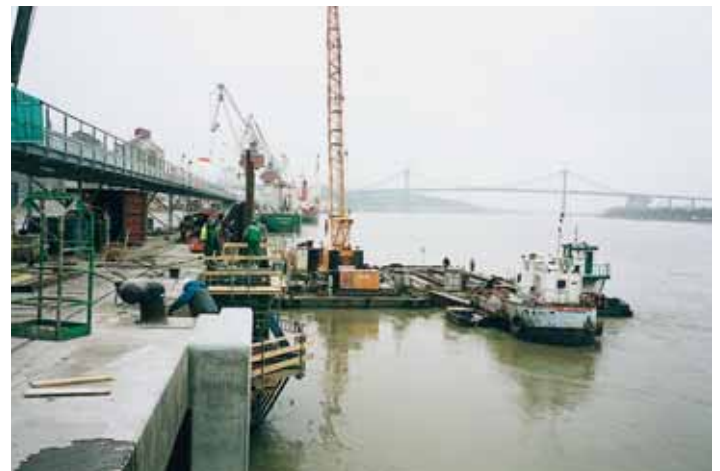
Photo 3 Vue d'ensemble Overall view
