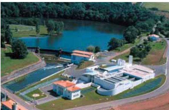
Production de 30 000 m 3 /j d'eau potable par décantation lamellaire, ozonation et CAG
