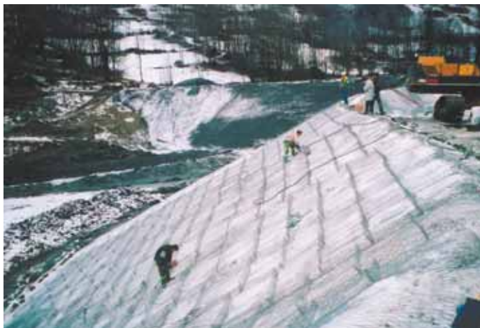
Photo 2 Mise en place des matelas Reno® Installation of Reno® mattresses
