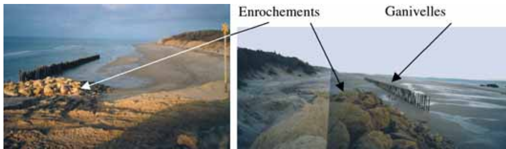
Figure 2 La plage de l'Amélie avant la construction des tubes brise-lames. Partie nord : à gauche. Partie sud : à droite L'Amélie Beach before construction of the breakwater tubes. Northern section : on the left. Southern section : on the right
