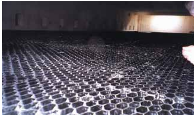
Vue intérieure d'un décanteur avec les modules lamellaires Interior view of a clarifier with the lamellar modules
