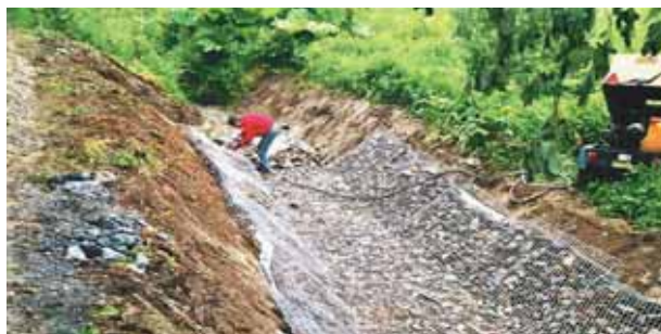
Photo 7 Mise en place des matelas Reno® Installation of Reno® mattresses
