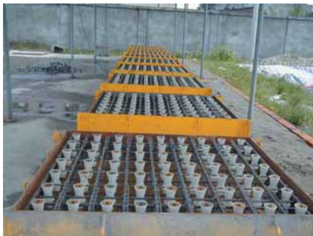
Photo 10 Atelier de préfabrication des dalles de filtres Filter slab prefabrication plant
