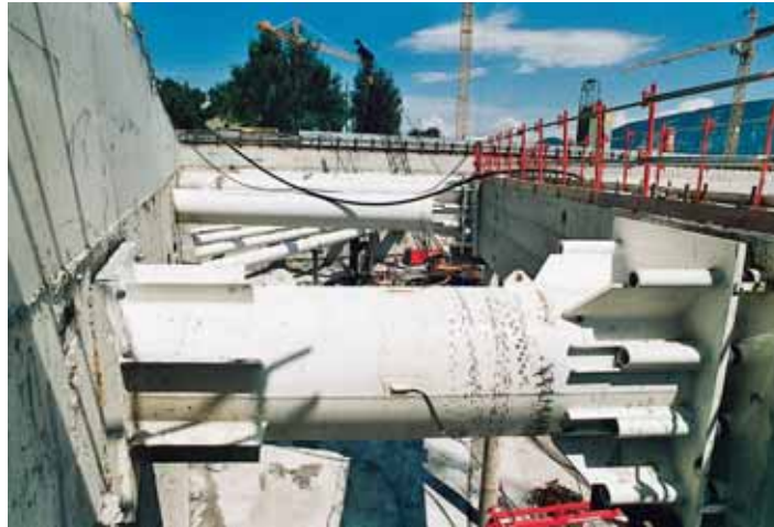
Photo 5 Détail buton Detail of strut
