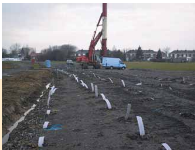
Photos 3 et 4 Mise en œuvre des drains Drain laying
