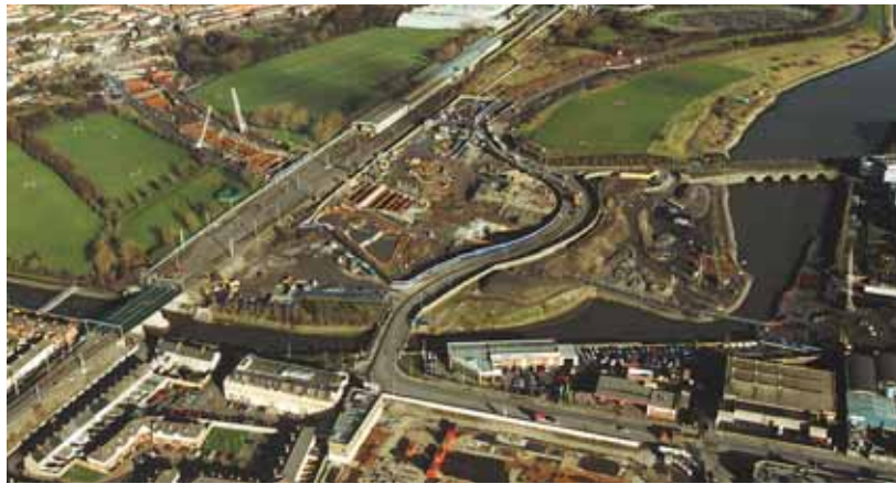
Photo 8 Tronçon sud : de Fairview Park à la rivière Tolka Southern section : from Fairview Park to the Tolka River
