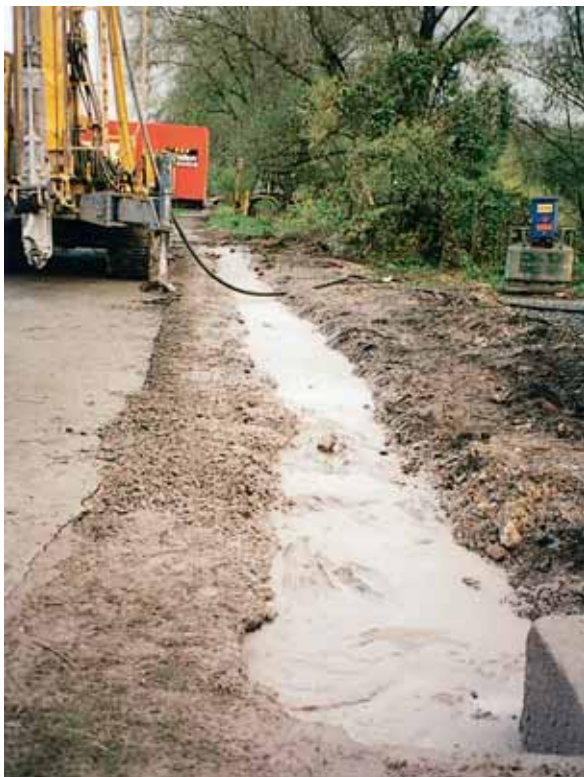
Photo 2 Détail du voile en fin de travaux Detail of the shell at the end of the works
