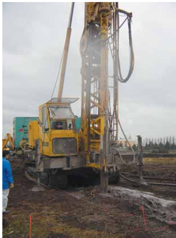
Photo 1 Foreuse Keller Keller drill
