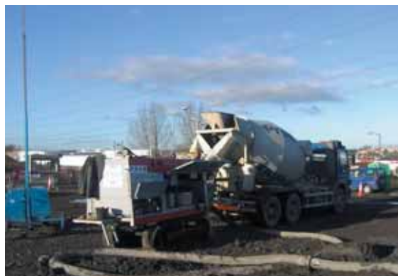
Toupie et pompe à béton Ready mix truck and concrete pump
