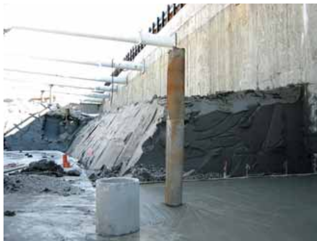
Photo 6 Risberne - Réalisation du sous-radier Berme - Execution of the sub-foundation raft
