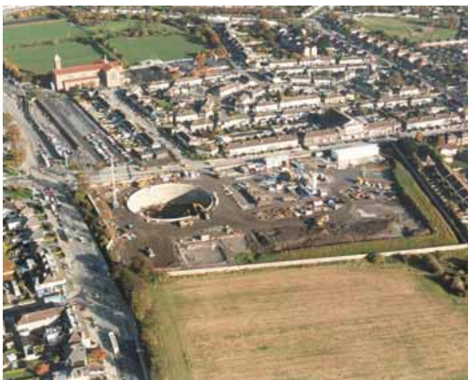
Photo 1 Puits WA2 : accès du tunnelier Shaft WA2 : tunnel boring machine access
