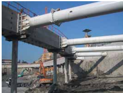
Photo 11 Terrassement - Vue de détail Earthworks - Detail view
