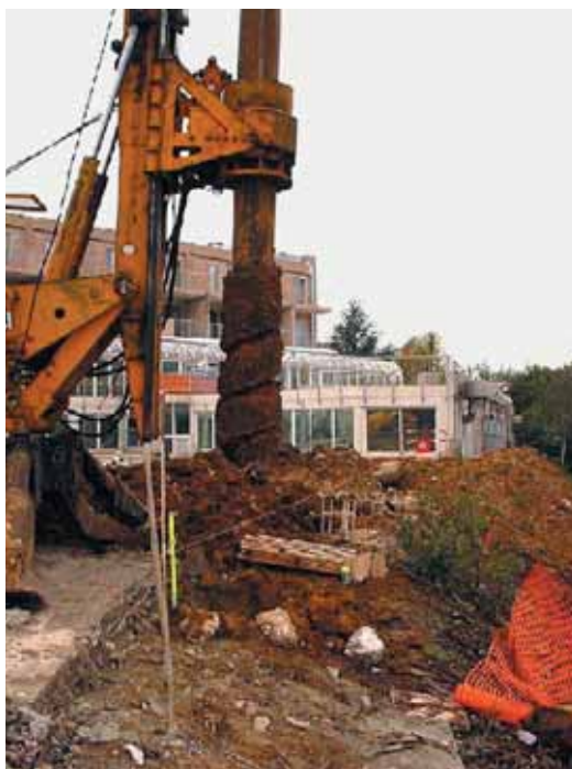
Photo 6 Extraction des terres (tarière) Earth extraction (auger)
