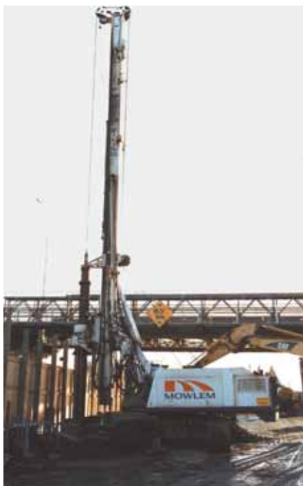
Photo 6 Secteur nord - Réalisation de pieux tangents Northern sector - Execution of tangential piles
