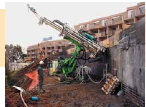
Photos 4 et 4b Poste de travail profil 3 et poste de clouage Work station profile 3 + nailing station
