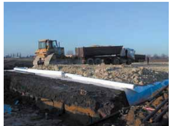
Photos 5 et 6 Mise en œuvre de la craie Laying chalk
