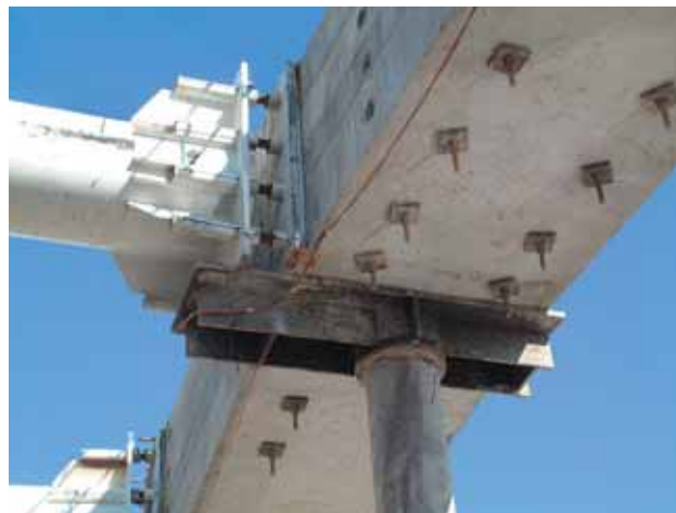
Photo 4 Détail console Detail of bracket
