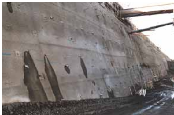
Photo 7 Secteur nord - Vue partielle du mur clouté Northern sector - Partial view of the gridded wall
