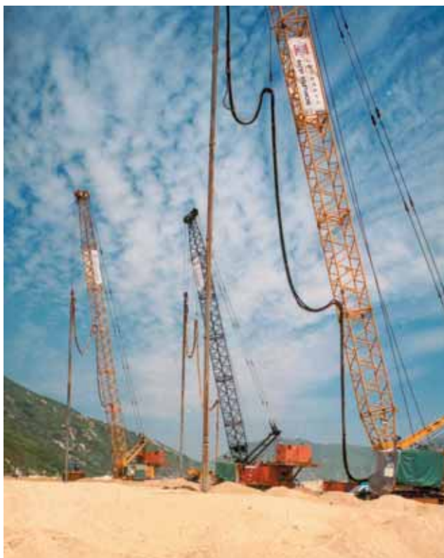
Photo 4 Vibrocompactage en cours au moyen de trois machines Vibrocompaction in progress with three Rigs working together
