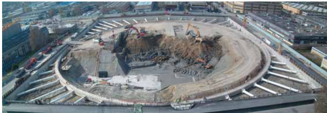
Photo 10 Terrassement - Vue aérienne Earthworks - Aerial view
