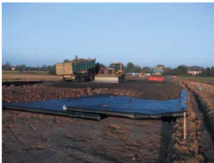
Photo 1 Piste et chemin en recyclé Track and path of recycled materials
