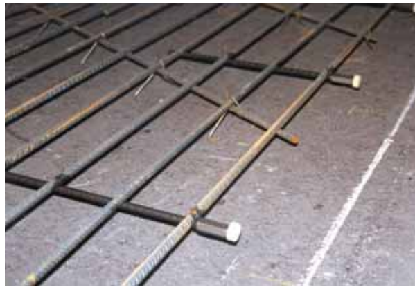
Photo 7 Goujons, ferrailage, deuxième bande Studs, reinforcement, second strip
