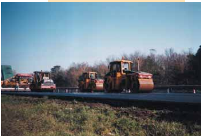
Atelier de compactage des enrobés Asphalt compacting equipment
