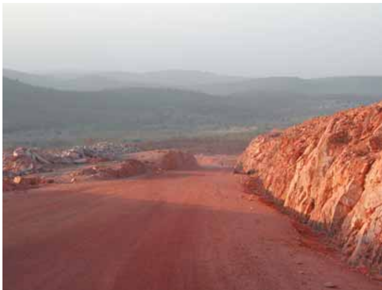
Photo 4 Déblais rocheux réalisés à l'explosif Rock excavation performed by explosive
