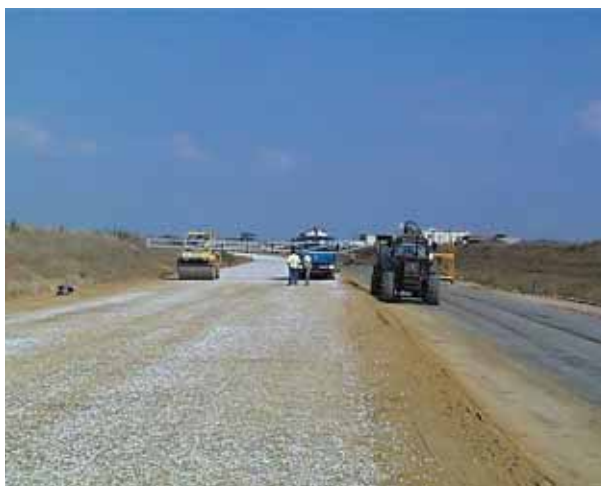
Photo 5 Cloutage et humidification
