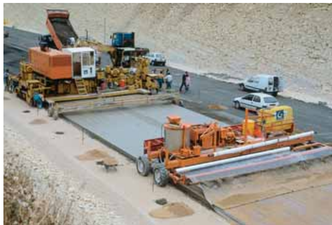
Photo 2 Chaussées composites BAC/GB : réalisation de la déviation des Rassats-Favrauds RN 141 Composite pavement of continuous reinforced concrete/bitumen treated base material : construction of the Rassats-Favrauds diversion on the RN 141 highway
