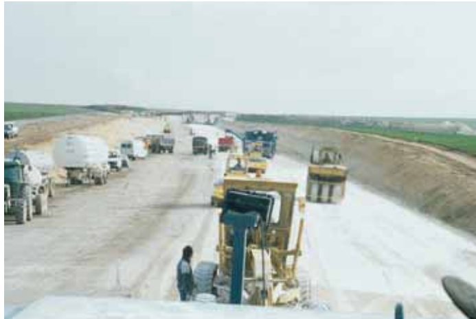
Photo 17 Vue générale d'un chantier traitement de sol pour la réalisation d'une plate-forme autoroutière
