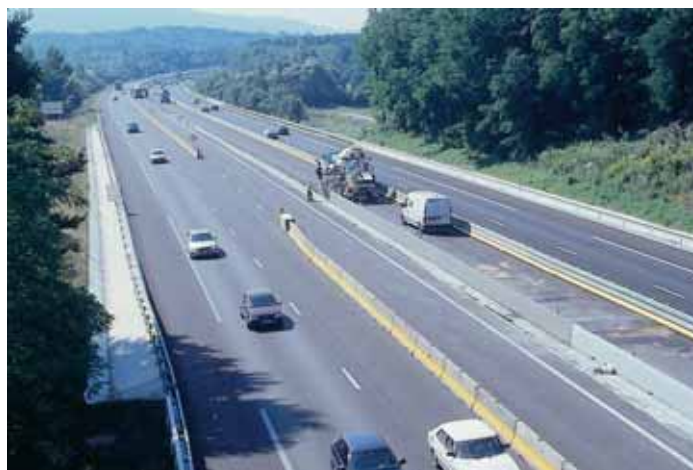
Photo 4 Autoroute A40 : entre les échangeurs de Bourg-en-Bresse et de Pont d'Ain, des ouvrages en béton extrudé pérennes et faciles à entretenir
