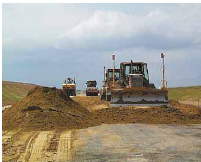
Photo 4 Mise en œuvre de la couche de sable traité Application of the layer of treated sand
