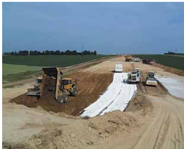
Photo 1 Traitement des limons Silt treatment
