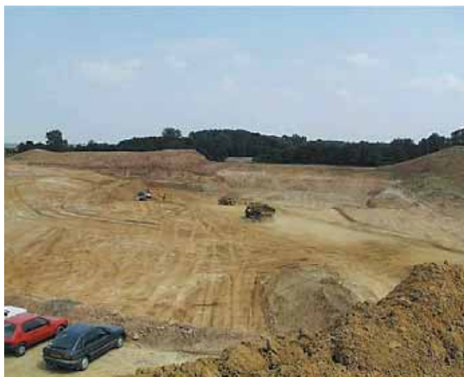
Photo 2 Carrière de sable à proximité du chantier Sand quarry close to the site
