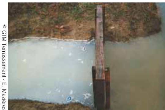
Photo 2 Filtre à fines pour filtration des eaux de ruissellement Fines filter for filtration of runoff water
