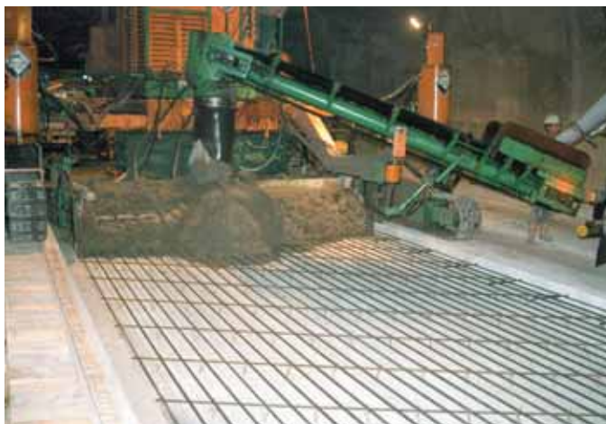
Photo 11 Bétonnage, deuxième bande Concreting, second strip
