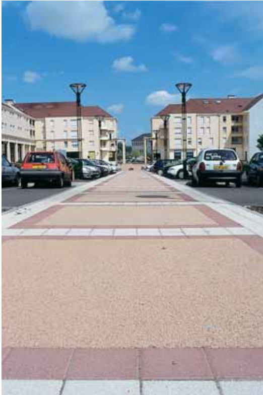
Photo 7 Paray-le-Monial (Saône-et-Loire) : l'espace piétonnier de la ZAC use largement du béton désactivé
