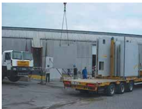
Photo 3 Mise en place de deux prémurs
