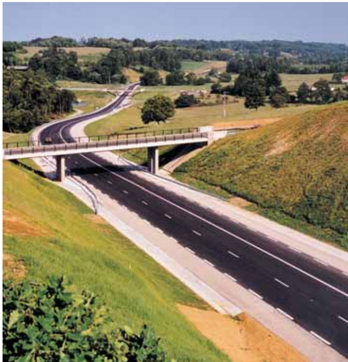
Photo 1 Vue générale de la déviation General view of the diversion
