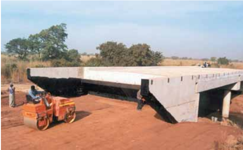
Photo 2 Pont deux travées en cours Two-span bridge in progress
