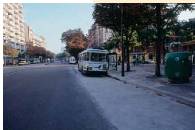
Photo 13 Paris - Boulevard Davout : chaussée composite en BCMC pour un arrêt de bus Paris - Boulevard Davout : composite pavement in thin bonded concrete overlay for a bus stop
