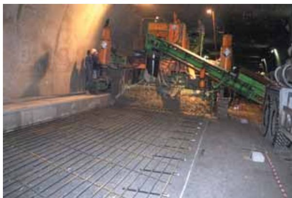
Photo 10 Bétonnage, première bande Concreting, first strip
