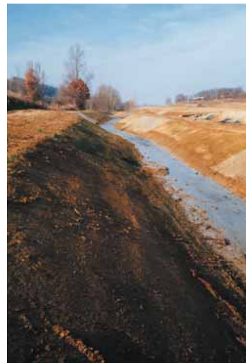
Photos 3 et 4 Toile de jute en protection de berge de l'A66 (A66 T1)
