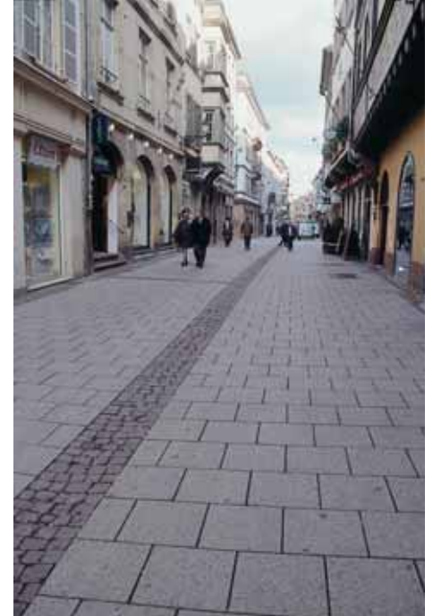
Photo 10 Strasbourg (Bas-Rhin) - Rue des Hallebardes : des dalles de béton rose pour une voie pleine de charme
