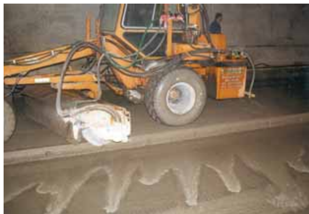
Photo 14 Evacuation des laitances de dénudage Removal of stripping laitances
