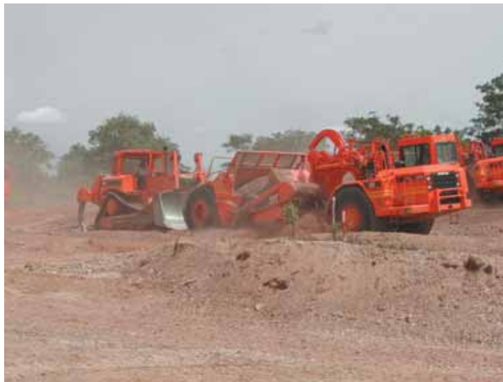
Photo 3 Décapeuses automotrices en cours de chargement Motor scraper during loading
