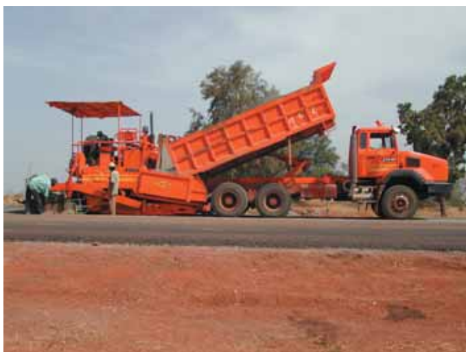
Photo 5 Mise en œuvre de la couche de base au finisseur Application of the base layer by paver finisher
