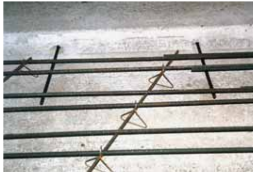
Photo 7 Goujons, ferrailage, deuxième bande Studs, reinforcement, second strip
