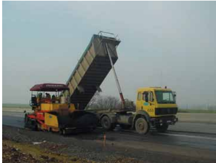
Mise en œuvre des enrobés
