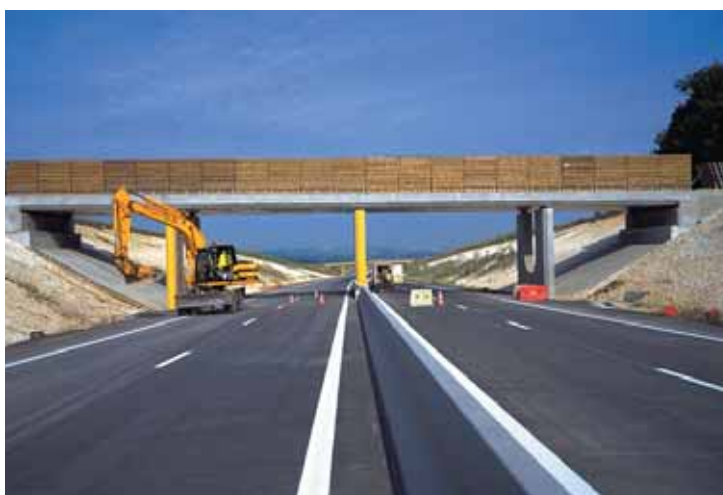
Photo 6 Caractéristiques géométriques réduites et ouvrage courant économique
