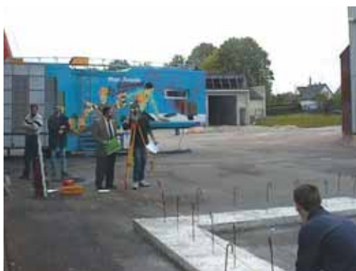
Photo 2 Implantation de deux prémurs
