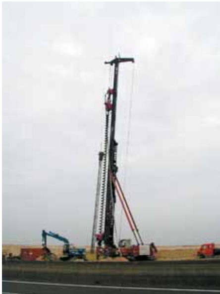
Photo 4 Réalisation des pieux Starsol Construction of Starsol piles
