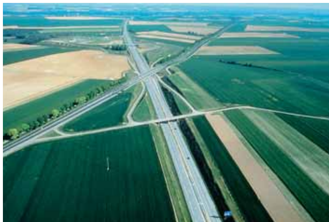
Vue générale d'une route en béton avec ses ouvrages et ses équipements annexes
