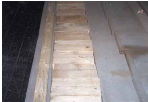
Photo 12 Protection des caniveaux latéraux Protection of side gutters
