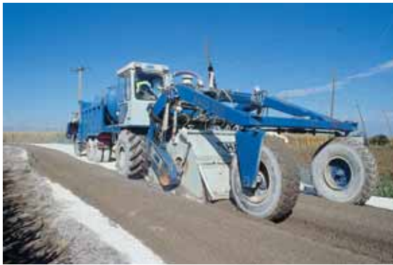
Photo 15 Bas-Rhin : retraitement au ciment d'un chemin départemental Lower Rhine region : cement resurfacing of a county road
