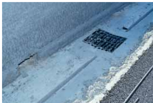
Photo 5 Autoroute A40 : les caniveaux à fente sont coulés dans une tranchée grâce à un moule spécifique A40 motorway : the slotted gutters are poured in a trench using a special mould
