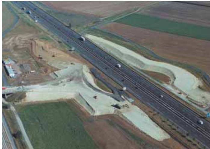
Photo 3 Remblais généraux en craie Main embankments of chalk
