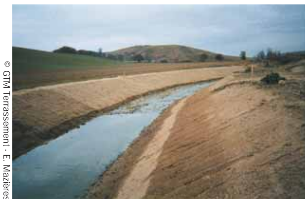
Photos 3 et 4 Toile de jute en protection de berge de l'A66 (A66 T1)
