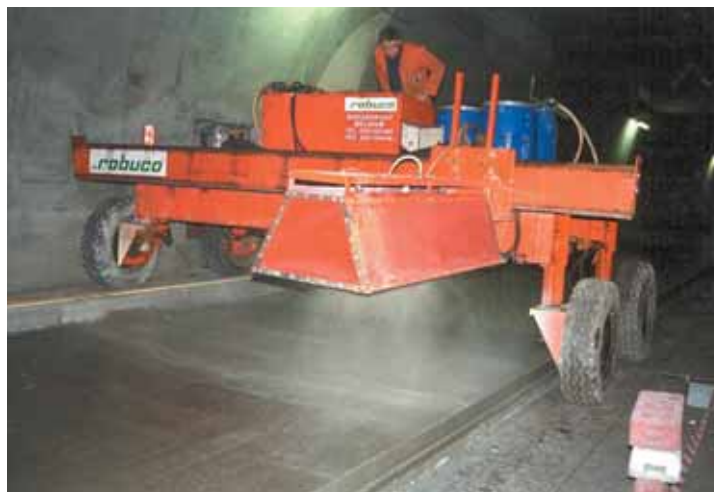
Photo 14 Evacuation des laitances de dénudage Removal of stripping laitances
