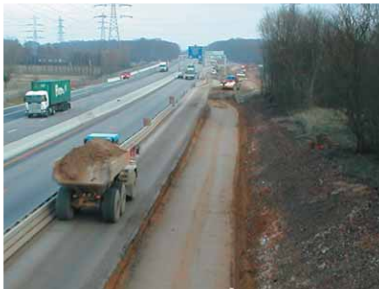
Transport des déblais par la voie de desserte
