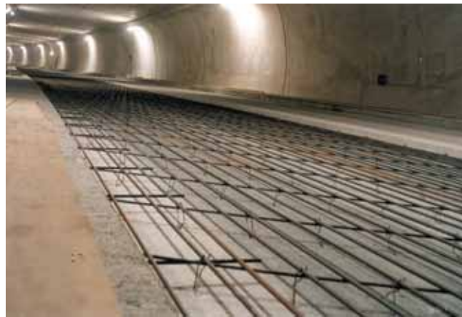
Photo 8 Ferrailage, deuxième bande Reinforcement, second strip
