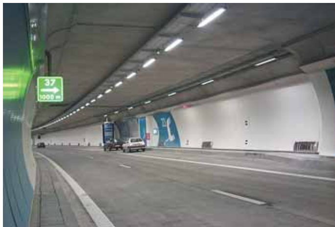
Photo 3 Vue de l'intérieur d'un des tunnels de Cointe View of the inside of one of the Cointe tunnels
