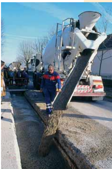
Photo 16 Auxerre (Yonne) - Remblayage d'une tranchée d'assainissement : utilisation d'un matériau autocompactant à base de ciment Auxerre (Yonne region) - Backfilling of a drainage trench : use of a self-compacting cement-base material
