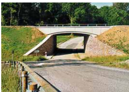
Photo 4 Passage inférieur de l'Etang Neuf Etang Neuf underpass
