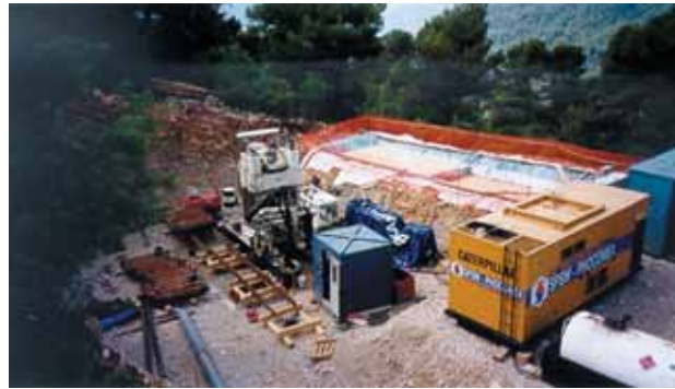
Photo 4 Zone d'installation Raise-Drill en tête de puits Raise-Drill installation zone at wellhead
