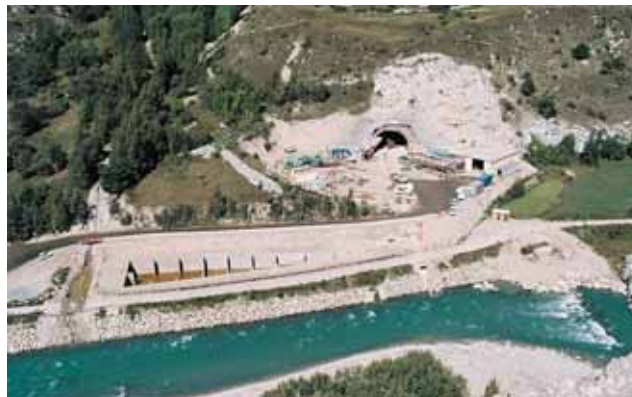
Photo 3 Entrée de la descenderie de Modane. Au premier plan, la rivière l'Arc et le bassin de décantation
