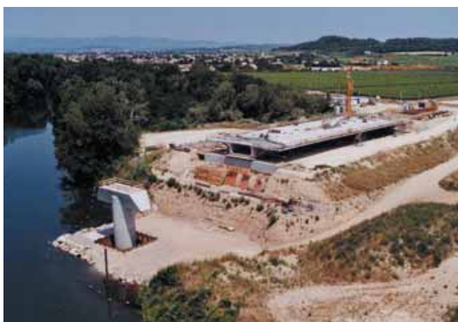
Photo 12 L'extrémité arrière du tablier, au droit du voussoir sur culée, en appui sur son calage provisoire, en attente du poussage
