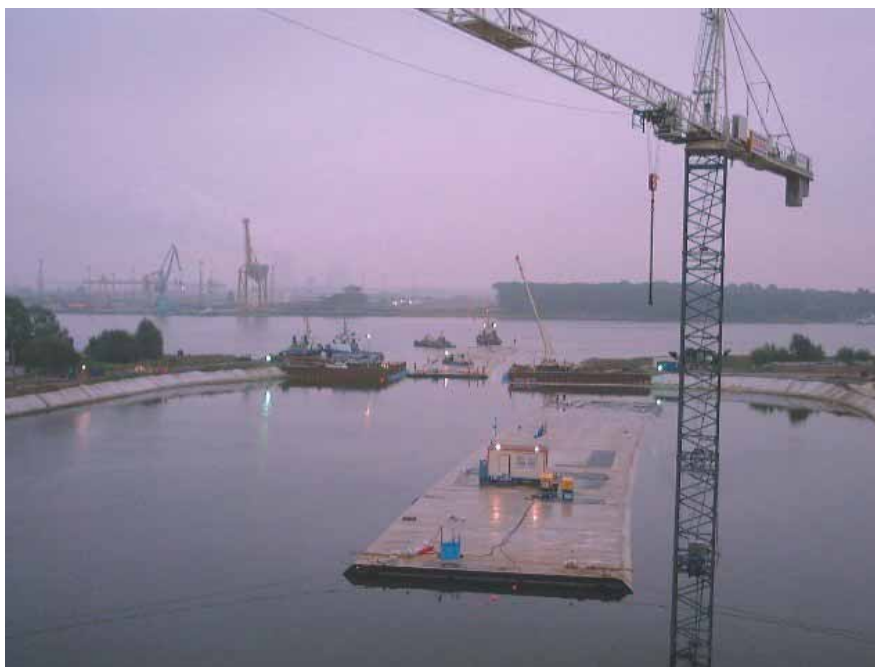
Sortie des caissons 1 et 2 Exit of caissons 1 and 2
