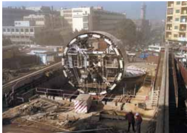
Photo 8 Roue de coupe à Darassa Cutting wheel at Darassa
