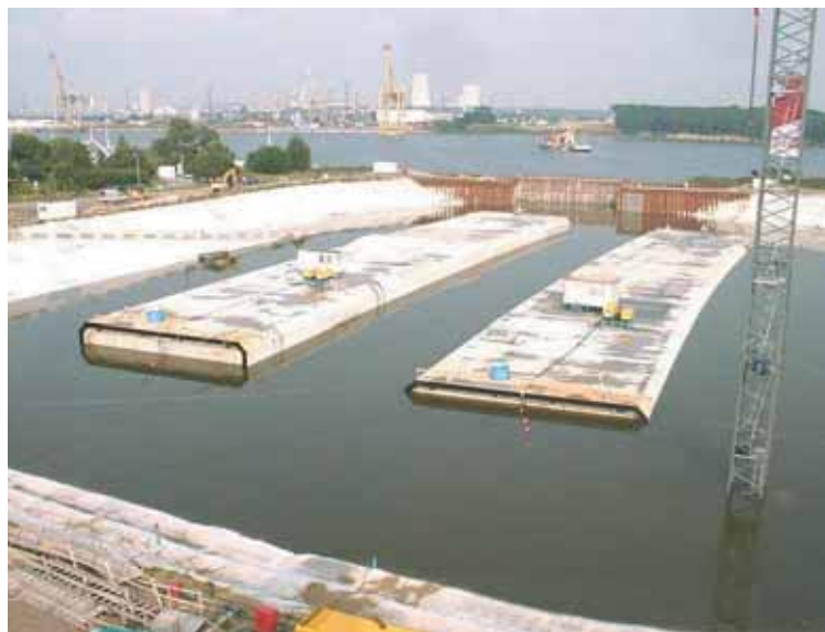
Caissons 1 et 2 en flottaison dans la darse Caissons 1 and 2 floating in the dock
