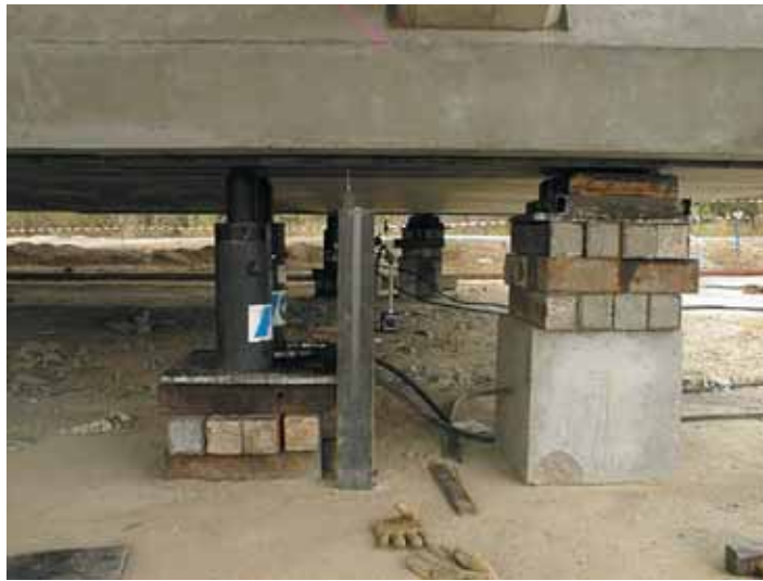
Photo 13 "Troisième appui de poussage" rajouté de façon provisoire à l'extrémité arrière sur une distance de 4,35 m
