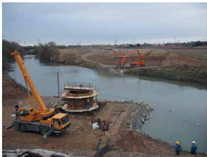
Photo 3 Coffrage de la pile P2 sur la plate-forme remblayée en rive gauche protégée contre les crues par des enrochements
