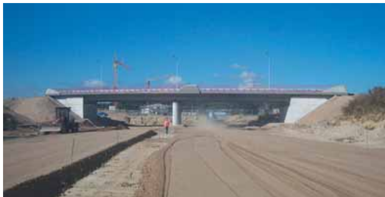
Pont n° 4 Bridge No. 4
