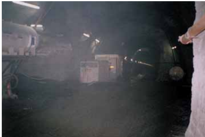
Photo 4 Un élargissement dans le tunnel ferroviaire Widening in the rail tunnel
