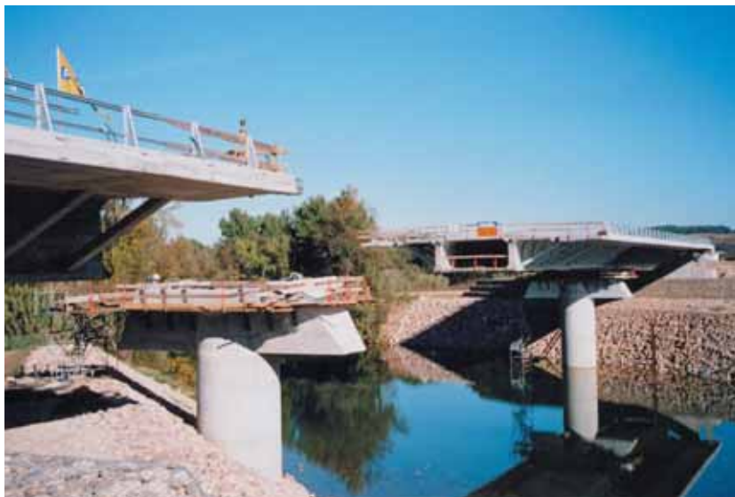
Photo 16 Au cours du second poussage, le fléau rive droite est parti pour rejoindre le fléau rive gauche déjà en place
