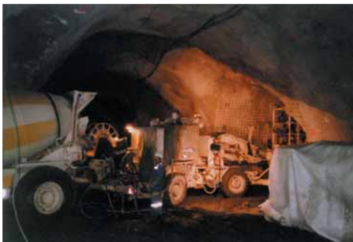
Photo 8 Béton projeté Shotcrete
