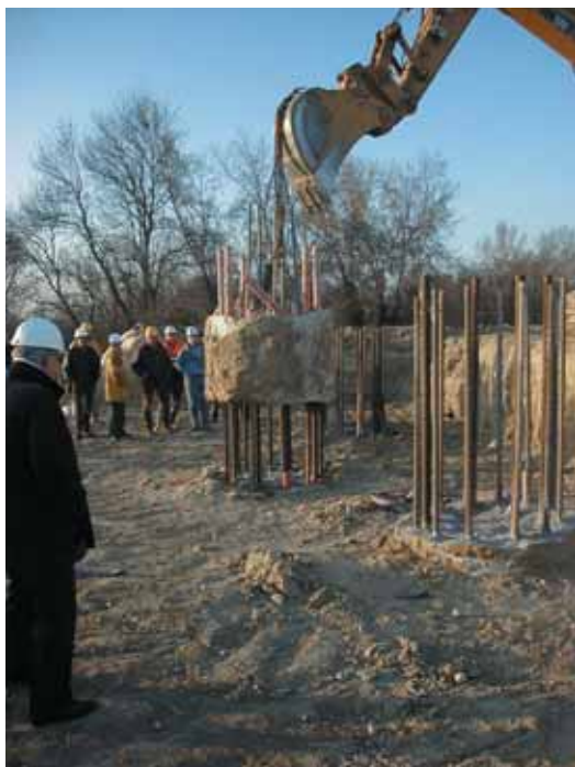
Photos 1 et 2 Recépage des pieux par la méthode "Recépieu" ® : extraction à la pelle de la partie supérieure polluée après prédecoupage à l'éclateur chimique
