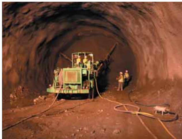
Photo 5 Descenderie de Modane : boulonnage
