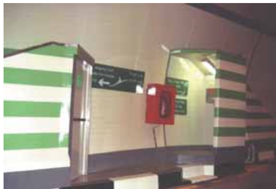
Photo 4 La cabine du toboggan The chute cabin
