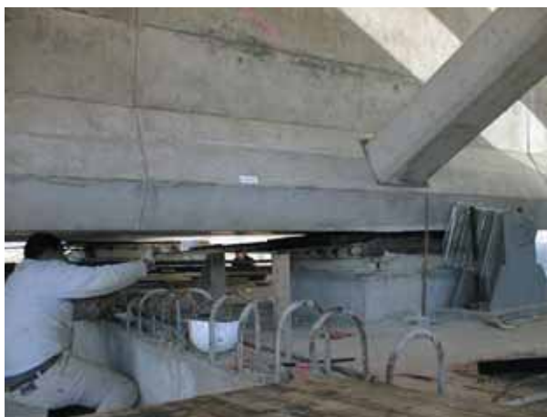
Photo 9 Introduction d'une plaque de glissement en néoprène Teflon® sur la platine de glissement en acier inoxydable au droit de l'appui sur culée. A droite du dé le dispositif de guidage latéral du tablier
