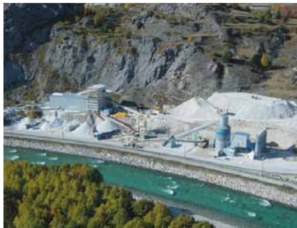
Photo 4 Vue générale des installations de valorisation des matériaux de déblais
