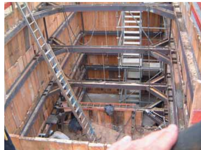
Photo 3 Vue du puits de travail View of the work shaft
