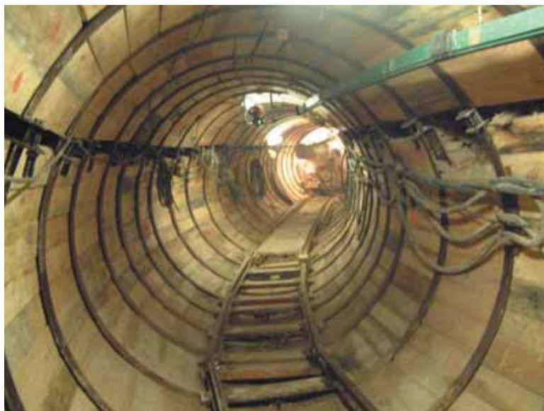
Photo 2 Vue de la galerie blindée View of the lagged gallery
