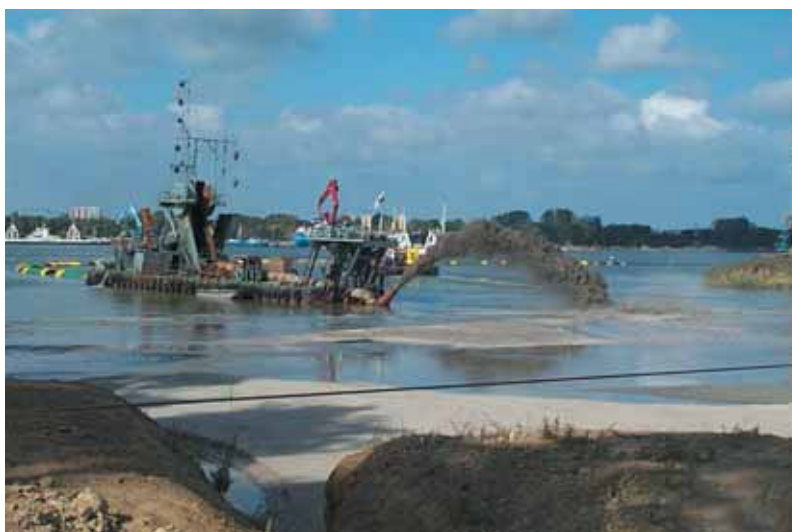
Remblaiement du tunnel en rive Est Tunnel backfilling on the East bank
