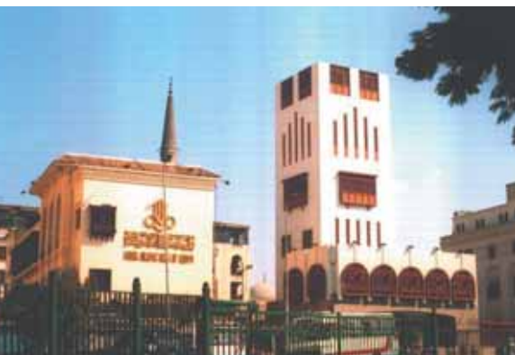
Photo 2 La place El Hussein avec la cheminée à droite El Hussein square with the chimney on the right
