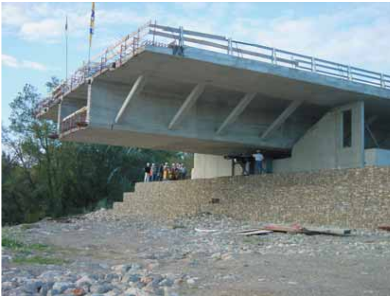
Photo 14 Poussage du fléau rive gauche : le tablier "sort" de la culée en abordant la travée de rive
