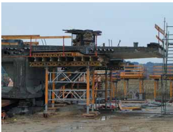
Photo 6 Détail du coffrage des encorbellements latéraux au moyen de tables coffrantes Detail of shuttering of side cantilevers by means of casting tables
