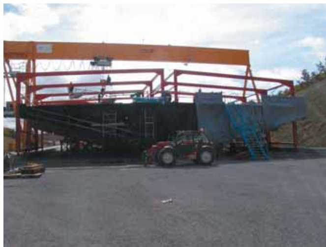
Photo 4 Assemblage du tablier métallique sur site Assembly of the steel deck on site
