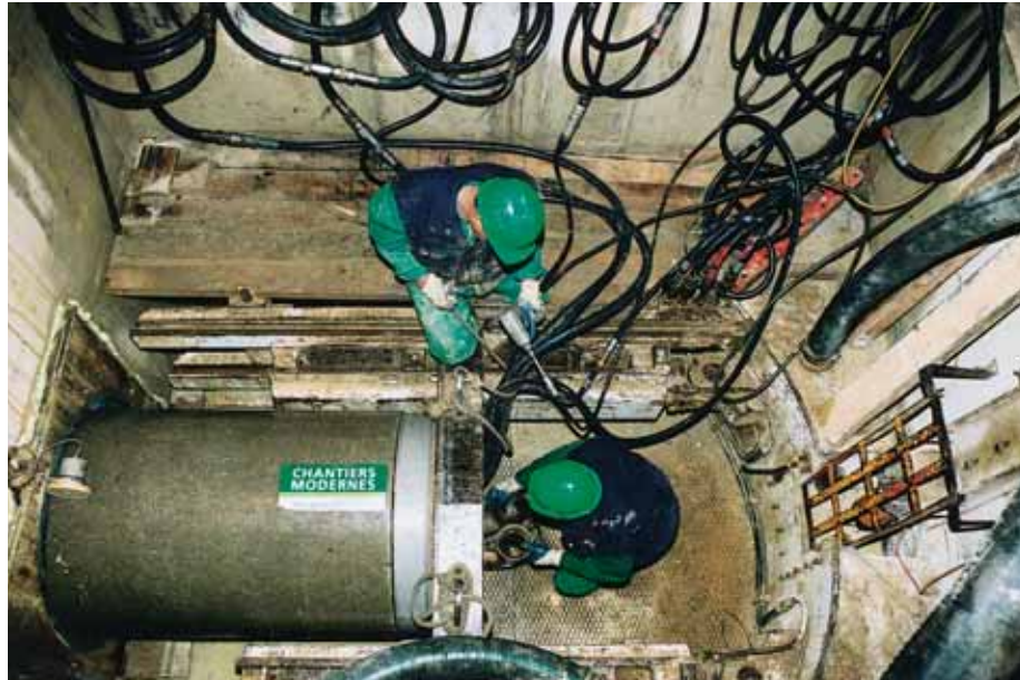
Photo 2 Dispositif de poussage des tuyaux Pipejacking device
