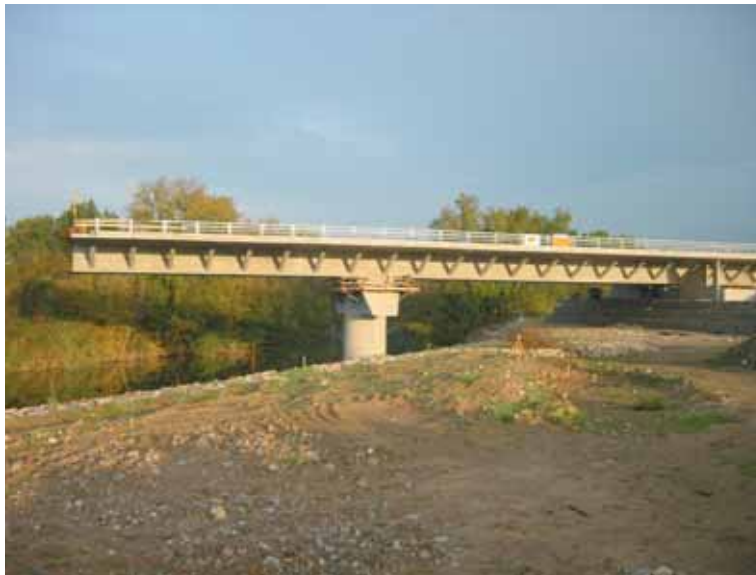
Photo 15 Fin du poussage du fléau rive gauche qui arrive dans sa position définitive
