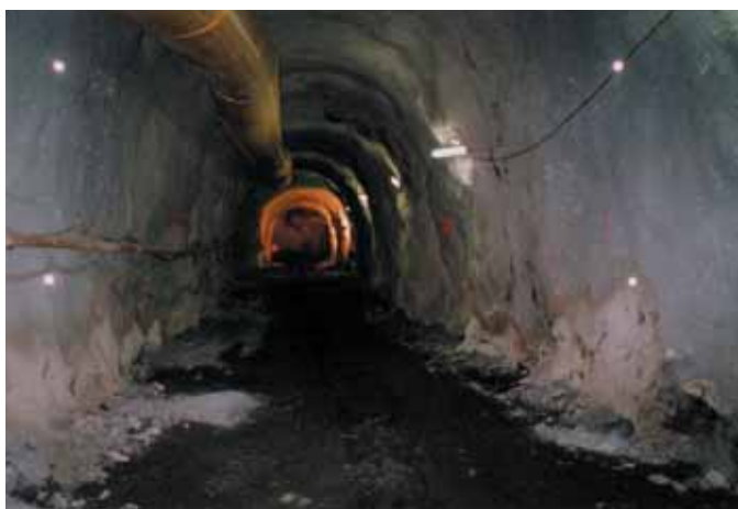
Photo 6 Galerie en section courante Gallery in link section
