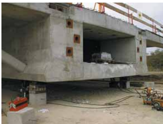
Photo 12 L'extrémité arrière du tablier, au droit du voussoir sur culée, en appui sur son calage provisoire, en attente du poussage
