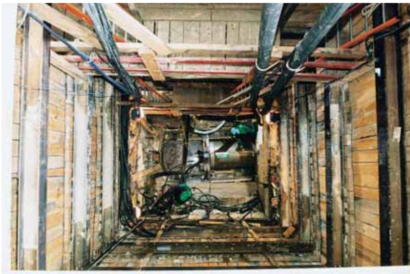
Photo 1 Vue d'un puits de poussée View of a thrust shaft
