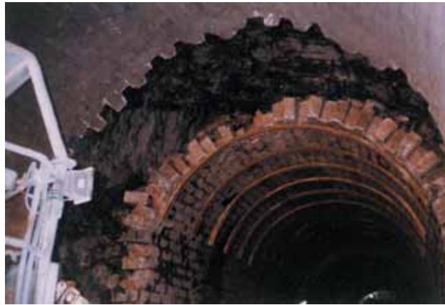
Photo 3 Démolition des maçonneries du tunnel ferroviaire Demolition of rail tunnel masonries
