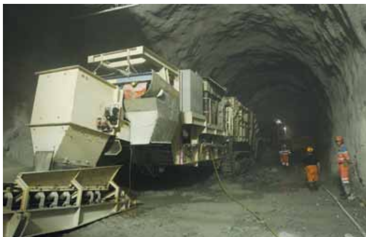
Photo 3 Concasseur mobile au front nord Mobile crusher on the North front
