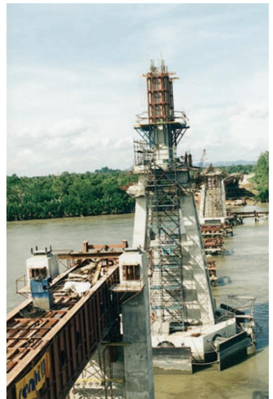
Transversalement, le voussoir est bétonné en trois phases :
