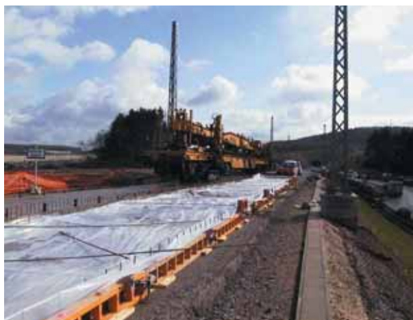
Photo 8 Approvisionnement d'un panneau d'appareil de voie au portique Bringing in a points and crossing panel by gantry crane
