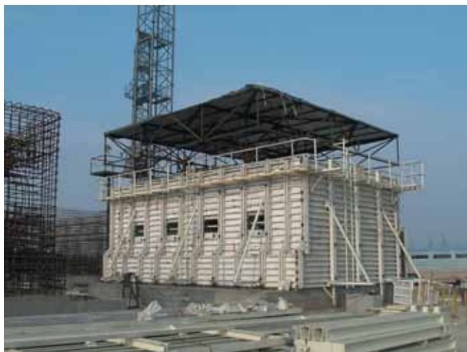
Photo 7 Coffrage des voiles des casemates et abri protecteur
