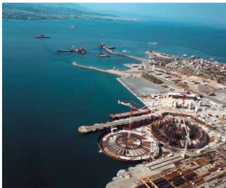
Photo 5 Vue aérienne de la double cale sèche
