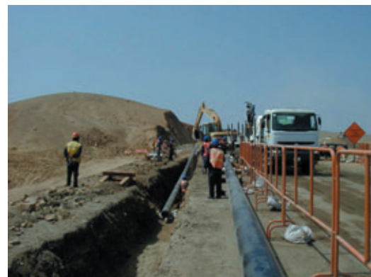
Photo 2 Mise en fouille du tube Lowering
