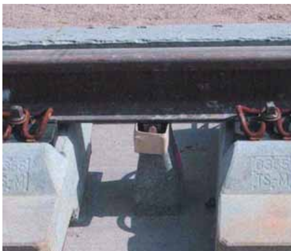
Photo 5 Cale de relevage de la voie Track raising wedge
