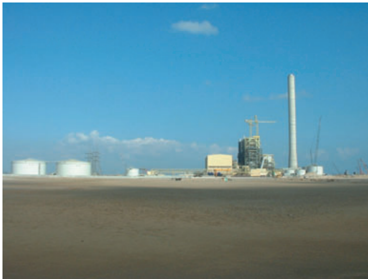
Photo 1 Vue de la centrale de Port Saïd View of the Port Saïd power station
