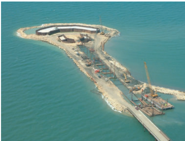
Photo 7 Vue d'ensemble Overall view
