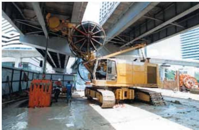
Photo 8 Bangkok Thaïlande. MRT Metro Project : benne hydraulique montée sur flèche raccourcie pour travail sous hauteur limitée
