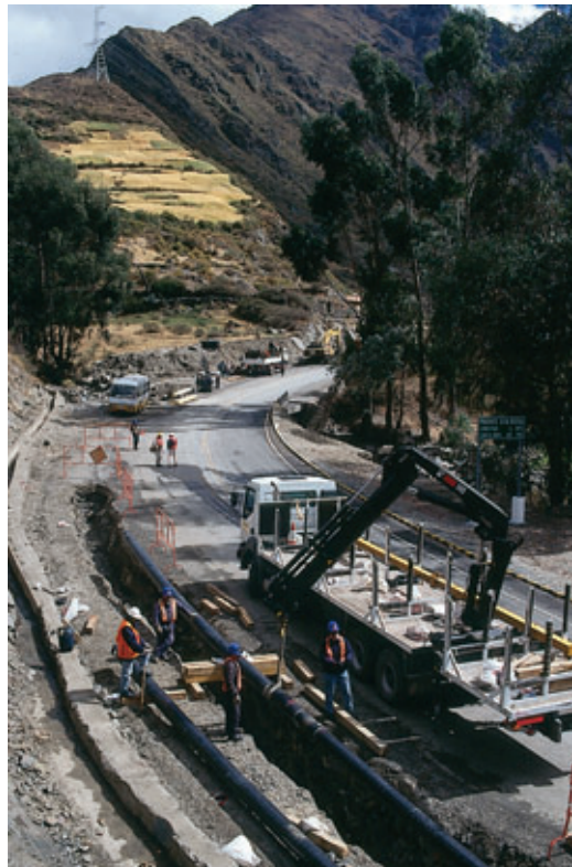
Photo 3 Un chantier urbain An urban site
