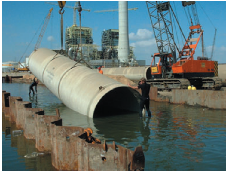
Photo 8 Pose des tuyaux Pipe laying
