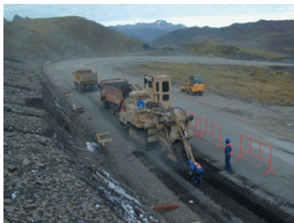
Photo 5 Evacuation des gravats par camion benne en avant de la tranchée Removing rubble by skip truck at the front of the trench
