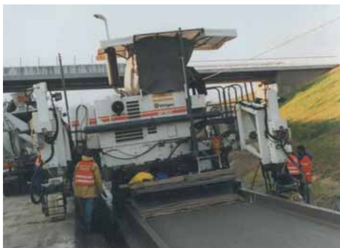
Photo 3 Construction de l'auget à la slip form
