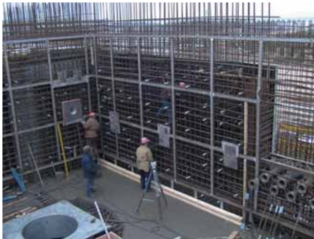
Photo 5 Usine de conditionnement - Salle principale : installation des cadres en inox Processing Plant - Main Process Room : Stainless Steel Frames Installation
