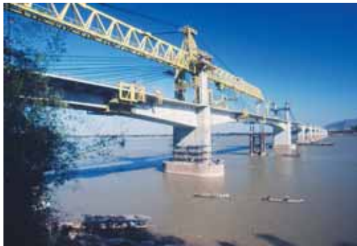
Photos 10 et 11 Ponts préfabriqués en encorbellement au Laos (ci-dessus) et à Hong Kong (à droite)
