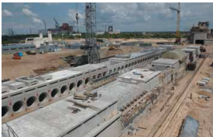
Photo 11 Vue d'ensemble des 232 casemates General View of the 232 Storage Modules
