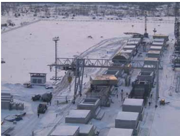
Photo 8 Bétonnage en hiver : béton en cure sous abris; abri écarté le temps du bétonnage
