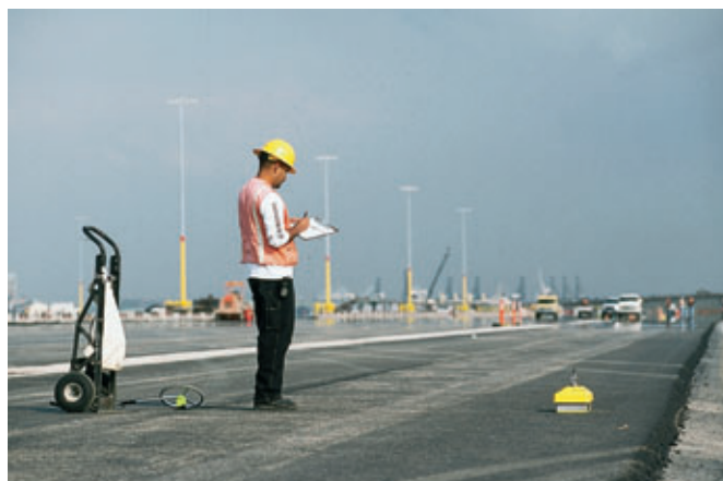
Contrôle de compacité Compaction checking
