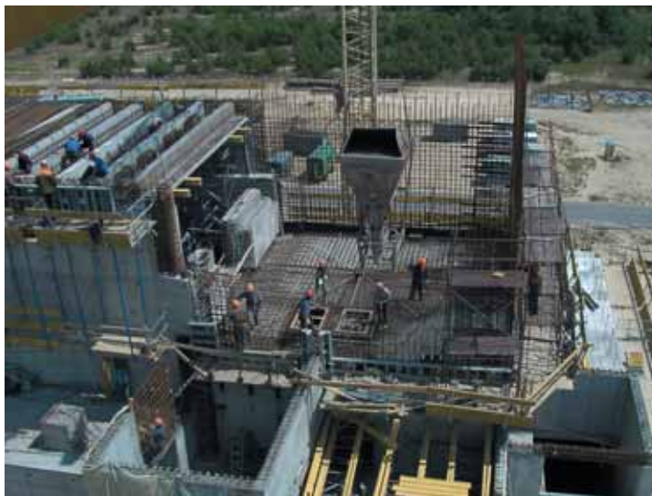
Photo 6 Usine de conditionnement - Salle principale : prédalles et béton coulé en place Processing Plant - Main Process Room : Precast Slabs and In-Situ Concreting
