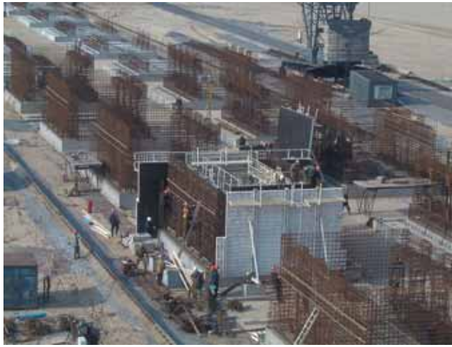
Photo 3 Installation du coffrage des voiles de casemates Shuttering the Walls of the Storage Modules
