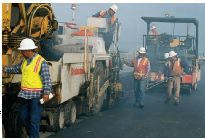
Application des enrobés bitumineux 0/37,5 mm
