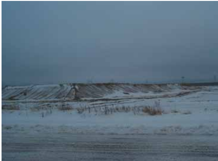
Photo 1 Consolidation de sol par préchargement
