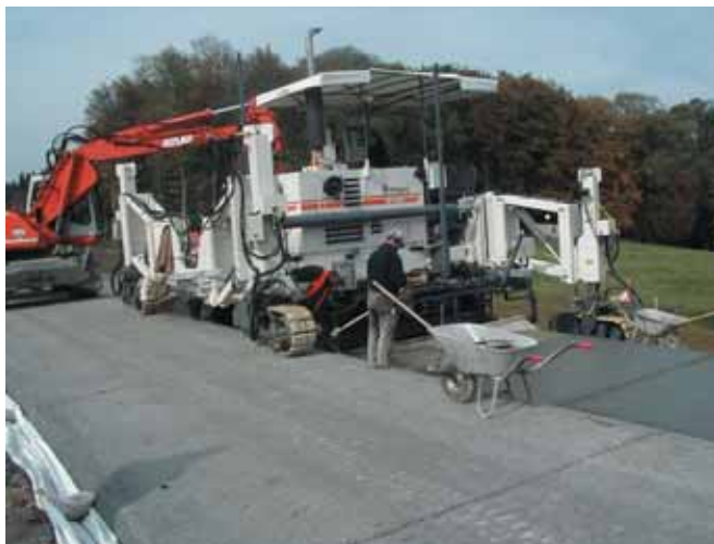
Photo 4 Construction de la couche de fondation à la slip form
