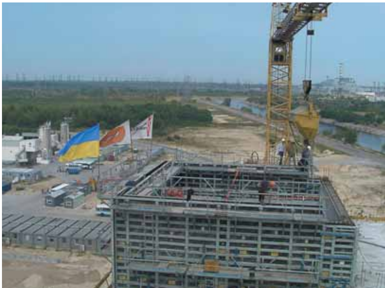
Photo 12 Usine de conditionnement : cérémonie du dernier béton Processing Plant : Last Concrete Celebration
