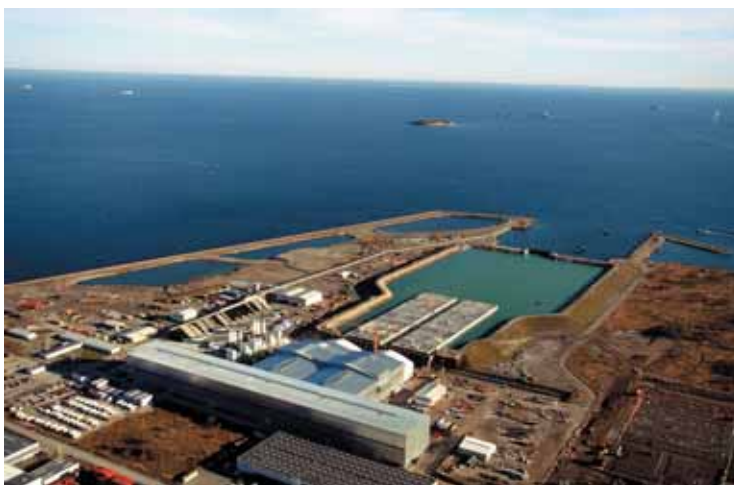
Photo 6 Vue du bassin de mise en flottaison et de l'atelier de préfabrication View of the float-out basin and the prefabrication workshop
