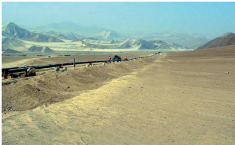
Photo 8 Travaux hors route d'accès Cross country works
