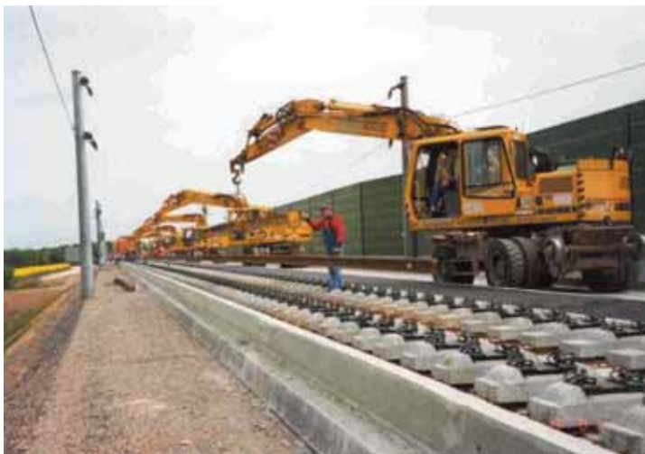
Photo 8 Approvisionnement d'un panneau d'appareil de voie au portique Bringing in a points and crossing panel by gantry crane
