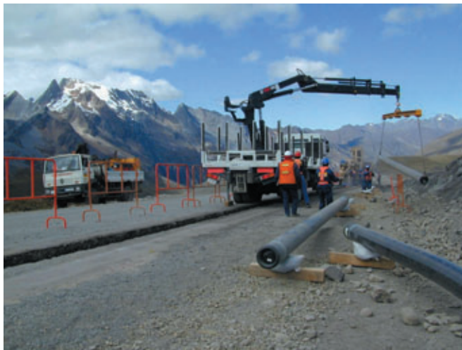
Photo 7 Ouverture de tranchée et bardage de tubes Trenching and stringing
