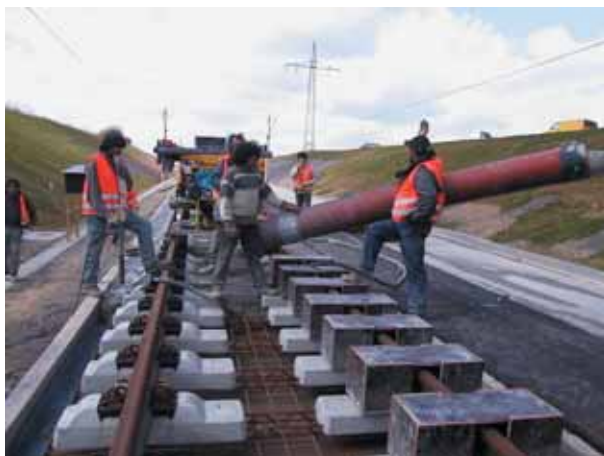
Photo 2 Mise en place manuelle du béton de remplissage
