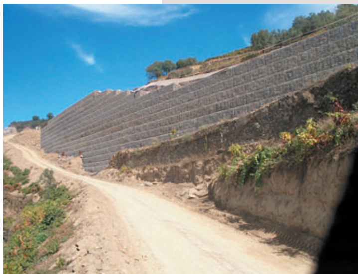
Photo 3 Vue de l'ouvrage MAD 171 View of structure MAD 171
