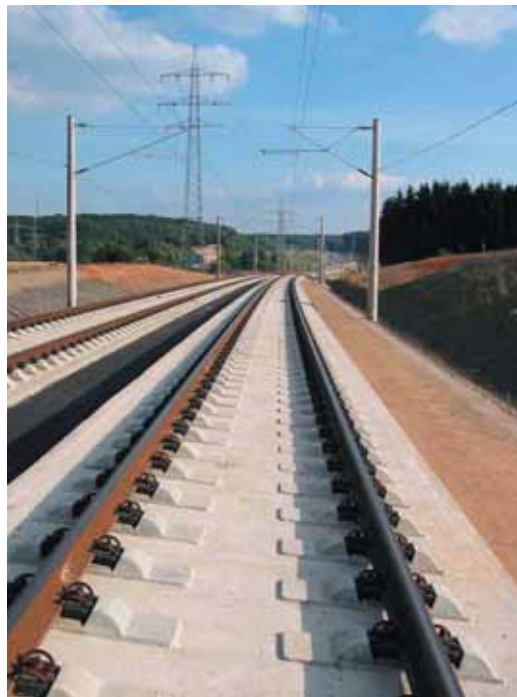
Photo 1 Voie fixe Rheda Berlin HGV terminée
