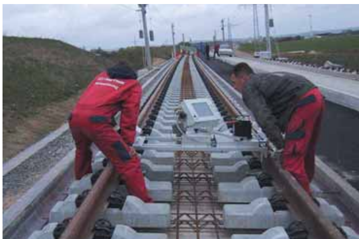
Photo 6 Réglage fin de la voie avec le système Hergie Precision adjustment of the track with the Hergie system
