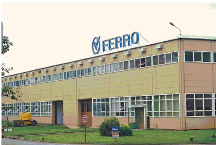
Usine Ferro. Vue générale du bâtiment. On peut voir en partie haute les ancrages des nouveaux câbles de précontrainte
