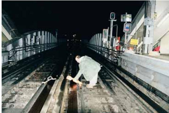
Mise en place des appareils de sécurité suite à la consignation de traction. La coupure du rail répond à une procédure précise, réalisée par du personnel formé par un service spécialisé de la RATP
