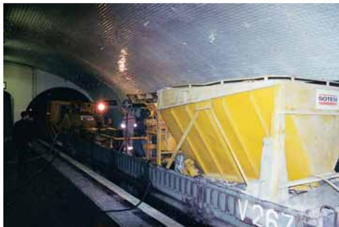
Trains de travaux pour traitement d'injection : une centrale montée sur plusieurs wagons afin de s'affranchir des contraintes liées à l'environnement extérieur
