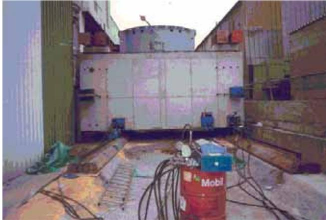
Usine Plâtres Lafarge. Déplacement du nouveau massif préfabriqué à l'aide de pousseurs hydrauliques. La largeur de passage disponible est extrêmement réduite par rapport au gabarit du bloc (moins de 20 cm par côté)
