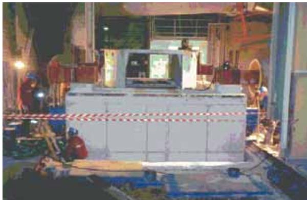
Usine Plâtres Lafarge. Descente du massif dans la fosse. La nouvelle embase métallique du broyeur est déjà en place sur le bloc préfabriqué
