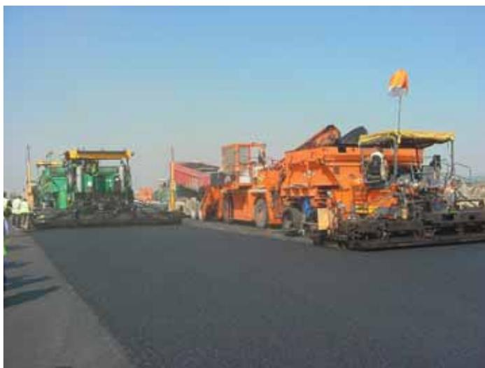
**Les finisseurs destinés à réaliser les EME étaient guidés par un plan laser**
