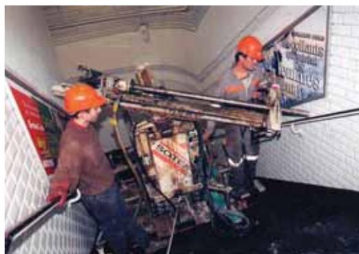
Sondeuse de reconnaissance pour les accès : une machine compacte qui peut être acheminée sans démontage à l'intérieur des enceintes du métro
