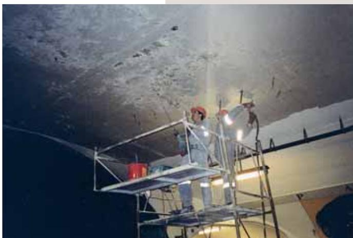
**Travaux d'injection de résine pour étanchéité : équipe réduite et matériel léger**
