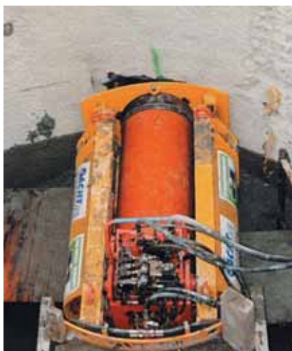
Microtunnelier, puits d'entrée Microtunneller, entry shaft
