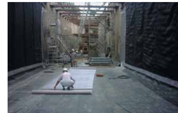
Mise en place de l'étanchéité du cadre de la structure interne
