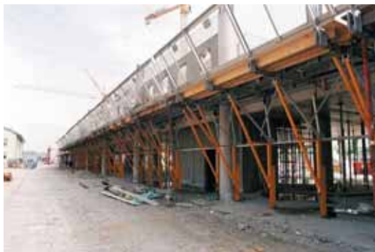
La protection arrière de la tribune ouest avec des plates-formes PRM
