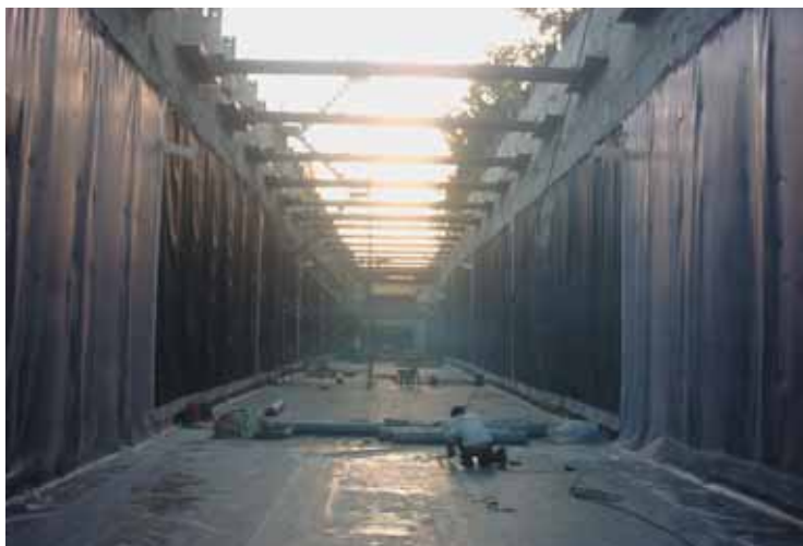
Etanchéité du cadre intérieur station métro Waterproofing the inside frame of the metro station
