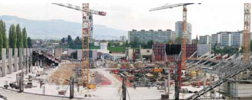
Vue d'ensemble avec le virage sud-ouest en phase d'achèvement
