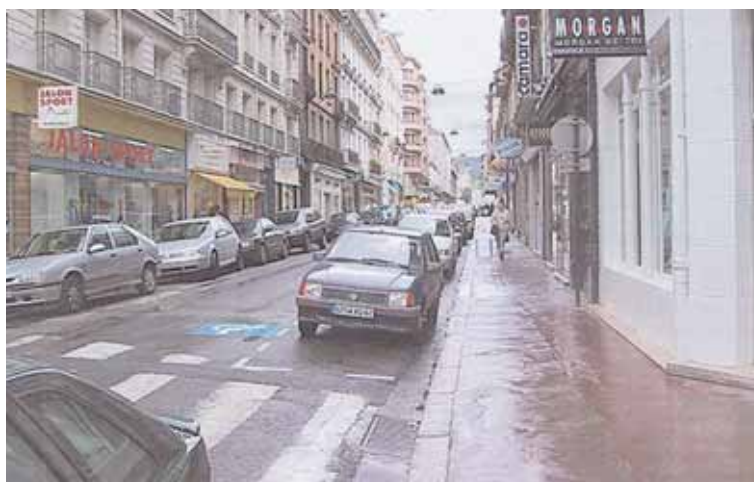
Photo 1 La rue Michelet avant travaux Michelet Street before the works
