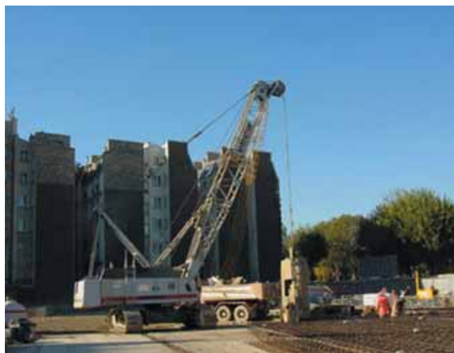
Photo 2 Excavation de la paroi Wall excavation
