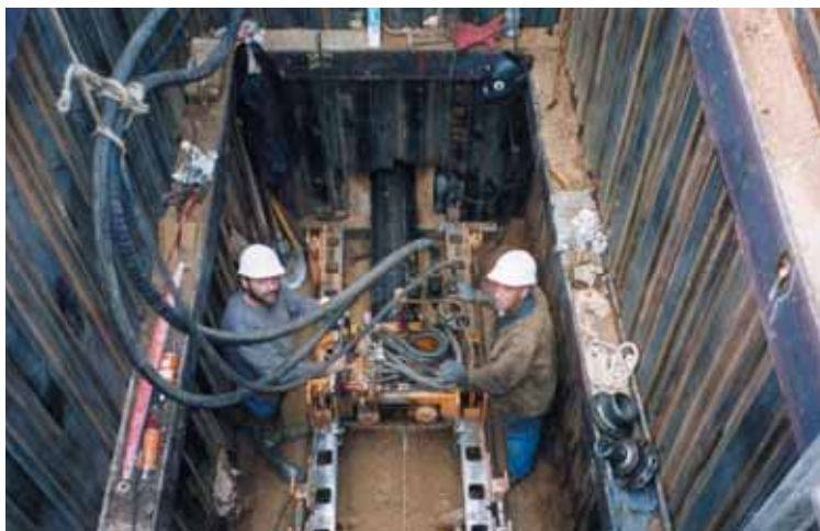
Photo 2 Forage guidé : mise en place des fourreaux acier 323 mm (Meaux)
