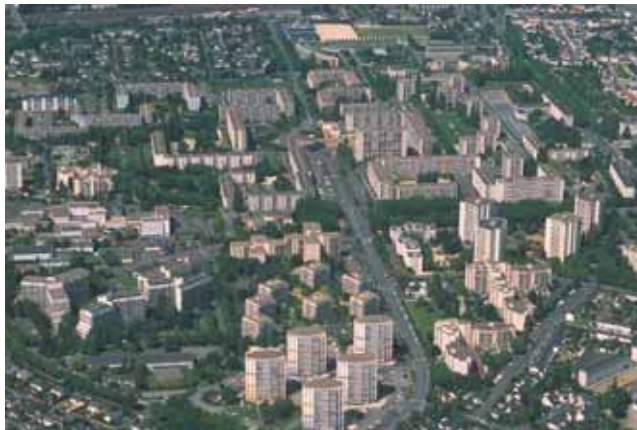
La Roseraie, un quartier ORU (Opération de renouvellement urbain) à réhabiliter selon le développement durable
