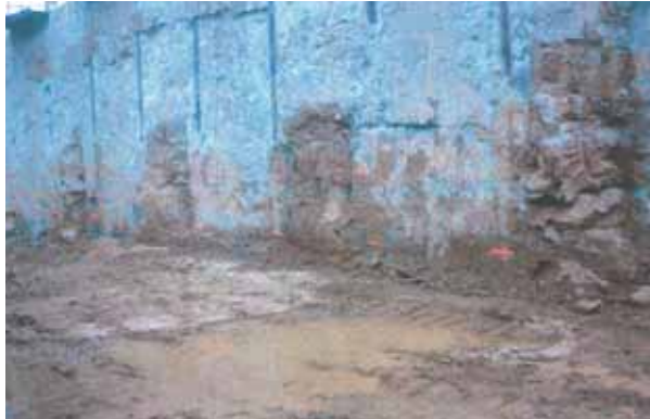
Photo 3 Paroi armée au coulis avec jambes de pantalon Grout reinforced wall with piers
