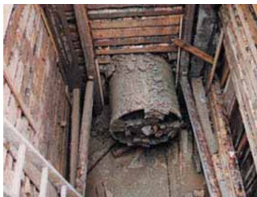
Microtunnelier, puits de sortie Microtunneller, exit shaft
