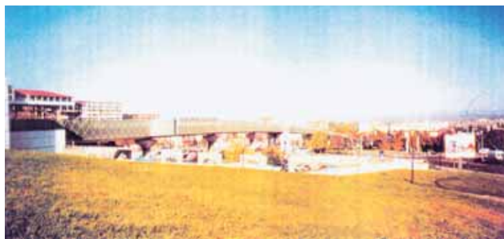
Photo 2 Viaduc Jolimont Jolimont viaduct
