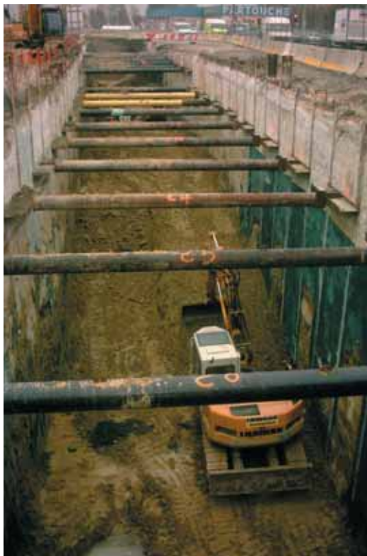
Phase terrassement en section tunnel
