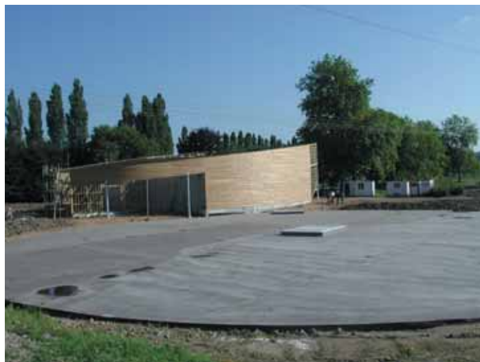
Chantier en cours : au premier plan, bassin en attente de l'aménagement final de surface et au second plan le bâtiment technique en cours de travaux de bardage bois
