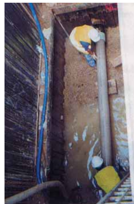
Photo 3 Tubage avec des tuyaux PRV Ø 200 mm (Meaux)
