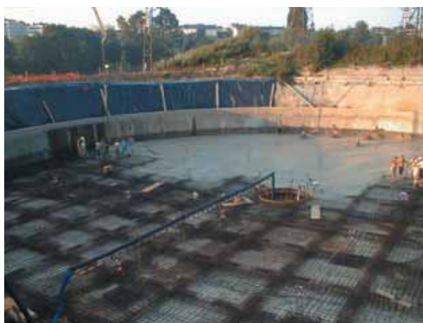
Chantier en cours : opération de coulage du radier
