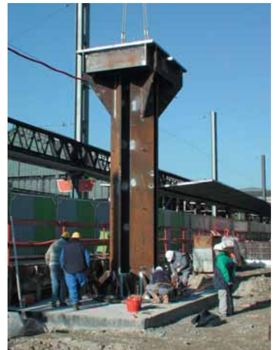
Photo 4 Pose du poteau métallique Installing the metallic column
