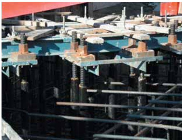
Photo 6 Pose et réglage des tiges d'ancrage Laying and adjustment of anchor rods
