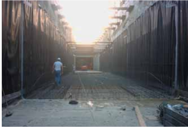
Ferrailage radier et piédroit de la station
