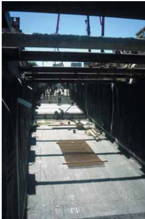
Bétonnage du radier en section tunnel Concreting of foundation raft in tunnel section
