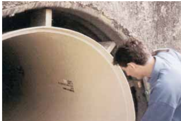
A10 - Coulombiers. Mise en œuvre d'éléments préfabriqués en PRV
