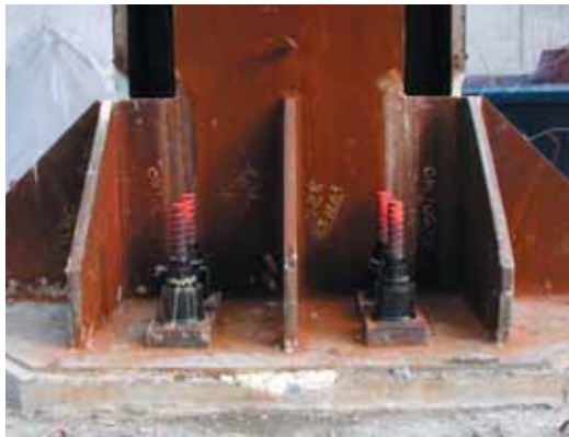
Photo 5 Base du poteau métallique
