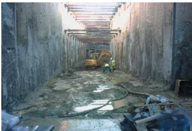
Phase terrassement en section tunnel
