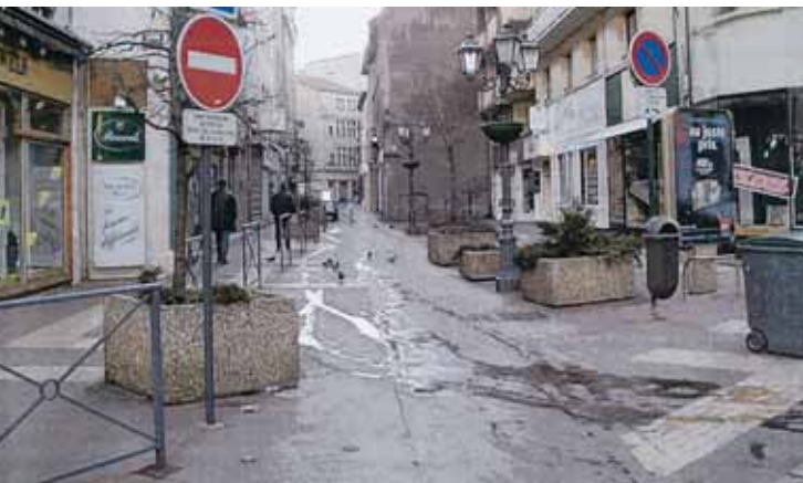
Photo 3 Voie piétonne avant travaux Pedestrian street before works
