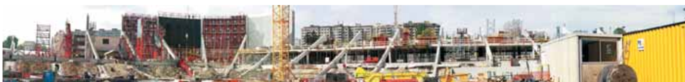
La tribune ouest est prête pour recevoir les premiers gradins préfabriqués
