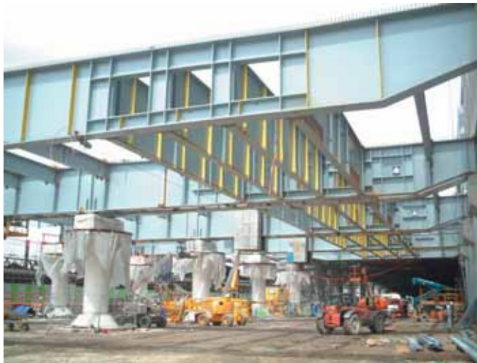
Photo 2 Percements dans les poutres principales Holes drilled in main beams
