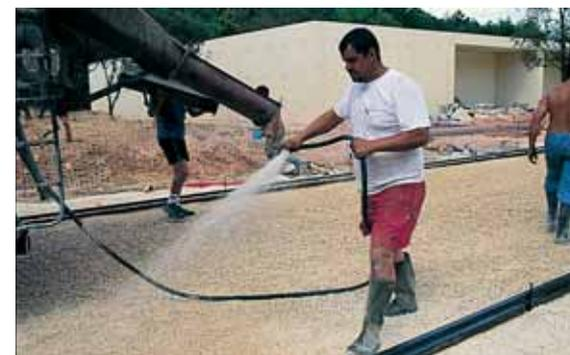
Humidification de la couche support en tout-venant compacté avant le coulage du béton
