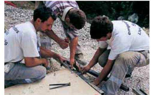
Mise à la forme des coffrages en tube d'acier avant le coulage du béton
