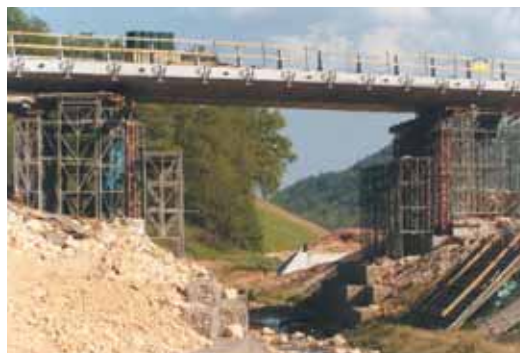
Photo 9 Ouvrage de franchissement du Durand Structure crossing the Durand
