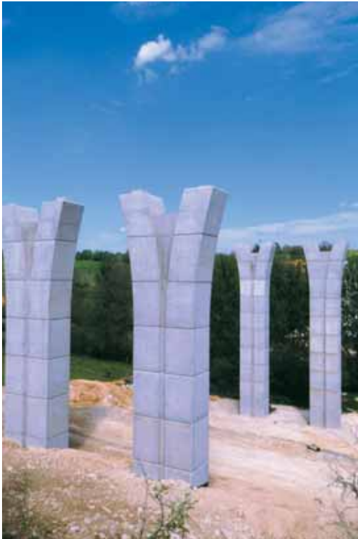
Photo 4 Les piles du viaduc The viaduct piers
