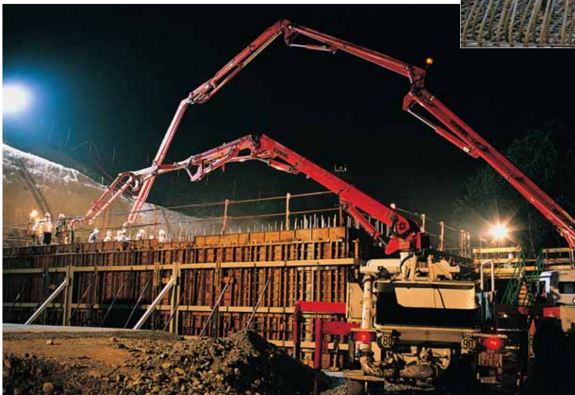
Bétonnage de la semelle de nuit (décembre 2001)
