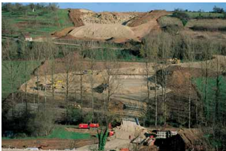
Viaduc du Douime. Les travaux préparatoires ont démarré à Azerat à la fin 2001
