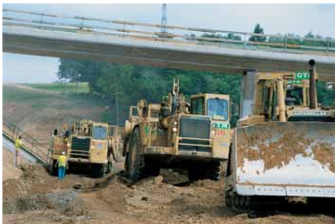
Atelier de terrassements sur la commune de Naves en Corrèze
