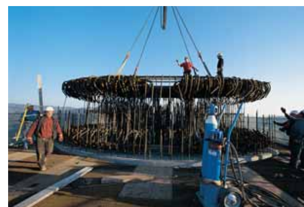
Ferrailage sur pile Iron reinforcement on pier
