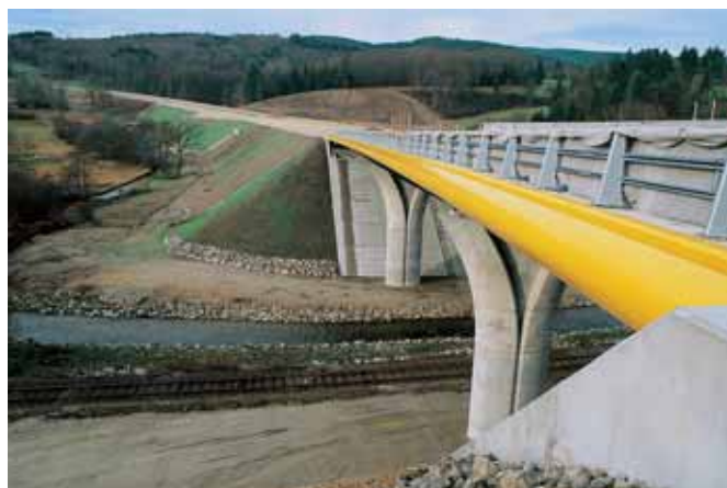
Le viaduc de la Soudeillette The Soudeillette viaduct
