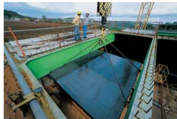
Mise en place d'un des neuf panneaux coffrants
