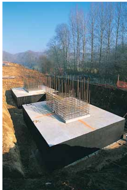
Photo 3 Les fondations du viaduc The viaduct foundations
