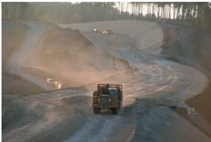
Photo 1 Terrassement dans les coteaux calcaires Earthworks in the limestone hills
