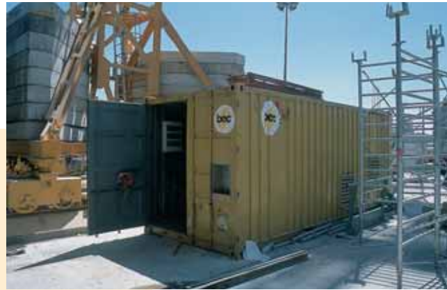
Photo 5 Container énergie Energy container
