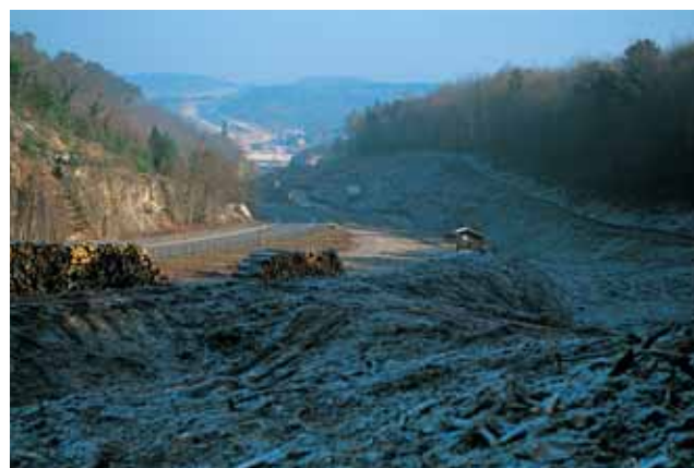
Travaux anticipés entre St-Laurent-sur-Manoire et le col d'Atur
