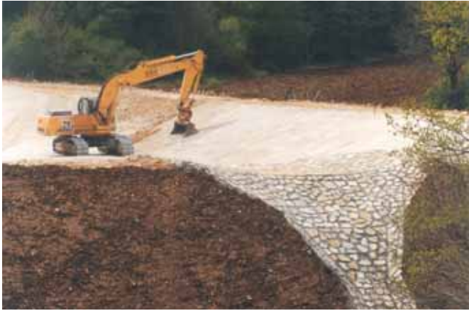
Photo 10 Finition d'un bassin Finishing a pond
