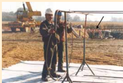
Photo 8 Zone de préfabrication des ferrillages, protection des zones de travaux par rubalise Iron reinforcement prefabrication area, protection of work areas by "rubalise" markers
