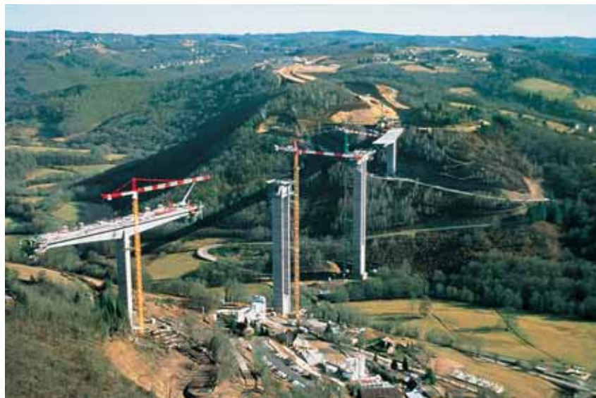
Vue générale de l'ouvrage en construction
