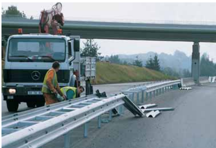
Mise en place des glissières de sécurité
