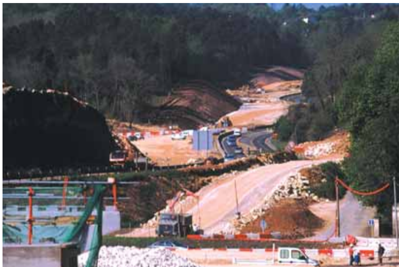
Photo 4 Terrassements à l'extrémité est de la section
