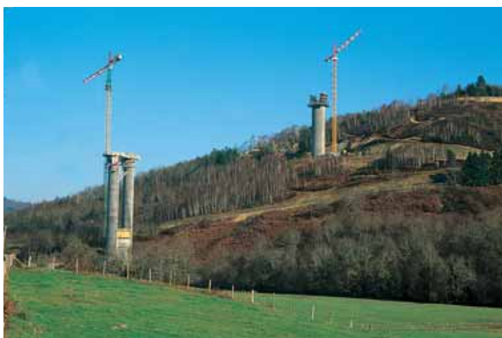
Piles 4 et 5 sur le Puy des Angles Piers 4 and 5 on Puy des Angles
