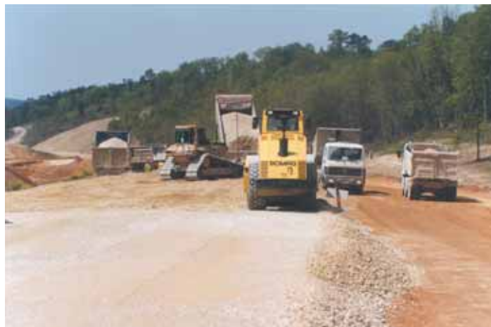
Photo 7 Mise en œuvre de la couche de forme Application of the improved subgrade
