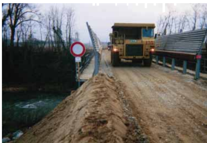
Photo 4 Protection des rivières protection des ouvrages de franchissement provisoires pour éviter la projection de boues dans les rivières traversées
