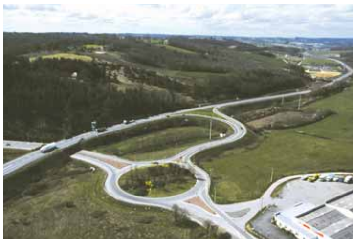
Photo 2 Echangeur de Périgueux Sud Périgueux South interchange
