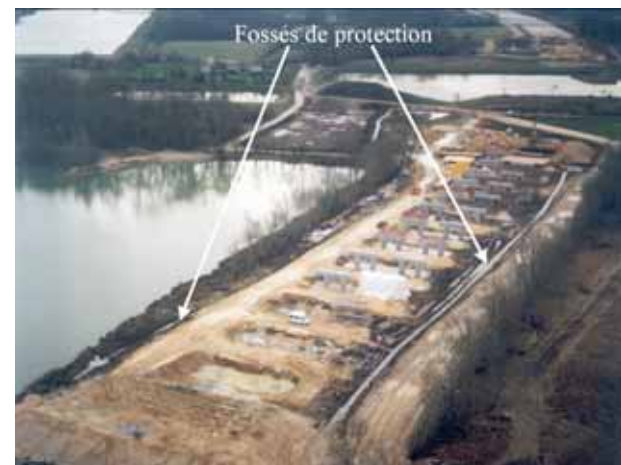
Photo 7 Des fossés de récupération des eaux de ruissellement et des eaux de plate-forme ceinturaient le chantier afin d'éviter toute détérioration des nappes phréatiques et des cours d'eau voisins, par des fines ou des huiles de décoffrage Ditches for recovering runoff water and roadway water surrounded the site in order to avoid any damage to the nearby water tables and watercourses, by fines or shuttering removal oils
