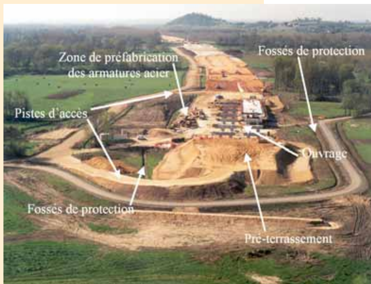
Photo 6 Organisation générale du chantier General organisation of the site
