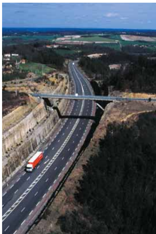
Photo 3 Pont-béquilles au col du Rolet Portal bridge in Col du Rolet pass
