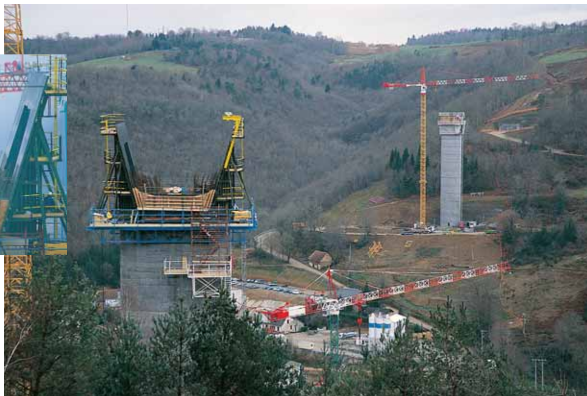
Coffrage du voussoir sur pile 5 Shuttering of segment on pier 5
