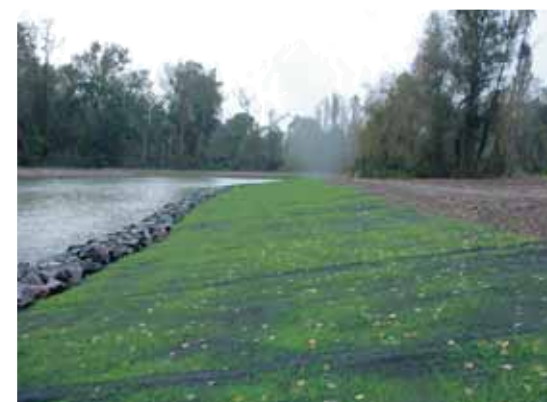
Polder d'Erstein : détail des protections des berges Erstein polder : detail of bank protection systems
