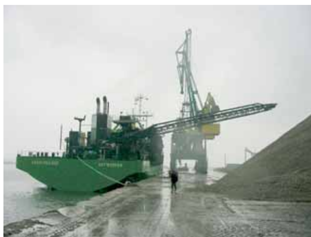
Photo 5 La DAM Charlemagne. Ses cent un mètres de long et sa capacité de plus de 5000 m 3 en font la plus grande d'Europe The Charlemagne sea access channel breakwater. With a length of one hundred and one metres and a capacity of over 5,000 cu. m, it is the largest in Europe
