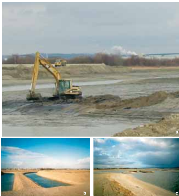
Photo 2 Nouveau reposoir. a) Terrassement des sables vasards. b) Talus et fossés de protection du site après travaux. c) Îles et étendue d'eau artificielles après travaux
