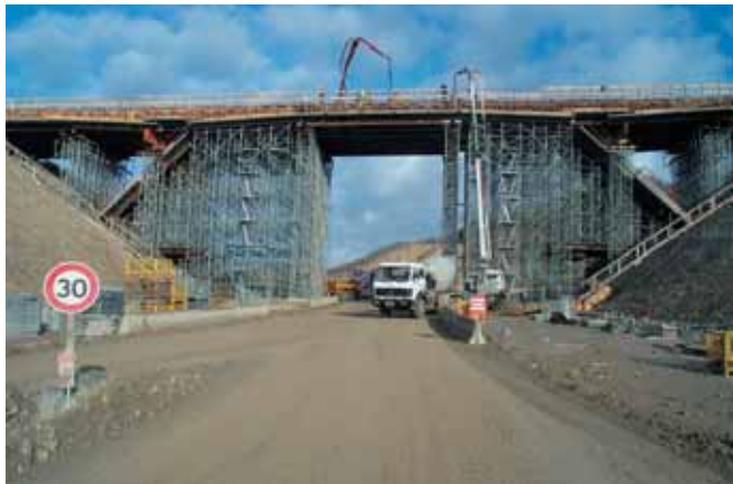
Photo 6 Pont à béquille PS 2160. Bétonnage du tablier
