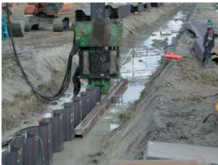
Photo 3 Réalisation du mur de quai Construction of quay wall
