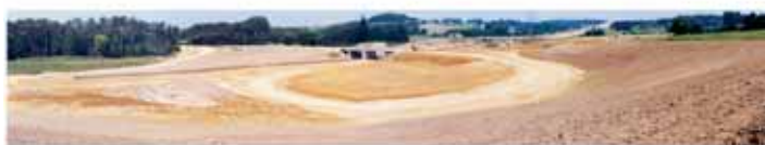
Exemple de terrassement : échangeur d'Ecomomy - A.28 - COFROUTE
