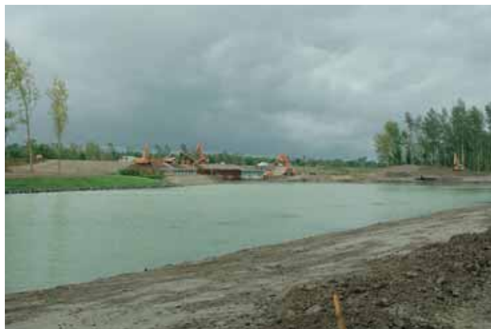
Polder d'Erstein : bassin dissipateur d'énergie en travaux
