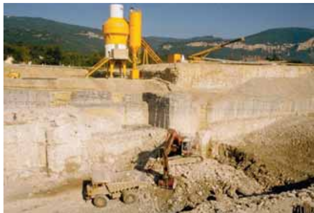
Photo 3 Fouille de Saut Brenaz - Tir séquentiel non électrique en mines ordinaires de 115 mm x 6 m (1984)
