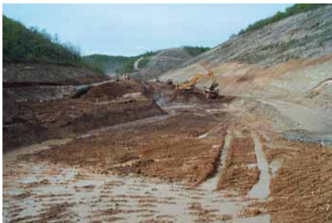
Photo 5 Terrassement dans la bêche R165 Coste Rital
