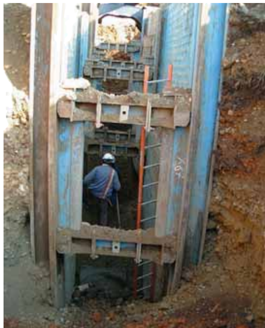
Blindage double glissière. Tranchée profonde
