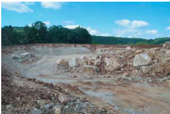
Photo 4 Déblai D143 Le Prats. Calcaire en blocs métriques avec des veines et des incrustations d’argiles rouges
