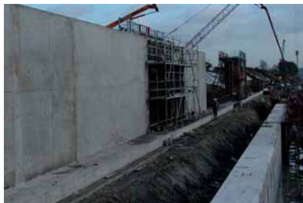
Photo 1 Mur de quai et mur de soutènement de la zone fluviale en construction
