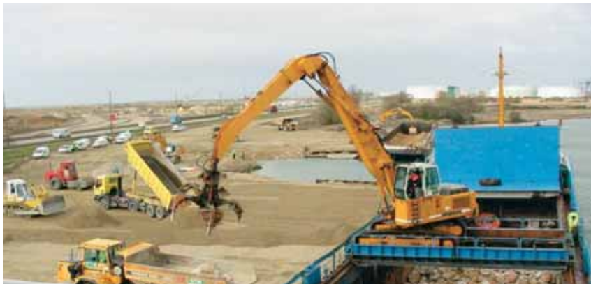
Photo 9 Au premier plan : quai maritime provisoire, déchargement d'enrochements durs. En arrière plan : quai fluvial provisoire, déchargement d'une barge de tout-venant silico-calcaire
