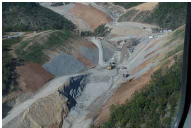
Photo 1 Terrassement du déblai D158 Larreguade
