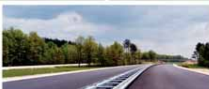
Végétalisation et terrassement A.85 COFROUTE
