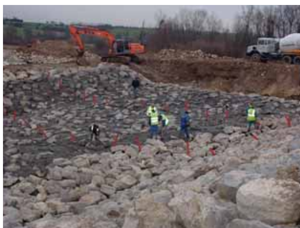
Allan : bétonnage des enrochements. Mise en place des barbacanes
