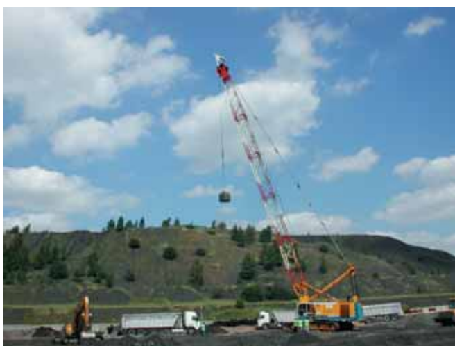
Photo 4 Réalisation des plots pilonnés Construction of rammed blocks
