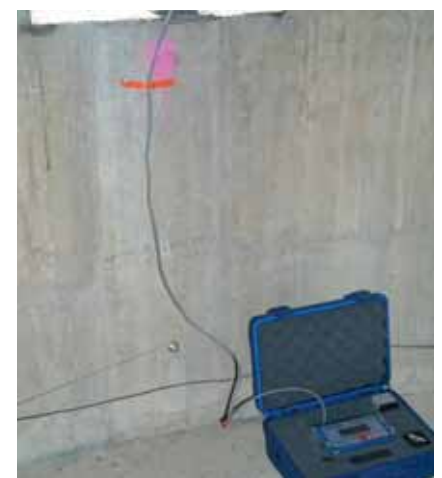
Photo 4 Station de télémessure GSM GSM telemetry station
