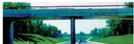
Exemple de terrassement : A.85 - COFROUTE
