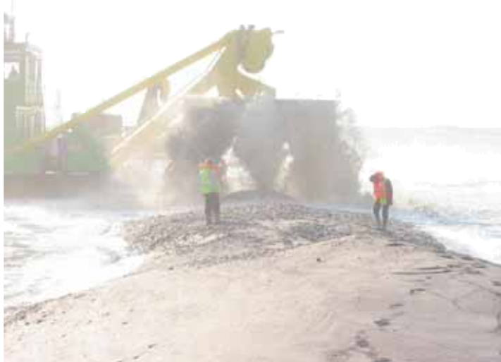
Photo 4 Mise en place du soubassement par le ponton diffuseur Bayard 2 Laying the base by spreader pontoon Bayard 2
