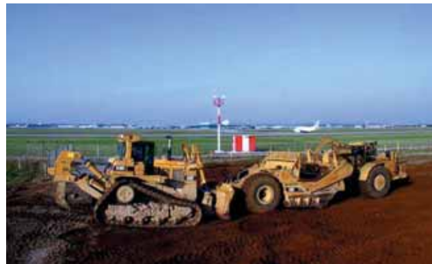
Photo 1 Décapage à proximité des pistes
