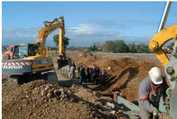
Visite de chantier. Tranchée à 6 m de profondeur
