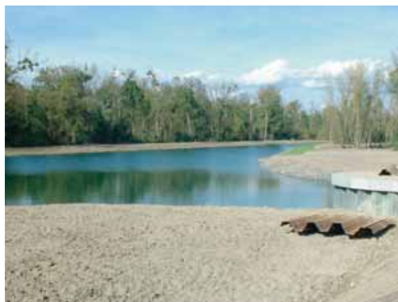
Polder d'Erstein : bassin dissipateur achevé Erstein polder : completed stilling basin
