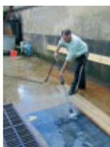
◆ Revêtement par géomembranes des ouvrages hydrauliques en béton : endommagement par nettoyage haute pression
