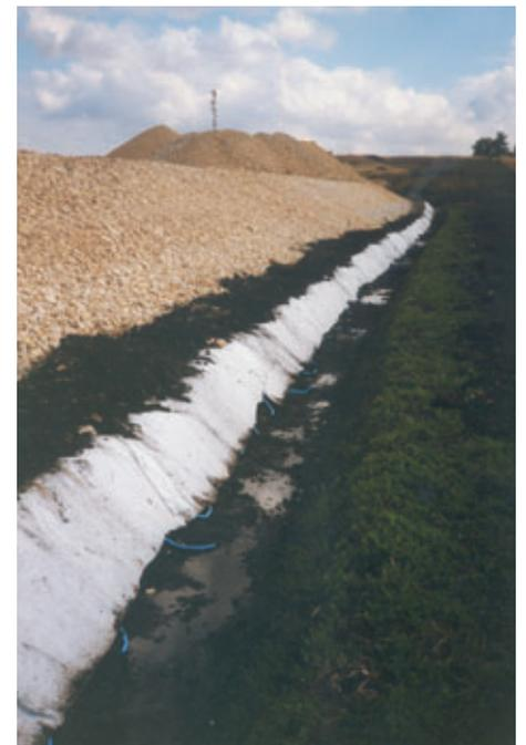
Vue d'ensemble de la construction du remblai sur la base drainante synthétique Teradrain
