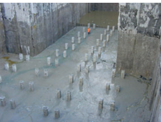
Photo 4 Le béton immergé et les poteaux d'ancrage du radier définitif The submerged concrete and the anchorage columns for the final foundation raft
