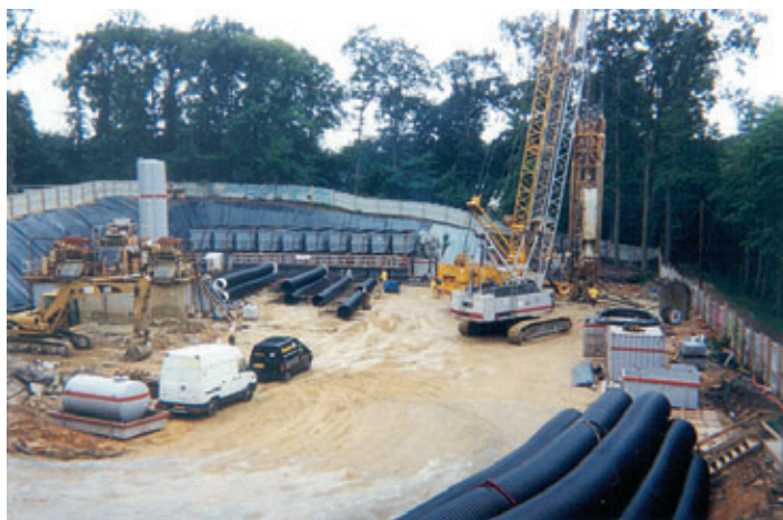
Photo 1 Vue générale General view
