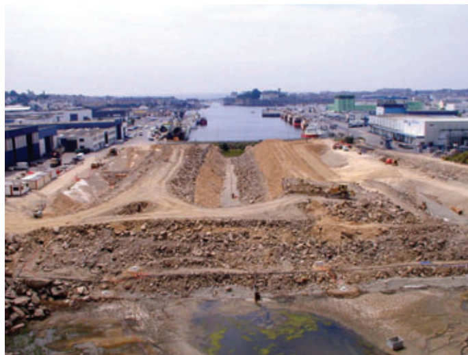
Remblai de préchargement pour consolidation des limons Pre-loading fill for silt consolidation
