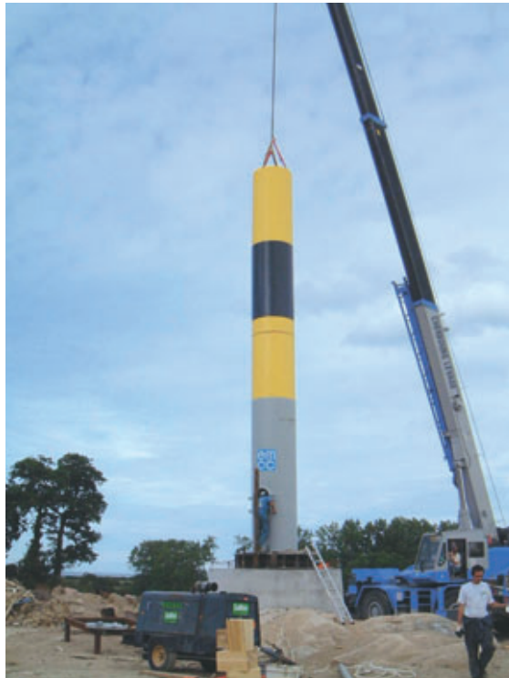
Photo 5 Validation à terre de la procédure de mise en place de la tourelle Validation of the turret installation procedure on land
