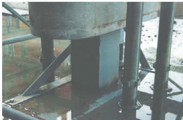
Photo 2 Principe de calage des poteaux béton armé dans le parking avec option d'un vérinage ultérieur
