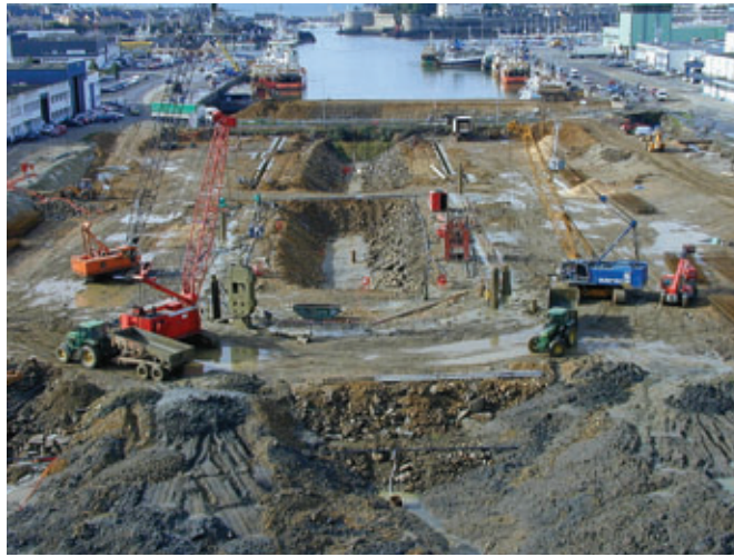
Réalisation de la paroi moulée Construction of the diaphragm wall
