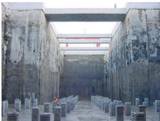
Photo 5 Le puits de départ The original pit
