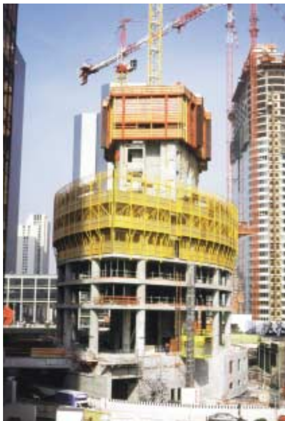
Photo 5 Noyau en avance de trois niveaux sur les planchers Advanced core of three levels on the floors
