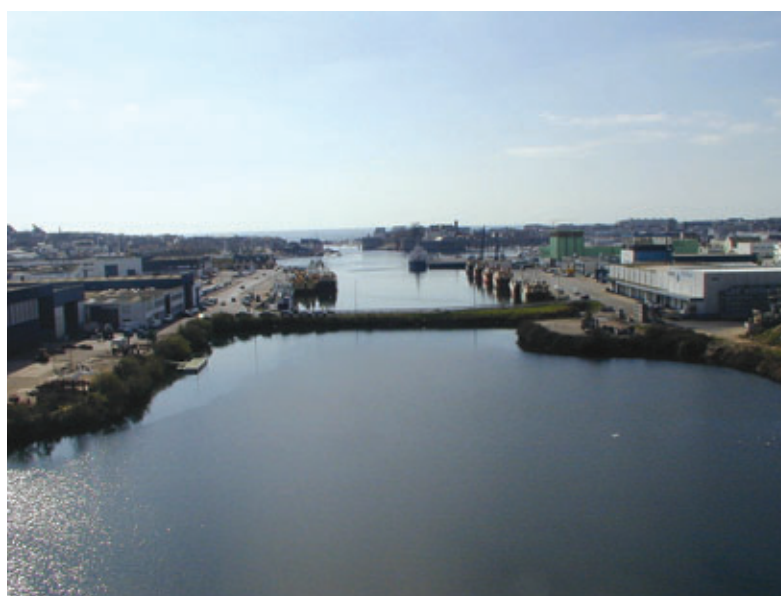
Etat des lieux avant travaux Site conditions before works
