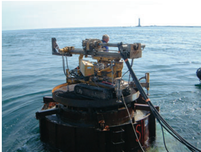
Photo 7 Forage sur site Drilling on site
