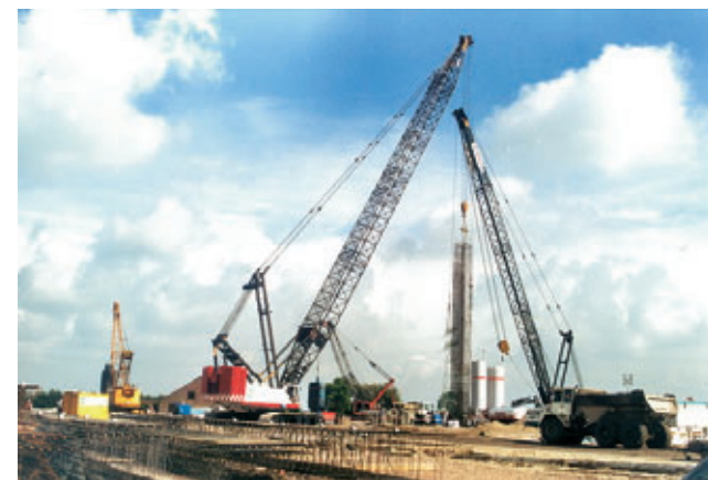
Photo 2 La manutention d'une cage d'armature Handling a concrete reinforcing cage
