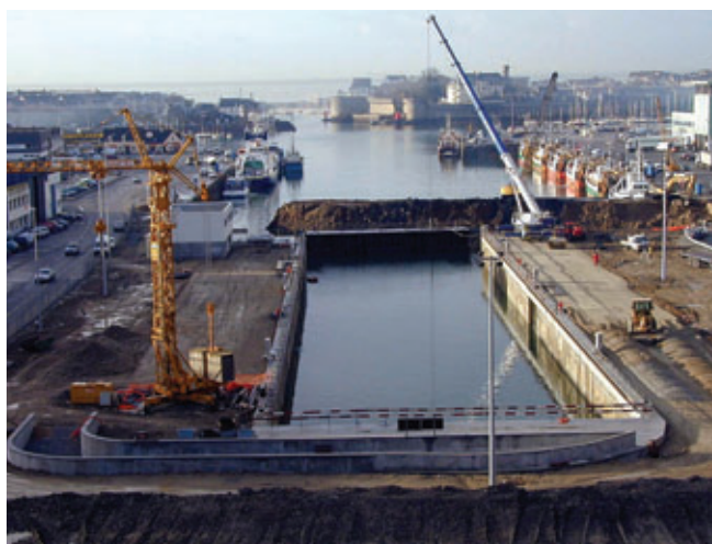
Mise en place de la porte Installation of the lock gate
