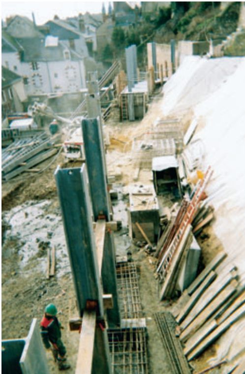
Pose de profilés et construction de la poutre de couronnement
