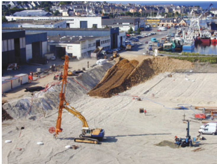
Mise en place des drains Drains installation
