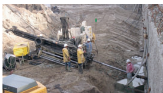
Photo 5 Réalisation des tirants d'ancrage dans la paroi moulée
