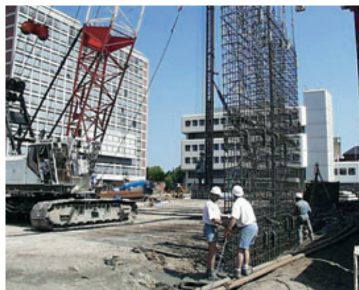
Photo 4 Equipement d'un panneau de paroi moulée avec une cage d'armature Equipment of a diaphragm wall panel with a concrete reinforcing cage
