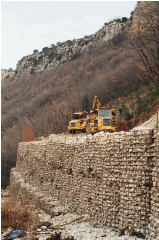
Ouvrage Tervoile piste d'accès P3 en cours de réalisation
