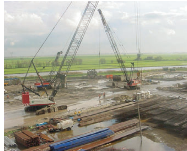
Photo 1 Vue générale du chantier General view of the site
