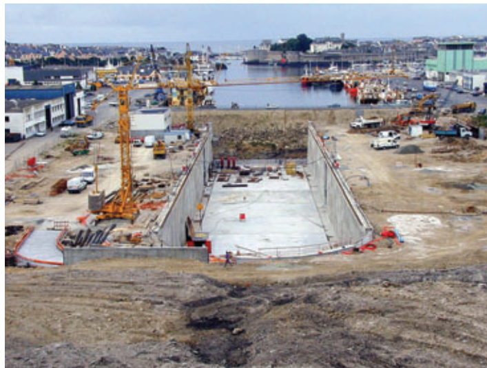
Cale en cours de travaux Dry dock under construction
