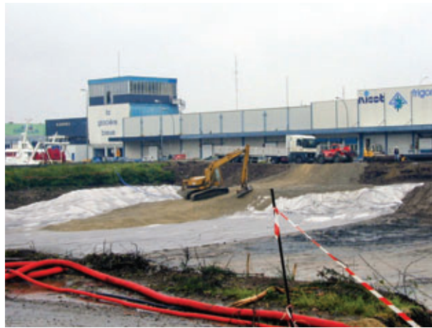
Mise en place de l'anti-contaminant et de la couche drainante Installation of the anti-pollutant and the bottom drain layer
