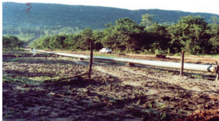
Photo 1 Préparation en fond de vallée de la section de pipeline à tirer dans le trou de forage
