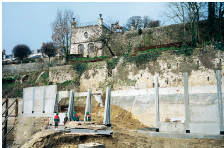
Pose de panneaux préfabriqués Placing of prefabricated panels
