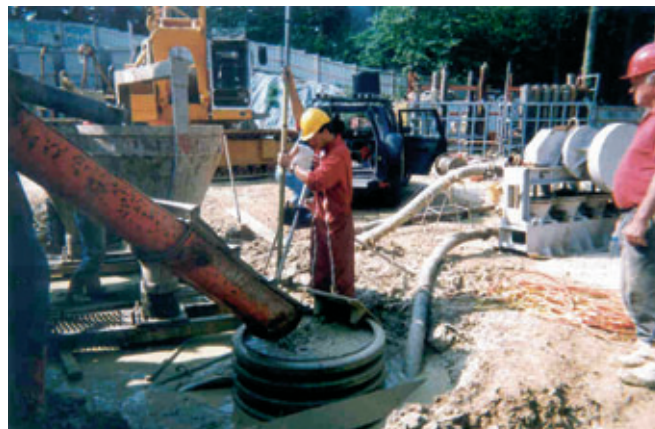
Photo 3 Le bétonnage Concreting
