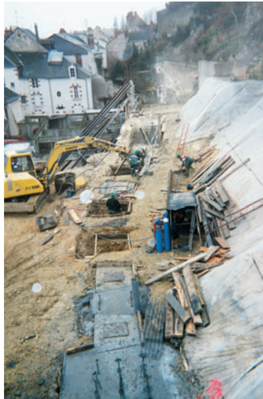
Création d'une plate-forme intermédiaire pour creusement des puits
