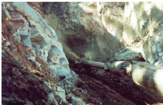
Photo 3 Le début du tirage, côté préfabrication de la conduite Start of drawing, at the prefabrication end of the pipe
