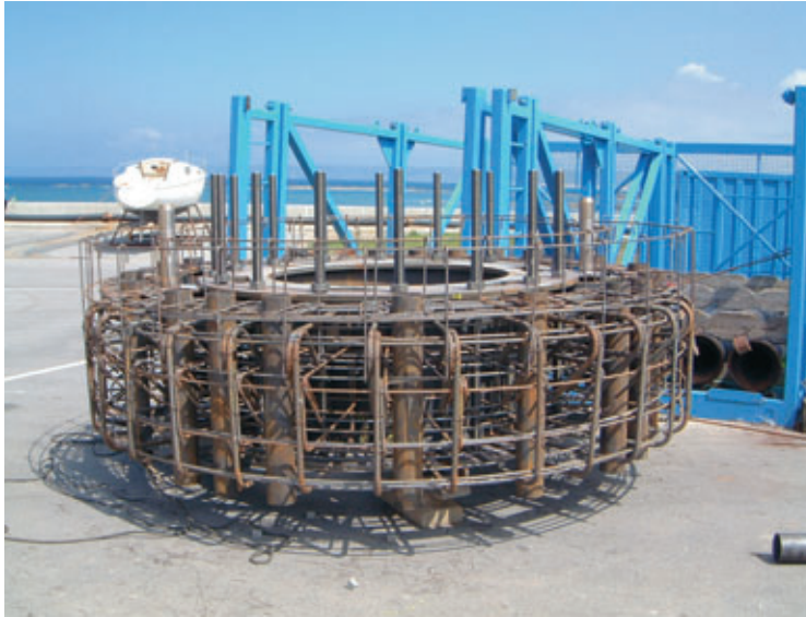
Photo 3 Ensemble préfabriqué bride + goujons d'ancrage + cage d'armatures (on remarque les tubes de réservation pour forages et les deux tiges verticales de fort diamètre destinées au centrage de la tourelle)
