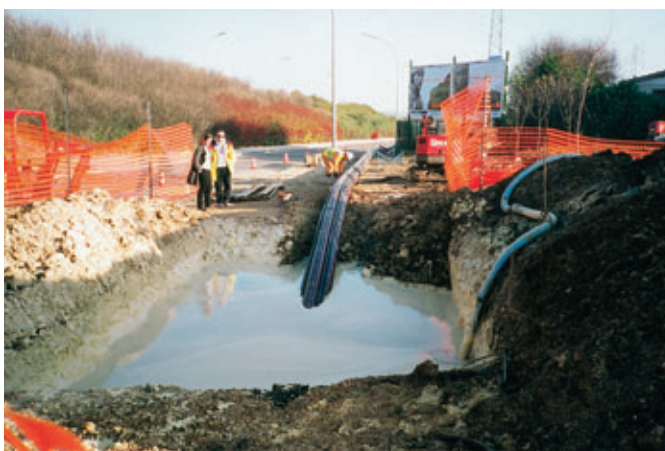
Mise en place d'un fourreau pour câble électrique 90 kV. Fouille d'introduction du fourreau
