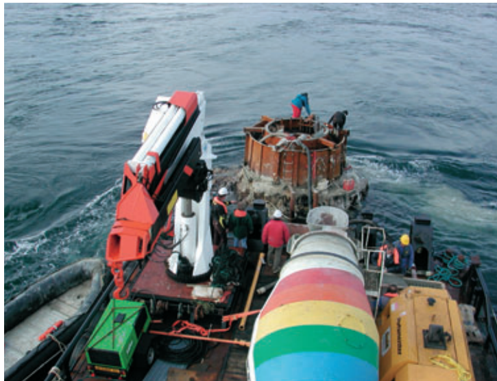
Photo 6 Bétonnage du socle Concreting the base
