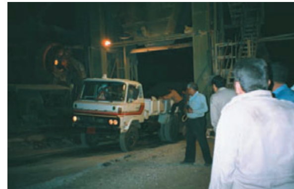
Photo 4 Chargement des enrobés à la centrale (camion de 10 t) Loading of asphalts in the plant (10-tonne truck)
