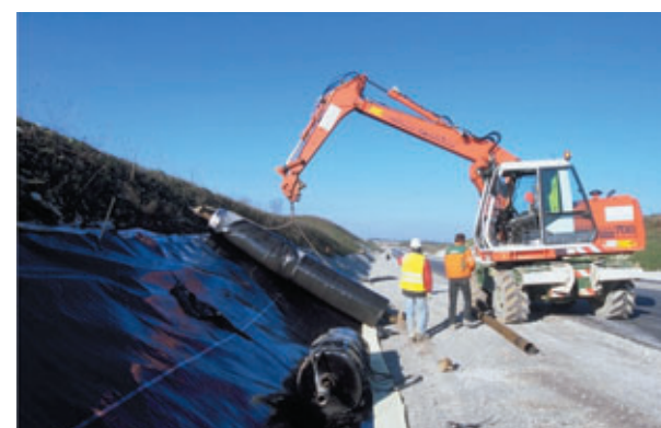
Pose de géomembrane sur talus et cunette
