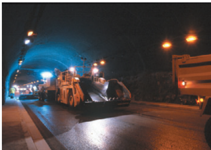
Photo 2 Atelier d'application : alimentateur Franex Application equipment : Franex feeder
