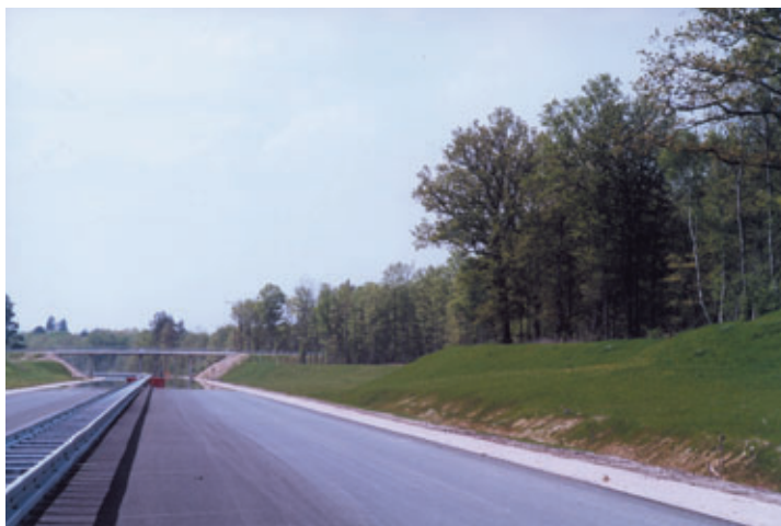
Photo 6 Modèle des déblais élargis Surface pattern of enlarged earth cuts
