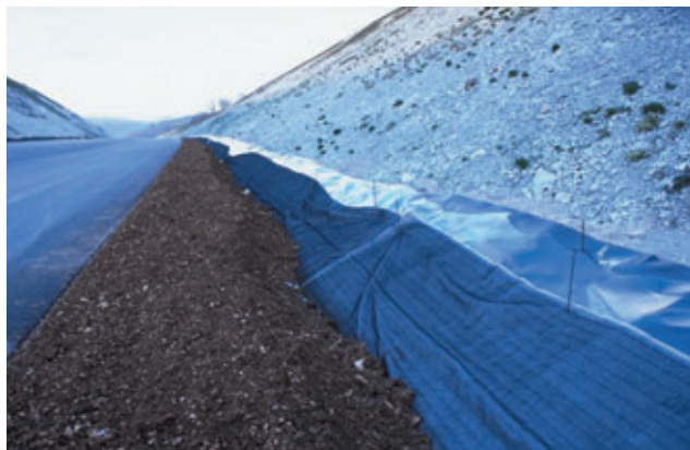
Pose de géomembrane et terre végétale sur talus et cunette
