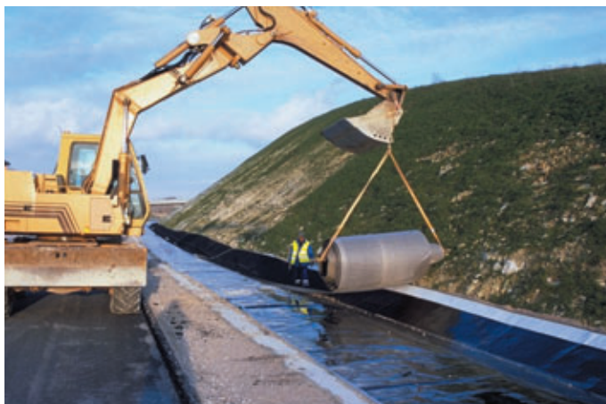
Pose d'Enkamat sur talus et cunette Laying of Enkamat on earth bank and gutter
