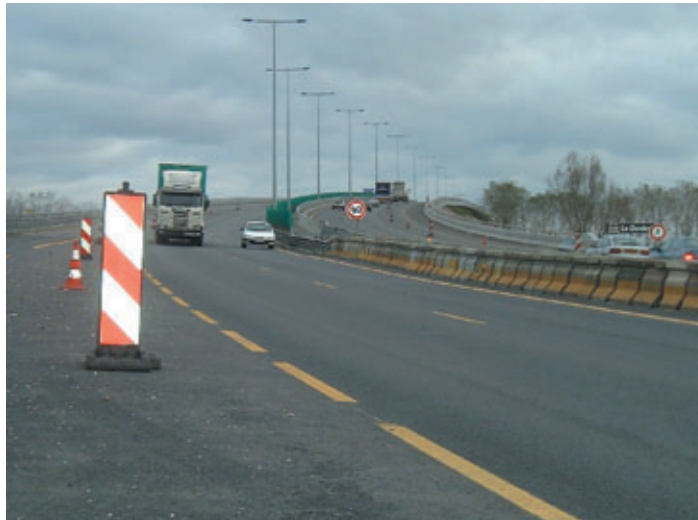
Photo 1 Viaduc sur la Dordogne Dordogne viaduct
