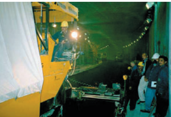
Photo 8 Compactage des enrobés à l'aide de deux cylindres Bomag (BW 141 AD2 et BW 140)
