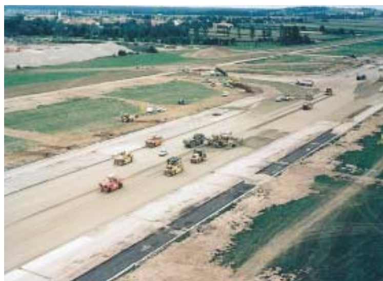
Photo 2 Mise en œuvre du 0/63 Application of 0/63
