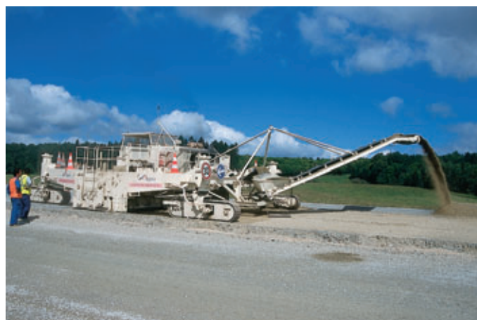
Découpe de la couche de forme à l'autograde et réutilisation des matériaux en assise de BAU Cutting out of the subgrade by Autograde machine and recycling of materials as hard shoulder base reinforcement
