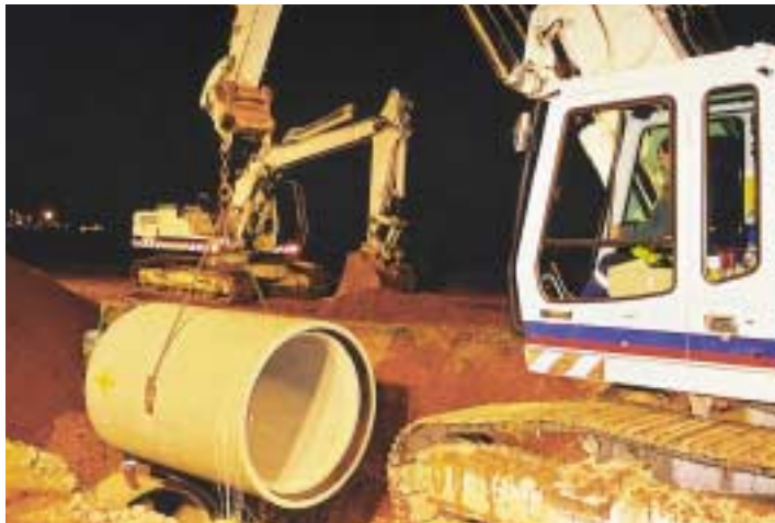
Photo 1 Travaux d'assainissement de nuit Sanitation work by night
