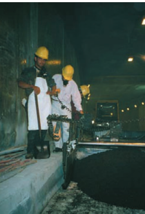
Photo 10 Position du palpeur à ultrason dans le caniveau Position of ultrasonic sensor in the gutter
