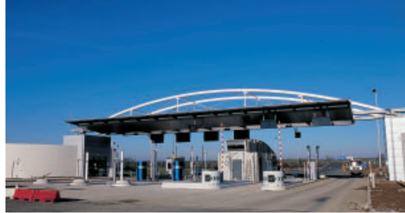
Photo 7 La gare de péage de Cholet nord
