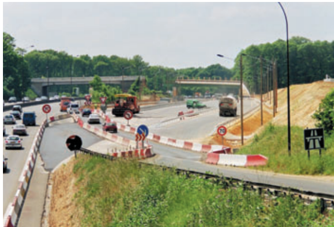
Photo 17 La déviation A13 peu de temps avant sa mise en service
