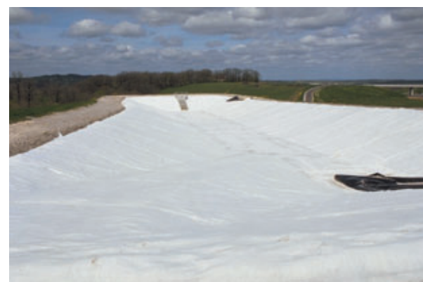
Géotextile sur bassin Geotextile on reservoir
