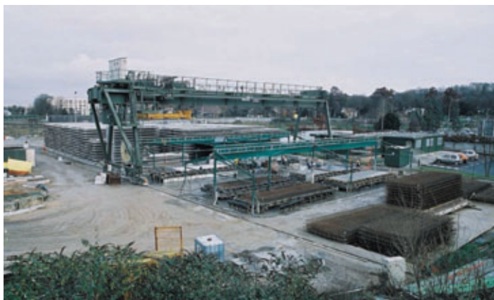
Photo 10 L'aire de préfabrication des dalles
