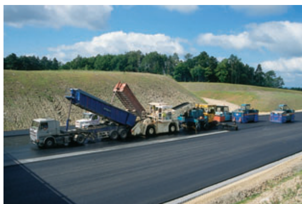
Atelier de mise en œuvre des enrobés Equipment for application of asphalts
