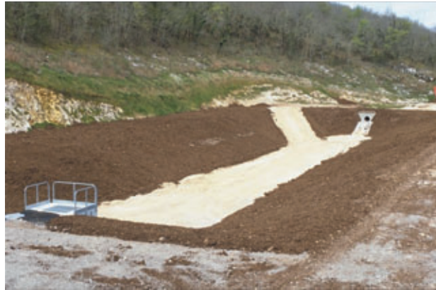
Pose de terre végétale sur bassin avant enherbement Laying of top soil on reservoir before putting under grass
