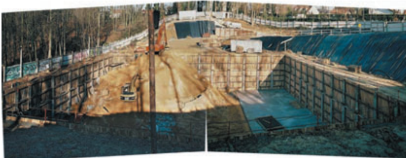
Photo 16 Berlinoise de l'unité de ventilation du Butard Berlin-type wall of the Butard ventilation unit
