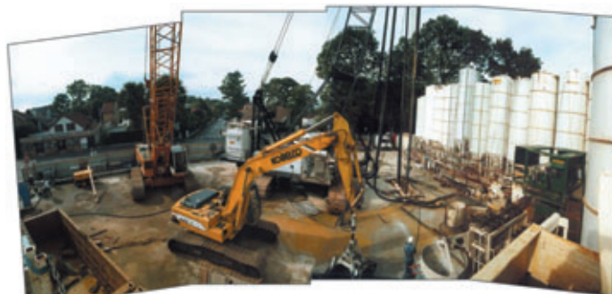
Photo 15 Exécution de la paroi moulée du puits de la place Berthet Construction of the diaphragm wall of the pit in Berthet square
