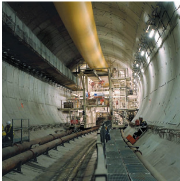
Photo 9 Le tunnel à l'arrière du tunnelier
