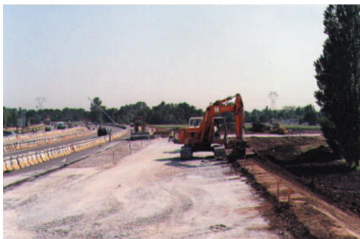
Photo 3 Elargissement du TPC par l'extérieur Widening of the central reservation from the outside
