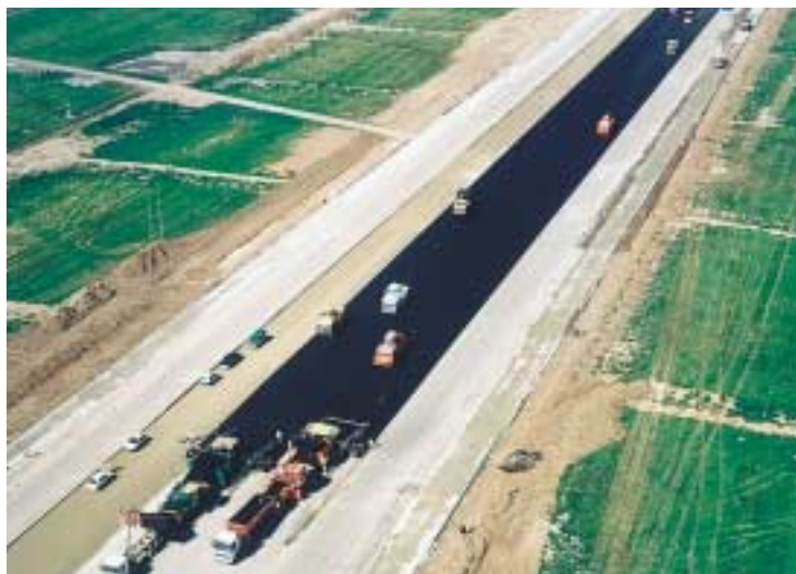
Photo 3 Mise en œuvre de la grave bitume 0/14 Application of bituminous-bound graded aggregate 0/14
