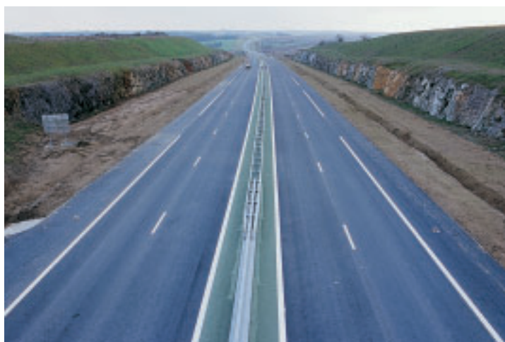
Photo 1 Le déblai D115, entre la barrière pleine voie de Beaulieu-sur-Layon et le viaduc du Layon The D115 earth cut, between the Beaulieu-sur-Layon mainline barrier toll station and the Layon viaduct
