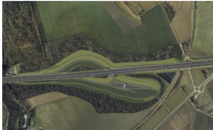
Photo 4 Vue générale du projet - A12 à Bailly
