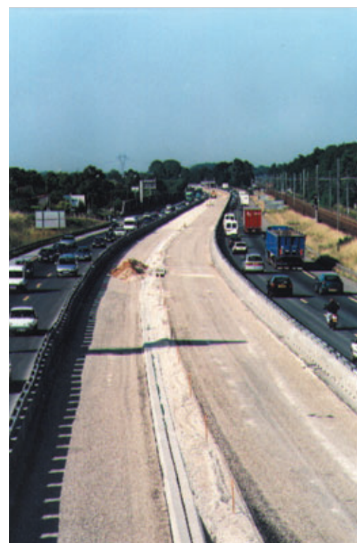
Photo 2 Élargissement du TPC par l'intérieur Widening of the central reservation from the inside
