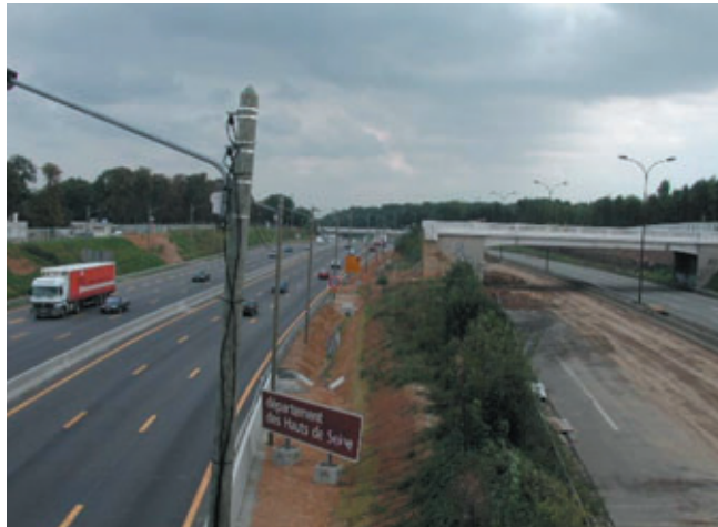
Photo 18 La déviation A13 mise en service
