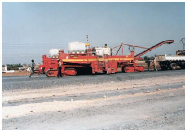
Autograde équipé du système GDP/DPS pour réglage de la couche de forme
