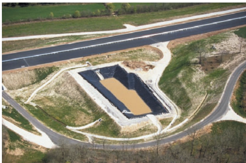
Vue aérienne bassin étanchéifié avec eau Aerial view of waterproofed reservoir with water
