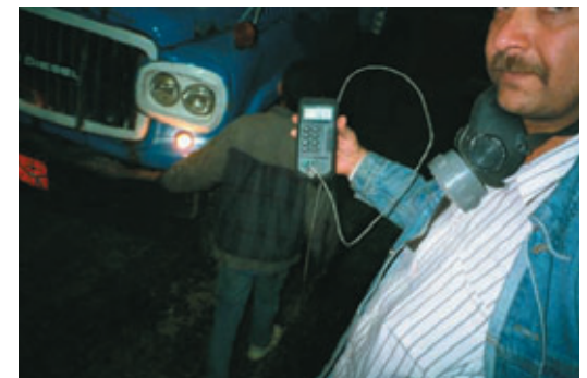
Photo 5 Contrôle de la température des enrobés au déchargement par le contrôle interne Check on temperature of asphalts at unloading by internal inspection
