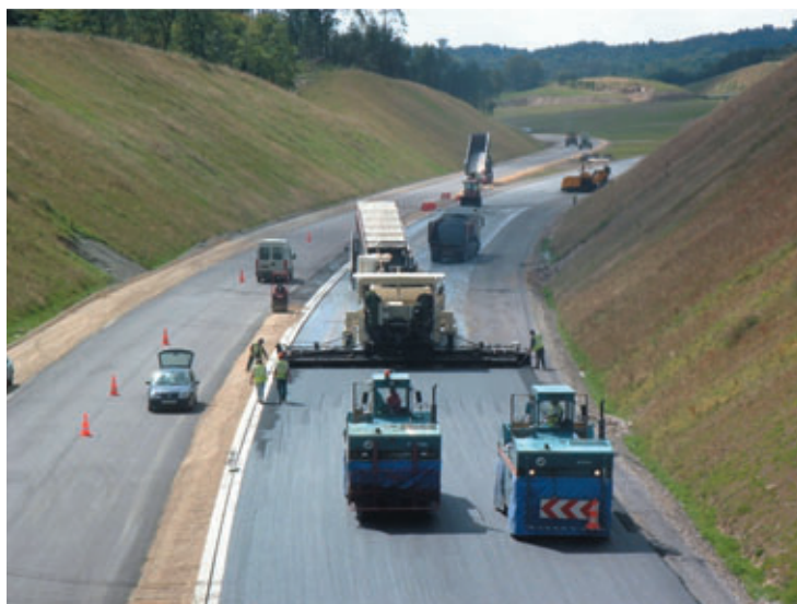
Atelier de mise en œuvre des enrobés en 11,5 m de large Equipment for application of asphalts over a width of 11.5 m
