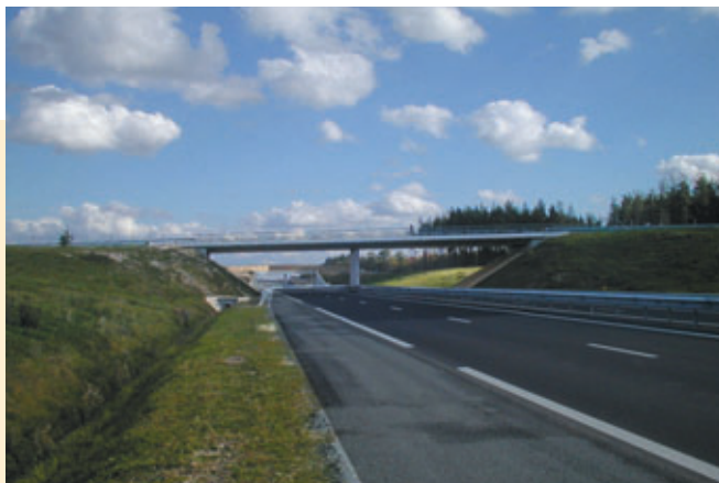
Photos 2 et 3 Passages supérieurs à deux et quatre travées Overpasses with two and four spans
