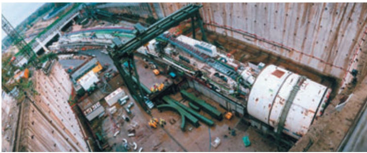
Photo 6 Le tunnelier en phase de montage à Rueil
