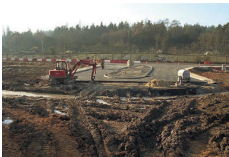
Photo 23 Les travaux d'accès de chantier à Pont Colbert Site access work at Colbert Bridge
