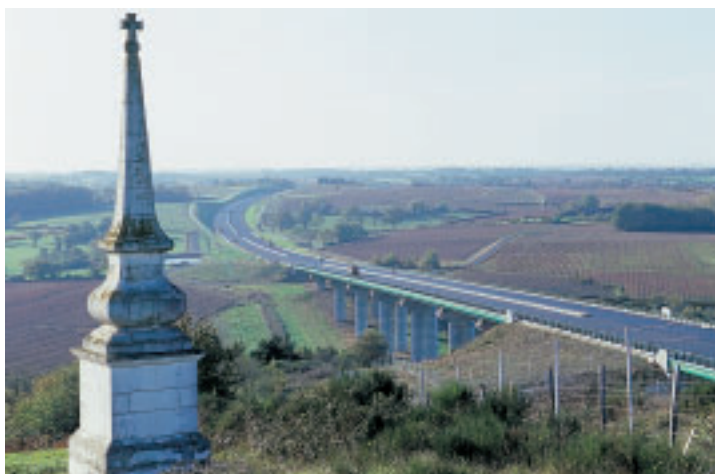
Photo 2 Le viaduc du Layon The Layon viaduct
