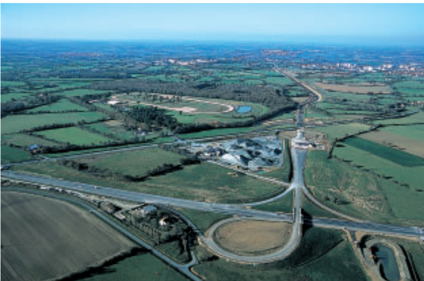
Photo 10 L'échangeur de Cholet sud et au fond, le barreau de raccordement à la RN160 The Cholet South interchange and, in the background, the connecting section to the RN160 highway
