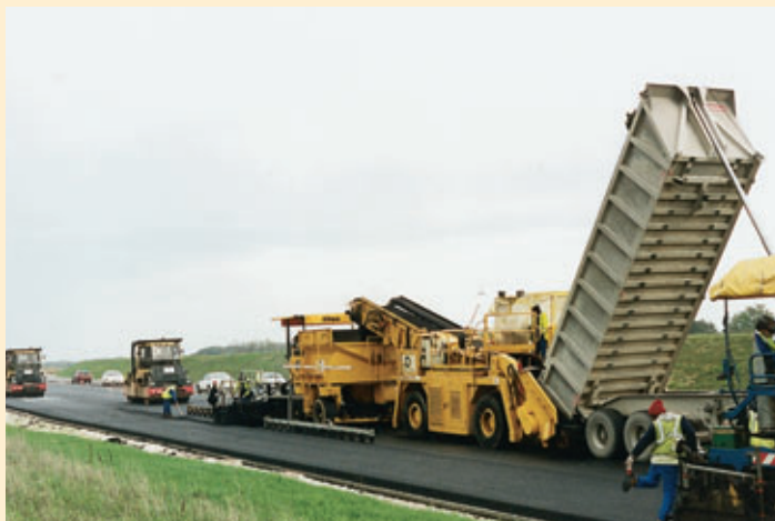
Photo 2 De haut en bas : vues d'ensemble de l'atelier de mise en œuvre (finisseur ABG Titan et alimentateur Franex) sur section courante + ITPC (GB de base)
