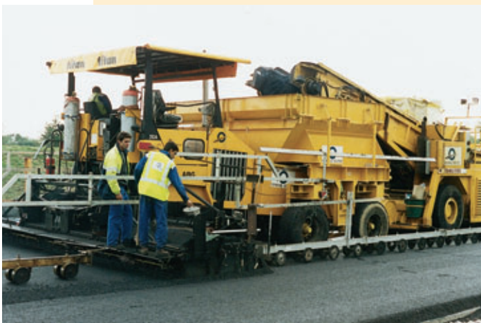
Photo 2 De haut en bas : vues d'ensemble de l'atelier de mise en œuvre (finisseur ABG Titan et alimentateur Franex) sur section courante + ITPC (GB de base)
