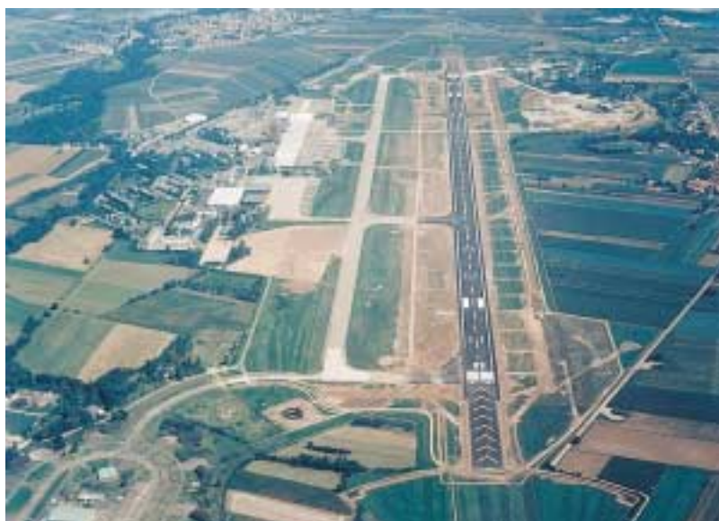
Photo 4 Vue aérienne de la piste terminée Aerial view of the completed runway
