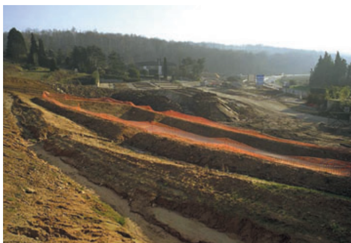
Photo 24 Préterrassements de la zone tête de tunnel Preliminary earthworks in the tunnel head area
