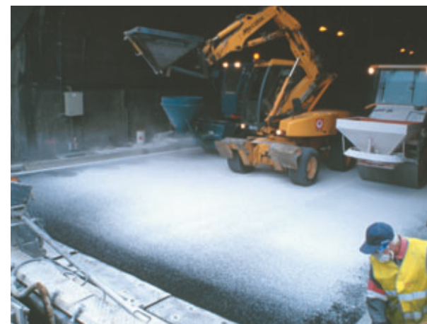
Photo 3 Epannage du sable blanc derrière le finisseur
