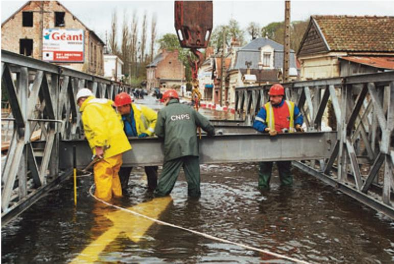
Mise en place d'un pont de secours dans la commune de Pont-Rémy par les agents du Centre national des ponts de secours et les équipes de la DDE de la Somme
