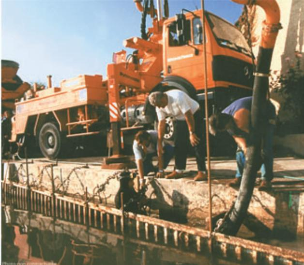
Aux vues des difficultés de réalisation du chantier du Collecteur de Pantin (3ème phase), **Béton de France** a développé en partenariat avec l'entreprise Eiffage un béton de type RMC Hydro. Ce chantier a fait appel à un béton RMC hydro non perméable. Coulé dans des conditions de travail difficiles, la mise en œuvre du béton RMC Hydro a nécessité l'utilisation d'un camion pompe.
