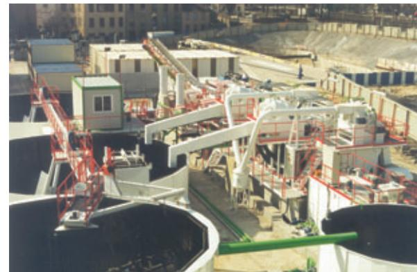
**Sotres : installation de traitement de boue bentonitique**
