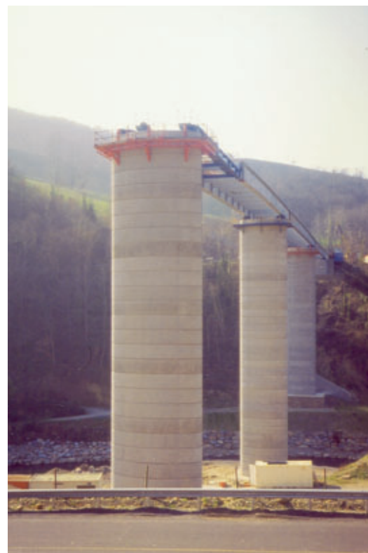
Photo 8 Lancement de l'ossature métallique sur les piles Structural steel construction work
