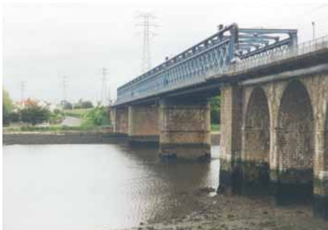
Photo 1 Vue générale de l'ouvrage General view
