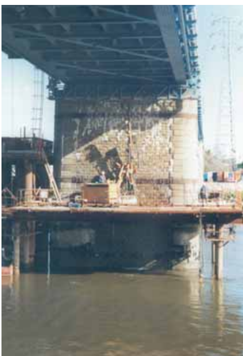
Photo 2 Injections au travers de l'entablement de la culée C3 Injection through the entablature of abutment C3
