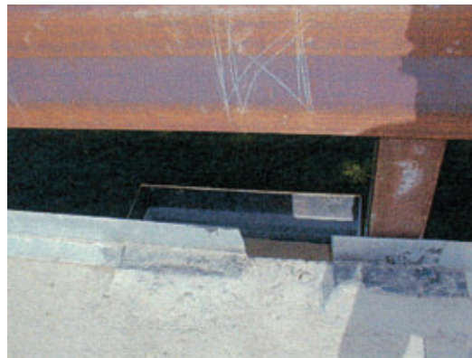
Photo 4 Cornières pour l'étanchéité de l'estacade Angle brackets for breakwater tightness
