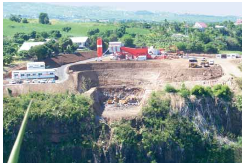
Vue des fouilles culée rive gauche
