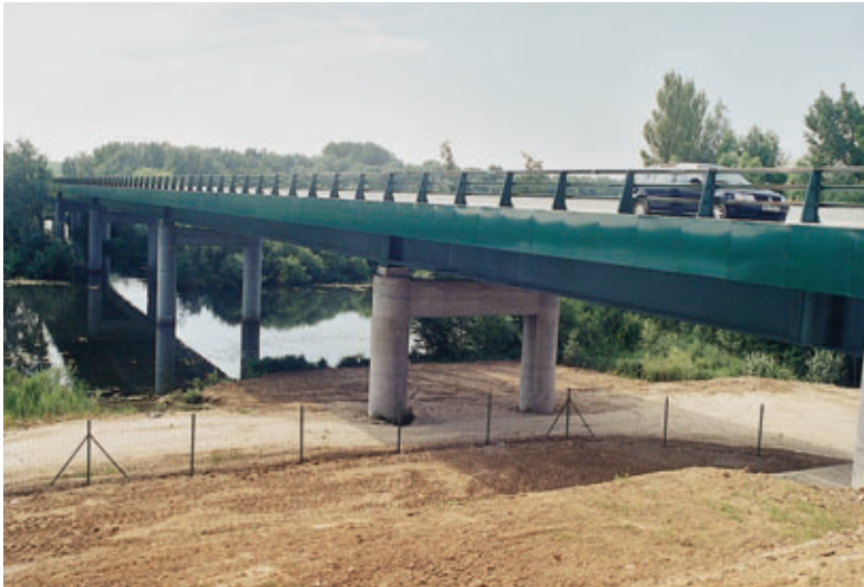
Vue du viaduc terminé
