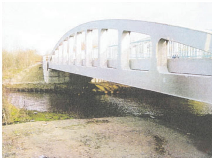
Ouvrage terminé, avant application de la couche de finition
