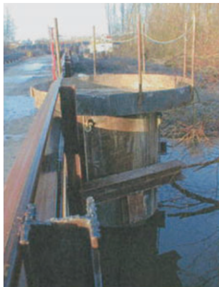
Photo 6 Protection en tête de pieu Protection at head of pile
