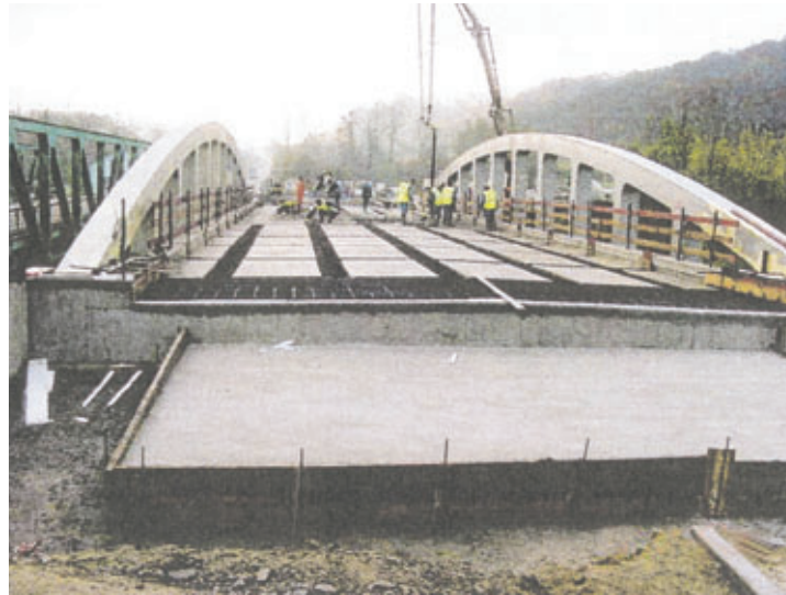
Clavage des éléments préfabriqués constituant le hourdis
