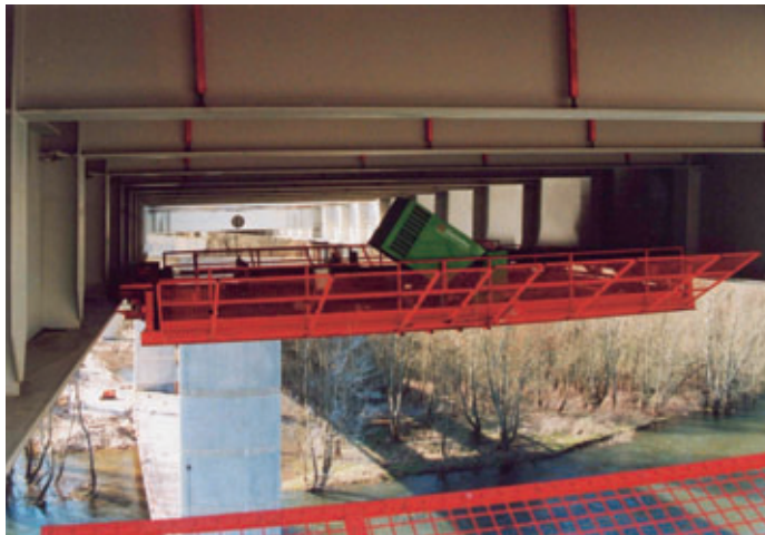
Photo 15 Passerelle de travail intérieure de bétonnage du tablier
