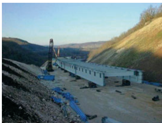
Photo 12 Aire de lancement du tablier sud Southern deck launching area
