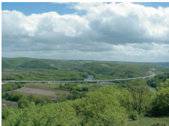
Photo 1 Vue générale de l'ouvrage General view of the structure
