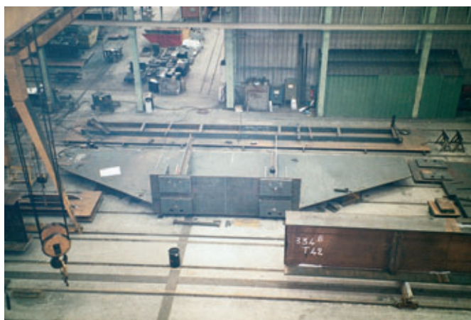
Photo 3 Assemblage d'une âme sur la semelle inférieure Assembly of a web on the lower flange
