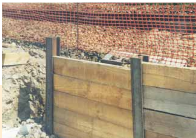
Photos 6 et 7 La paroi berlinoise sur le remblai Lanester The Berlinoise wall on the Lanester backfill
