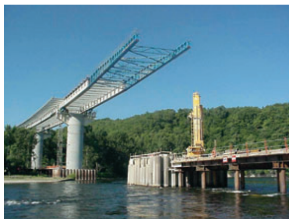
Photo 10 Chevêtre de l'appui P6 en cours de manutention Header of support P6 undergoing handling
