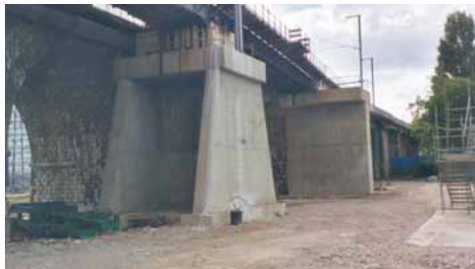
Photo 4 La pile provisoire P4 et à l'arrière, le portique P5/P6 Temporary pier P4 and, at the rear, trestle P5/P6
