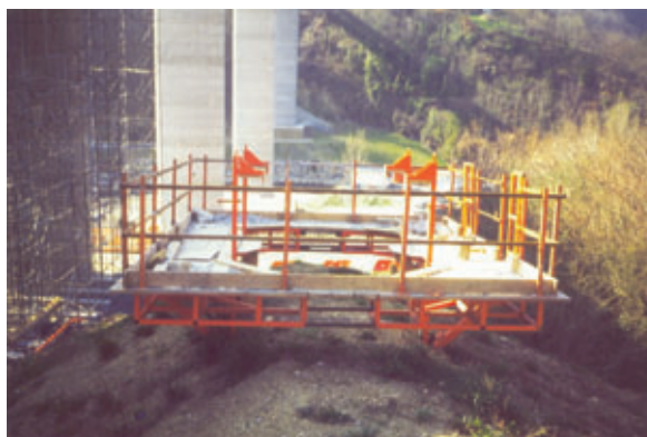
Photo 5 La passerelle de travail The work footbridge
