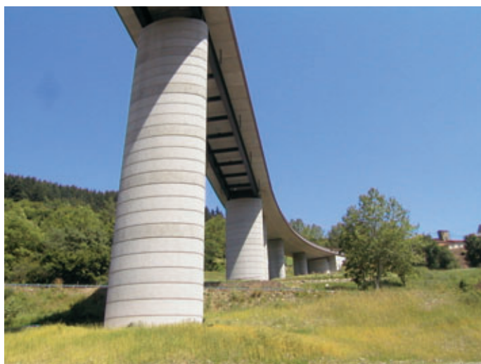
Photo 2 Les piles Piers
