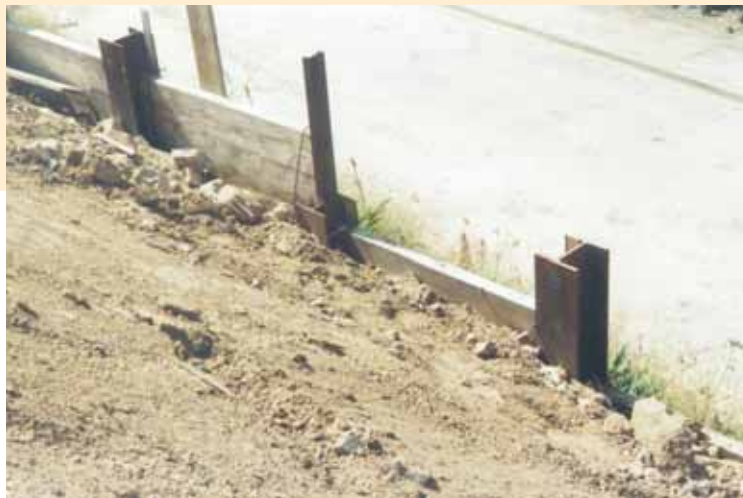
Photos 6 et 7 La paroi berlinoise sur le remblai Lanester The Berlinoise wall on the Lanester backfill
