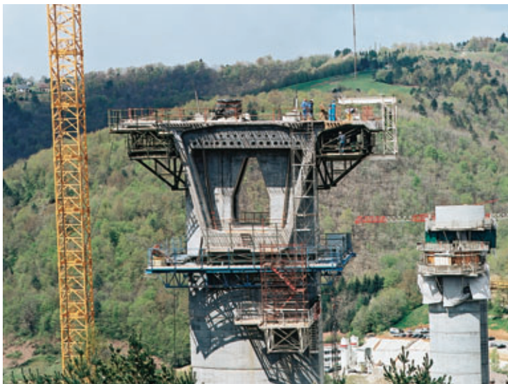
Photo 4 Voussoir sur pile et précontrainte de fléau Segment on pier and prestressing of the beam
