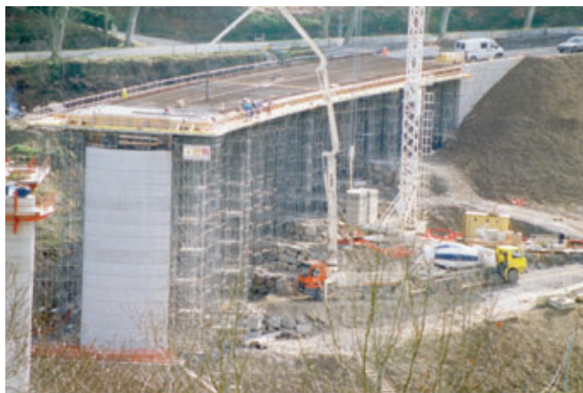
Photo 6 L'étalement de l'ouvrage d'accès Shoring the access structure
