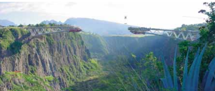
Vue de l'ouvrage en cours de construction View of the structure undergoing construction
