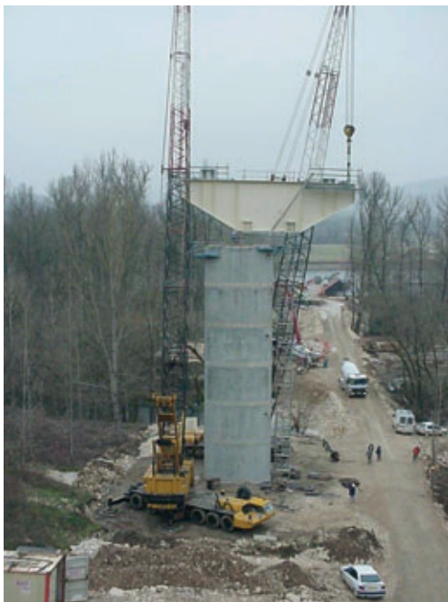
Photo 9 Grutage d'un chevêtre courant Crane hoisting of a standard header
