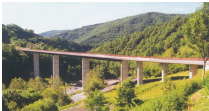
Photo 1 Vue d'ensemble de l'ouvrage terminé Overall view of the completed structure
