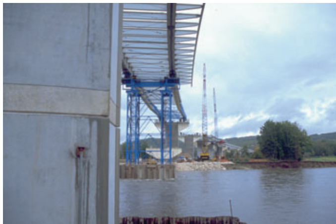
Photo 4 Hissage chevêtre Hoisting the header
