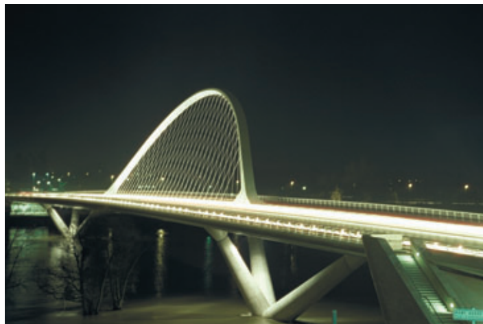
Photo 7 Vue depuis la rive nord, la nuit View from the north bank, at night
