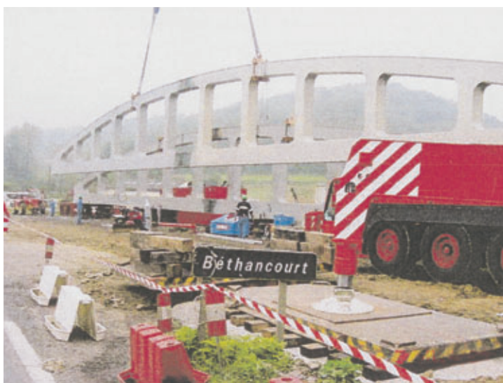
Prise en charge des poutres après assemblage sur plate-forme Loading the girders after assembly on platform
