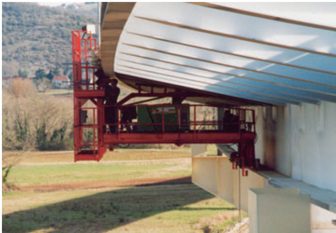
Photo 16 Passerelle de travail extérieure de bétonnage du tablier
