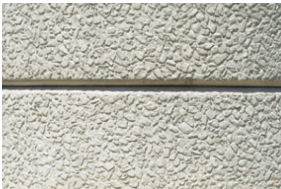
Photo 3 Détail du parement des piles
