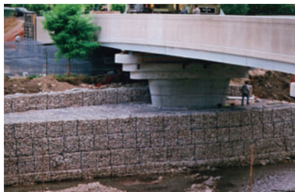
France Gabion : des solutions contre l'érosion
