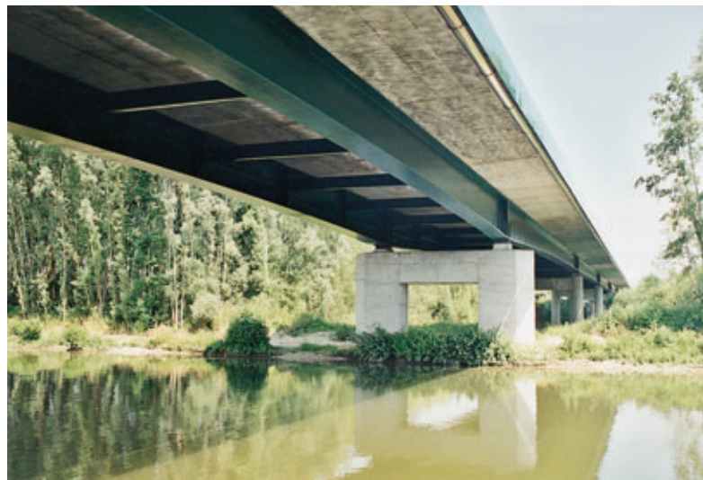
Vue de l'ouvrage terminé View of the completed viaduct
