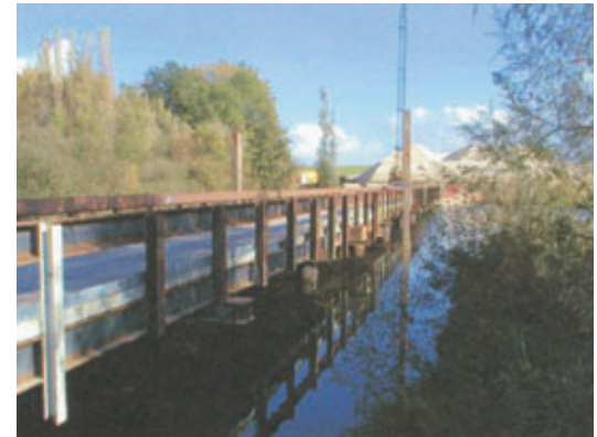
Photo 5 L'estacade terminée The completed breakwater
