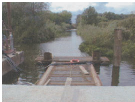
Photo 1 Guide pour les fondations de l'estacade Guide for breakwater foundations
