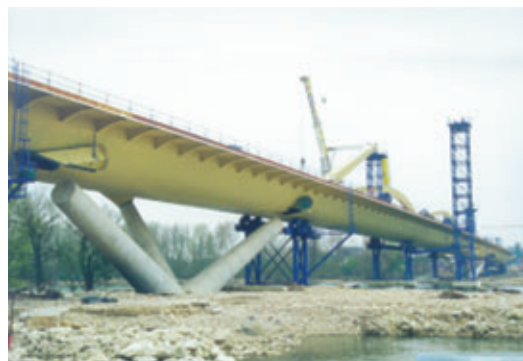
Photo 11 Poussage du tablier Deck pushing
