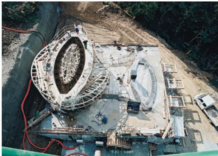
Photo 2 Coffrage sans tige des piles Rodless shuttering of the piers
