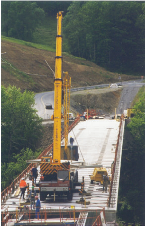
Photo 9 La pose des dalles du tablier Laying the deck slabs
