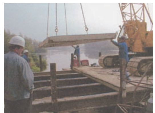
Photo 2 Mise en place d'une dalle de l'estacade Laying a breakwater slab
