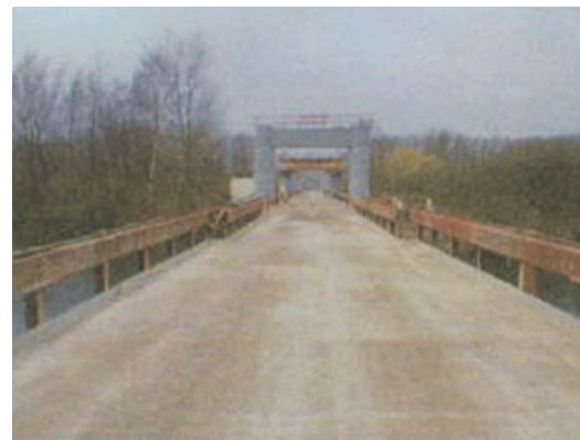
Photo 7 Vue d'une pile à partir de l'estacade View of a pier from the breakwater
