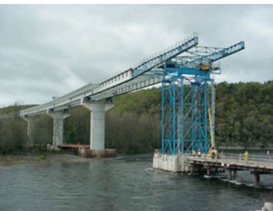
Photo 13 Palée provisoire en P7 Temporary bent at P7
