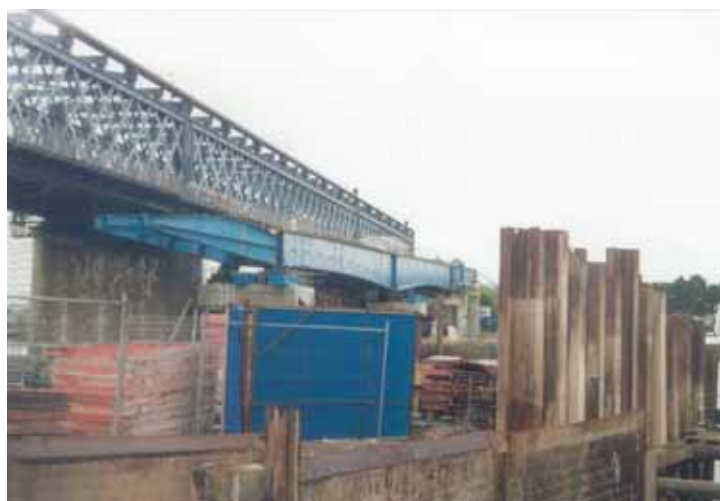
Photo 12 Le lançage avec l'avant-bec Launching with the launching nose
