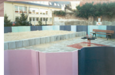
Europrofil France : des solutions de palplanches en milieu urbain
