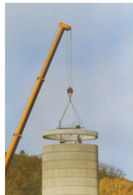
Photo 4 La pose des coques de piles Laying of pier shells
