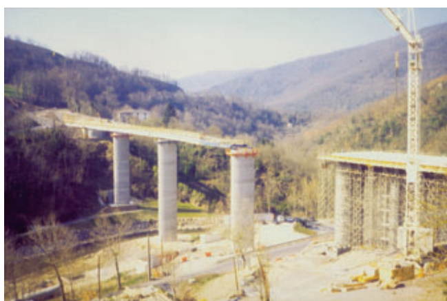
Photos 7 Lancement de l'ossature métallique Structural steel construction work
