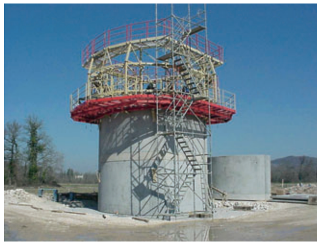
Photo 8 Outil de pose des coques préfabriquées Tool for placing of prefabricated shells
