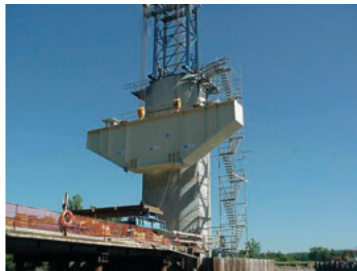
Photo 10 Chevêtre de l'appui P6 en cours de manutention Header of support P6 undergoing handling
