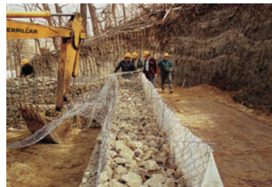
France Gabion : solution de remblai renforcé à parement minéral en gabions
