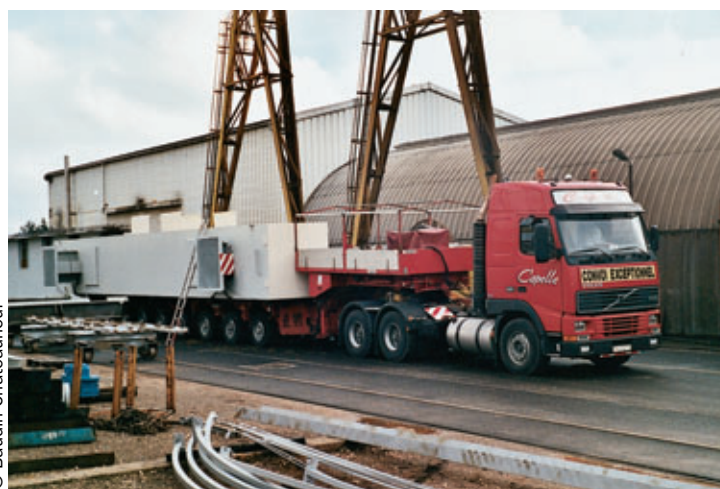
Photo 2 Chargement d'un chevêtre pour expédition Loading a header for shipment
