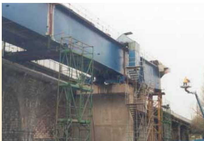
Photo 9 et 10 Le rabotage des tronçons de poutres Butt welding of girder sections
