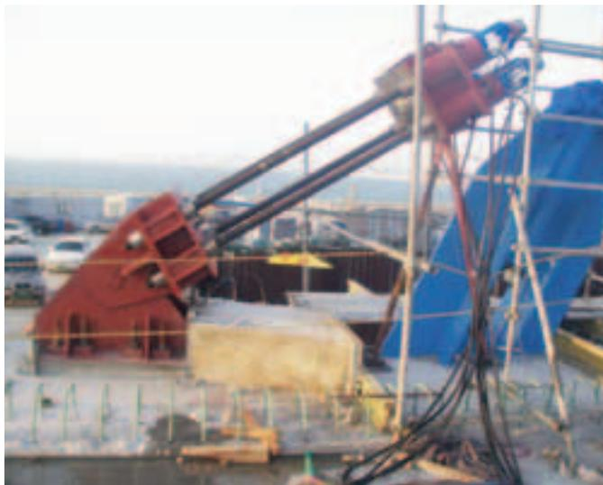
**Ancrage permettant la mise en œuvre rapide d'un hauban provisoire**
