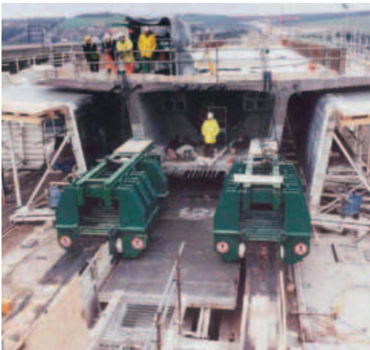
► poussage, ces plaques glissaient sur les longrines et étaient récupérées en extrémité derrière la culée. Elles étaient réutilisées après nettoyage.
