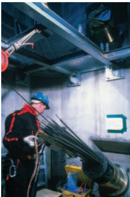
Mise en œuvre des haubans dans le pylône
