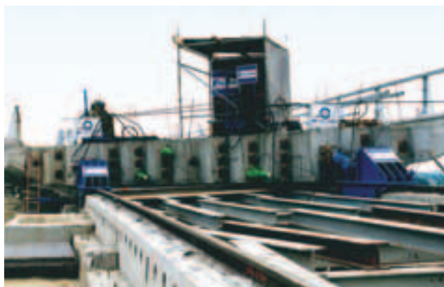
Photo 20 Avant-bec et palée provisoire du PS 008 Nose and temporary bent of overpass 008
