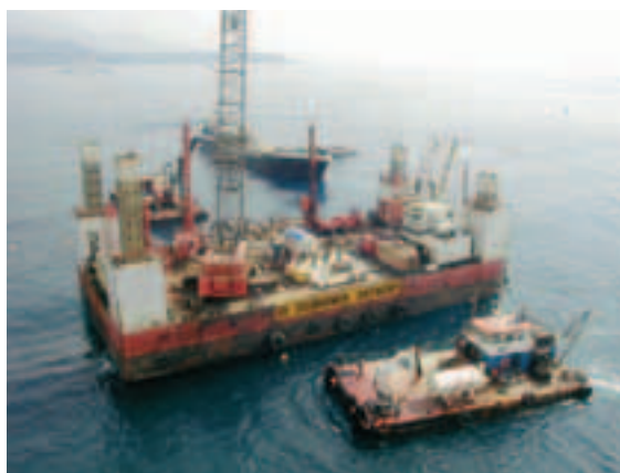
Photo 2 Plate-forme auto-élevatrice équipée pour les injections solides Platform with auto-elevator designed for solid injection
