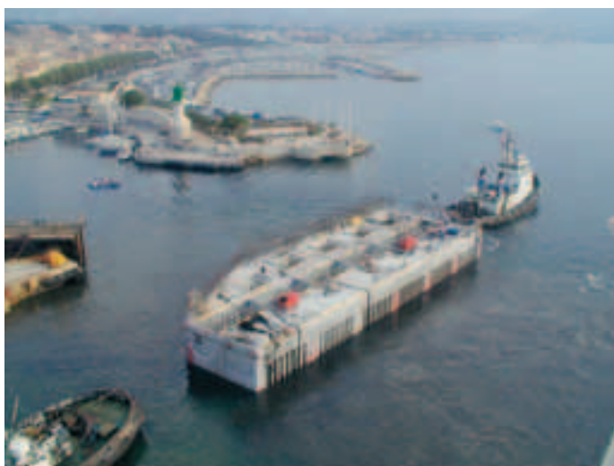
Photo 8 Caisson M2 sortant de la forme de La Ciotat
