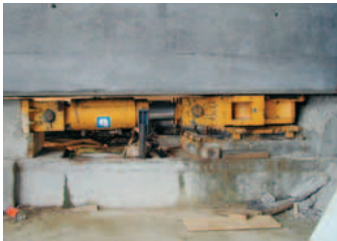
Photo 7 Dispositif de poussage Eberspeicher Eberspeicher pushing system
