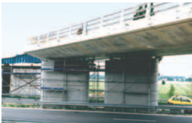
Photo 21 Le PS 008 en cours de poussage Overpass 008 during pushing
