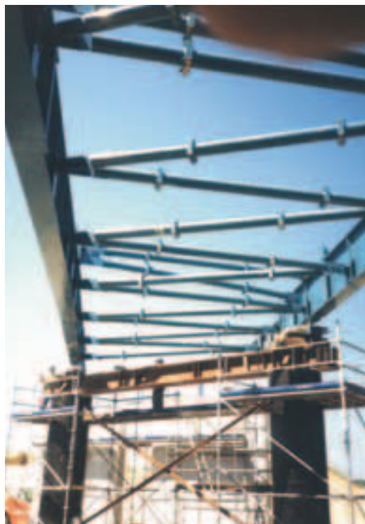
Photo 20 Avant-bec et palée provisoire du PS 008 Nose and temporary bent of overpass 008
