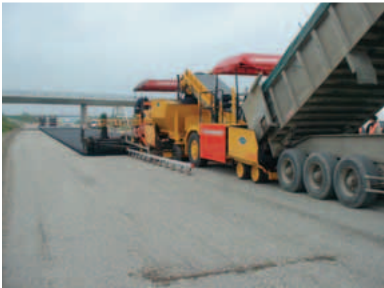
Photo 22 Mise en œuvre de la couche de fondation Placing of base course
