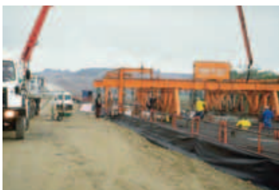
Photo 15 Viaduc de l'Hers : bétonnage d'un plot
