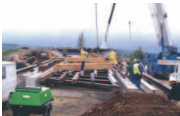
Photo 18 Coffrage des tabliers Deck shuttering
