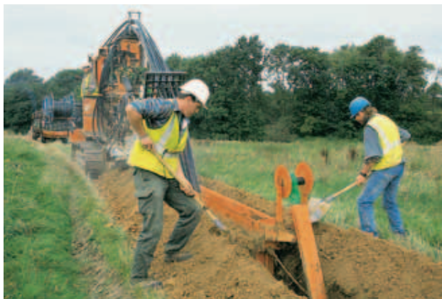
Photo 5 Passage de la trancheuse, dont la roue de 20 cm ouvre la tranchée
