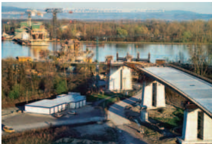
Photo 1 Vue générale du chantier (en arrière plan, la construction du pont principal sur le fleuve)
