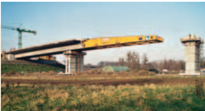
Photos 11, 12, 13, 14 Tablier en cours de poussage à différentes phases de la construction Deck during pushing in different construction phases
