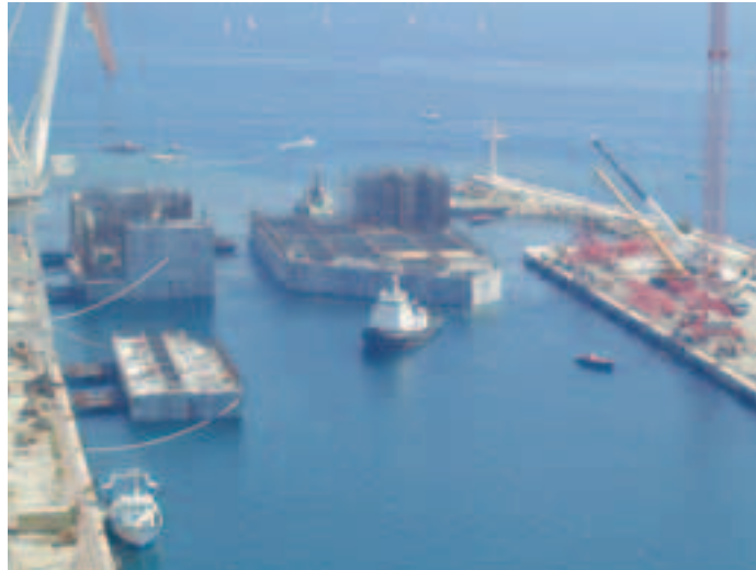
Photo 9 Caissons M1, M2 et culée dans le bassin à flot de La Ciotat Caissons M1, M2 and abutment in La Ciotat wet dock
