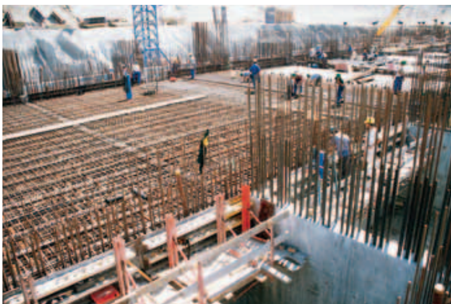
Ferrailage de la dalle à - 12, recevant le niveau de parking le plus bas
