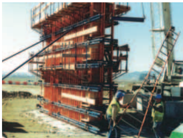
Photo 8 Habillage des piles avec des briquettes Brick facing on piers
