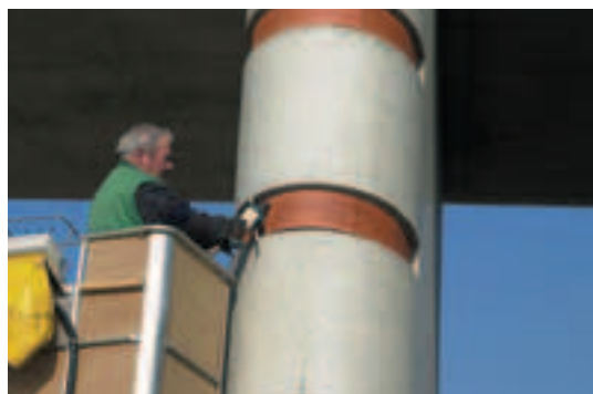
Photo 8 Habillage des piles avec des briquettes Brick facing on piers
