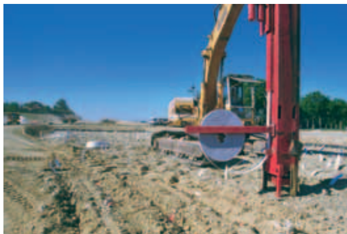
Photo 3 Mise en œuvre des drains verticaux Placing of vertical drains
