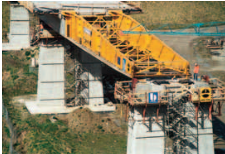
Photo 4 Accostage de l'avant-bec sur un appui Positioning of cutwater on a bearing
