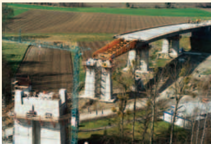
Photos 11, 12, 13, 14 Tablier en cours de poussage à différentes phases de la construction Deck during pushing in different construction phases
