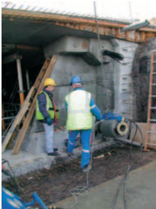
Photo 10 Mise en tension des câbles intérieurs Tensioning of inside cables
