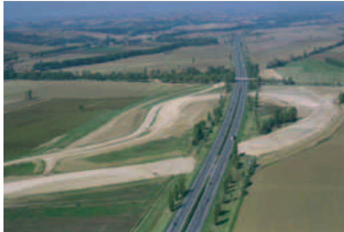
Photo 16 Le début des remblais de la bifurcation Start of cuttings at junction
