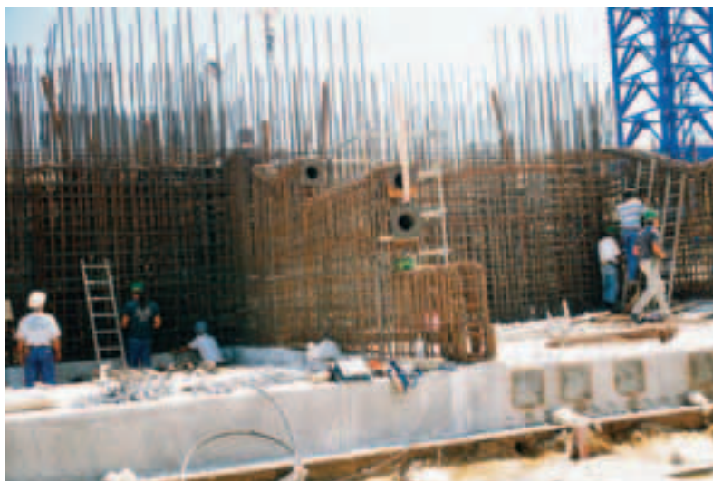
Ferrailage en cours (extrémité côté phare) et de ses raidisseurs. On peut observer des déviations de précontrainte, ainsi que des gaines en boucle
