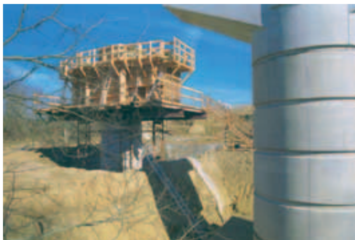
Photo 13 Coffrage du chevêtre sur le viaduc de l'Hers
