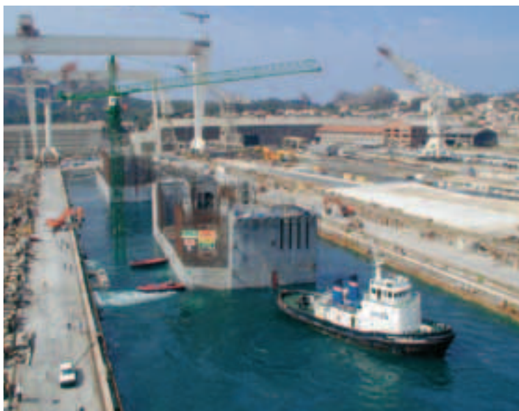
Photo 7 Première mise en eau de la forme de La Ciotat
