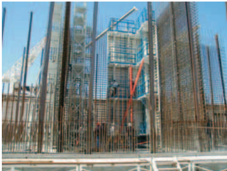
Photo 12 Coffrage et ferrailage d'une levée de 10 m du caisson M2 Shuttering and reinforcement of 10 m levee for caisson M2
