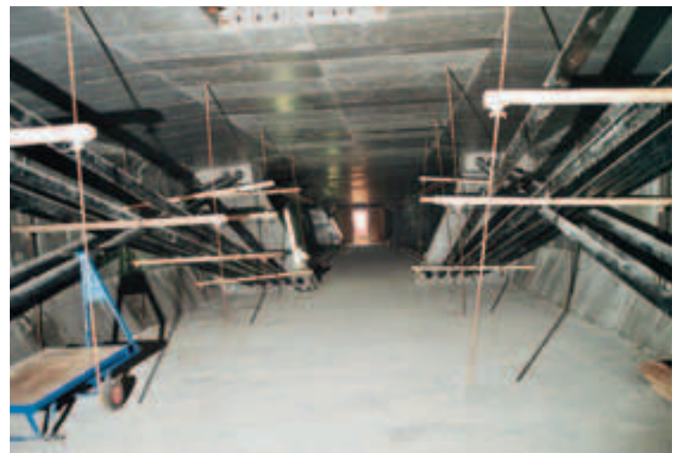
Photo 2 Intérieur du caisson. On remarquera les câbles de précontrainte extérieurs au béton
