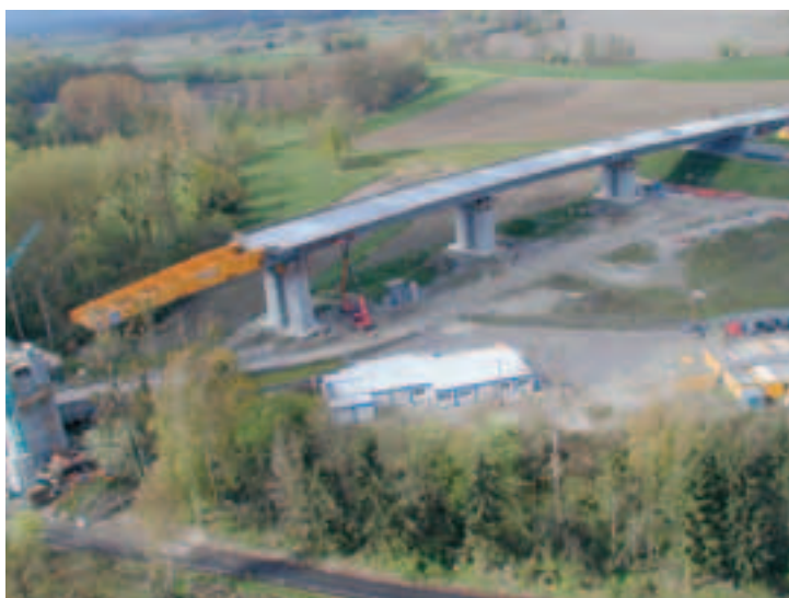
Photo 15 Vue aérienne du viaduc Aerial view of viaduct
