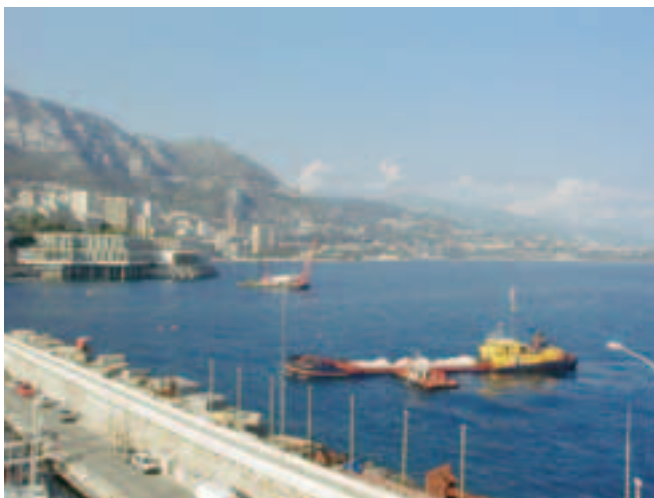
Photo 6 Clapage des remblais en pied de la digue sud
