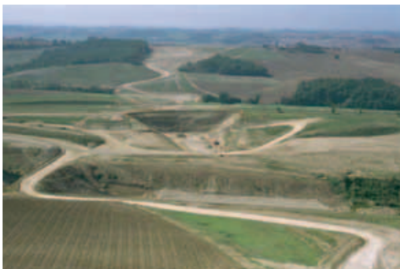
Terrassements généraux dans les coteaux du Lauragais General earthworks in the Lauragais hills
