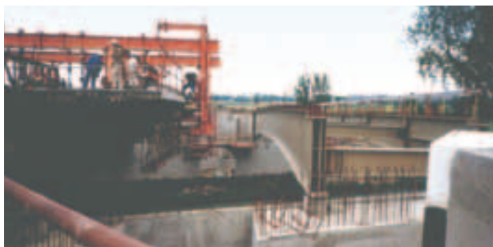
Photo 12 Ossature métallique et bétonnage du franchissement du canal du Midi
