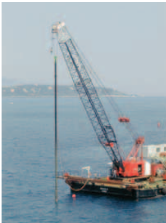
Photo 4 Vibreux de 150 mm suspendu à son aiguille. Ce vibreur a pu descendre à 20 m à l'intérieur des remblais spécialement sélectionnés
