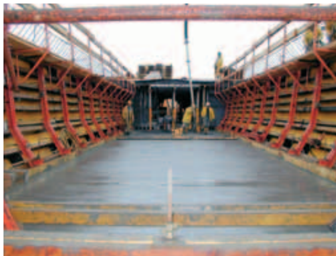
Photo 9 Bétonnage d'un plot Concreting of post
