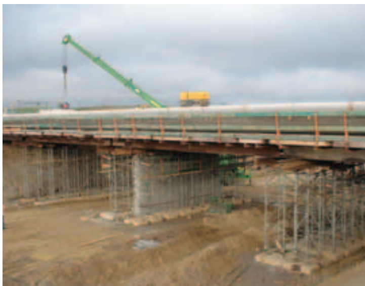
Photo 9 Etalement du PS 55 par GTM Strutting of overpass 55 by GTM
