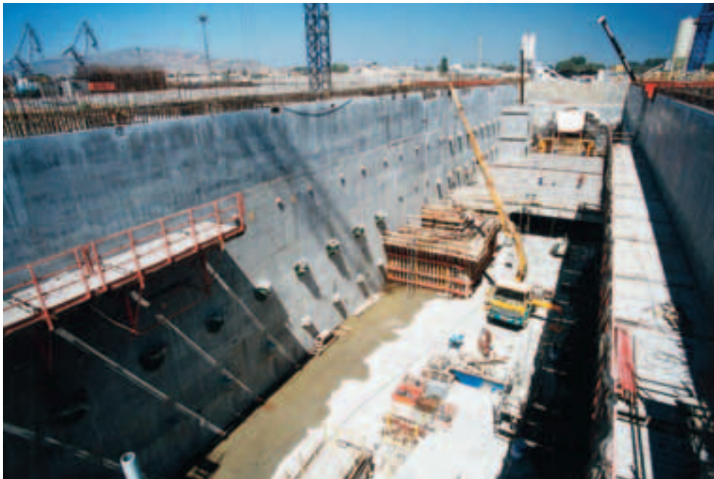
Une vue de l'intérieur du "bateau". On peut remarquer les corbeaux qui vont supporter les poutres des planchers des niveaux de parking. Les cages d'escalier et d'ascenseurs commencent à sortir
