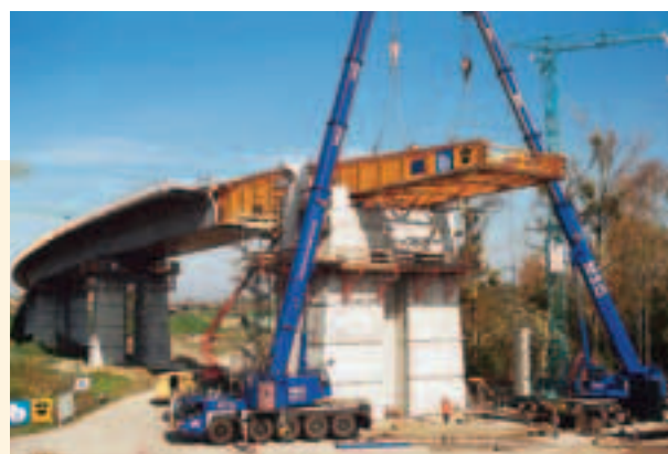
Photos 16 et 17 Démontage de l'avant-bec Dismounting of cutwater
