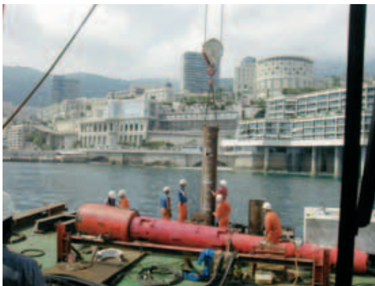
Photo 5 Préparation du battage d'un pieu. En rouge, marteau de battage
