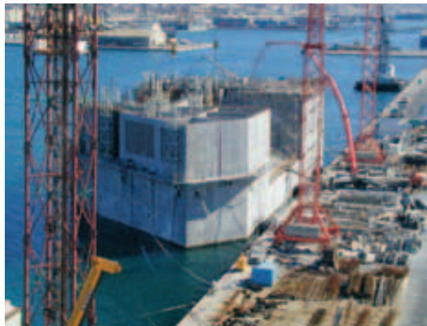
Photo 10 Fin des travaux de la culée au quai Wilson du port de Marseille End of works on abutment of Wilson wharf at Port of Marseilles
