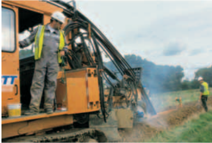
Photos 2, 3 et 4 Plusieurs techniques de pose sont utilisées sur ce projet (pose mécanisée, pose traditionnelle et forage dirigé)
