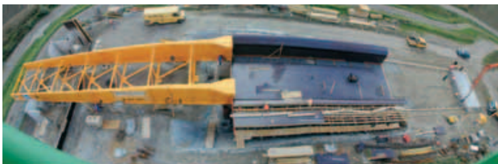
Photo 3 Vue aérienne du banc de préfabrication Aerial view of precasting bench
