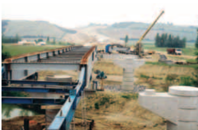
Photo 15 Viaduc de l'Hers : bétonnage d'un plot
