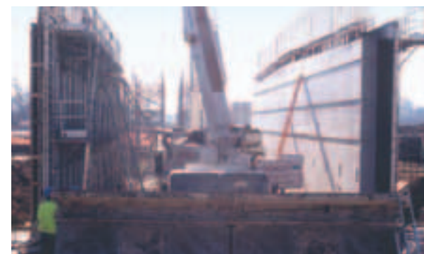
Photo 11 Réalisation du PI 229 Underpass 229
