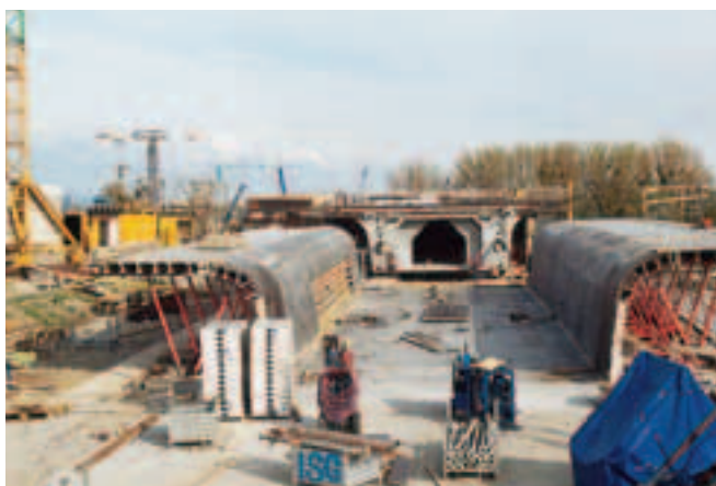
Photo 18 Le tablier achevé est sorti du banc de préfabrication Completed deck is removed from prefabrication bench
