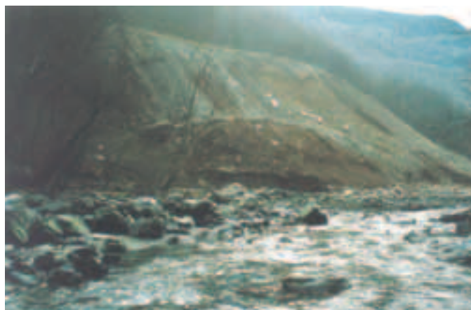
Photo 2 Etat initial du dépôt des Nantieux (1997) Initial condition of Les Nantieux site (1997)
