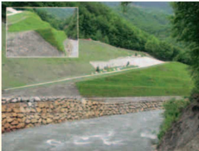
Photos 11 et 12 Aménagement final (juin 2001) Site after operations (June 2001)
