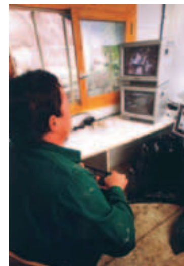
Photo 9 Commande de la pelle à distance (assistée de caméra) Remote control of shovel (camera assisted)
