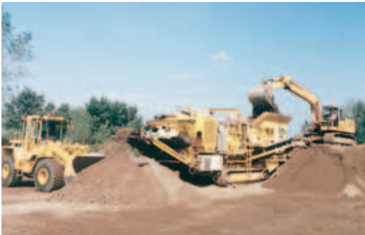
Recyclage sur chantier de démolition. Traitement in situ par concasseur mobile
