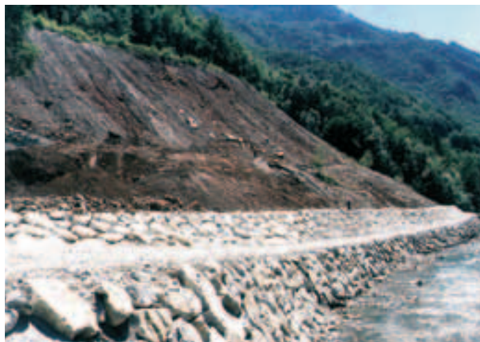
Photo 3 Vue du site après réalisation des enrochements
