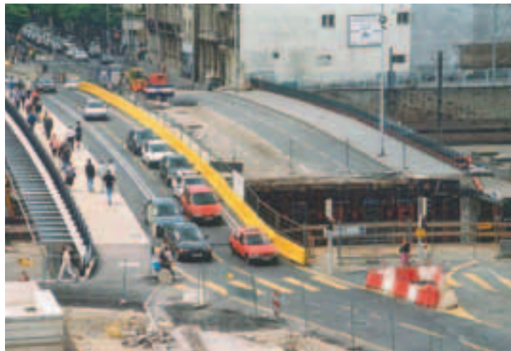
Photo 6 Travaux de l'ouvrage d'allongement Works on extension structure
