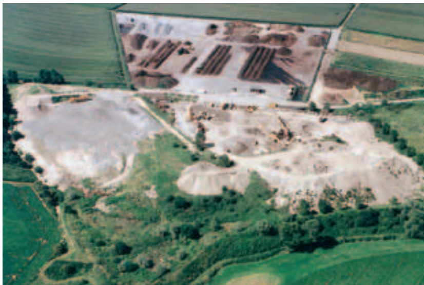
Vue d'ensemble d'un centre de valorisation (inertes, mâchefers, boues de step, déchets verts) à Oberschaeffolsheim
