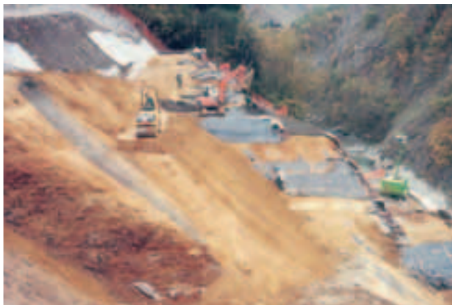
Photos 6 et 7 Remise en place des résidus traités Replacement of treated residue
