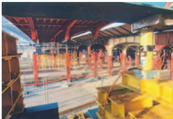
Photo 3 Mise en place de l'ouvrage neuf parallèlement à l'ouvrage existant Erection of new bridge parallel to existing structure
