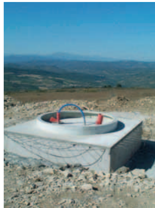
Vue du massif avant pose de l'éolienne View before wind turbine installation
