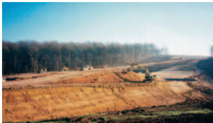
Photo 4 Vue d'ensemble des terrassements Overall view of earthworks
