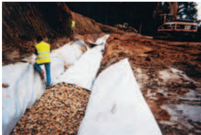
Photo 1 Remblaiement des tranchées drainantes Backfilling of drainage trenches
