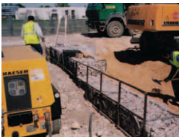
Mise en œuvre du Terramesh® System
