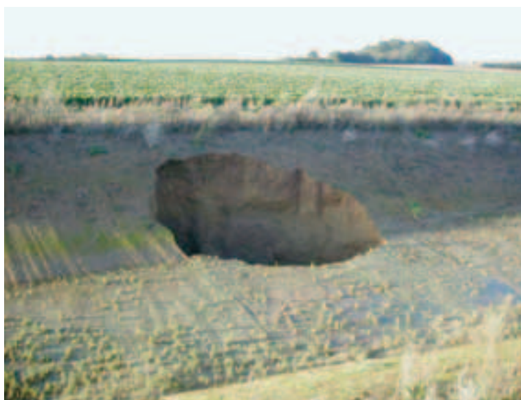
Photo 4 Effondrement d'une cavité dans un fossé élargi
