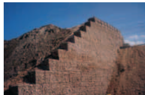
Ouvrage en cours de finition
