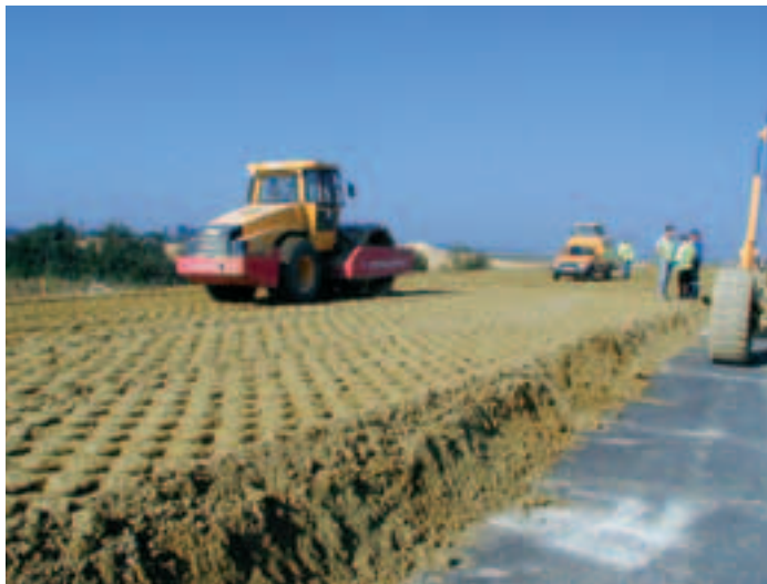
Photo 2 Rabotage de la couche de forme à l'autograde
