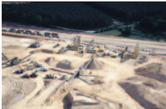
Photo 2 Vue d'ensemble de l'aire de fabrication de la couche de forme sur le site des Grandes Pièces à La Bussière. Les stations de criblage sont au premier plan Overall view of subgrade production area on Grandes Pièces site at La Bussière. Screening stations in foreground
