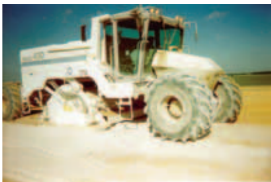
Photo 1 Traitement à la chaux au déblai avec un pulvimixeur
