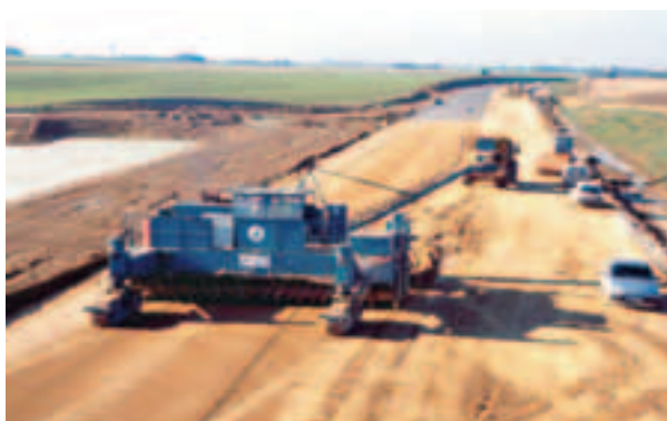
Photo 2 Rabotage de la couche de forme à l'autograde
