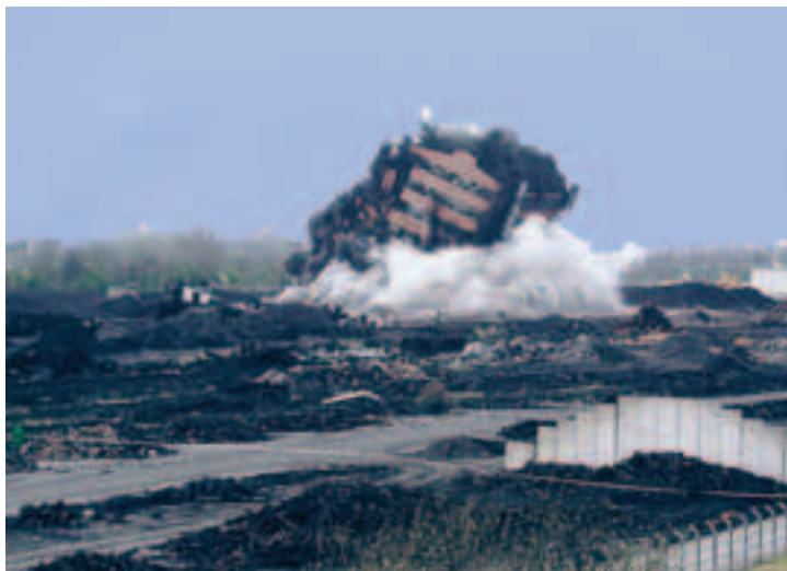
Foudroyage de l'usine Aggлонord Demolition of Aggлонord factory
