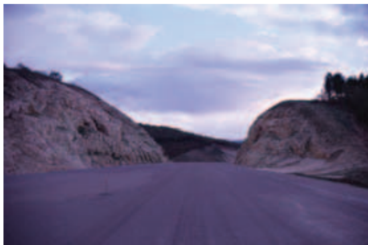
Photo 7 Tranchée couverte de Terregaye (400 m) Cut-and-cover section of Terregaye (400 m)
