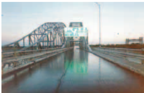
Photo 12 Aperçu du tablier après la pose de la membrane
