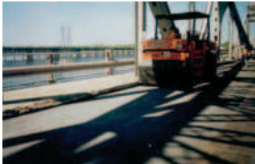
Photo 7 Application de la couche de protection à l'ardoisine Application of synthetic slate protection layer
