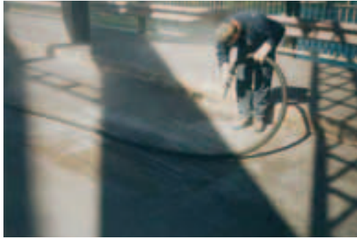
Photo 4 Nettoyage au jet de sable Sand-blast cleaning
