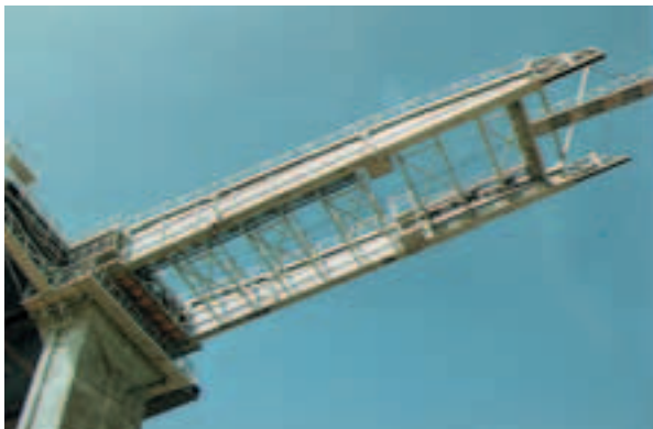
Pont de Normandie, viaduc d'accès
