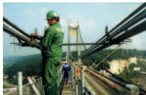
Pont de Tancarville, montage des câbles
