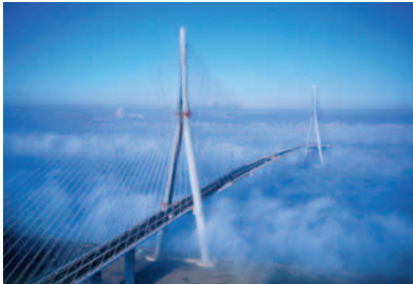
Le pont de Normandie, vue générale
