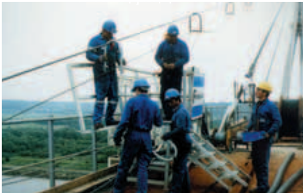
Pont de Normandie, montage des haubans
