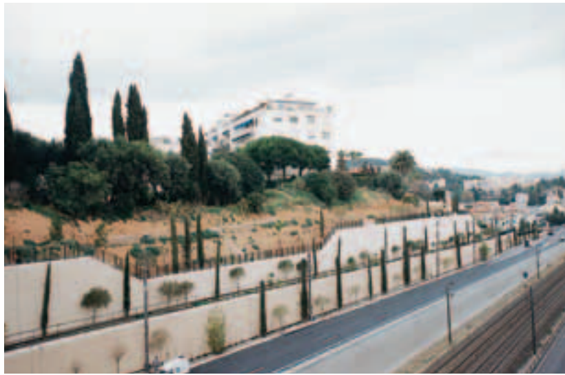
Finitions en cours Finishing work
