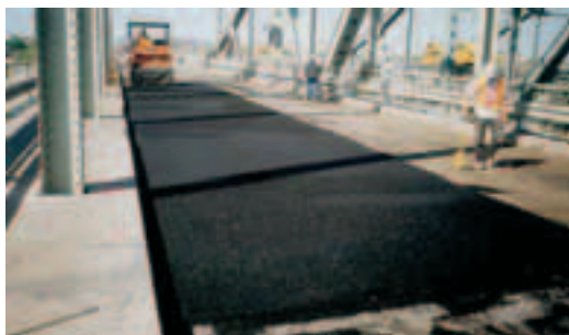
Photo 8 Mise en place de l'enrobé Bétonplast Placing of Bétonplast mix
