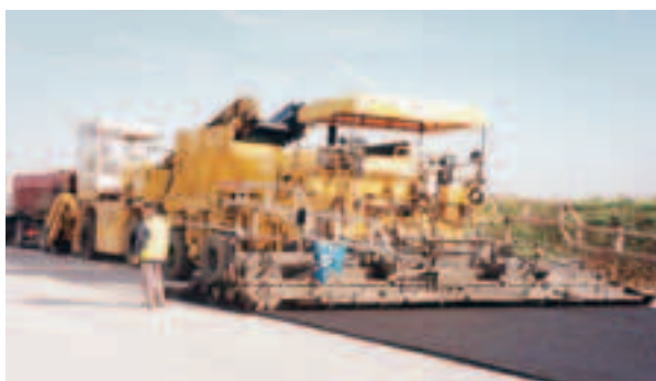
Photo 7 Finisseur Vögele grande largeur S 2500 Vögele S 2500 extra-wide paver
