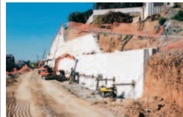
Construction de murs à tirants Construction of tie-rod walls
