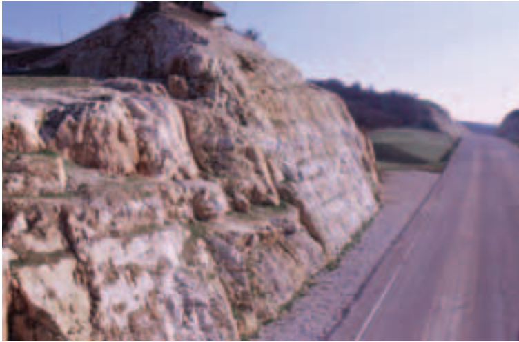
Photo 8 Section courante de l'A20 en cours de finition (Lamothe-Cassel) Section of A20 in finishing phase (Lamothe-Cassel)
