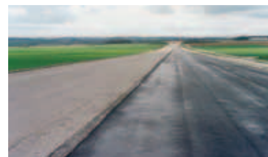
Photo 7B A droite, le sable enrobé. A gauche la surface du STLH avant mise en œuvre du sable enrobé On the right, the asphalt-treated sand. On the left, the surface of the treated sand before placement
