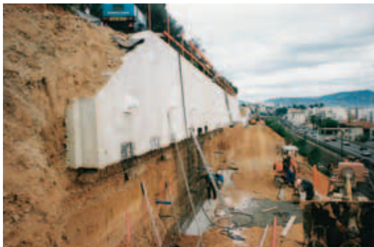
Construction de murs à tirants Construction of tie-rod walls
