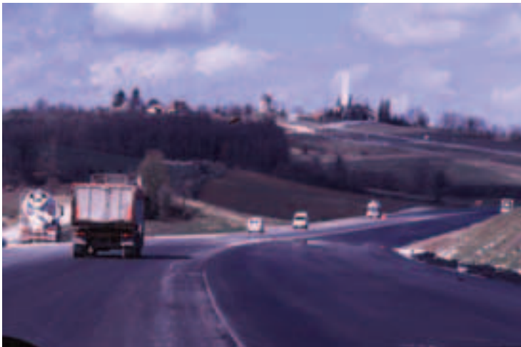
Photo 6 Tranchée couverte de Sol-de-Roques (200 m), têtes de tranchée côté sud
