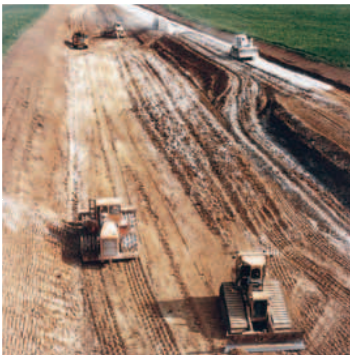
Photo 1 Phase de terrassement et traitement chaux/liant routier
