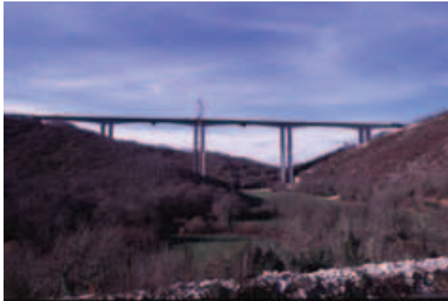
Photo 1 Le viaduc de la Rauze (555 m de long, 100 m de haut)
