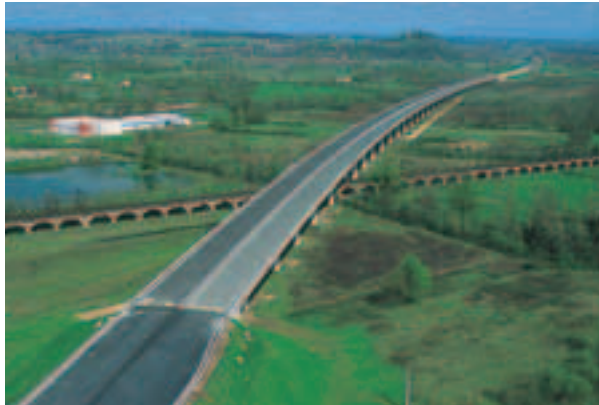
Photo 1 Le viaduc des Barrails à Arveyres
