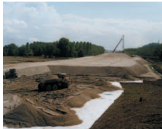
Photo 4 Mise en place de remblai de préchargement sur Bidim
