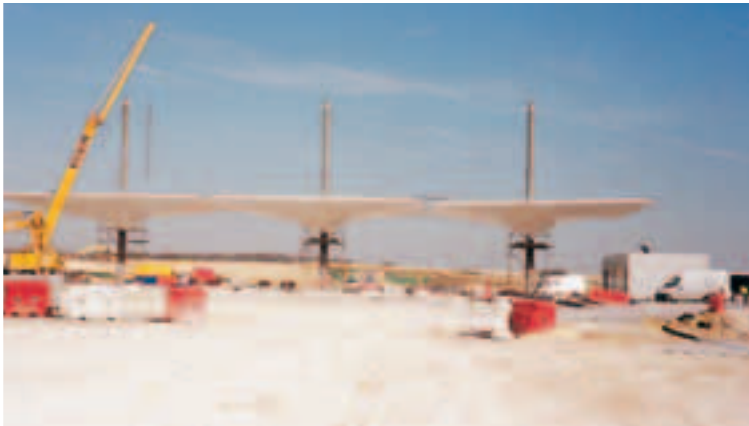
Photo 10 Barrière pleine voie de Boves en travaux Boves full-width barrier during works
