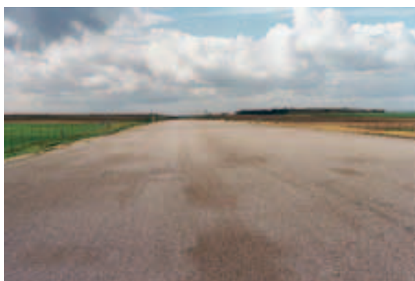
Photo 3 Vue de la couche de "Fondabase" après cloutage et enduit de protection
