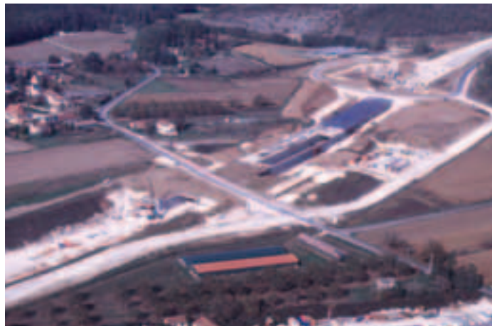
Photo 5 Détail des talus Royal® (Le Mut) Detail of the Royal® slopes (Le Mut)
