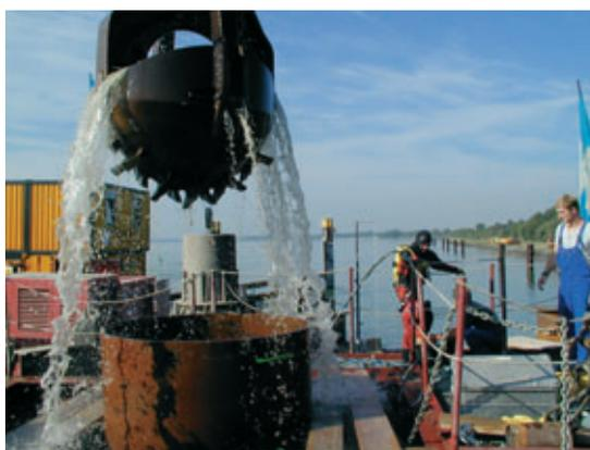
**Forage d'un pieu dans le fleuve : forage au grappin diamètre Ø 1,80 m**
