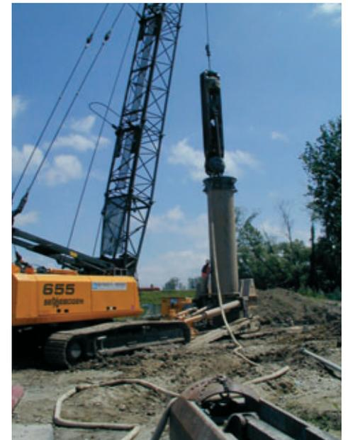
**Viaduc côté France : forage d'un pieu Ø 1,30 m à l'abri d'un tube de travail**
