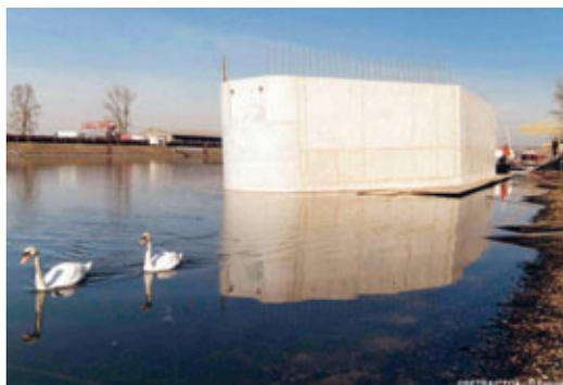
**Transport d'un caisson par flottaison sur le Rhin à l'aide du pousseur Vredeborg**
