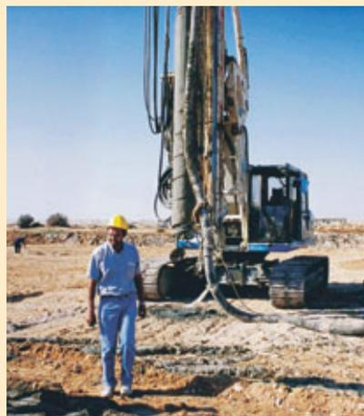
total, plus de 1 800 CMC de 42 cm de diamètre, représentant environ 15 000 m, ont été réalisées en un mois et demi grâce à une machine spécialement adaptée. L'économie globale est importante compte tenu de la réduction de la profondeur des fondations et de la suppression des poutres en tête de pieux.
