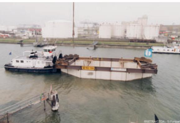
**Mise en place d'une chemise métallique**
