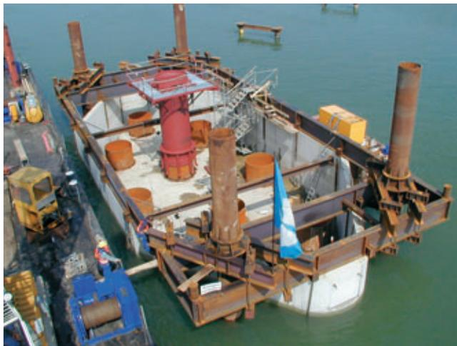
**Le caisson asséché, connecté aux chemises métalliques des pieux. A noter le cadre métallique et les pieux de maintien provisoires**
