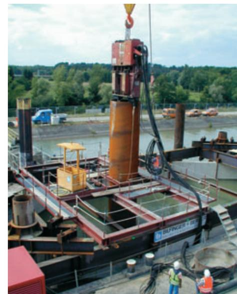
**Fonçage d'une chemise métallique Ø 1,80 m à l'aide du vibreur Muller MS120**
