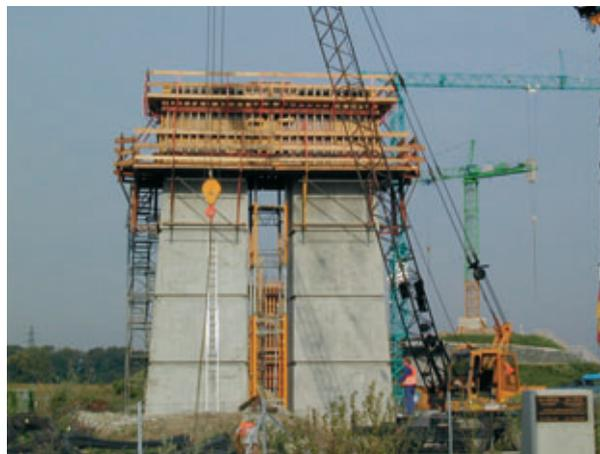
Viaduc côté France. Coffrage d'un chevêtre de pile
