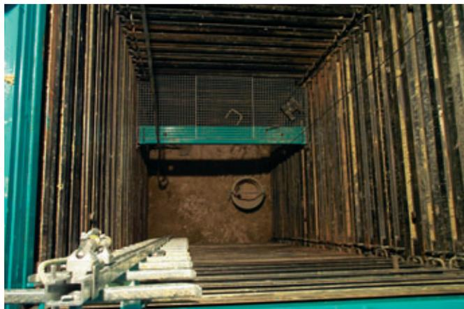
**Blindage : échelle "perroquet" d'accès, dispositif coulissant auto-bloquant antichute, palier intermédiaire grillagé de protection des opérateurs**
