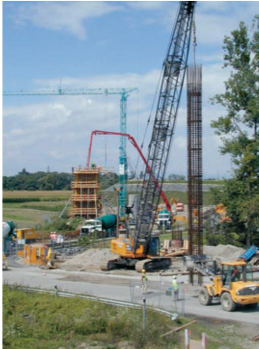
**Pile culée côté France : mise en place de la cage d'armatures d'un pieu**
