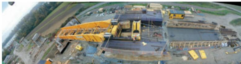
**Viaduc côté France. Tablier en cours de réalisation sur le remblai d'accès**
