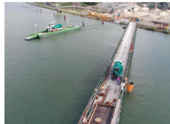
Transport des bétons d'une rive à l'autre par bac et estacade d'accès à la pile dans le fleuve
