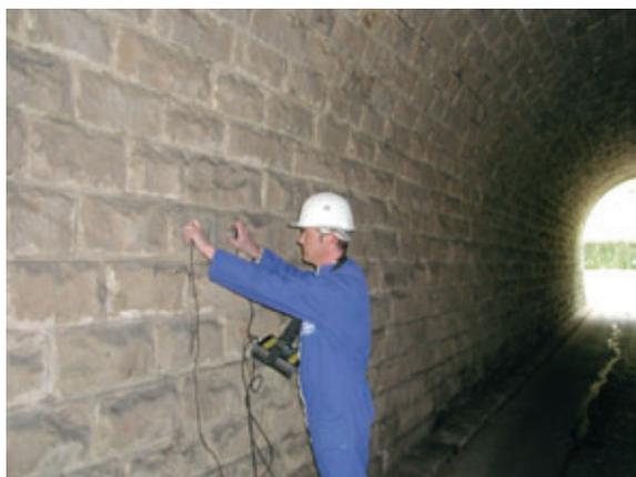
**CEBTP. Cartographie d'un contact béton/terrain (zones de vides en rouge)**
