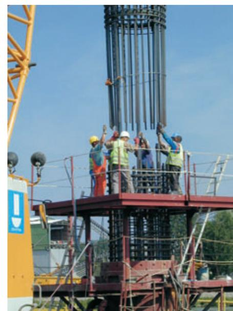
**Mise en place d'une cage d'armatures d'un pieu diamètre Ø 1,80 m**
