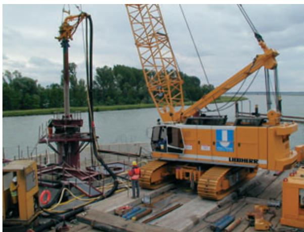
**Forage d'un pieu dans le fleuve : forage au trépan Ø 1,80 m**
