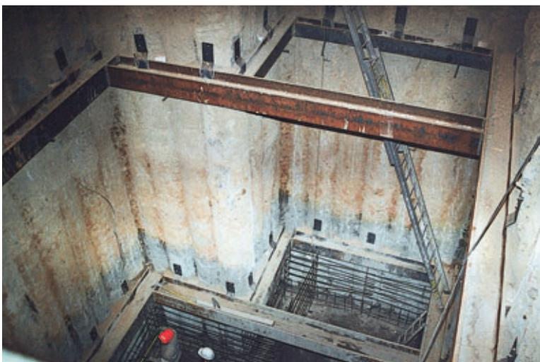
Vue du soutènement en pieux sécants après terrassement et bétonnage
