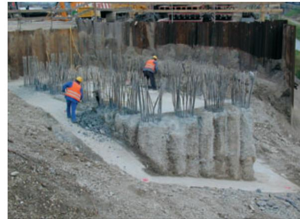
**Pile culée côté Allemagne : recépage des pieux sécants**
