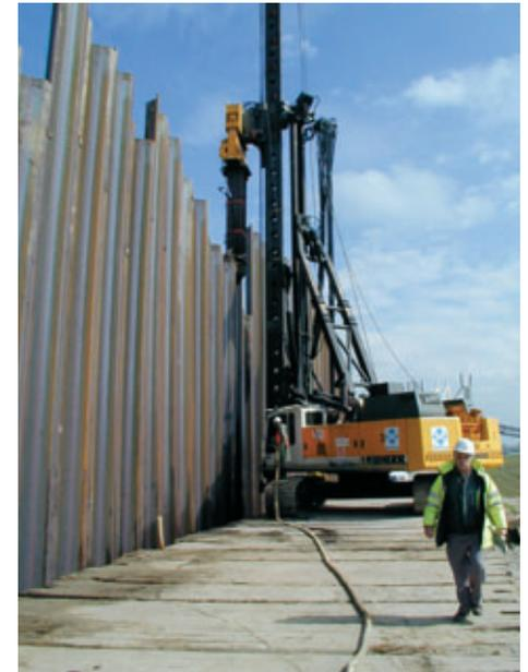
**Confortement des digues : vibrofonçage des palplanches rive droite**
