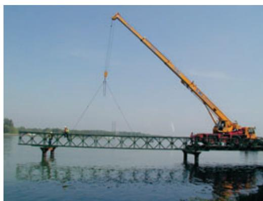
Mise en place de l'estacade d'accès à la pile dans le fleuve côté Allemagne
