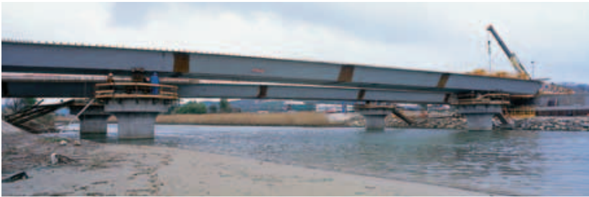
Opérations d'accostage et descente sur appuis des structures métalliques des tabliers
