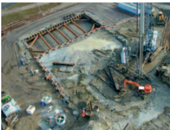
Photo 5 Vue générale du puits de départ General view of outlet shaft
