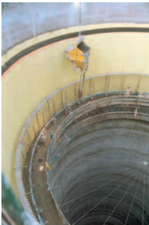
Photo 3 Bétonnage du puits PX 54 après mise en œuvre de l'étanchéité
