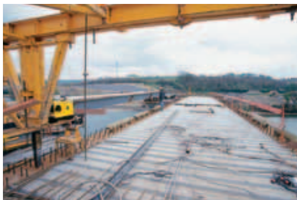
Système de coffrage de la dalle en béton armé des tabliers
