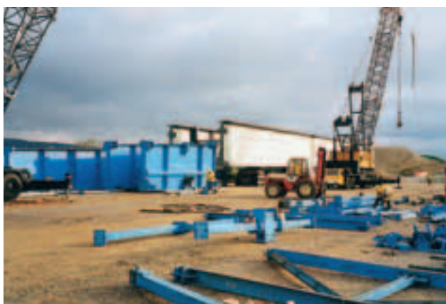
Première poutre et avant-bec First beam and nose
