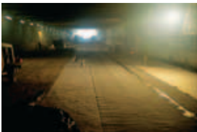
Tranchée couverte d'Avignon 30000 m 2 Siplast Teranap
