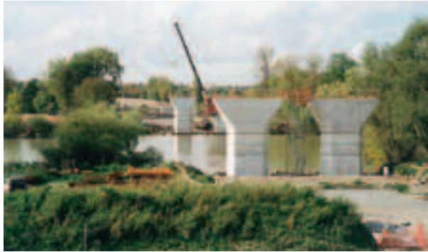
Vue générale des appuis General view of bearings
