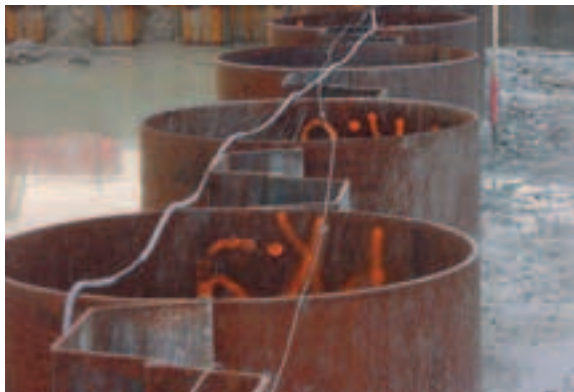
Photo 3 Détail de batardeau - Tubes et palplanches Detail of cofferdam - Tubes and sheetpiling
