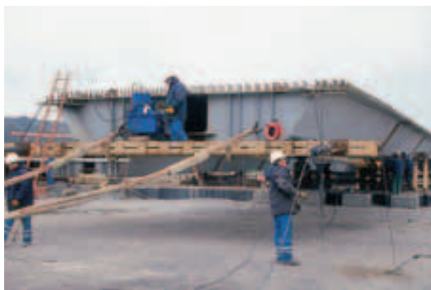
Dispositifs de poussage des structures métalliques des tabliers
