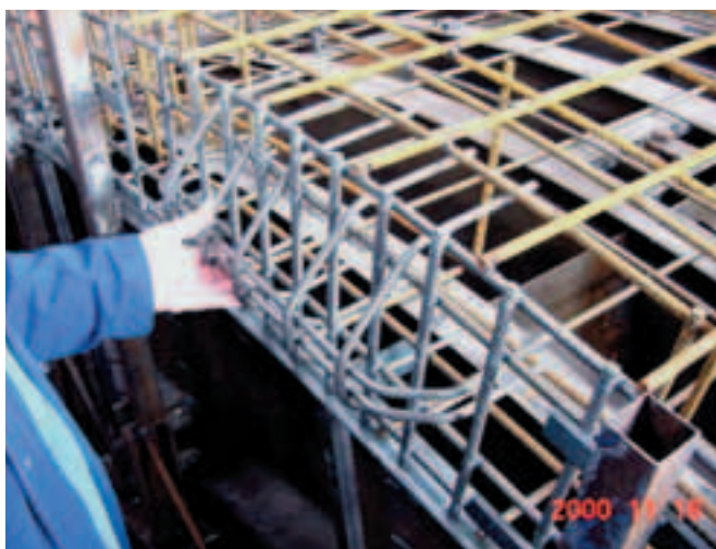
Photo 6 Cage d'essai de voussoirs type 1 Type 1 segment test cage
