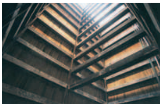
Photo 5 Le puits de sortie The outlet shaft
