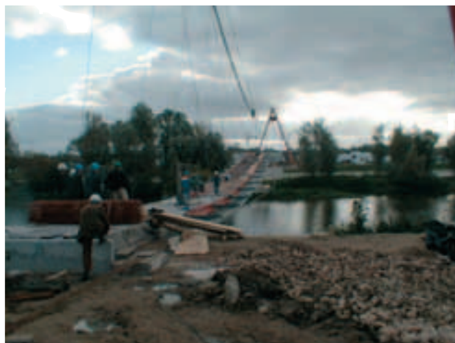
Mise en œuvre des câbles de suspension définitive du tablier métallique Placing the final deck suspension cables
