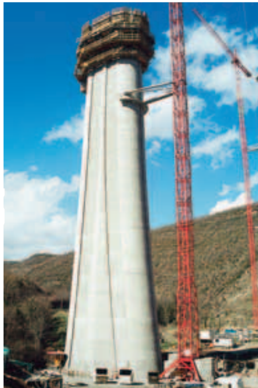
Pile P3 à mi-construction. L'outil coffrant extérieur est dans sa configuration "auto-grimpante". A noter les bracons d'attache de la grue sur la pile
