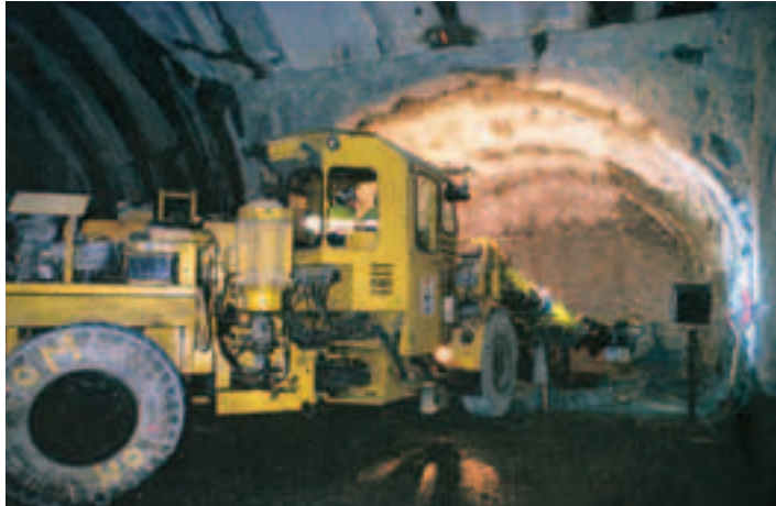
Création d'un abri Work on a shelter
