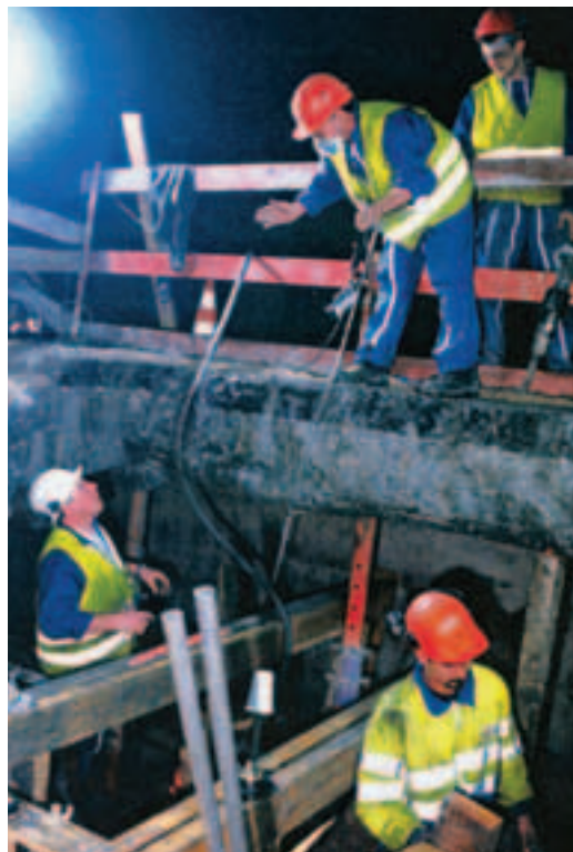
Percement de la chaussée vers la gaine d'extraction pour la construction d'un carneau de désenfumage Opening in pavement towards exhaust duct of smoke removal system
