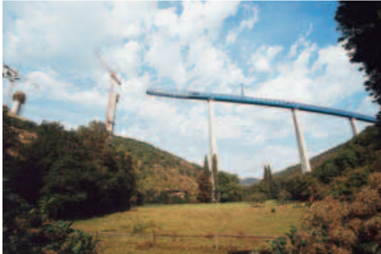
Vue générale de l'ouvrage après le lancement sur la grande travée de 144 m
