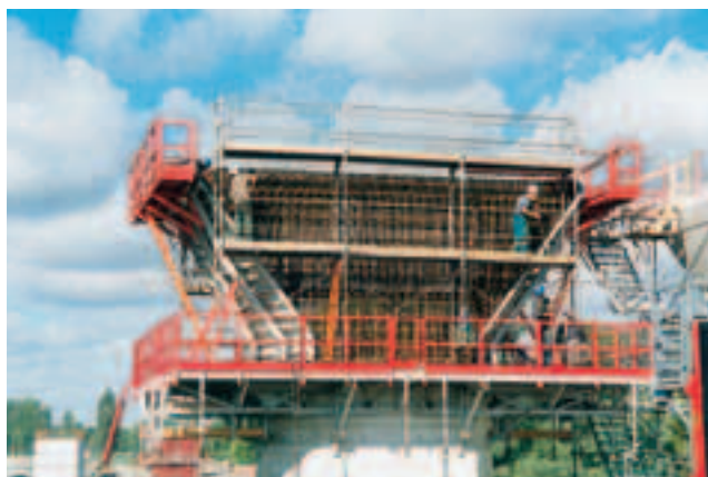
Coffrage ferrillage d'un chevêtre Reinforced shuttering for a pier head
