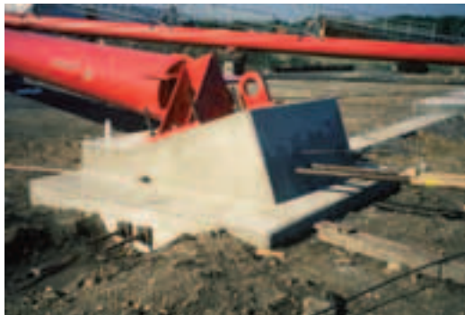
Massifs d'appui des pieds de pylône Tower foundation blocks
