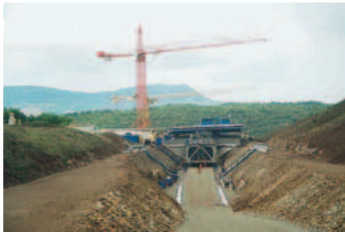
Portique de retournement des demi-caissons du tablier Portal for handling of deck box-girder sections
