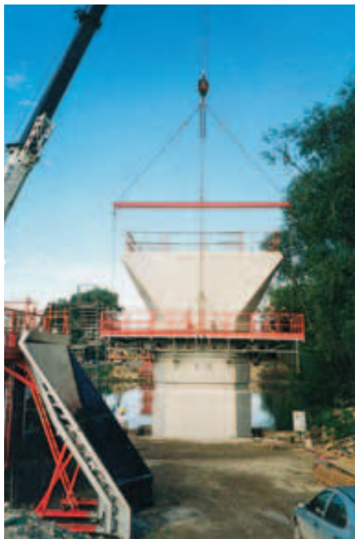
Passerelle pour chevêtre Walkway for pier head
