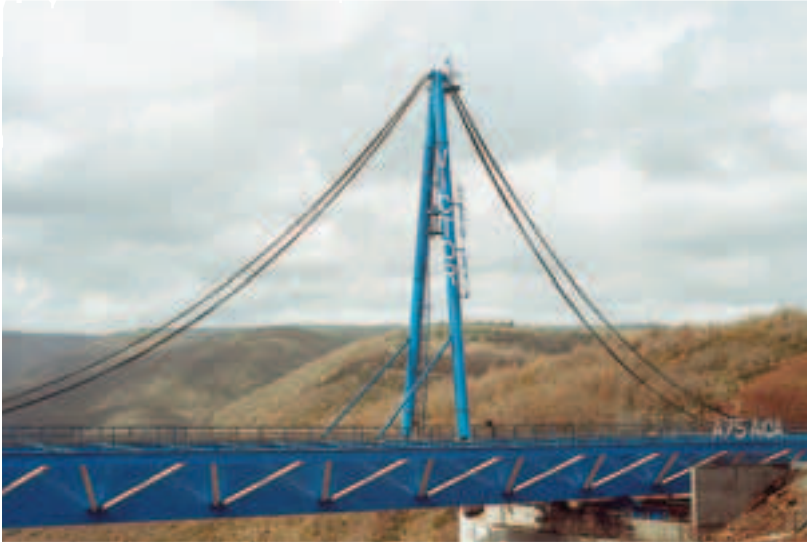
Mât de haubanage provisoire (27 m de haut), haubans en position détendue
