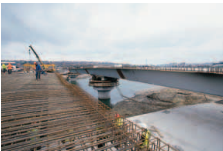
Dispositifs de poussage des structures métalliques des tabliers
