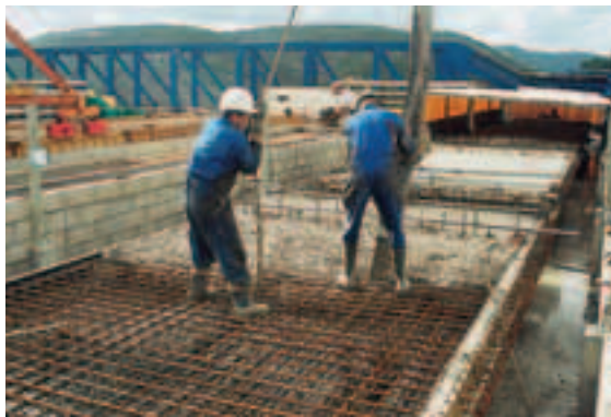
Bétonnage des dalles préfabriquées du tablier sur le chantier (côté nord)
