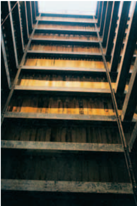
Photo 6 Le puits de sortie The outlet shaft
