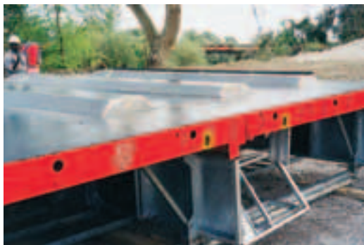
Négatif en tôle pour les nervures boulonnées sur les banches Negative section in sheet steel for ribbing bolted on the shuttering
