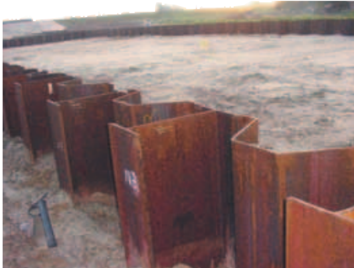
Photo 1 Détail de batardeau - Profils HZ et palplanches Detail of cofferdam - HZ sections and sheetpiling
