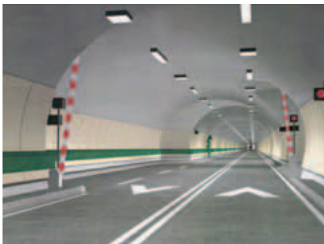
La signalisation dans le tunnel vue au PM 6544 Tunnel signing as seen from point PM 6544
