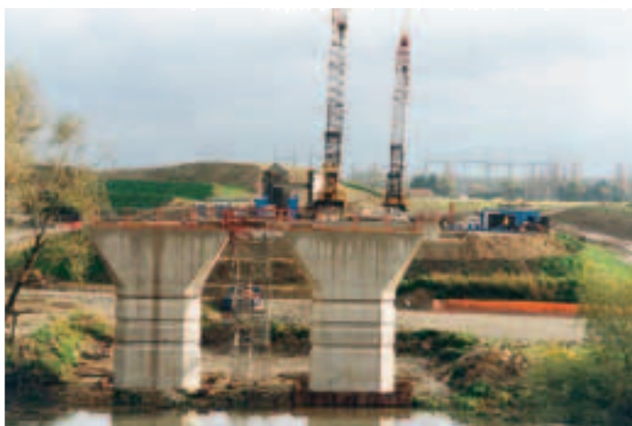
Vue des piles P5. A l'arrière plan, plate-forme de lancement Baudin Chateaufeuf
