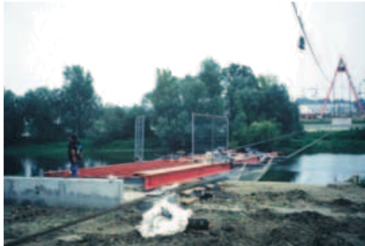
Opérations de lancement du tablier métallique Steel deck launching operations
