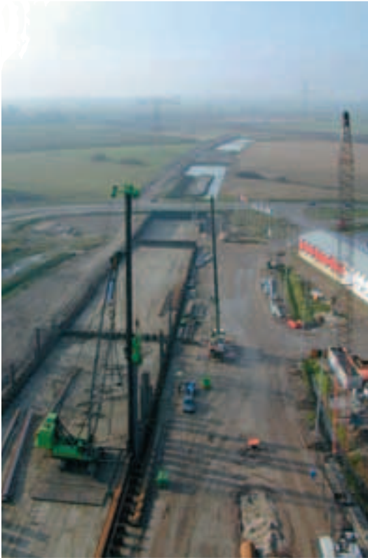
Photo 2 Vue générale des accès côté ouest General view of access on west side
