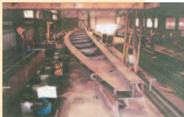
Fabrication en atelier de l'ouvrage
