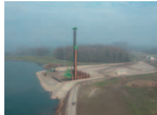
Photo 4 Puits d’arrivée Inlet shaft
