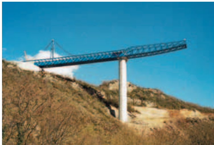
Vue de l'ouvrage après son lancement sur la pile P1 en décembre 1999. On note l'avant-bec de 60 m en porte-à-faux
