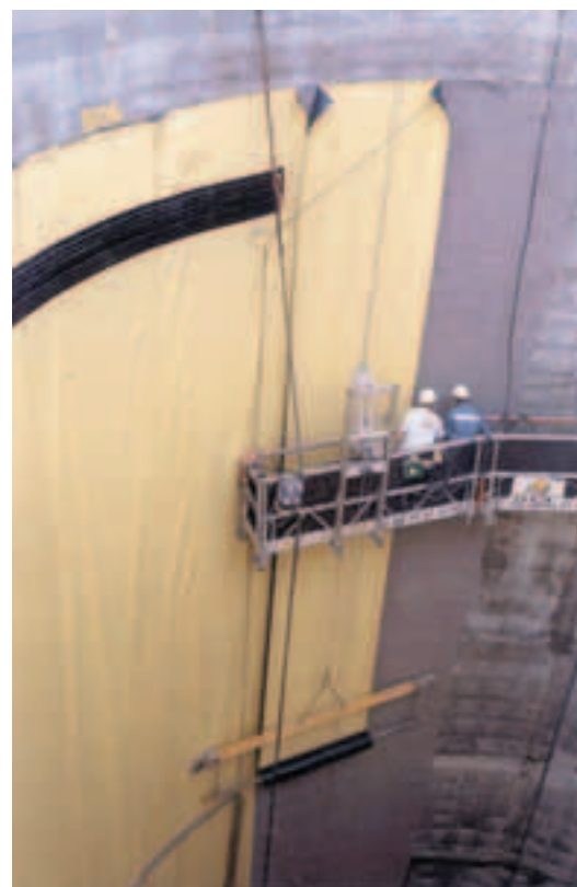
Photo 2 Pose de la géomembrane dans le puits PX 56
