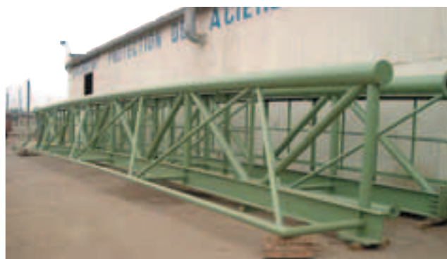
Passerelle piétonne de 36 m passant au-dessus de l'autoroute des plaines à Tahiti
