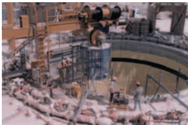
Photo 1 Vue générale du puits PX 56 et du dispositif de congélation
