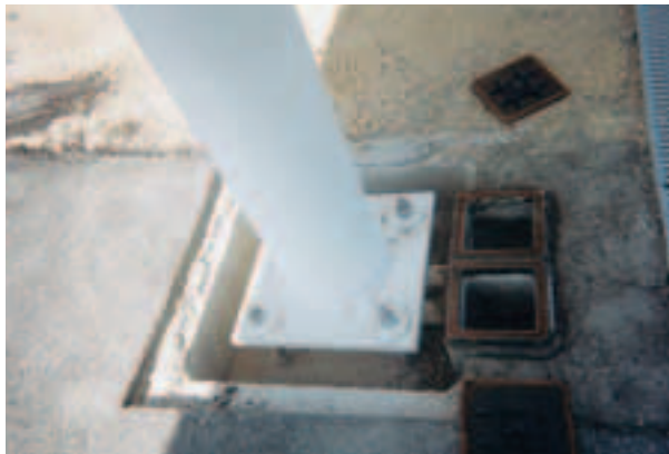
Raccordement gaine ascenseur passerelle
