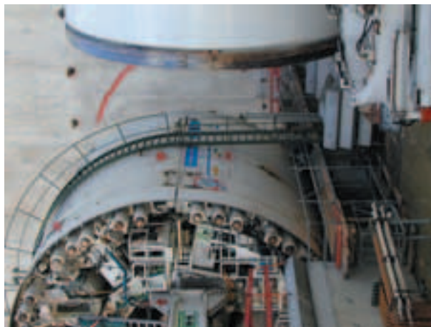
Arcane - Un escalier circulaire permet le montage du tunnelier de Socatop
