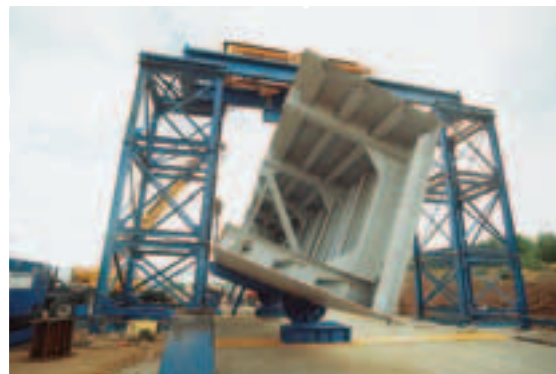
Portique de retournement des demi-caissons du tablier Portal for handling of deck box-girder sections
