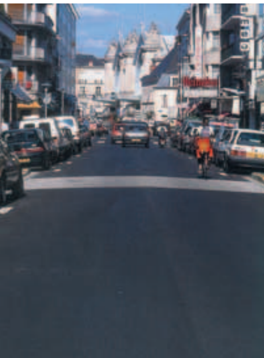
Photo 1 Le béton bitumineux phonique Viaphone
