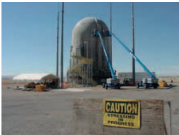
Photo 7 Dans le domaine du nucléaire, Soundprint® permet de suivre les phénomènes de fissuration et donc de s'assurer de l'étanchéité des enceintes de confinement
