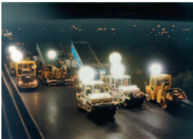
Photo 1 Eclairage adapté aux travaux de nuit sur autoroute
