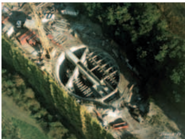
Premier Prix : le puits PIBOP (puits intégré pour bassin d'orage profond) de Méricourt/Billy Montigny, dans le district de Lens-Liévin
