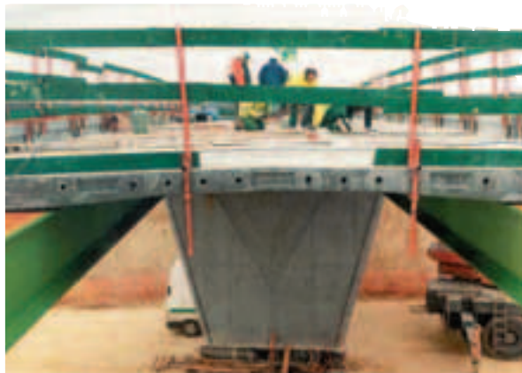
Deuxième Prix ex æquo Rapidopont : pont mixte à hautes performances Second Shared Prize, Rapidopont : high-performance composite bridge
