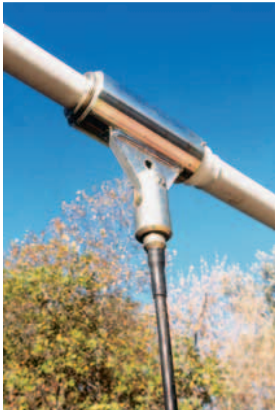
Deuxième Prix ex aequo "Système de suspension autoprotégé étanche". Collier de suspente, pont de la Chartrouse
