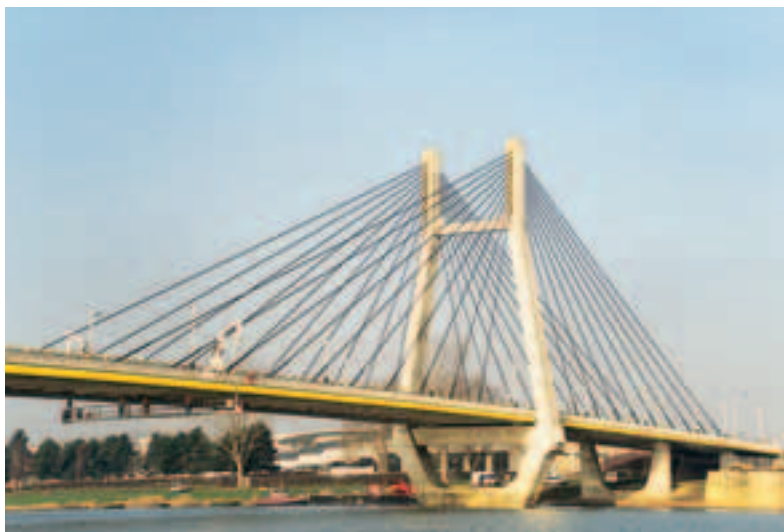
Mise en œuvre de la passerelle de visite "Epsilon" du CETE de Lyon
