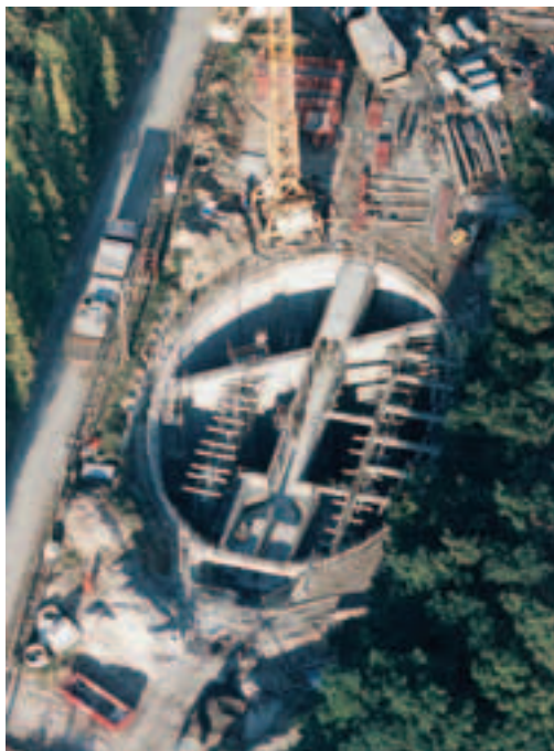
Puits PIBOP. Vue d'avion
