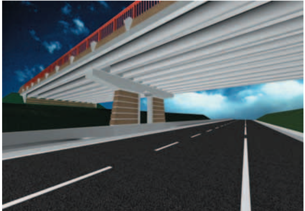
Image virtuelle de l'ouvrage innovant de Bourg-lès-Valence en cours de construction et réalisé en BSI
