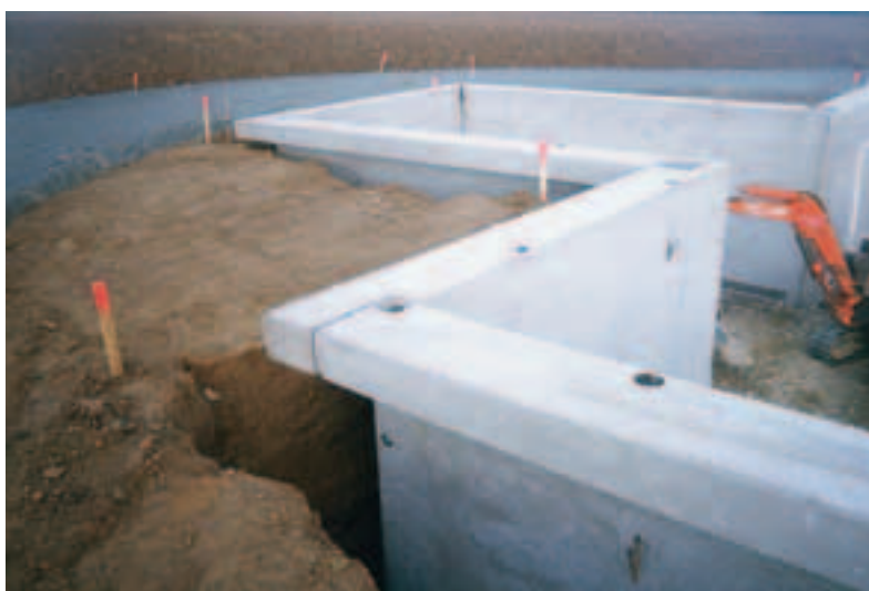
Mur de soutènement préfabriqué pour déchetterie, label IVOR 1999
