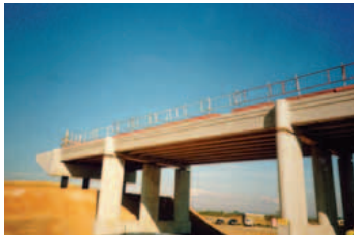
Photo 3 Vue en sous-face d'un ouvrage type Underside view of a typical structure
