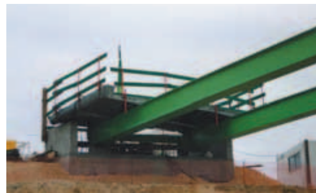
Photo 1 Pont d'autoroute sur l'A16 Bridge on the A16 motorway
