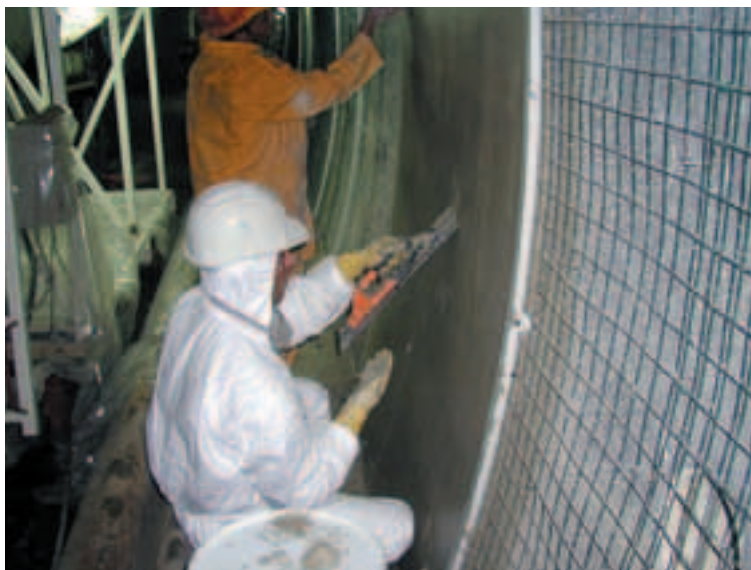
Photo 8 Travaux de projection de produit réfractaire Refractory product projection works
