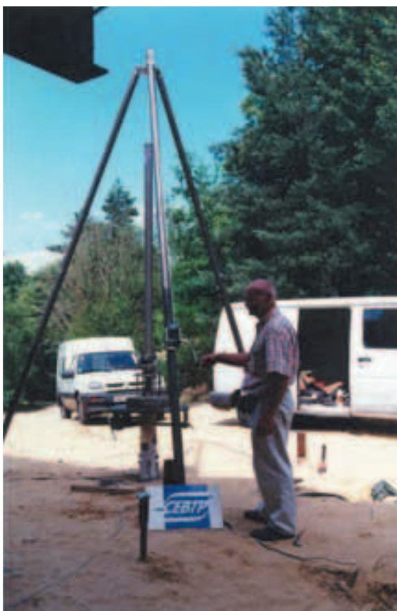
Essai de chargement dynamique d'un micropieu Micropile dynamic loading test
