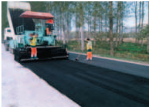
Photo 3 Actichape : nouveau béton bitumineux à froid
