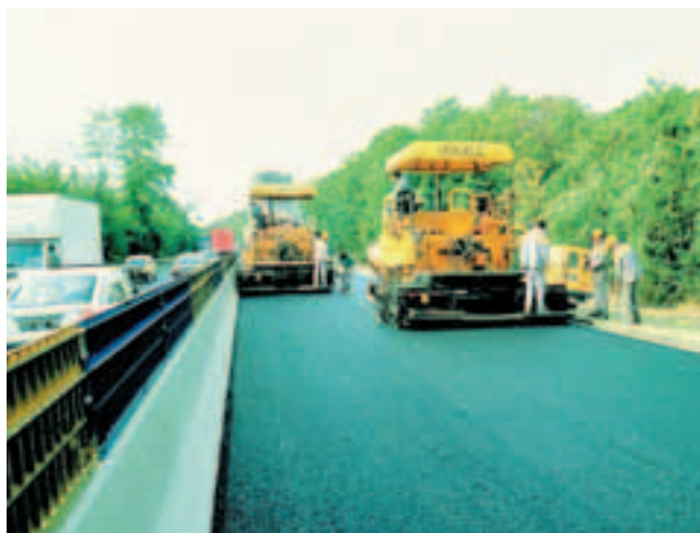
Photo 2 Renforcement de chaussée en enrobé à module élevé
