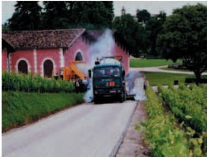
Photo 3 Actichape : nouveau béton bitumineux à froid
