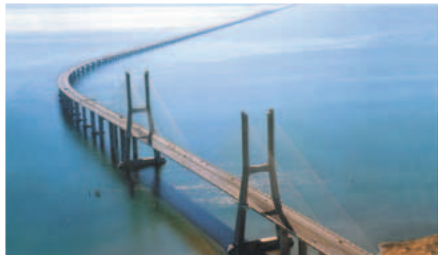
Photo 7 Vue générale du pont sur le Tage General view of bridge over the Tagus
