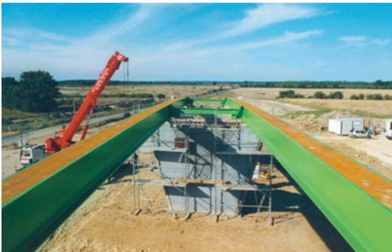
poutres reçoivent une protection tri-couche en totalité sauf les surfaces internes du caisson et la partie supérieure des poutres;
