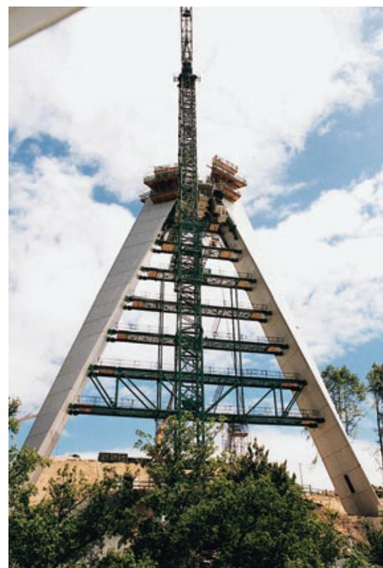
Pylônes en cours de réalisation avec butonnage provisoire
