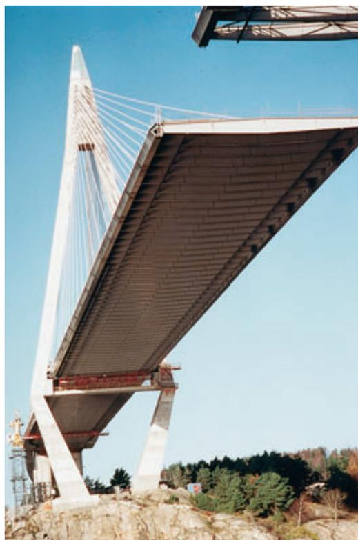
contrainte (photo 3). Les spécifications du projet interdisent toute fissuration sur le pylône durant la phase de construction.
