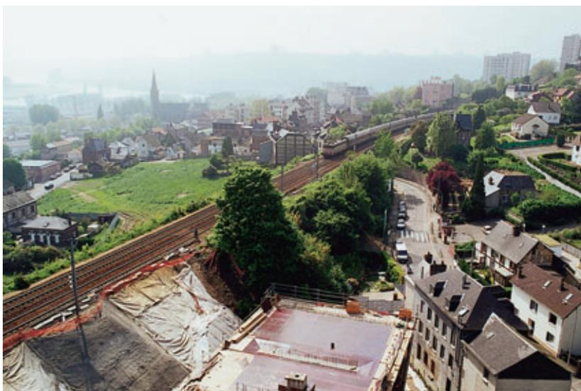
Les concepteurs de TEOR ont opté pour un tracé sinueux respectant des pentes limitées à 4 % et des rayons de courbures de 27 m minimum. TEOR coupe la ligne SNCF avec un biais de 27 degrés, puis plonge à flanc de talus ferroviaire, quasiment parallèlement à celui-ci, avant de bifurquer vers la Seine.
