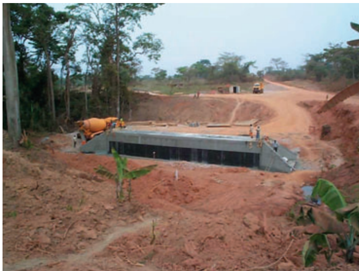
Photo 4 Fossé longitudinal bétonné Longitudinal concrete drainage ditch
