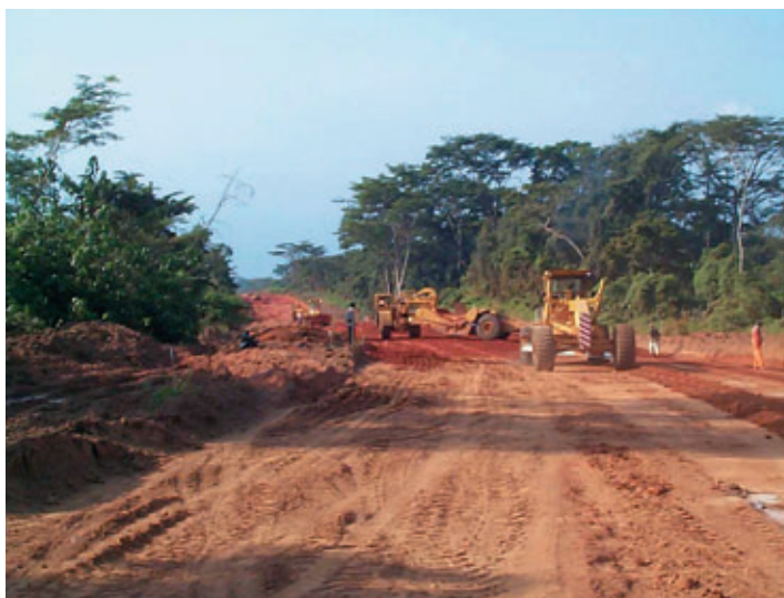
Photo 1 Les terrassements dans les sables Earthworks in sand
