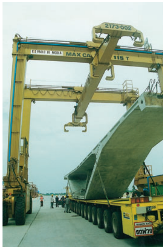
Figure 17 Shuttle-lift for the transportation of D6 segments Navette-ascenseur pour le transport des voussoirs D6
