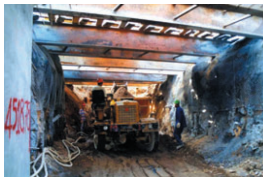
Traversée sous voies ferrées
