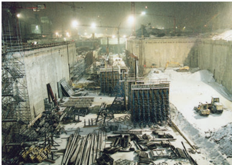
Photo 3 Démontage de la paroi moulée par sciage Dismantling of the diaphragm wall by concrete sawing
