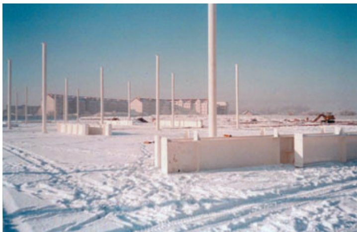
Photo 1 Pose des premiers poteaux de charpente
