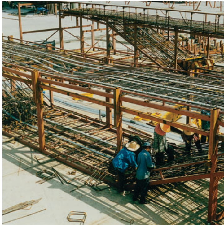
Figure 14 D6 rebar cage Cage d'armatures voussoirs D6
