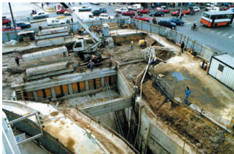
Déversoir principal Main spillway
