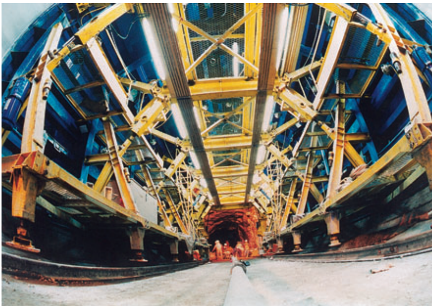
Photo 4 Coffrage type en tunnel
