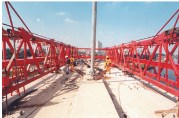
Photo 5 L'équipage vu de dessus Top view of formwork
