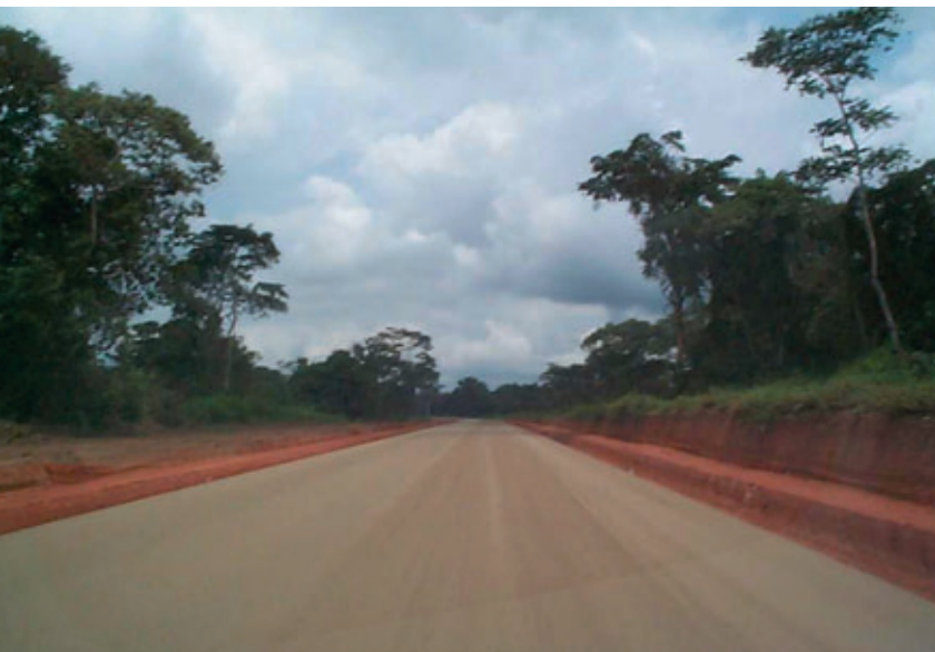
Photo 6 La route bientôt terminée The road, nearing completion
