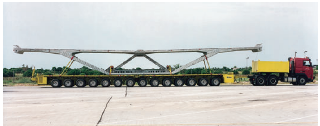
Figure 1 D6 segment on a trailer Voussoir D6 sur une remorque
