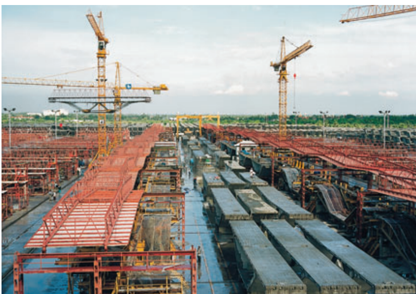
Figure 13 D6 production line Ligne de production des voussoirs D6
