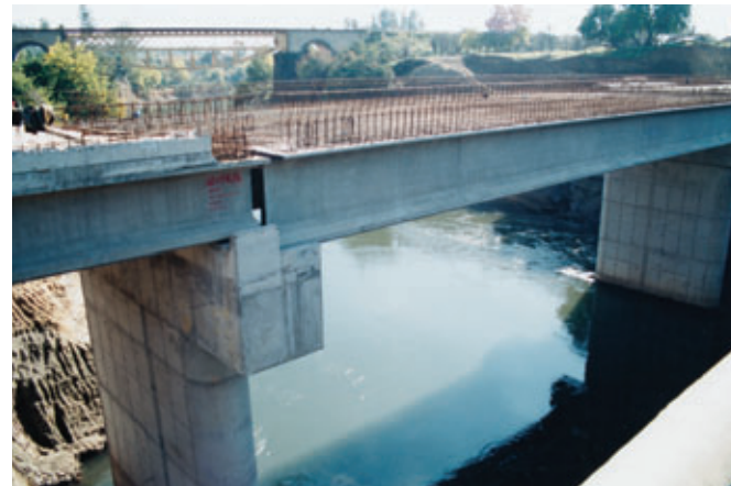
Photo 3 Pose de poutres sur le pont Laja Placing of beams on Laja Bridge
