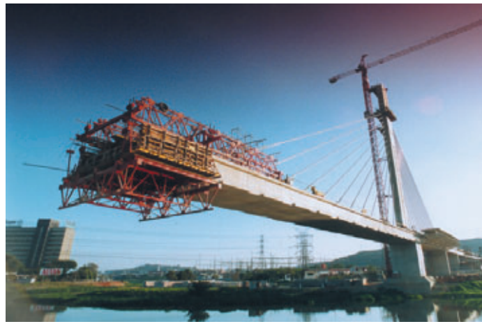
Photo 4 L'équipage en place The rigging in place
