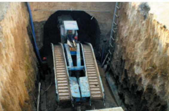
Entrée en galerie par le puits d'attaque Entry into tunnel through driving shaft
