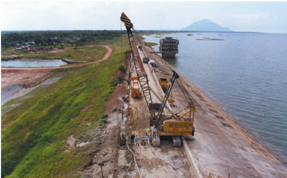
Photo 1 Excavation de la paroi au coulis Excavation of diaphragm wall
