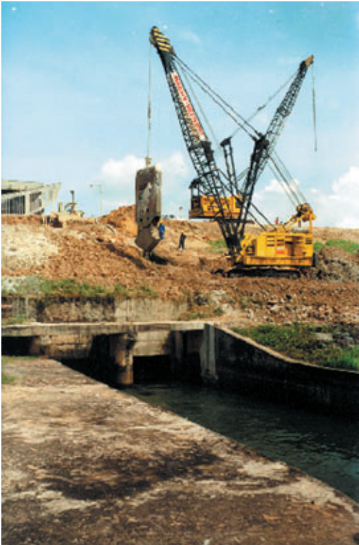
Exécution de la paroi au coulis le long du canal de fuite Construction of diaphragm wall along the discharge channel
