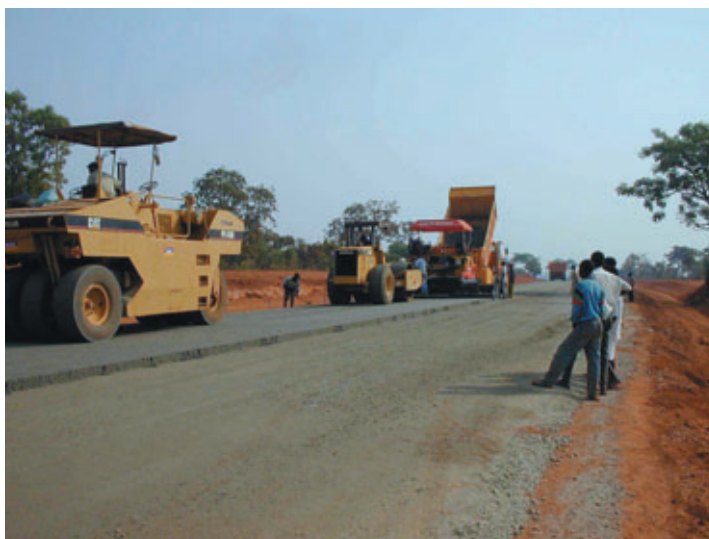
Photo 5 Mise en œuvre de la couche de base Placing the base course
