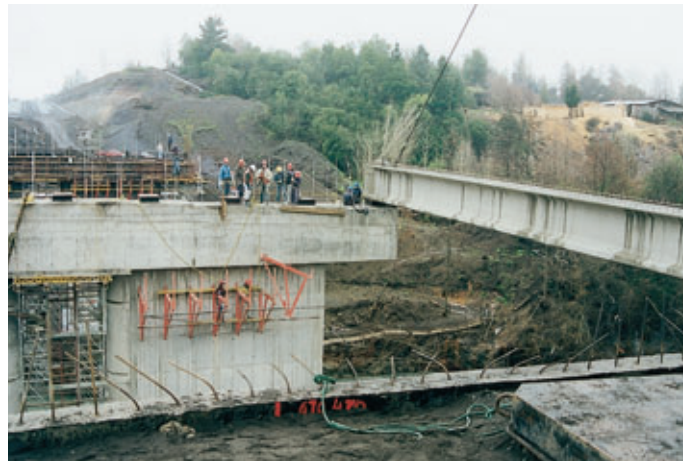
Photo 3 Pose de poutres sur le pont Laja Placing of beams on Laja Bridge
