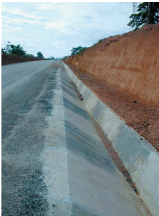
Photo 4 Fossé longitudinal bétonné Longitudinal concrete drainage ditch
