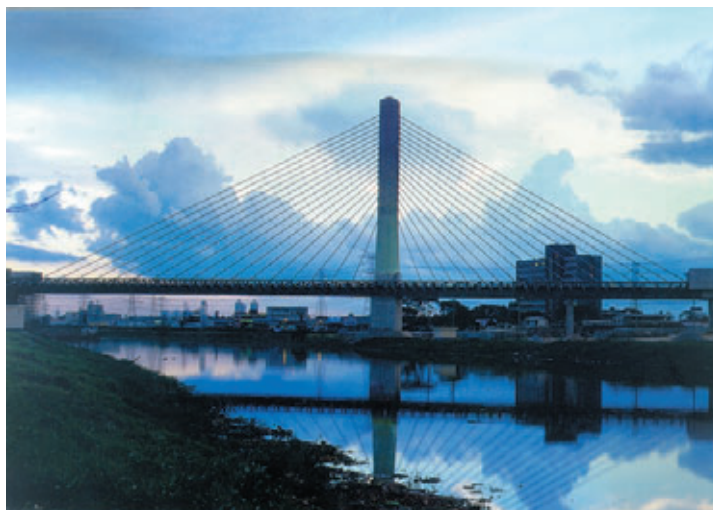
Photo 1 Vue d'ensemble de l'ouvrage Overall view of the structure
