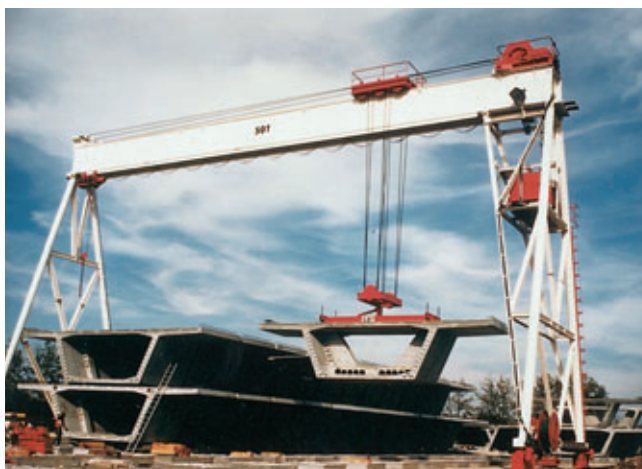
Photo 3 Usine de préfabrication - Stockage des voussoirs Precasting plant - Segment storage
