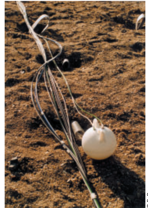
Photo 7 Sonde de suivi des tassements
