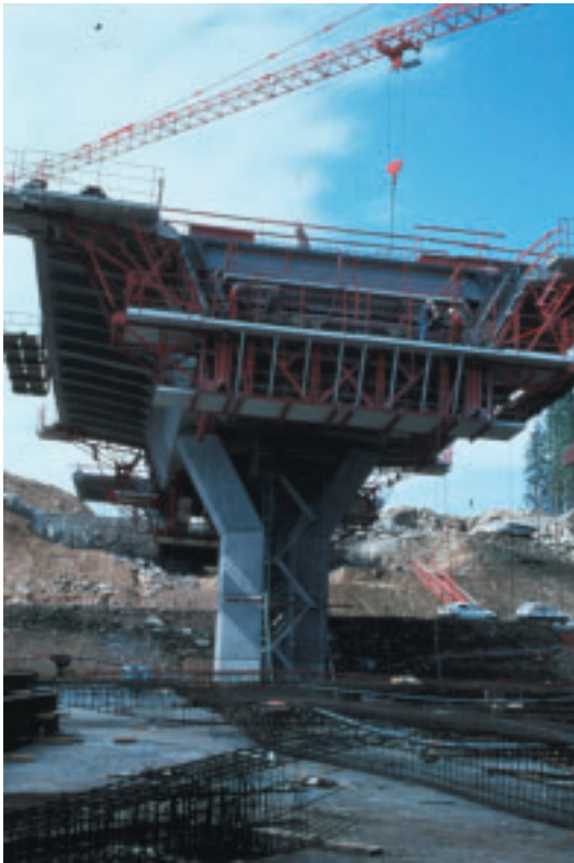
Photo 1 "Cloué" sur la pile par une précontrainte verticale, le tablier supporte un porte-à-faux impressionnant "Nailed" on the pier by vertical prestressing, the deck supports an impressive overhang
