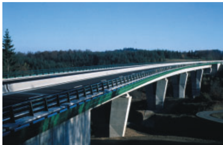
Photo 4 Le viaduc des Bergères dessine une courbe sur un rayon de 1 300 m The Bergères viaduct forms a curve over a radius of 1 300 m
