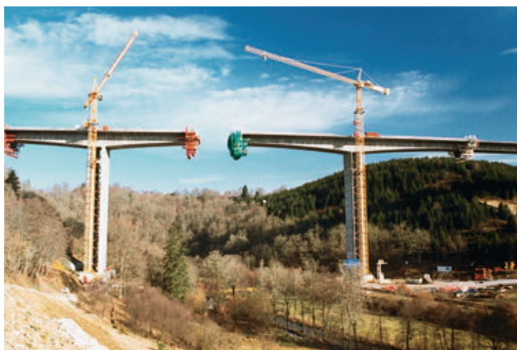
Photo 10 Avancement des travaux en mars 1999 Work progress in March 1999
