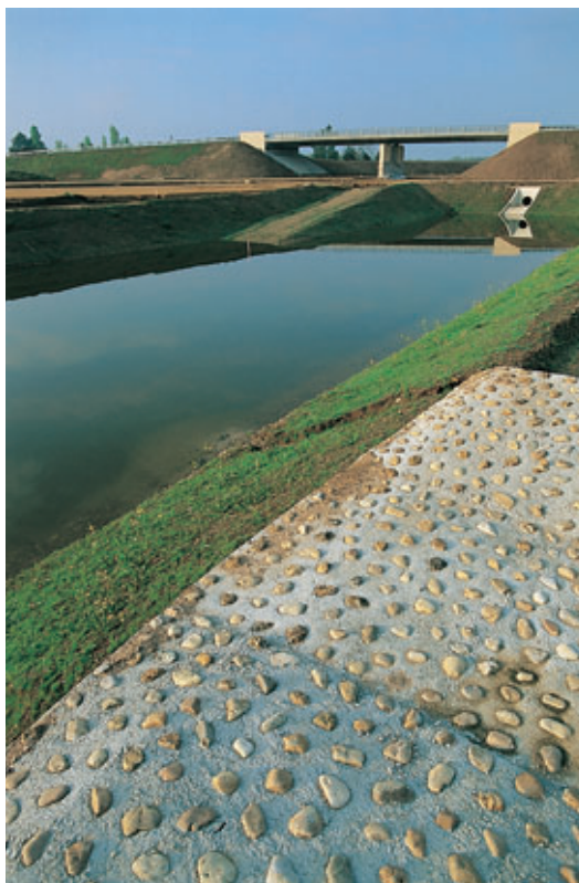
Photo 1 Bassin de traitement des eaux sur Libourne ouest/Coutras Water treatment basin on the Libourne ouest/Coutras section
