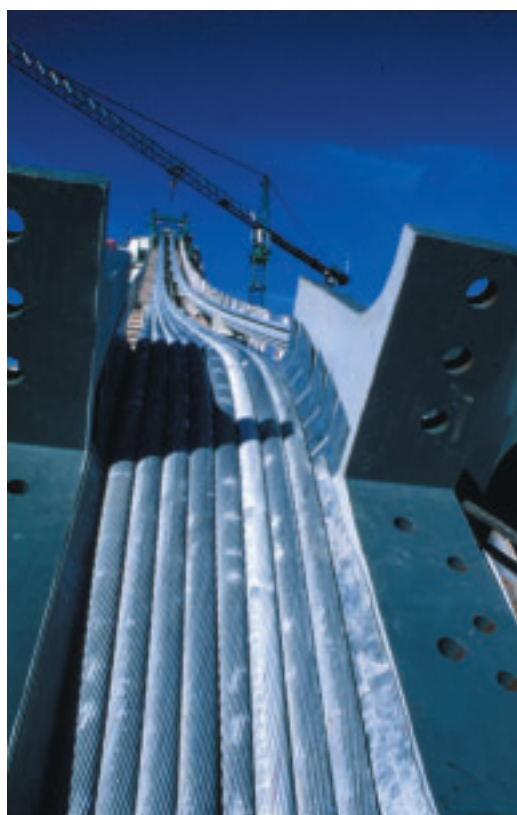
Photo 4 Gros plan sur les torons constituant le câble porteur
