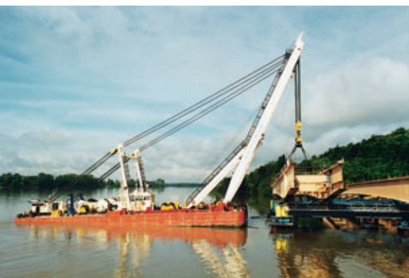
Photo 4 Prise en charge du premier colis Handling the first section
