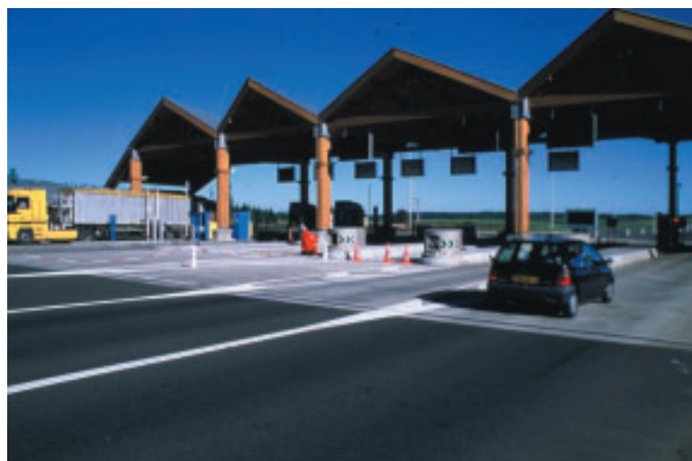
Photo 2 Vue d'ensemble de la gare d'Ussel est General view of Ussel Est toll plaza
