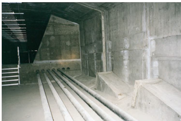
Photo 11 Précontrainte extérieure 27T15 External prestressing 27T15
