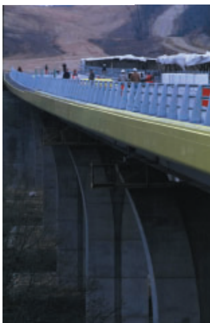
Photo 15 Viaduc de la Crempse sur Montpon/Mussidan Crempse viaduct on the Montpon/Mussidan section
