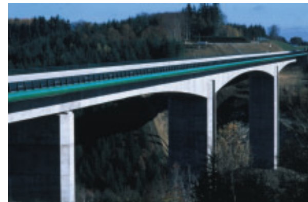
Photo 4 On observe sur cette photo, les piles en double voile et les fléaux à épaisseur variable
