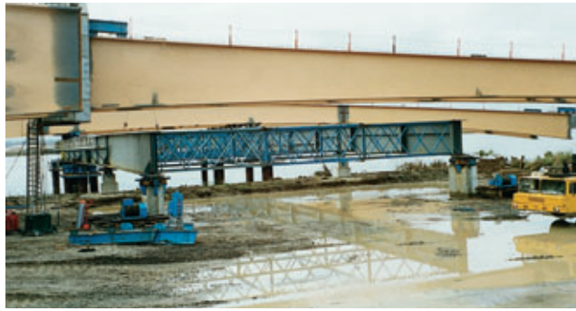
Photo 2 Partie hyperstatique de l'estacade. On remarque les treuils de ripage au pied des rehausses béton The statically indeterminate part of the platform. Note the transfer winches at the base of the concrete side panels
