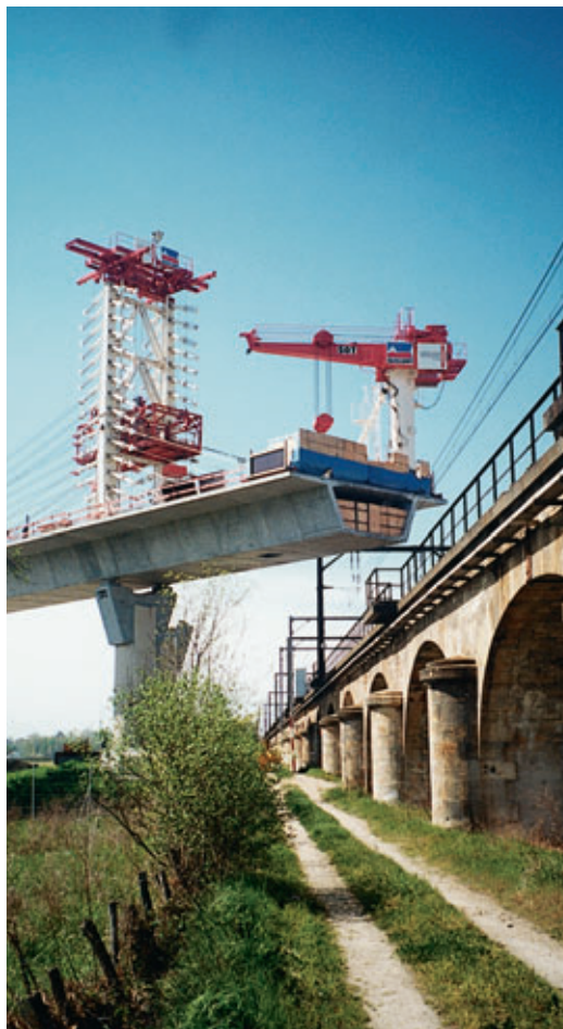
Photo 6 Franchissement du viaduc des 100 Arches 100 Arches viaduct crossing
