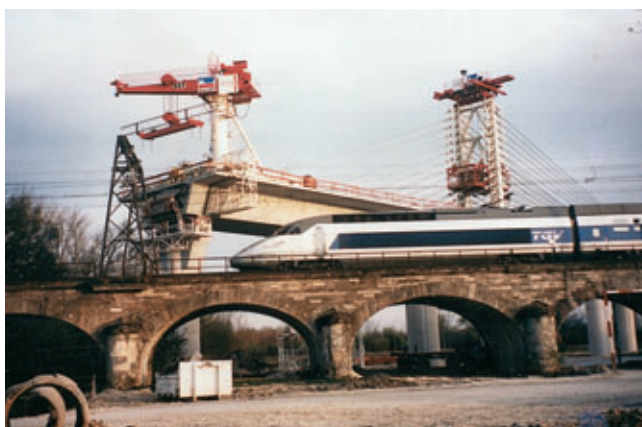
Photo 1 Le viaduc des 100 Arches The 100 Arches viaduct
