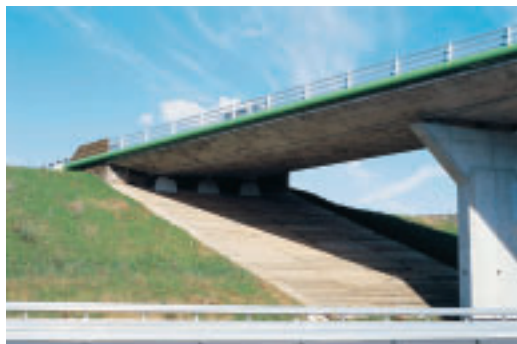
Photo 2 Ambiance bois pour les perrés de ce passage supérieur
