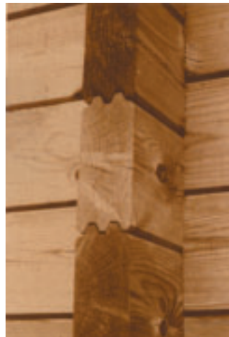
Photo 5 La structure porteuse en madriers massifs empilés The bearing structure in stacked solid planks
