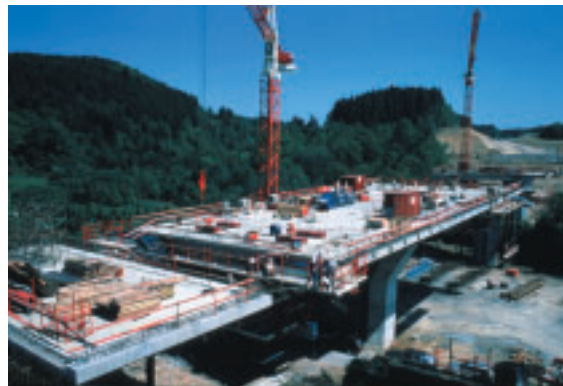
Photo 2 Le tablier a été construit par encorbellements à partir d'équipages mobiles The deck was built by cantilevering on travelling formwork
