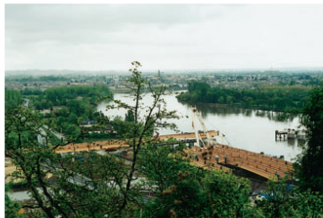
Photo 3 Vue de la bigue finissant la pose du premier colis et de l'estacade chargée des quatre autres colis du premier tablier plus le premier colis du second tablier View of crane placing the first section and the platform loaded with four other sections of the first deck plus the first section of the second deck
