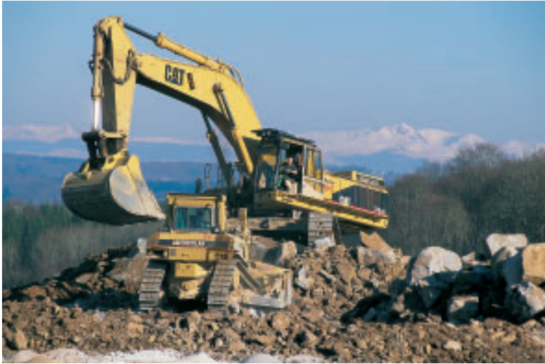
Photo 4 Construction de l'A89 sur fond de Sancy enneigé
