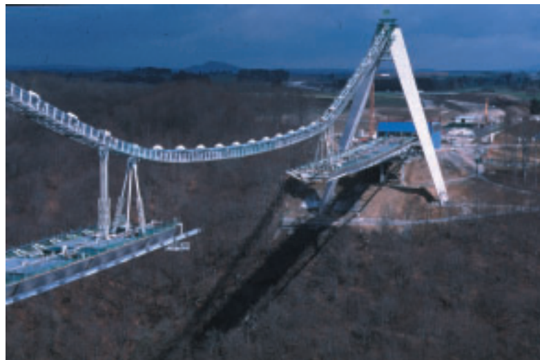
Photo 2 A la conquête du vide, le lancement du tablier selon la "méthode Tarzan"
