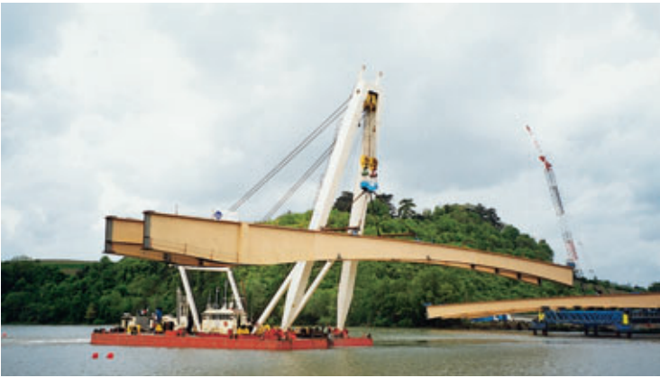
Photo 5 Transfert d'un élément de 95 m de long et 360 t Transferring a 360-t element 95 m long
