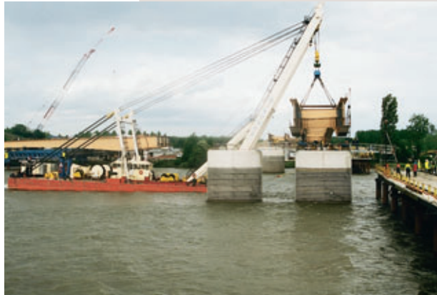
Photo 6 Pose du deuxième colis. On remarque en jaune l'élingue ceinturant la pile Placing the second section. Note, in yellow, the sling around the pier
