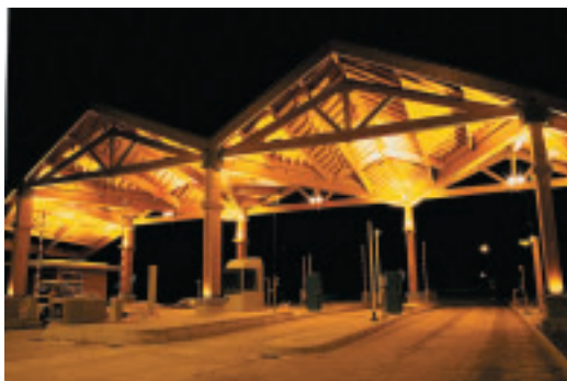
Photo 3 Sur les 192 km de l'A89 entre Corrèze et Puy-de-Dôme, les auvents des gares de péage seront en pin rouge
