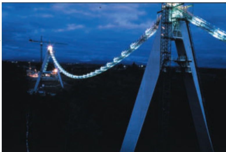
Photo 3 Le "pont de singe" est en place pour la pose des câbles et des suspentes
