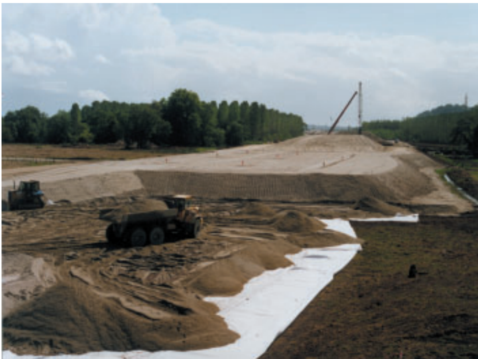
Photo 6 Mise en place du remblai de préchargement sur Bidim
