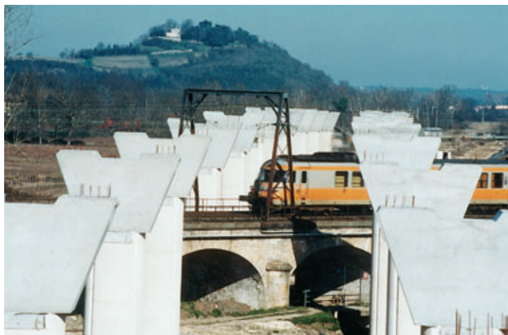
Photo 2 Réalisation des appuis Work on the bearings
