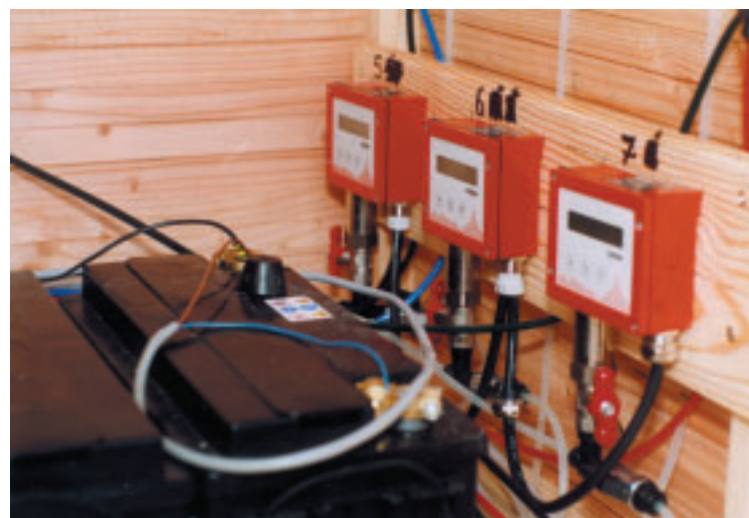
Photo 8 Appareillage de recueil des données du suivi des tassements
