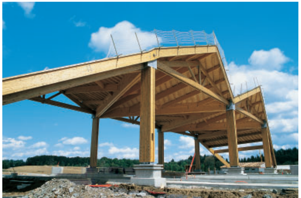
Photo 1 L'auvent de la gare d'Ussel est en chantier (août 1999)
