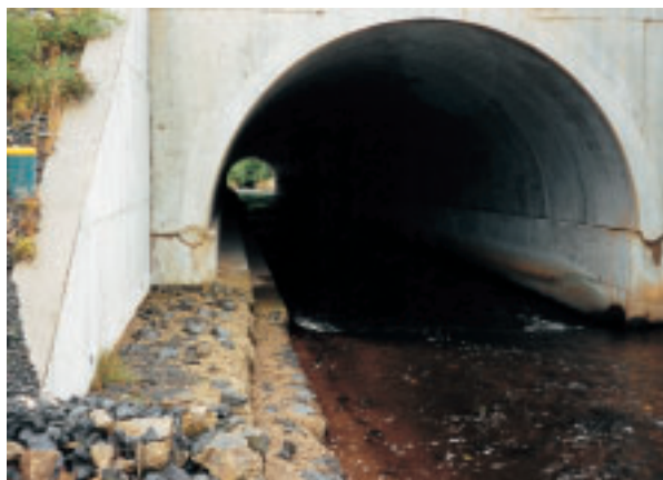
Photo 2 Dans les tunnels, des marches ont été posées à différentes hauteurs pour que le passage à sec soit possible même lors de crues importantes
