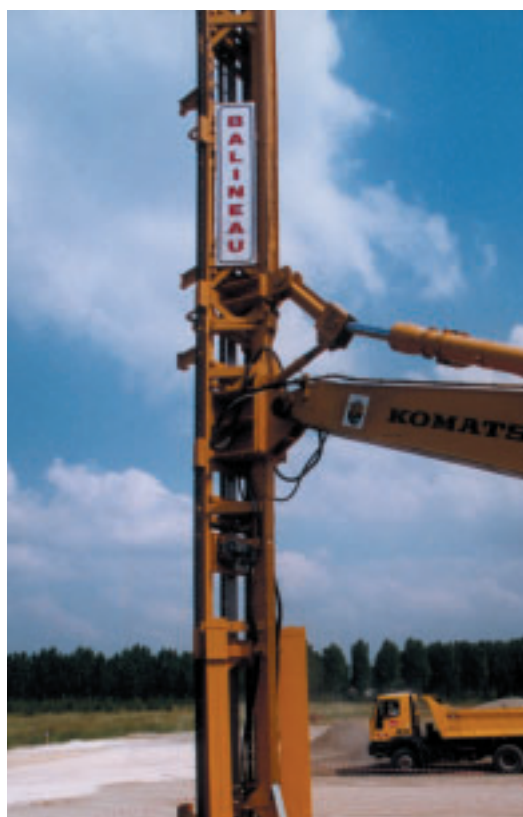
Photo 5 Mise en place des drains verticaux Setup of vertical drains
