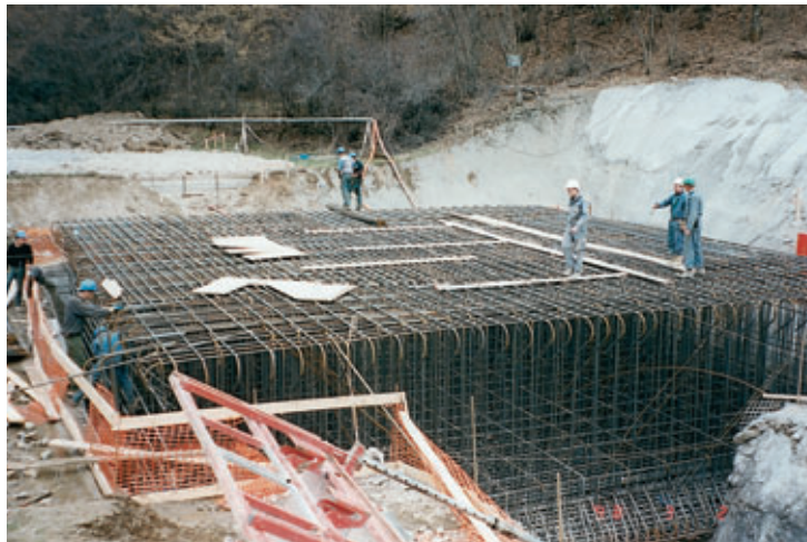
Photo 3 Semelle de la pile P3 Footing of pier P3
