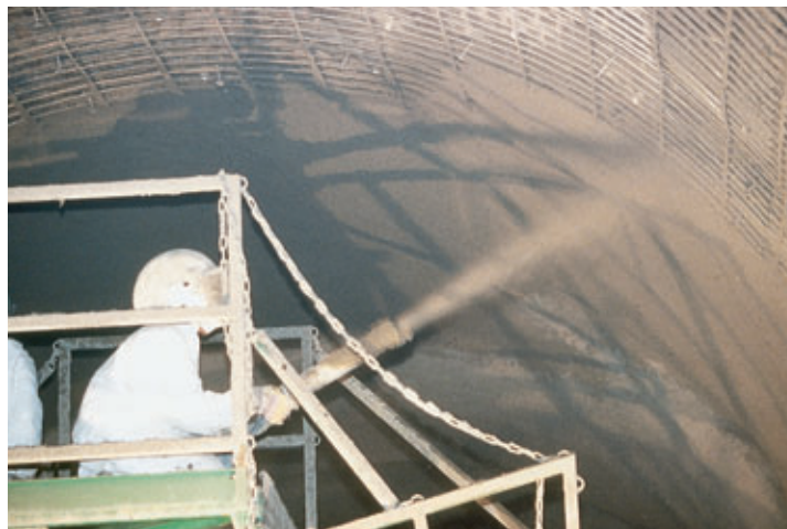
Photo 3 Projection de béton RIG RIG shotcreting
