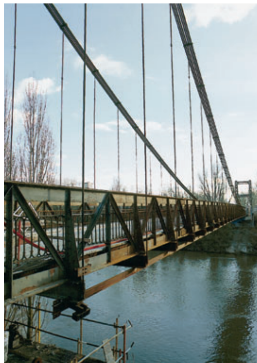
Photo 1 Vue générale depuis la rive General view from bank
