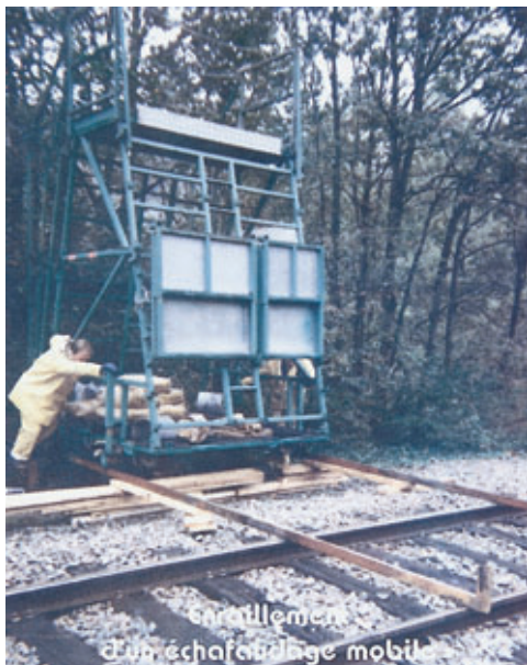
Photo 5 Enraillement d'un échafaudage mobile Placing of mobile scaffolding on rails
