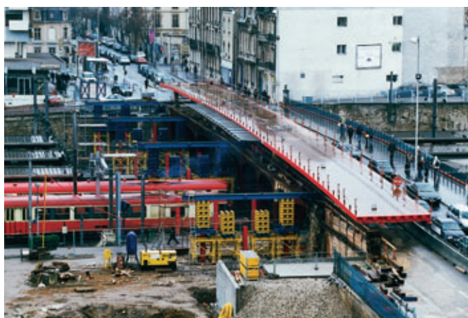
Photo 1 Vue générale de l'ouvrage avant le premier ripage General view of the structure before first displacement
