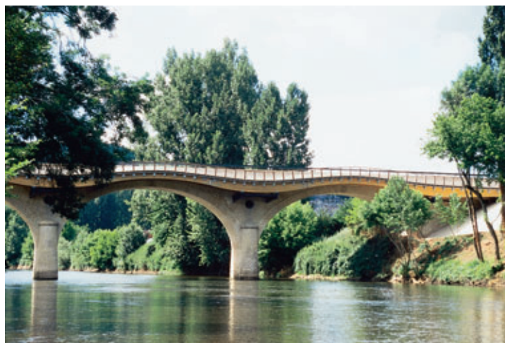
Vue de la Vézère View of the Vézère
