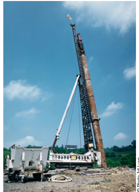
Photo 1 Sonnette de battage type Fundex F12 Fundex F 12 pile hammer
