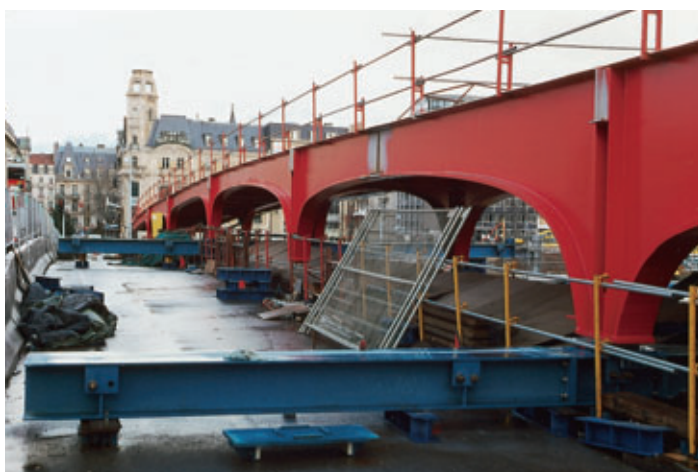
Photo 2 Vue sur le pont après le premier ripage : zone de chantier sur l'ouvrage existant View of bridge after first displacement : working zone on existing structure
