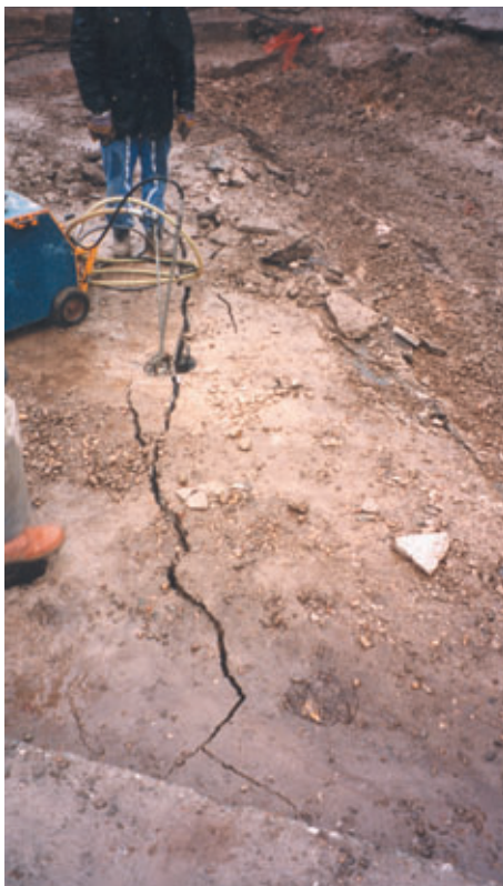
Photo 1 Démolition par éclateur hydraulique Demolition by hydraulic splitter
