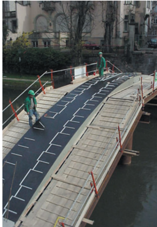
Photo 3 Détail du cintre et du coffrage de la sous-face Detail of underside shuttering and centring
