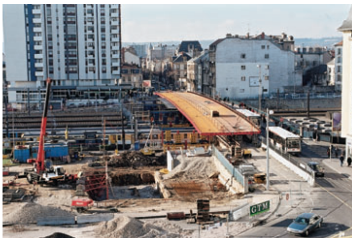
Photo 3 Vue de l'ouvrage complet avant le deuxième ripage View of complete structure before second displacement
