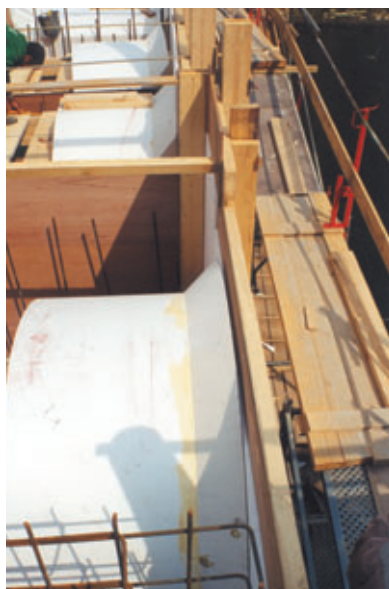
Photo 4 Coffrage des tympans cintrés Shuttering of centred tympan
