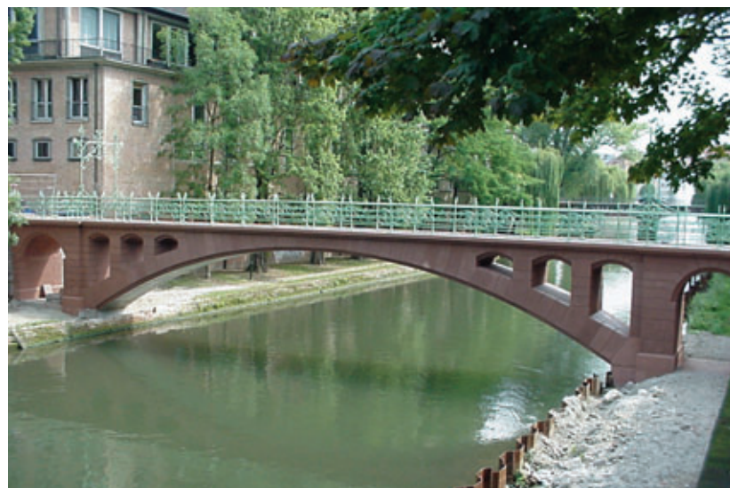
Vue générale de l'ouvrage reconstruit General view of reconstructed structure
