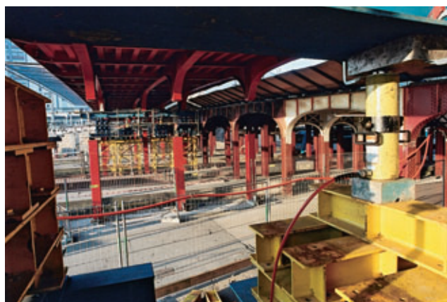
Photo 4 Vue du tablier avant sa descente sur appuis View of deck before lowering onto supports
