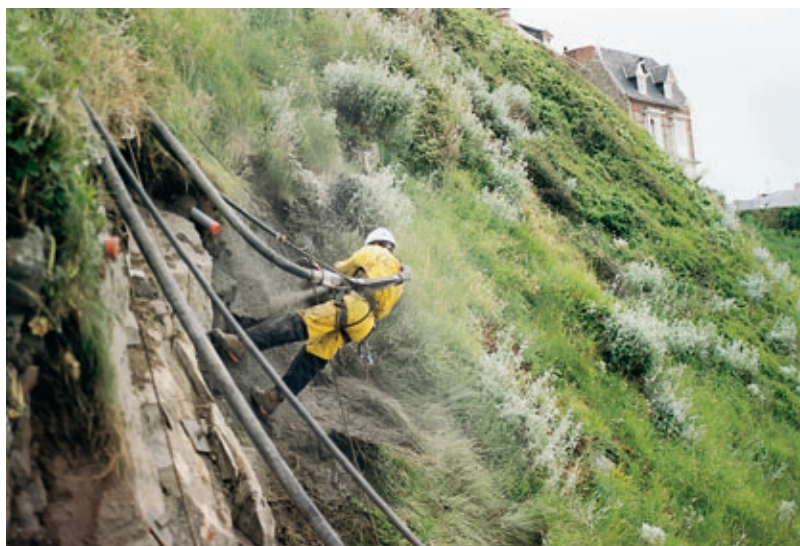
Photo 2 Exécution du béton projeté sur cordes Applying shotcrete on cords
