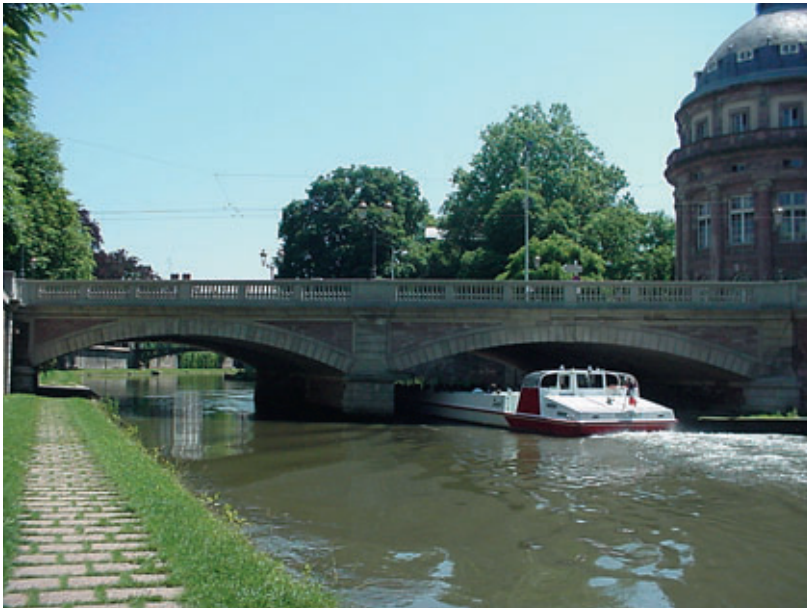
Vue générale de l'ouvrage General view of the structure
