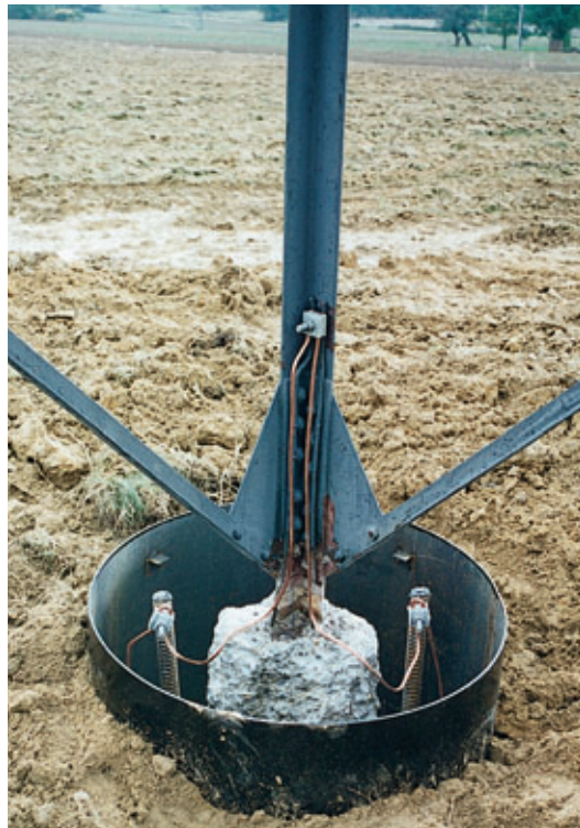
Photo 2 Renforcement par deux micropieux forés injectés d'une fondation superficielle (avant bétonnage du massif de liaison)
