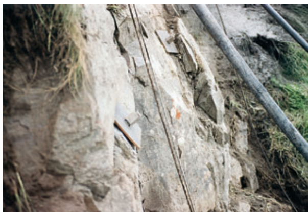
Photo 1 Vue de détail clous des masses rocheuses instables Detail view of nails in unstable rock masses
