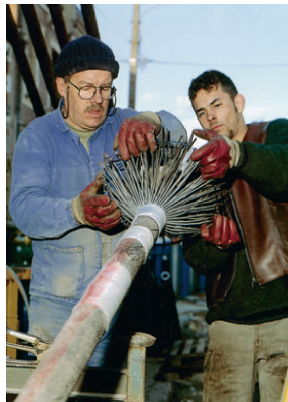
Photo 5 Culottage au zinc Zinc capping
