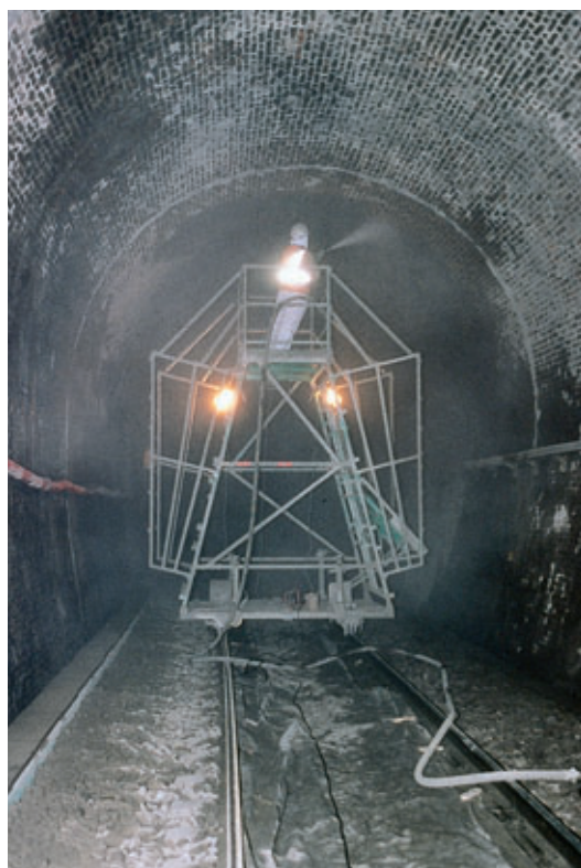
Photo 1 Hydrosablage - Hydrosablage
