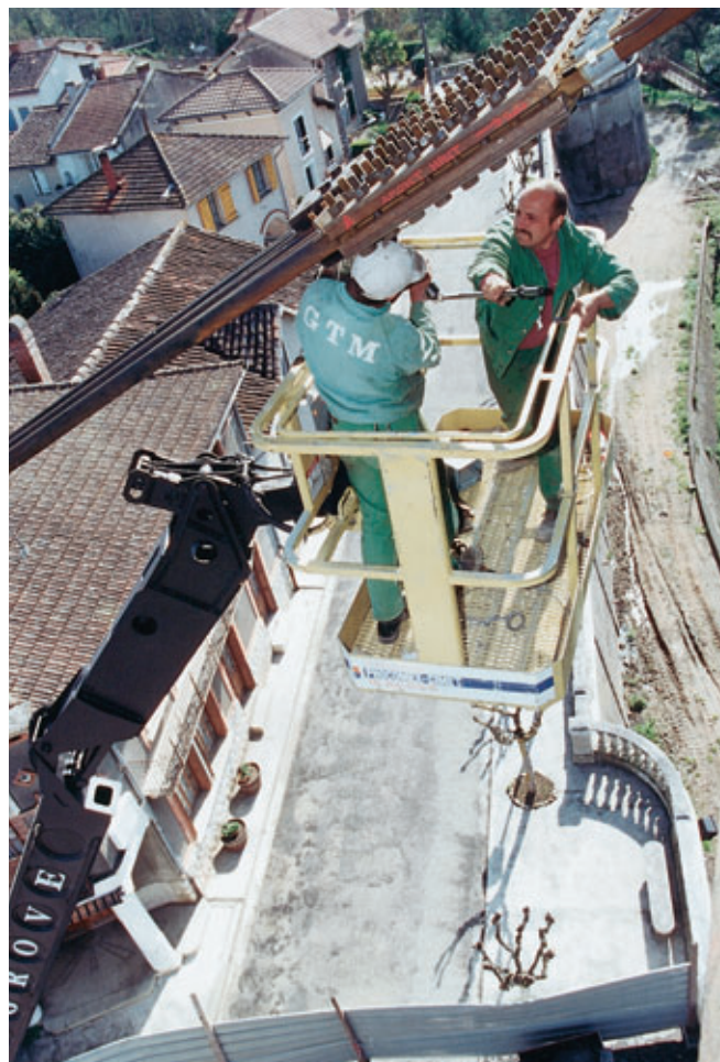
Photo 3 Serrage d'une mordache depuis la nacelle
