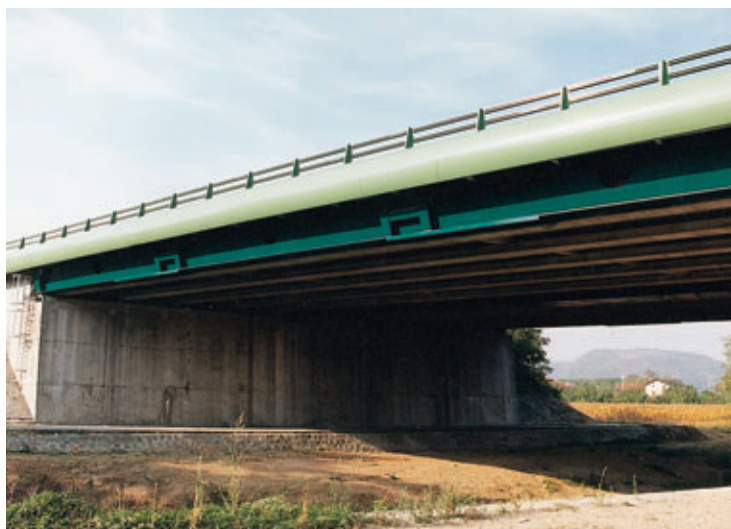
PI 250 - Le Dolon. Ouvrage après travaux
