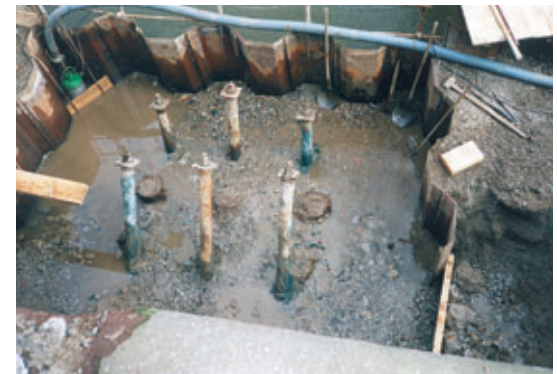
Photo 2 Les têtes de micropieux au milieu des pieux bois existants
