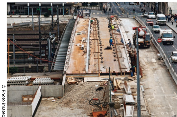
Photo 5 Travaux de superstructure : bordures, corniches, rails Superstructure works : curbs, cornices, rails
