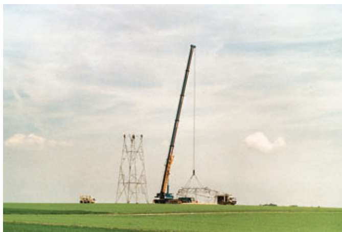
Photos 3 à 6 Levage d'une tête de pylône 400 kV Lifting a 400-kV tower head
