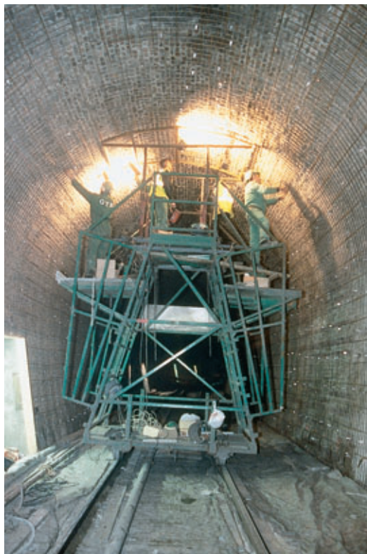
Photo 2 Pose des panneaux de treillis soudé
