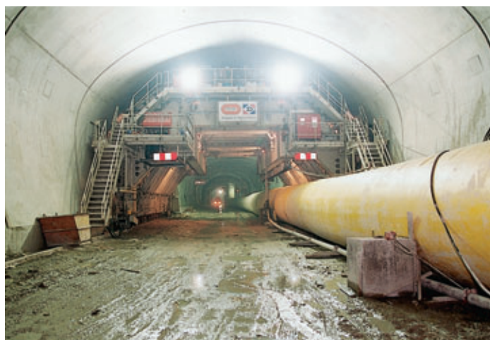
Photo 8 Tunnel Ha Kwa Chung - Revêtement définitif et coffrage précontraint
