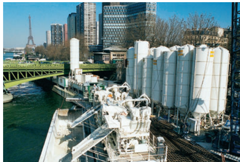
Photo 1 Vue d'ensemble de la zone d'installation de chantier, avec au premier plan, les deux unités de recyclage Caviem SB16 disposées au-dessus de la barge à déblais
