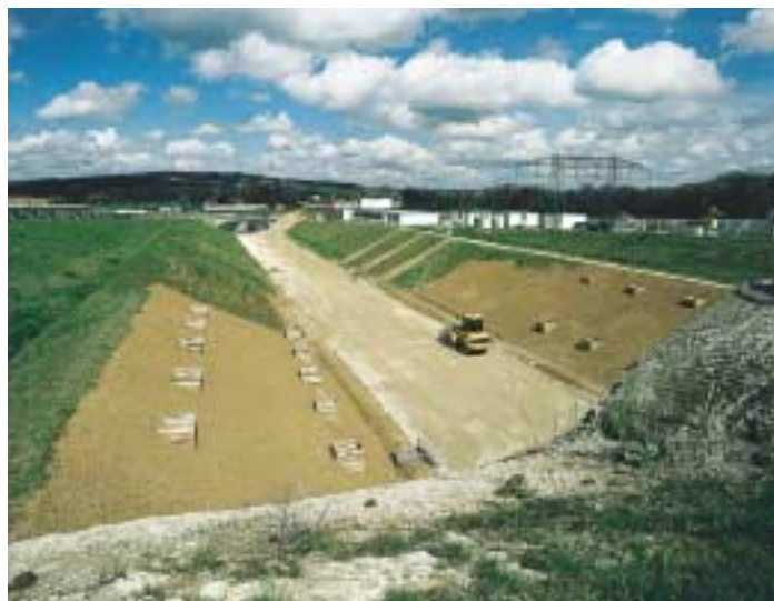
Tranchée d'accès au tunnel Tunnel access trench
