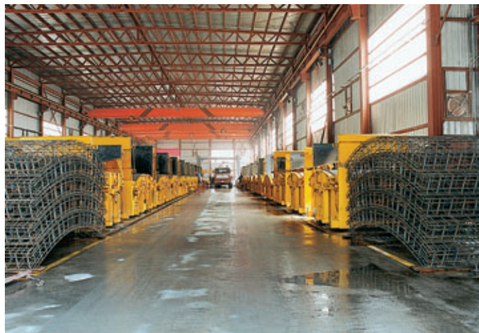
Photo 11 Usine de préfabrication - Cages et moules Pre-casting plant - Cages and moulds
