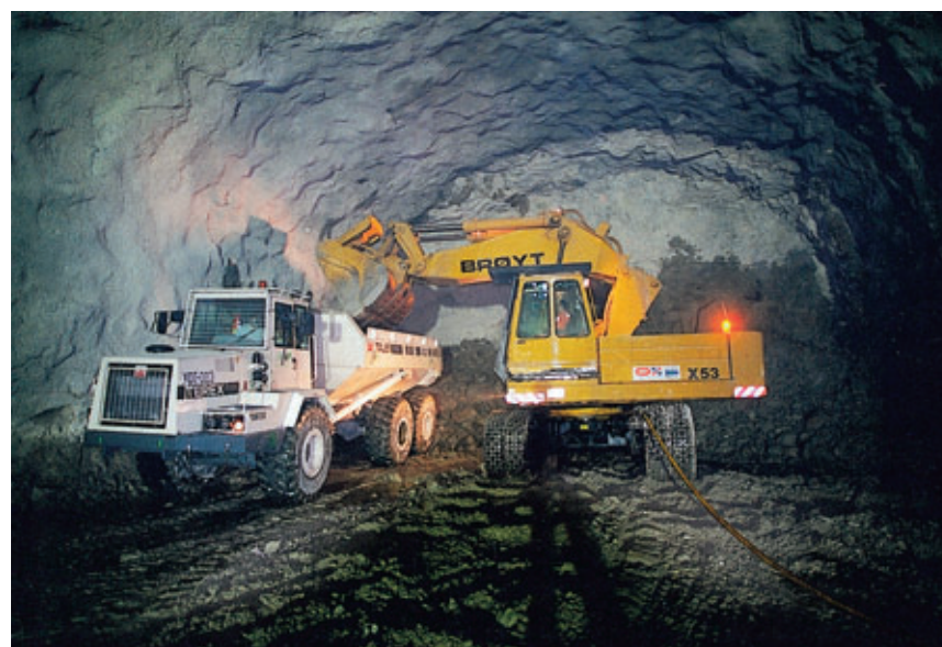
Photo 7 Tunnel Ha Kwa Chung - Marinage de l'excavation
