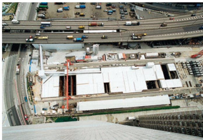
Photo 5 Vue d'avion du puits J et des protections acoustiques Aerial view of shaft J and blast protection
