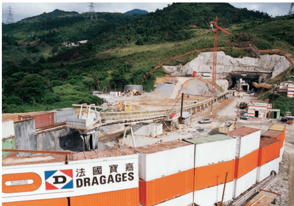
Photo 2 Vue du convoyeur à l'extérieur avec jetée des matériaux et magasin de bande View of conveyor on the outside with material discharge point and belt storehouse
