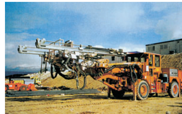
Photo 12 Le Para 206-90 sur le chantier de Driskos dans les montagnes du Pinde, près de la ville grecque d'Ioannina
