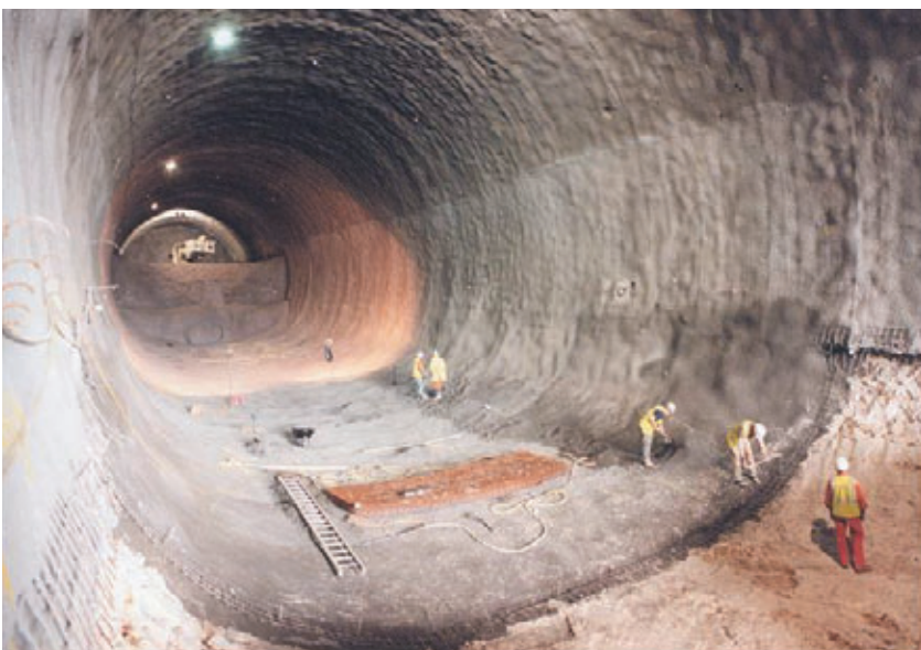
Photo 1 Vue de la section complète excavée View of complete excavated section
