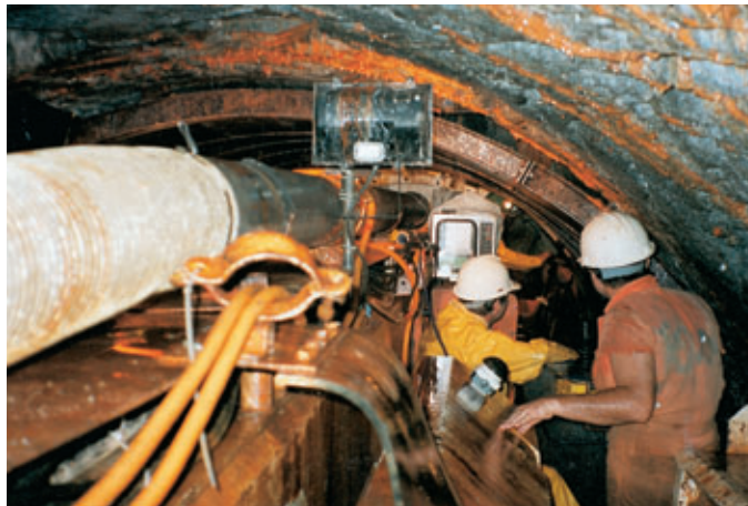
Photo 21 Forage de reconnaissance à l'avancement sur collecteur Chain Wan - Hong Kong
