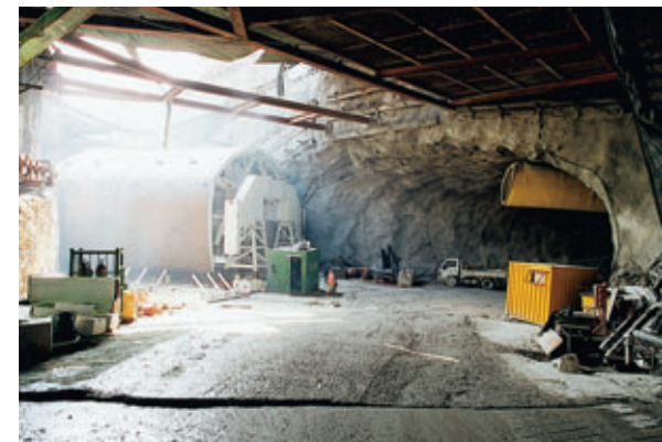
Photo 1 Vue de l'entrée du tunnel depuis le puits A View of tunnel entrance from shaft A
