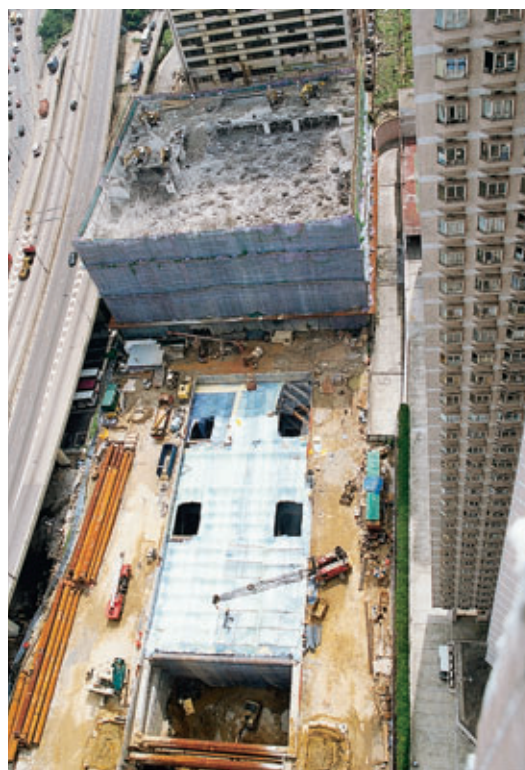
Photo 4 Vue d'avion du puits J et protection contre les tirs d'explosifs Aerial view of shaft J and blast protection
