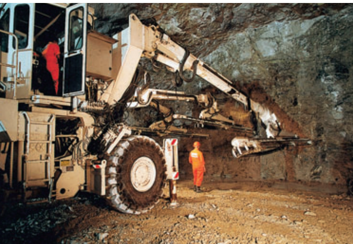
Photo 6 Tunnel Ha Kwa Chung - Foration des trous d'explosifs au robofore
