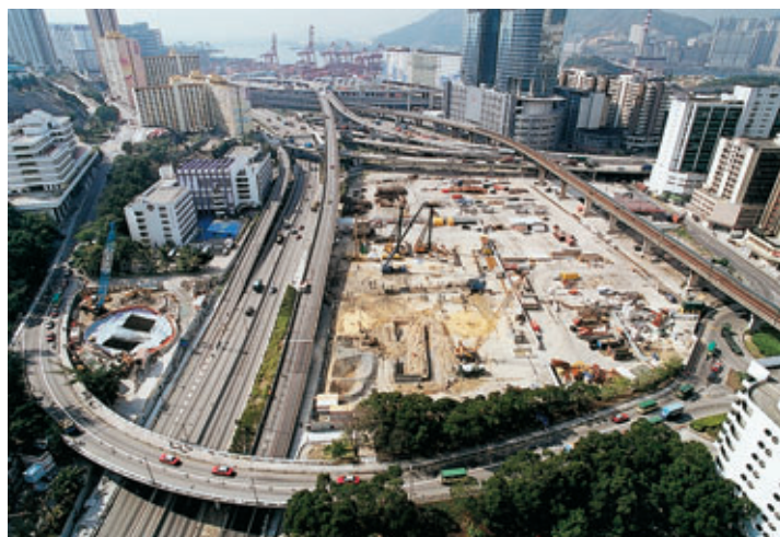
Photo 2 Vue d'avion du puits D, E et des fondations du bâtiment de ventilation Aerial view of shaft D, E and foundations of ventilation building
