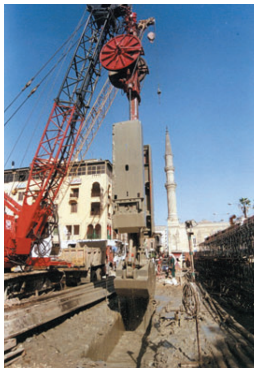
Les travaux spéciaux du chantier d'El Azhar Special works of the El Azhar project
