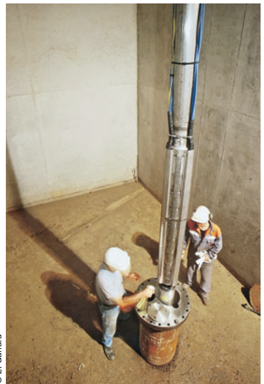
Descente de la pompe dans le puits de la Madone Lowering of pump into the Madone well
