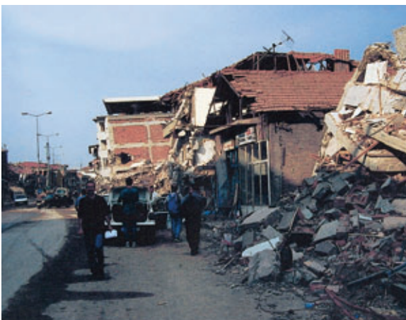
Photo 2 Adapazarı - Turquie (1999). Effets de site possibles sur alluvions lâches Likely site effects on unconsolidated alluvial deposits
