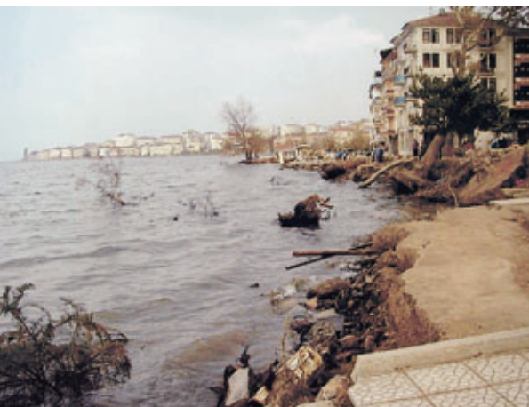
Photo 15 Gölcük - Degirmendere - Turquie (1999) Glissement latéral avec disparition d'un hôtel en mer Lateral spreading with sinking hotel
