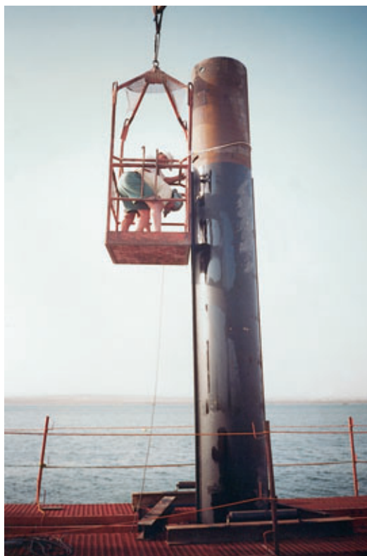
Photo 5 Installation des capteurs Sensor installation
