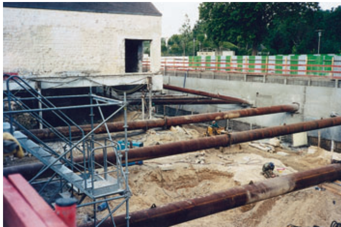
Photo 2 Vue générale du butonnage. Première nappe General view of struts. First layer
