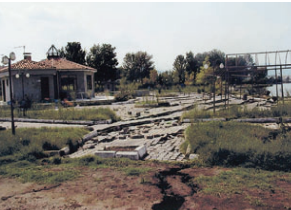
Photo 14 Gölcük - Turquie (1999) : Glissements latéraux dus à la liquéfaction et fissures de sol Lateral spreading due to liquefaction and soil cracks
