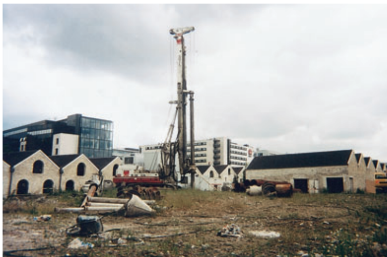
Photo 1 Vue générale avec les chais conservés. Réalisation des pieux berlinois à partir du terrain naturel
