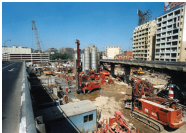
Photo 5 Puits de sortie et tranchée couverte d'Attaba, vue générale du chantier Exit shaft and cut-and-cover structure trench of Attaba, general view of site
