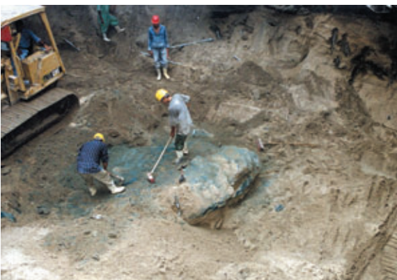
Photo 4 Dégagement du plot d'essai d'injections de coulis Microsol Clearing of Microsol slurry grouting test point
