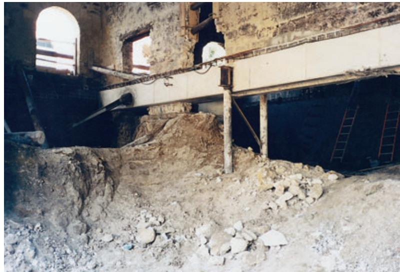
Photo 3 Vue sur poutre moisante View of tie beam
