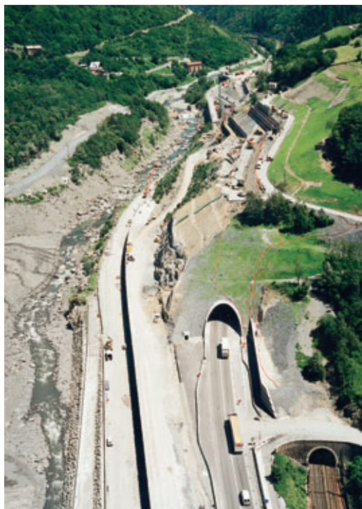
Photo 2 L'éperon des Sorderettes vu depuis l'aval avec, de gauche à droite : la rivière l'Arc, la RN6 utilisée en accès chantier, la voie descendante A43 en construction, la voie montante A43 en tunnel utilisée par la RN6 dans ce basculement de circulation, les voies ferrées traversant l'éperon en tunnel
