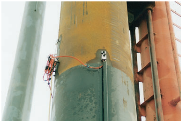
Photo 4 Pieu instrumenté Instrumenting pile
