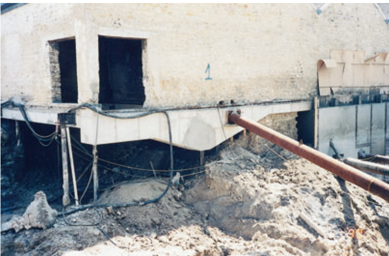
Photo 4 Vue sur poutre moisante à inertie variable View of variable-inertia tie beam
