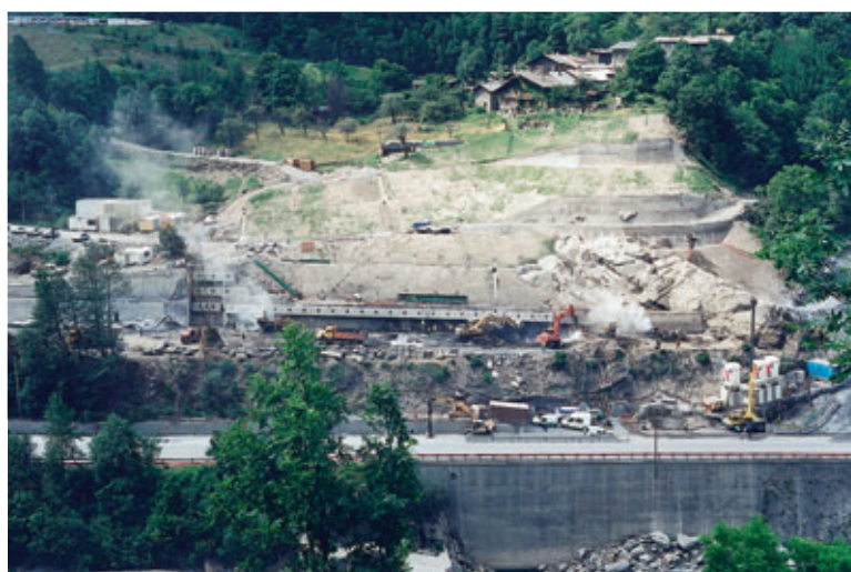
Photo 5 La zone amont avant la construction des parois tirantées The downstream zone before the construction of the tied walls
