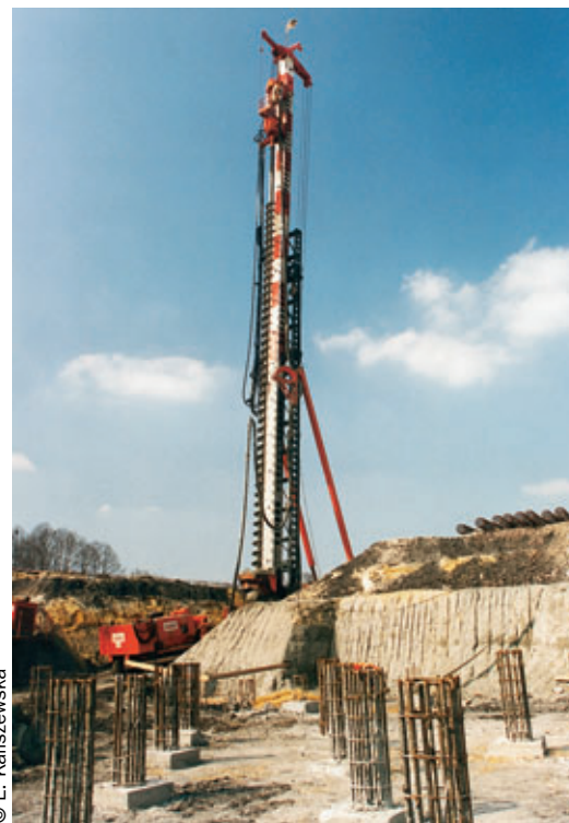
Photo 2 Foration de pieux pour l'usine Opel de Gliwice (Silésie, Pologne) Pile boring for Opel plant in Gliwice (Silesia, Poland)
