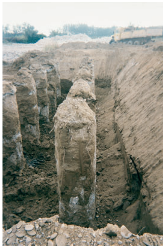
Photo 5 Dégagement de la tête de pieux sur le chantier TGV Méditerranée lot 4C Pile head clearing on TGV Mediterranean project, Lot 4C
