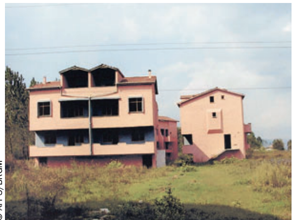
Photo 5 Gölcük - Turquie (1999) : Pas de dommage sur ces constructions de deux niveaux No damages on these two storey dwellings
