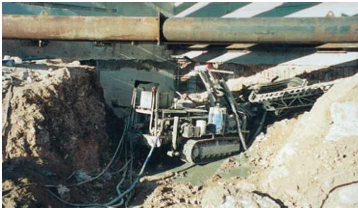
La foreuse dans une des multiples positions délicates The drilling machine in one of the many delicate positions
