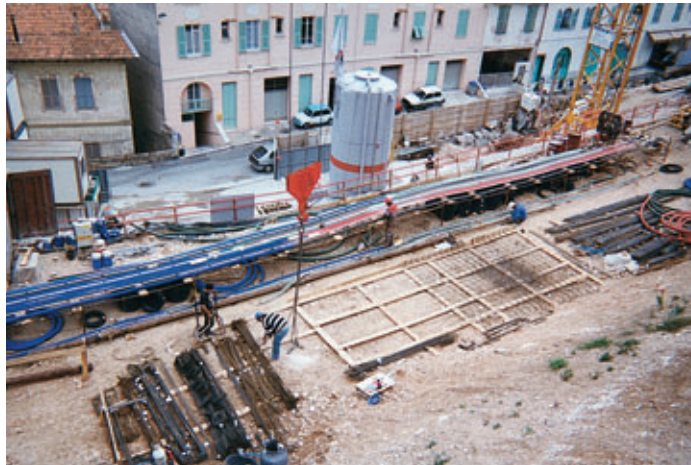
Photo 3 Le banc de préfabrication des tirants The tie prefabrication bench
