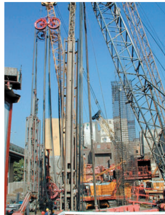
Photo 3 Station de Port-Saïd, paroi moulée en cours d'exécution Port-Saïd station, diaphragm wall during construction
