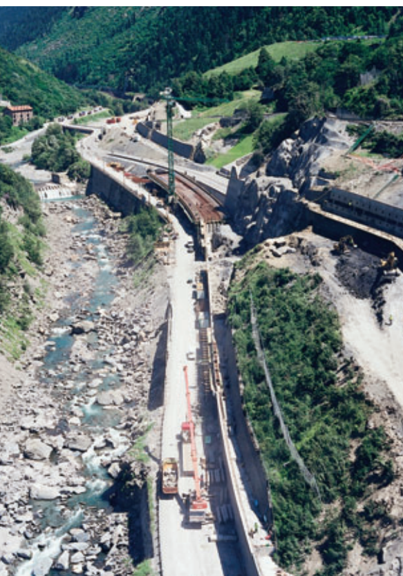
Photo 9 La construction des murs de soutènements en béton armé en contrebas de l'éperon. On remarque les protections par filets anti-sous-marins et le viaduc des Sorderettes
