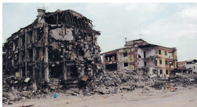
Photo 3 Adapazarı - Turquie (1999). Effets de site possibles sur alluvions lâches Likely site effects on unconsolidated alluvial deposits
