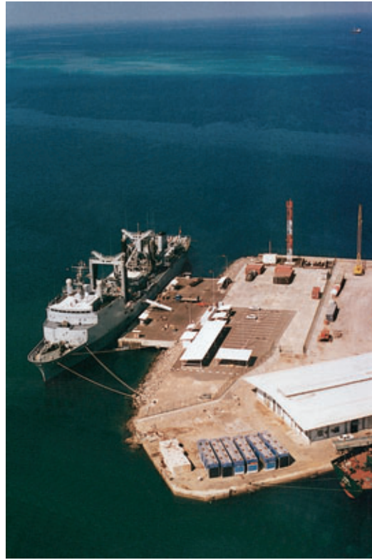
Photo 3 Vue du nouveau poste 9 New berth 9 view
