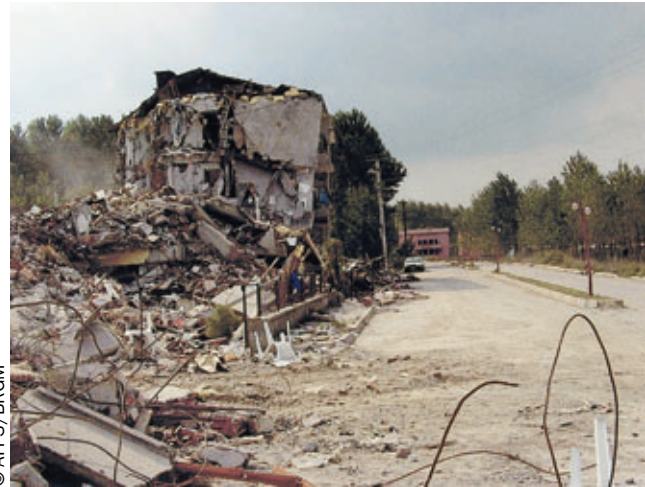
Photo 4 Gölcük - Turquie (1999). Effets de site possibles sur sols mous près de la mer Site effects on soft soils near the sea
