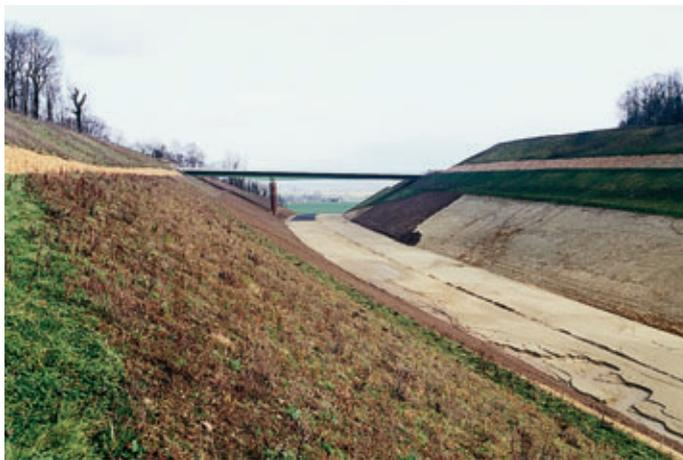
Le chantier de la RN 32, déviation de Compiègne, Thourotte et Ribecourt, concerne la réalisation d'une 2 x 2 voies sur une longueur de 14 km dans des terrains principalement crayeux, limoneux et sableux.
