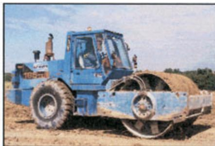
Compactage de chaque couche à l'aide d'un **compacteur vibrant Lebreiro V 5** permettant d'assurer un module de déformation **EV2 > 400 Bars**. Contrôle de chaque couche par essais de plaque
