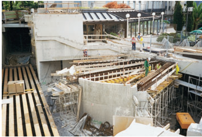
Ouvrage du Triangle. Construction du plancher au niveau 32 NGF. Les poutres du tablier en poutrelles enrobées sont mises en place. Le voile arrière du bâtiment commercial est reconstruit
