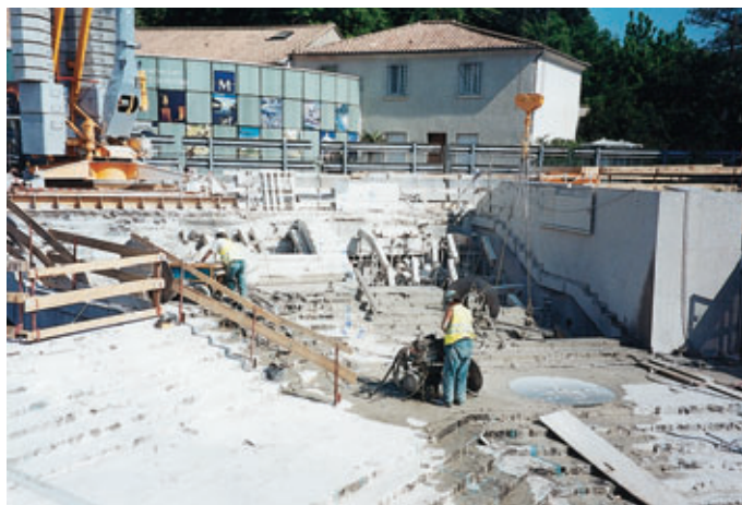
Ouvrage du Triangle. Démolition par sciage de l'escalier monumental existant Triangle structure. Demolition by sawing of existing monumental stairway
