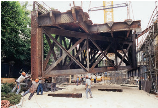
Photo 6 Réalisation des dés d'appui sur les sommiers existants Preparation of bearing blocks on existing imposts
