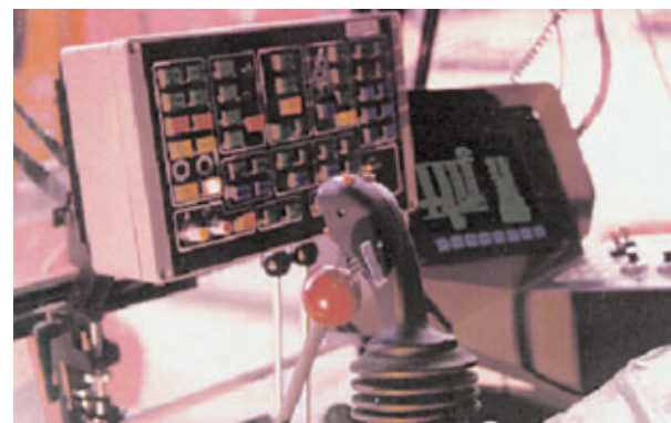
Figure 6 Tableau de commande de l'hydrofraise avec contrôle de verticalité Hydrofraise steering switchboard and verticality control panel
