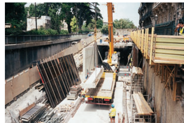
Avenue Fr. Mistral. Construction du cadre fermé Avenue Fr. Mistral. Construction of closed frame
