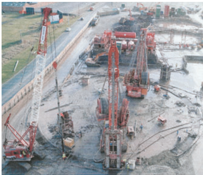
Photo 1 Les deux hydrofraises en cours d'excavation sur un réservoir The two hydrofraises at work on the same tank
