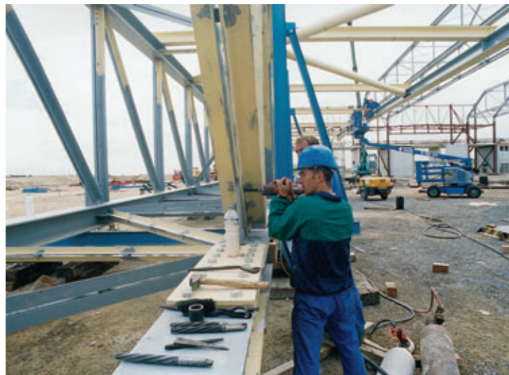
Assemblage de la troisième poutre Assembly of third girder
