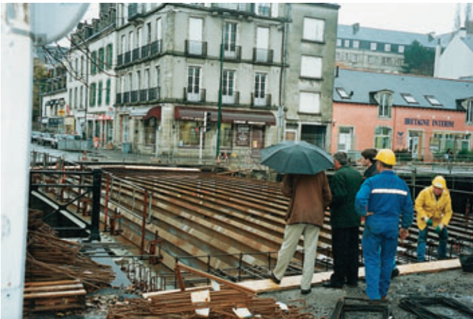
Vue des poutrelles View of beams
