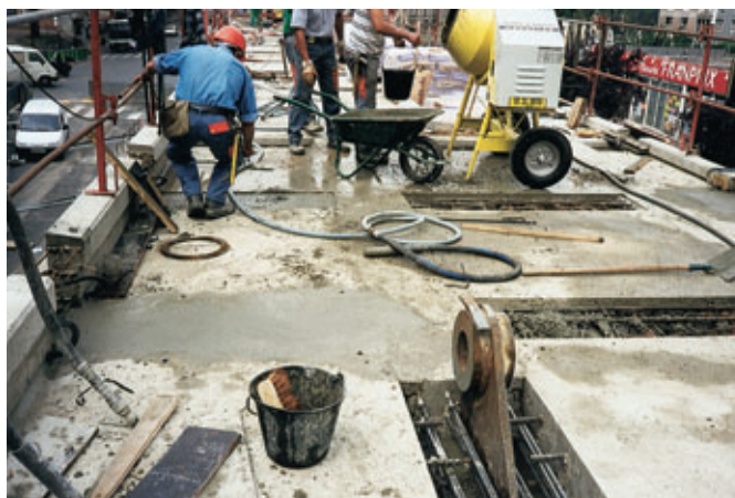
Photo 4 Clavage des hourdis au béton sans retrait Non-shrink concrete deck element keying
