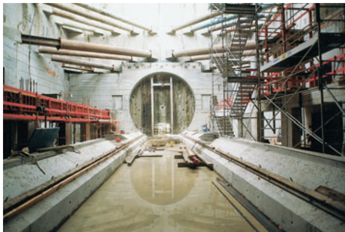
Station République. Vue sur le tympan côté arrivée du tunnelier République station. View of the tympan on TBM emergence side
