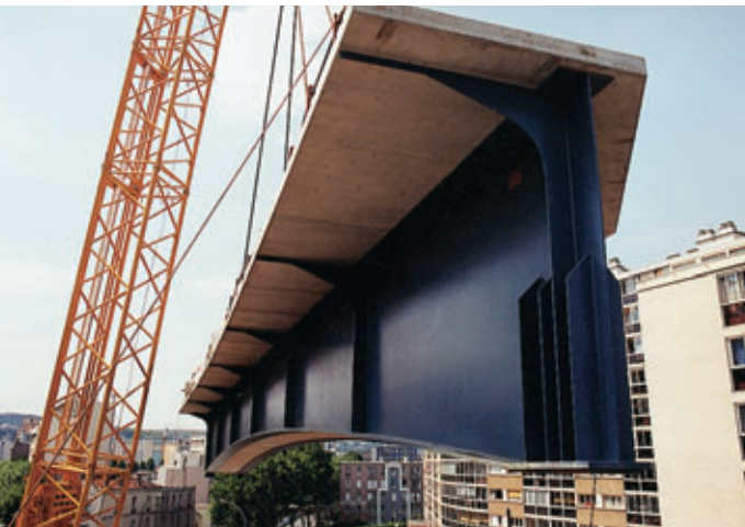
Photo 8 Manutention des tabliers
