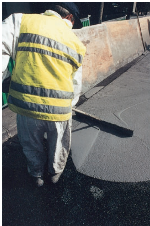
Photo 2 Étalement du coulis sur les bétons bitumineux ouverts supports
