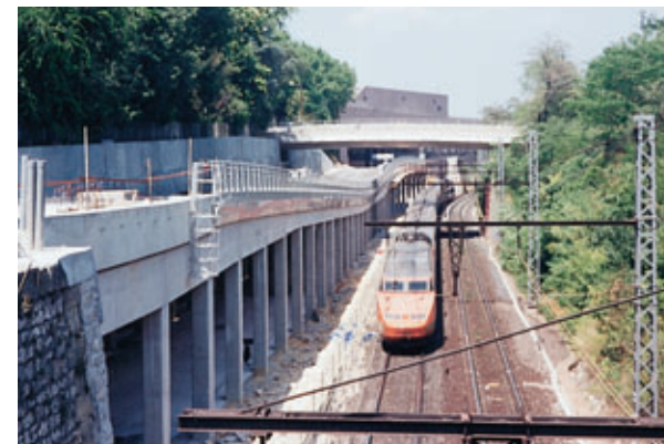
Avenue de la Citadelle. Ouvrages des tronçons 4 et 5 et passerelle du lycée en cours de finition
