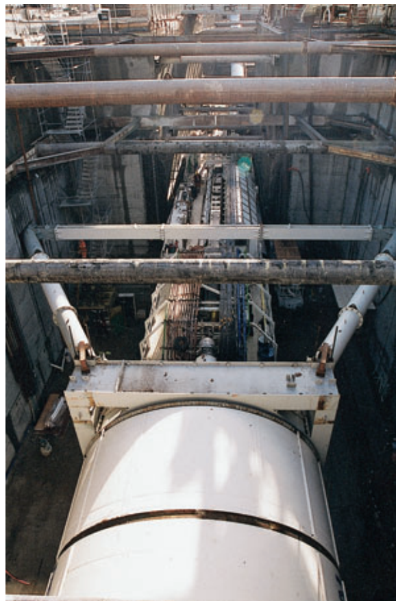
Tunnelier en phase de démarrage dans la station Clémenceau
