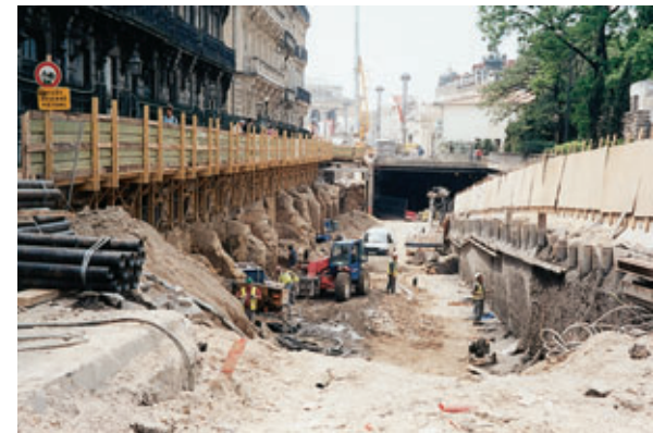
Avenue Fr. Mistral. Réalisation de la paroi de blindage provisoire et des terrassements généraux Avenue Fr. Mistral. Provision of a temporary cladding wall and general earthworks
