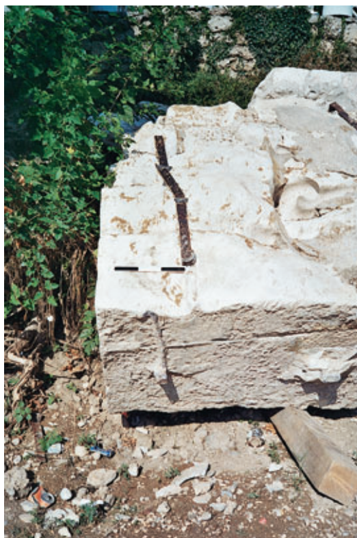
Photo 2 Groupe de voussoirs encore assemblés sur le dessus par des agrafes en métal forgé scellées au plomb; au premier plan apparaît un joint en coupe avec deux tenons également scellés au plomb dont on aperçoit le canal de coulée vertical; la ligne horizontale correspond à un forage d'injection pour le coulis de ciment employé en 1970 au cours des dernières consolidations du pont avant sa destruction
