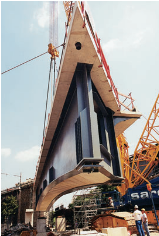
Photo 7 Manutention des tabliers
