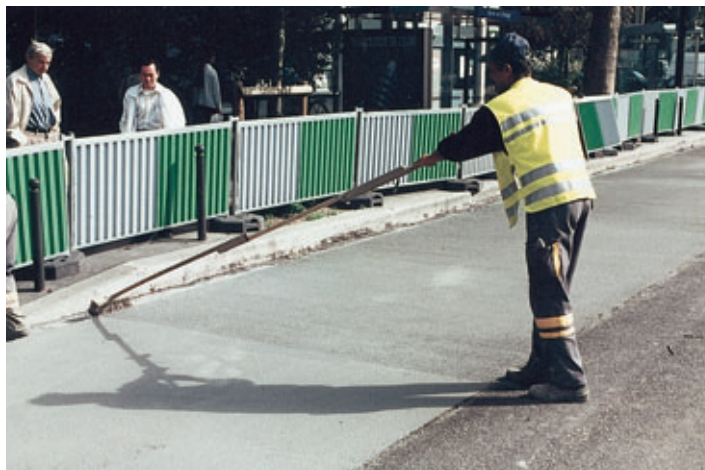
Photo 4 Réalisation du balayage après percolation du coulis
