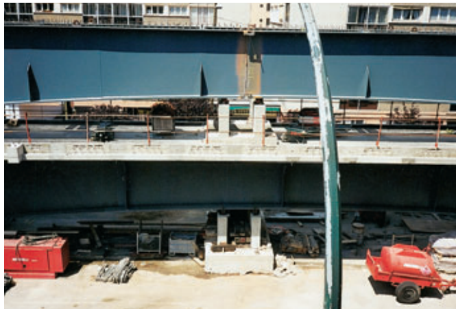
Photo 1 Superposition des deux tabliers sur appuis provisoires Superimposition of two decks on temporary supports
