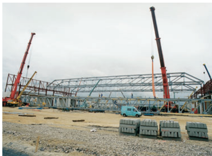
Préparation au montage de la troisième poutre Preparation for erection of third girder
