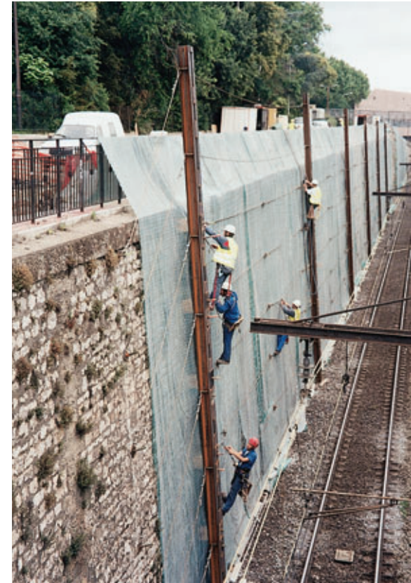
Avenue de la Citadelle. Mise en place du dispositif antichute de pierres sur les voies SNCF
