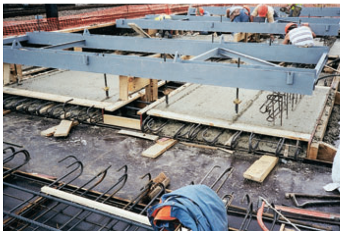
Photo 3 Préfabrication des éléments de hourdis avec leur palonnier de manutention Pre-casting of deck elements with their handling beam
