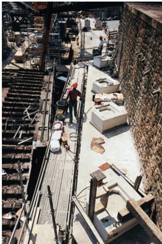
Photo 6 Réalisation des dés d'appui sur les sommiers existants Preparation of bearing blocks on existing imposts
