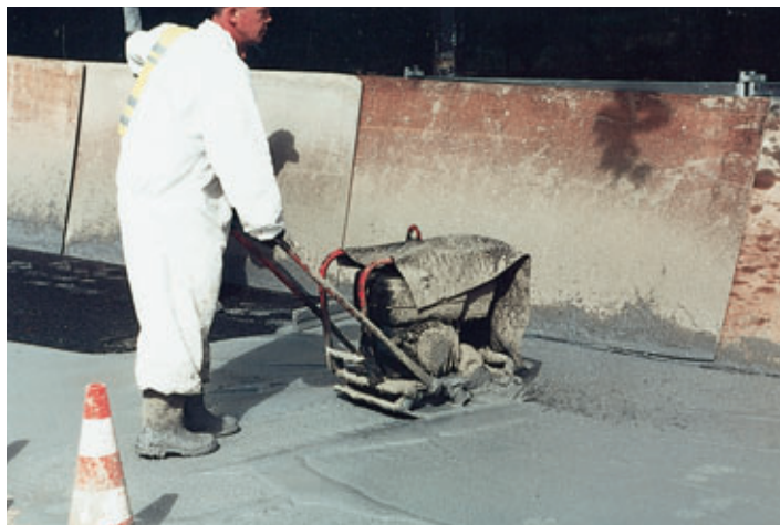
Photo 3 Percolation forcée du coulis ciment-résine à l'aide d'une plaque vibrante
