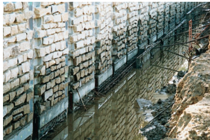
Mise en forme d'une longrine BA en pied de paroi berlinoise
