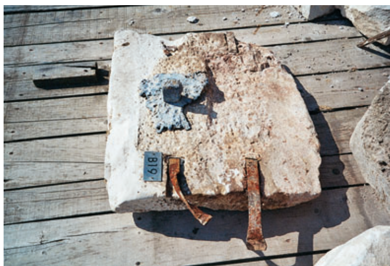
Photo 3 Élément type d'archivolte dans l'état où il a été repêché dans la Neretva; sur son lit d'attente, il reste encore les agrafes forgées en queue d'aronde et un tenon pris dans sa gaine de plomb
