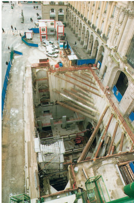
Station République, vue générale République station, general view
