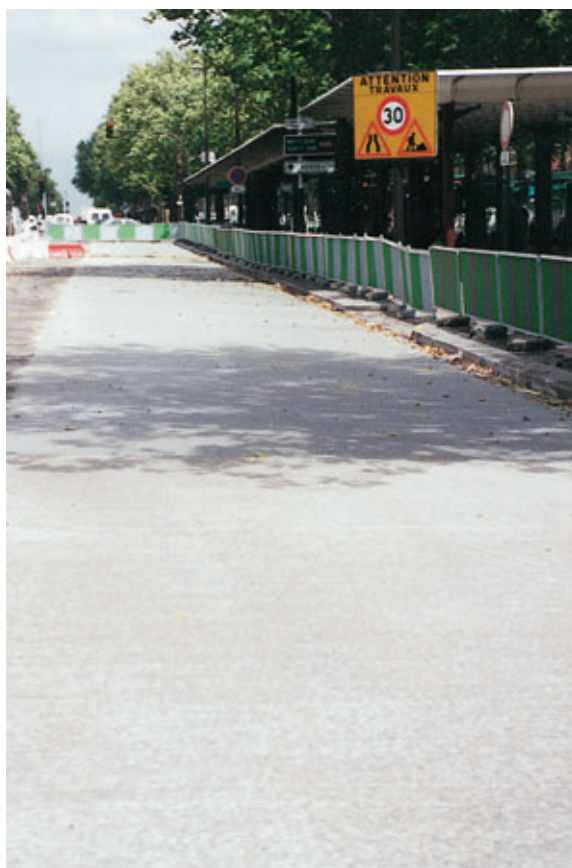
Photo 5 Aspect clair du Rodal après la prise du coulis de ciment-résine
