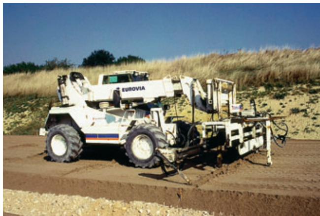
Photo 5 Matériel de préfissuration Olivia Olivia precracking equipment
