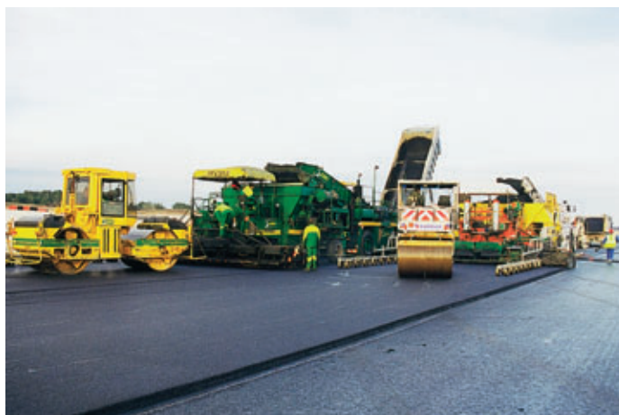
Photo 4 Mise en œuvre de BB aéronautique sur la piste
