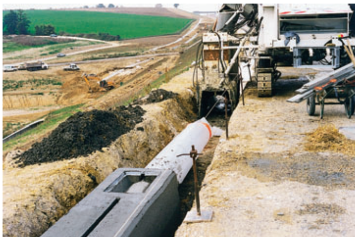
Photo 4 Machine à coffrage glissant pour béton extrudé, utilisée pour la réalisation d'un caniveau à fente
