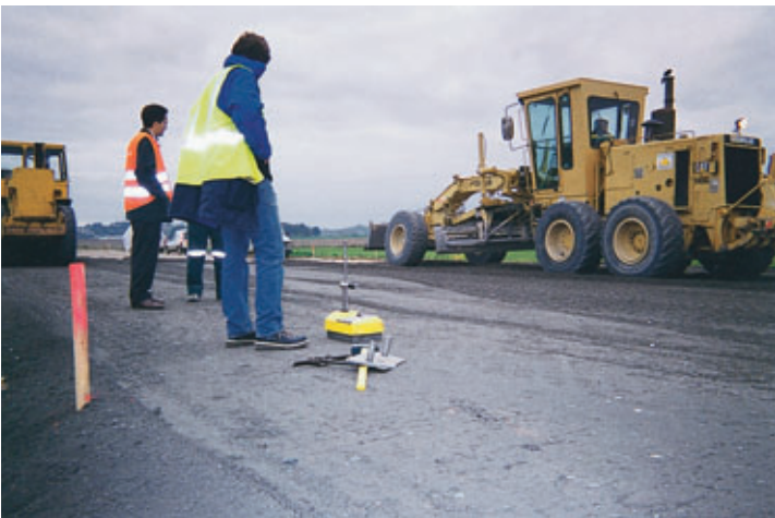
Photo 5 Vingt points de contrôle quotidiens au gammadensimètre 20 daily test points with gammadensimeter
