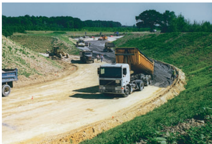
Photo 1 RN12 (Yvelines) : 2 000 t de Scorcim® C en couche de forme
