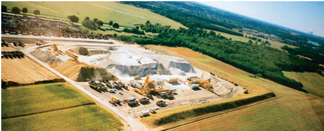
Photo 2 Vue d'ensemble des centrales d'enrobage sur l'aire de Châtillon-sur-Loire
