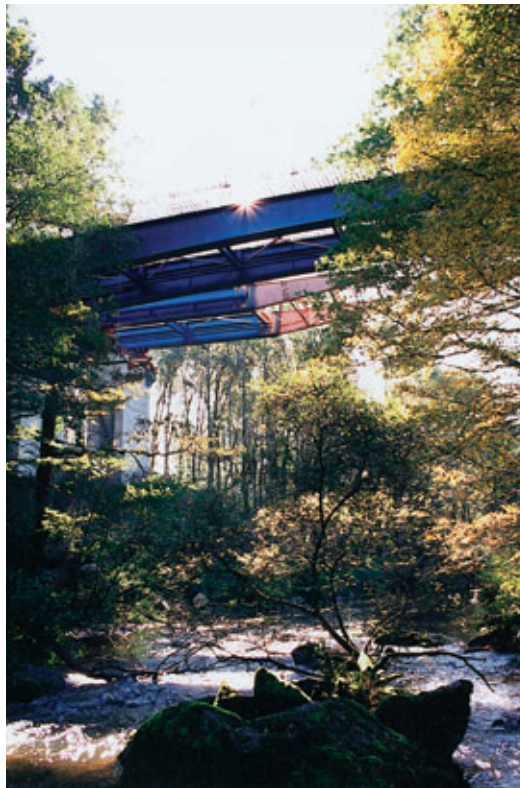
Photo 2 Pont sur la Glane : des travaux en harmonie avec l'environnement Bridge over the Glane : works in harmony with the environment
