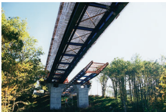
Photo 1 Pont sur la Glane : lançage du deuxième tablier
