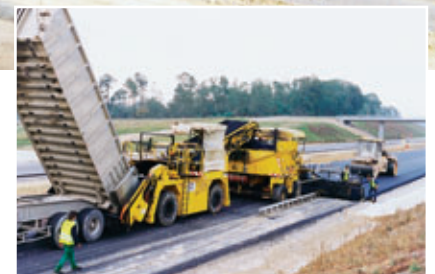
Photo 3 Vue d'ensemble de l'atelier de mise en œuvre (finisseur Vogele S 2500 et alimentateur Franex)
