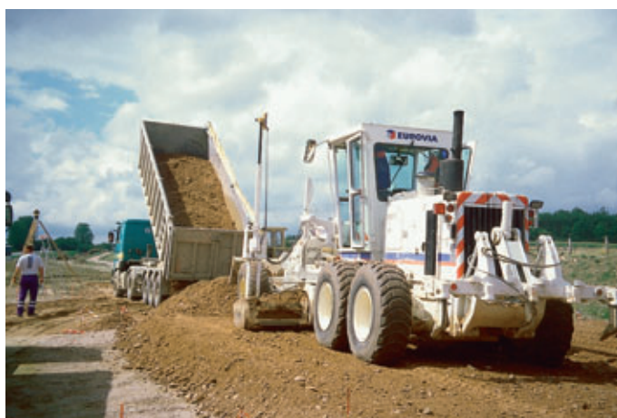
Photo 2 Régilage du tout venant 0/60 Levelling of run-of-quarry 0/6 material
