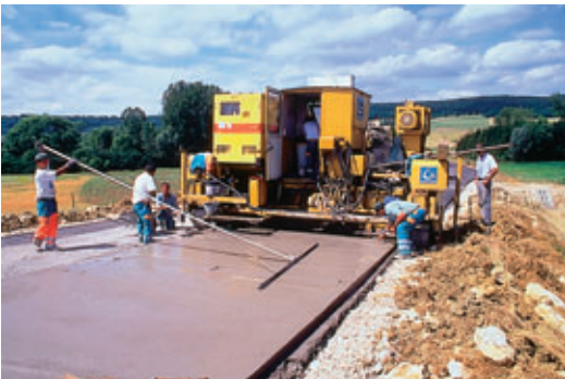
Photo 7 Contournement de la commune de Maizières. Coulage du béton à l'aide d'une machine à coffrage glissant Maizières bypass. Pouring of concrete using a slipform machine
