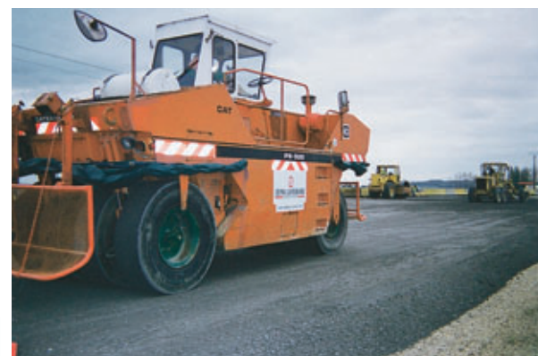
Photo 4 Niveleuse, cylindre vibrant V4 et compacteur P3 : le Scorcim® est mis en œuvre avec du matériel traditionnel Grader, vibrating cylinder V4 and compactor P3 : Scorcim® is applied with conventional equipment
