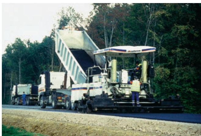
Photo 6 Atelier de mise en œuvre des enrobés Asphalt application plant
