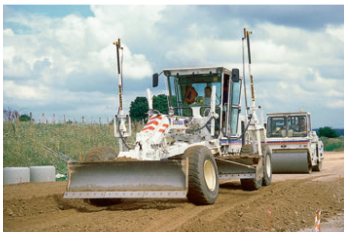
Photo 3 Niveleuse guidée par laser Laser-guided grader
