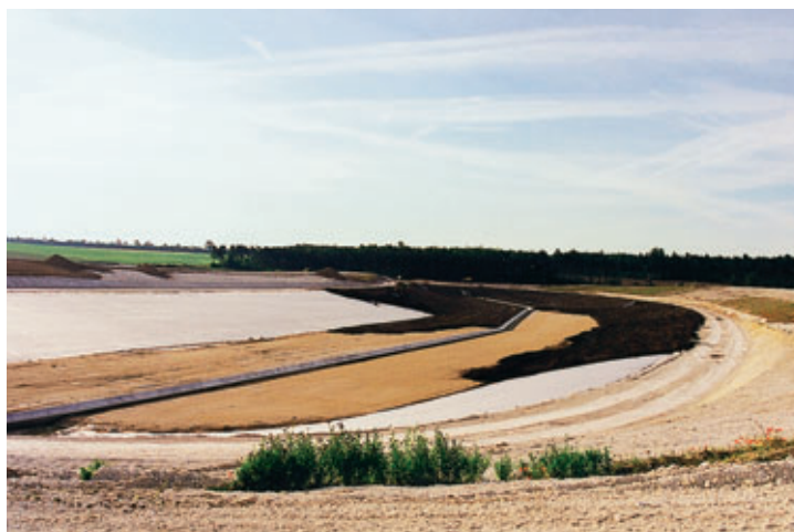
Photo 2 Bassin de rétention Retention basin
