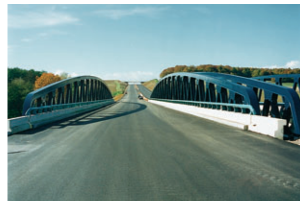
Photo 1 Ouvrage de franchissement de l'Avière Structure over the Avière
