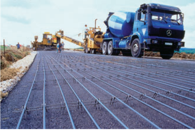
Photo 6 Contournement de la commune de Maizières (Meurthe-et Moselle). Devant l'atelier de bétonnage, les armatures longitudinales du BAC sont positionnées à la hauteur voulue au-dessus de la couche de grave bitume Maizières bypass (Meurthe-et-Moselle region). Before the concreting plant, the longitudinal CRC reinforcing steel is positioned at the desired height over the asphalt-treated base layer
