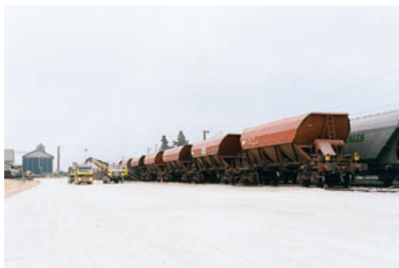
Photo 1 Embranchement ferroviaire et quai de déchargement Railway connection and unloading platform
