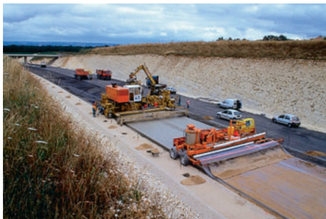
Photo 4 Déviation des Rassats-Favrauds, RN 141 (nord-est d'Angoulême). Vue générale du chantier de mise en œuvre de la technique du béton armé continu (BAC) sur grave bitume
