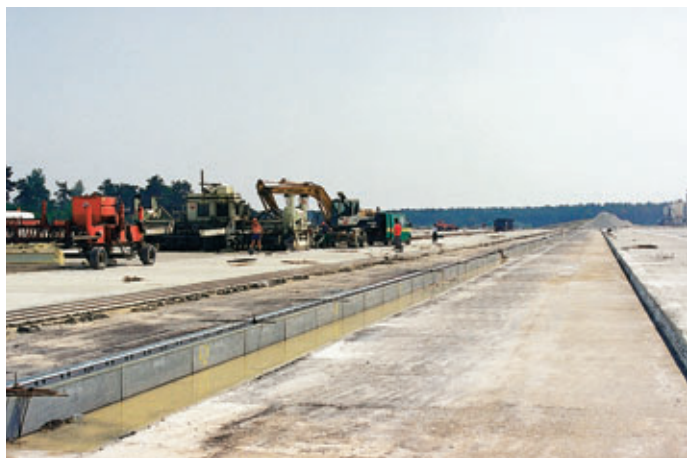
Photo 5 Mise en œuvre du béton de roulement sur l'aire de stationnement gros porteurs
