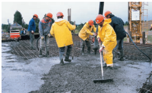
Coulage du tablier sur la RN160 à Chemillé
