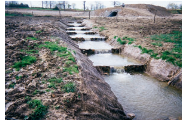
Photo 3 Echelle à poissons : dispositif permettant la remontée du cours d'eau par les poissons lorsque son profil en long est trop pentu
