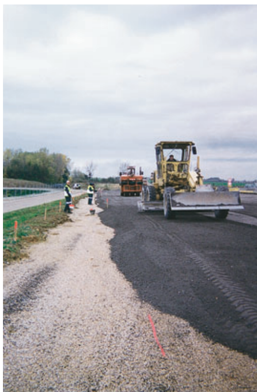
Photo 2 RN2 (Seine-et-Marne) : le Scorcim® C remplace du sable ciment en couche de fondation
