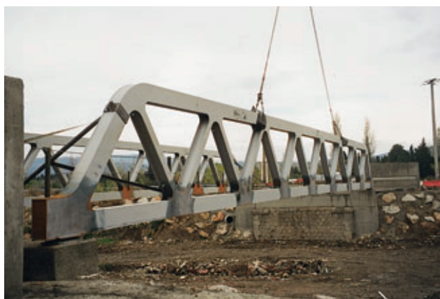
Pose à la grue Crane erection
