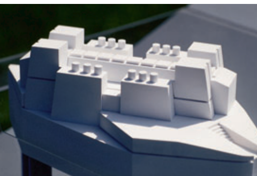
Photo 8 Vue des appuis dans le fleuve sans tablier. On distingue le sommier d'appui (13,00 x 1,50 m) et les volumineuses butées parasismiques disposées dans les quatre angles (maquette DDE Bas-Rhin - J. Parreaux)
