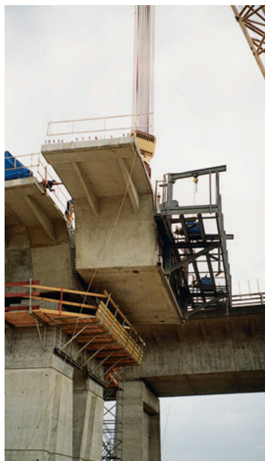
Assemblage d'un voussoir Segment assembly
