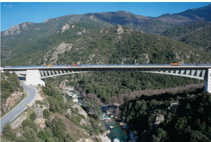
Vue de l'ouvrage terminé View of completed structure
