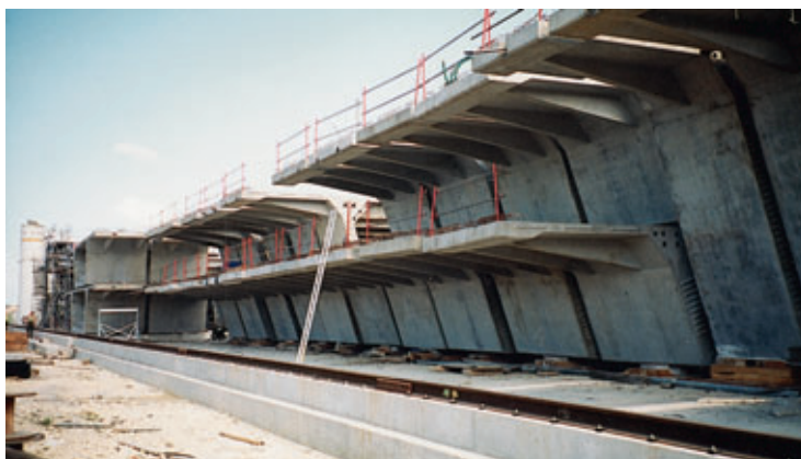
Usine de préfabrication - Stockage des voussoirs Segment pre-casting and storage
