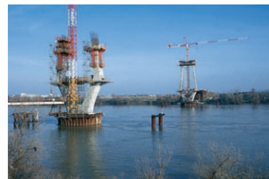
Photo 3 Coffrage pylône - Exécution des bras - Vue générale
