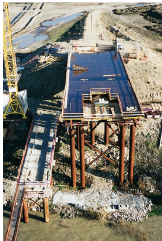
Photo 6 Etalement de rive Bank shoring
