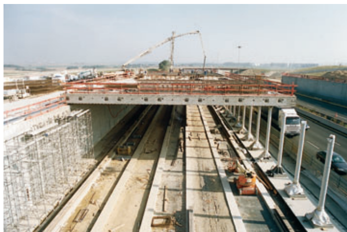
Dalle phase A en cours de bétonnage
