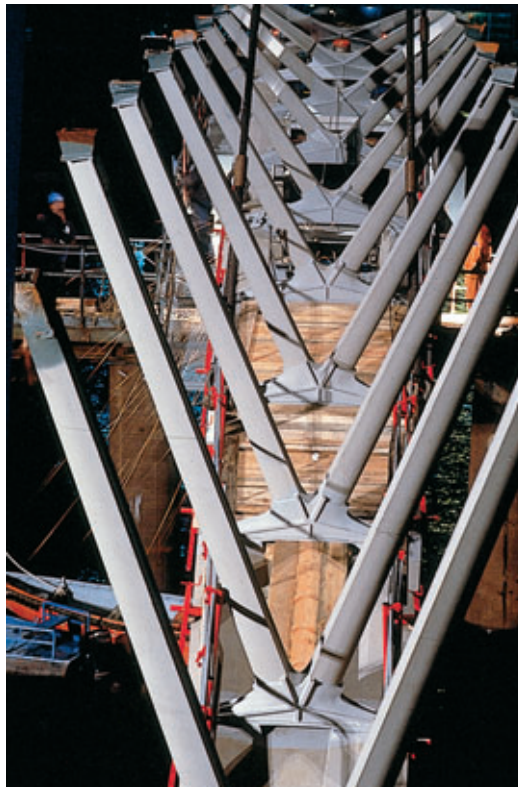
Eventail des bracons sur étriers Range of braces on stirrups
