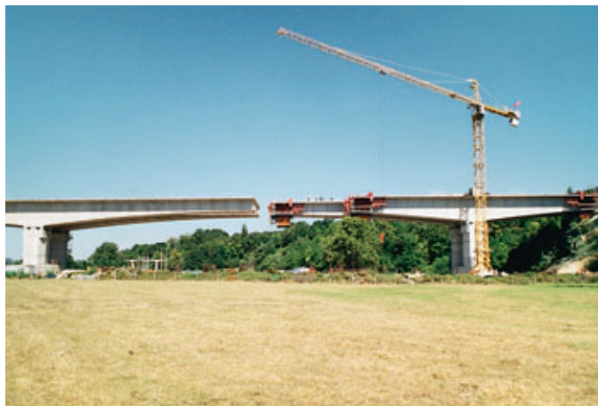
Photo 4 Vue des tabliers en cours de construction View of decks under construction
