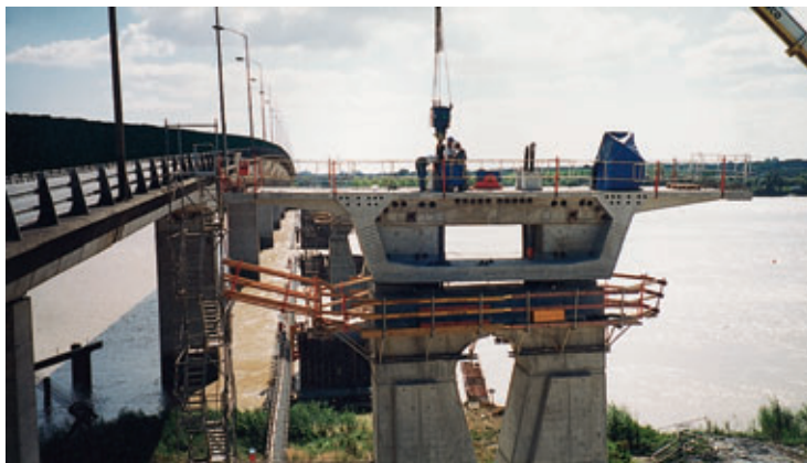
Assemblage d'un VSP sur la barge
