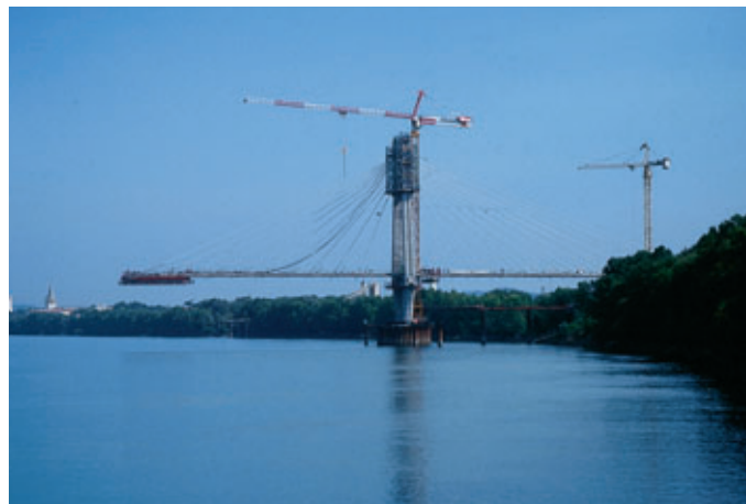
Photo 9 Surencorbellement - Réalisation du voussoir n° 9 Overhang - Completion of segments No. 9
