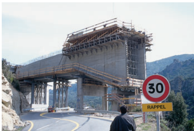
Photo 9 Travée sur cintre P2 - C3 Span on centre P2 - C3
