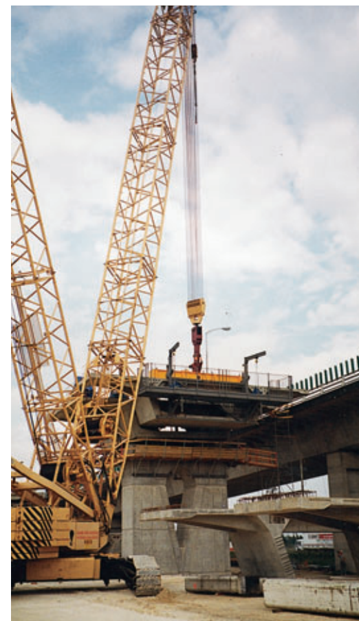
Pose d'un voussoir - Fléau à terre
