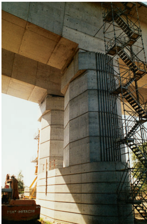
Photo 2 Vue d'une pile View of a pier
