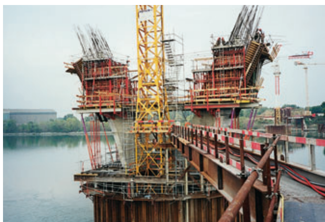
Photo 1 Coffrage pylône levée n° 3 Tower formwork, embankment No. 3
