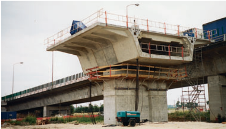
Haubanage d'un fléau à terre Cable staying of beam on land
