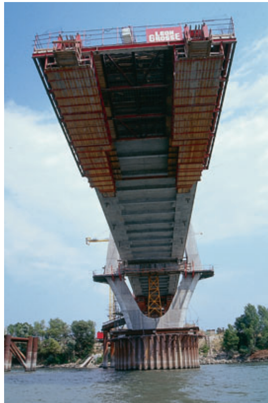
Photo 10 Surencobernement - Vue de dessous Overhang - Bottom view
