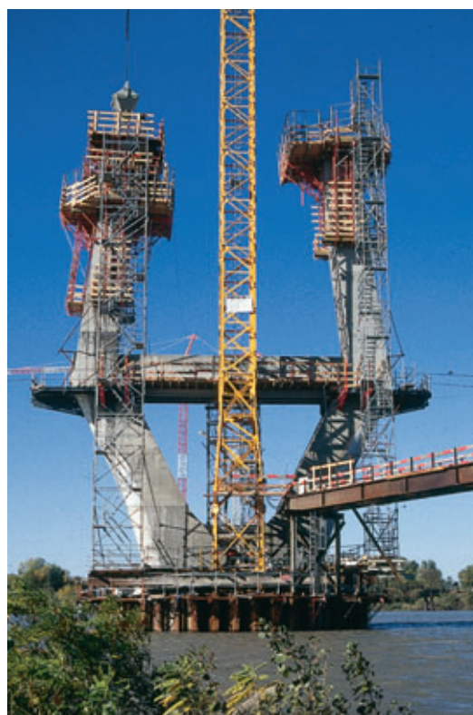
Photo 2 Coffrage pylône - Exécution des bras
