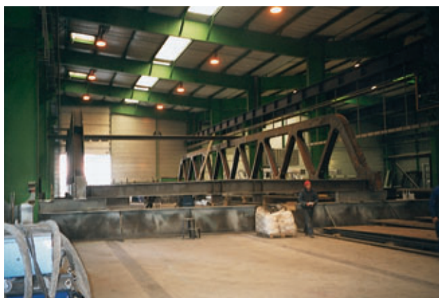
Montage à blanc en atelier Trial assembly in the plant
