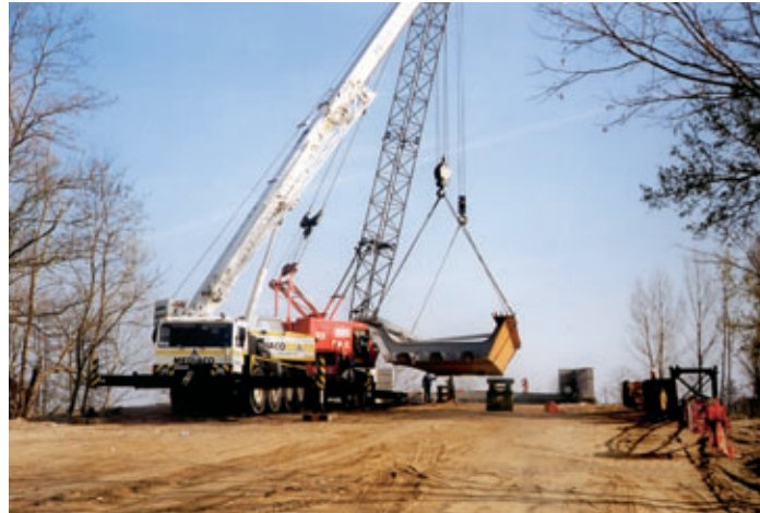
Levage des premiers tronçons de caisson Lifting the first box-girder sections
