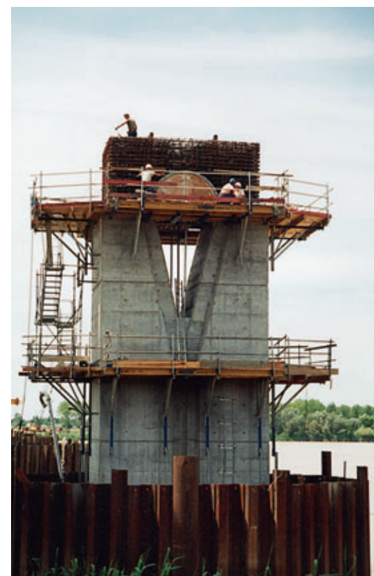
Pile en rivière
