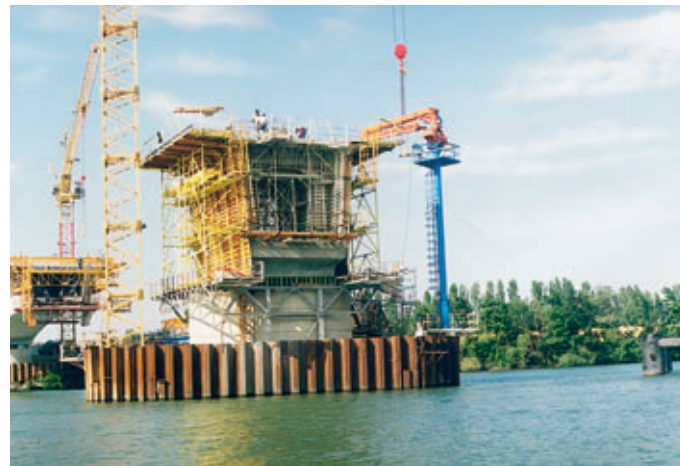
Voussoir sur pile Segment on pier
