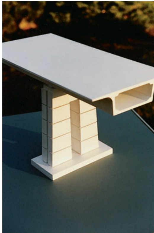
Photo 9 Vue d'un appui courant du viaduc d'accès côté France avec tablier (maquette DDE Bas-Rhin - J. Parreaux) View of an access viaduct bearing on French side with deck (model DDE Bas-Rhin - J. Parreaux)
