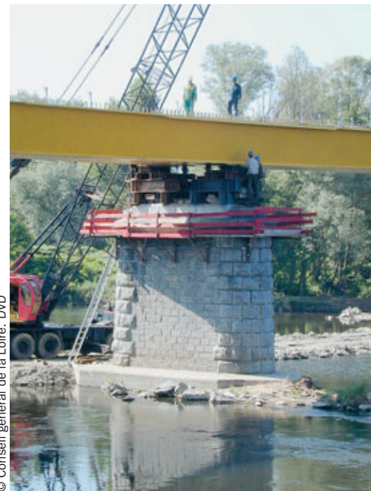
Chaises de lancement sur piles Pier launching brackets
