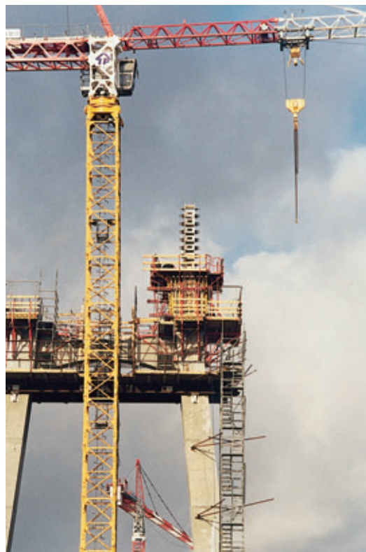
Photo 5 Tête d'ancrage des haubans Cable anchoring head
