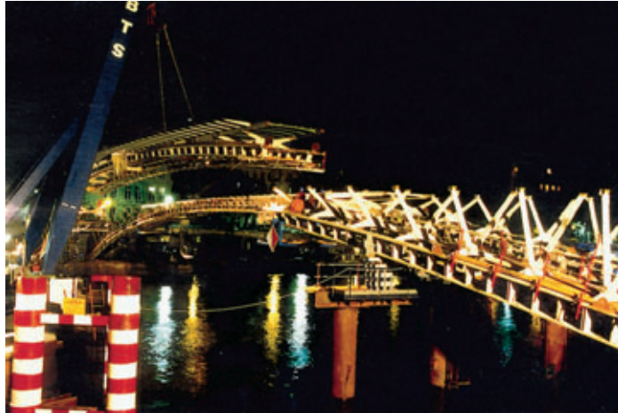
Levage du tronçon central côté amont Lifting the middle section on the upstream side
