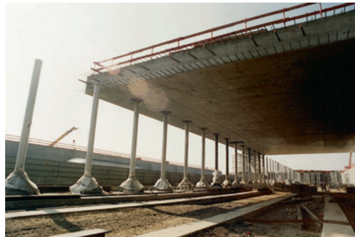
Dalle phase A après décoffrage Slab in phase A after removal of formwork
