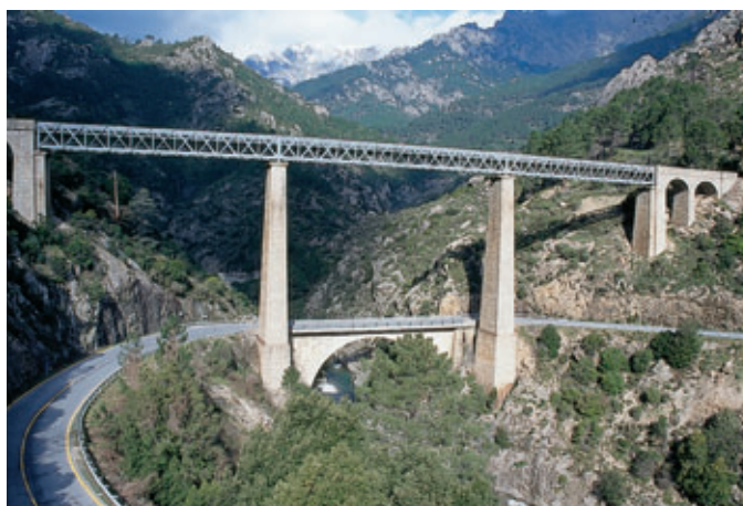
Photo 1 Vue de l'ouvrage existant View of existing structure
