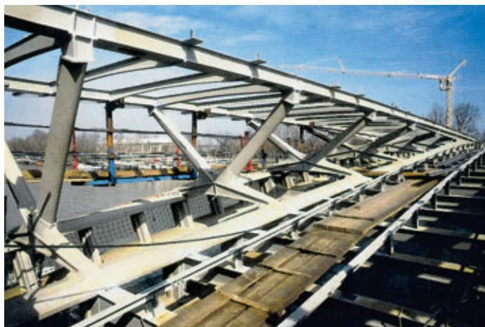
Travaux d'équipement du platelage supérieur Work on upper plating
