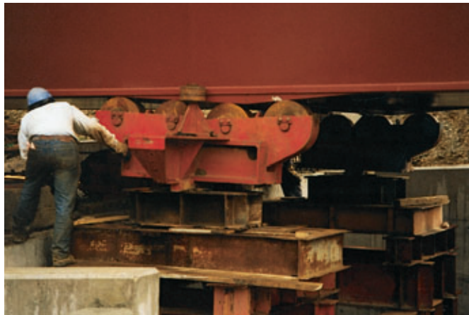
Détail des chaises de lancement sur culée C0
