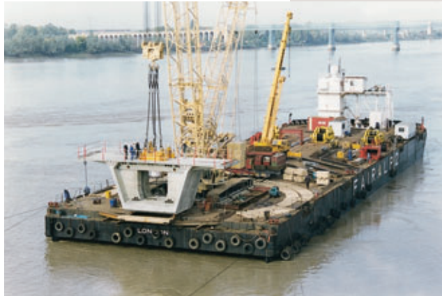
Grue Demag CC2800 sur barge Demag CC2800 crane on barge
