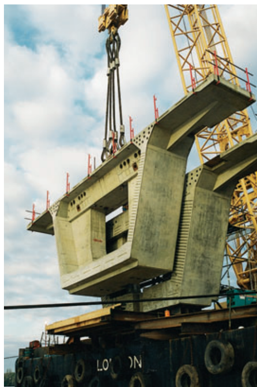
Assemblage d'un VSP sur la barge
