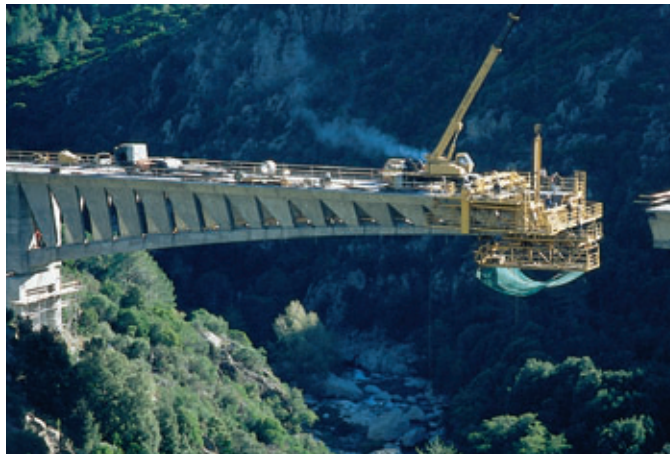
Photo 6 Fléau n° 2 avant clavage Arm No. 2 before keying
