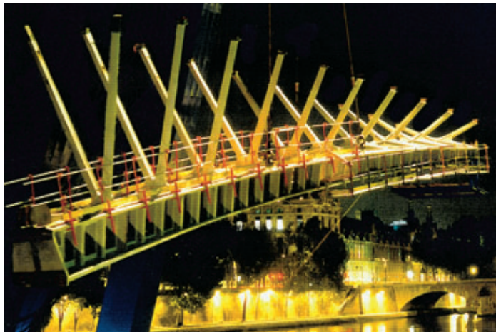
Levage d'un tronçon de rive Lifting a bank section
