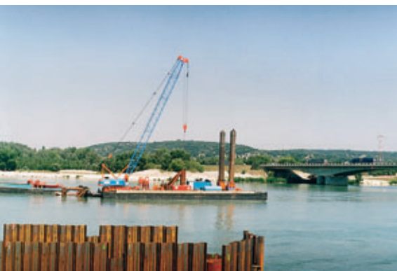
Batardeaux en rivière Cofferdams in river
