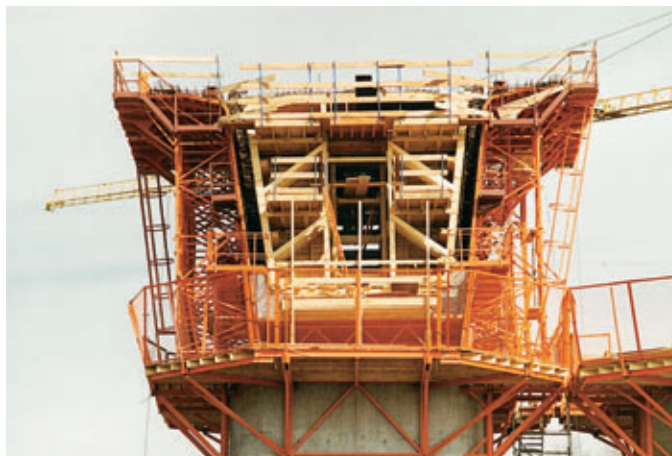
Photo 3 Vue d'un voussoir sur pile en fin de coffrage View of segment on pier at end of shuttering
