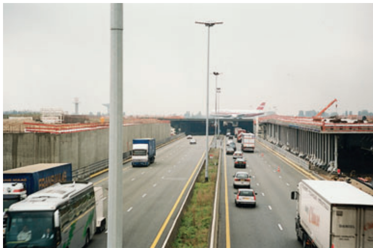
Vue générale du chantier General view of site
