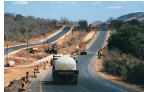
Construction d'une déviation de trafic pour permettre la reconstruction complète de la route existante
