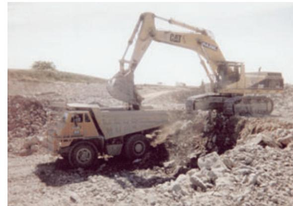
**Mesure in situ de caractérisation d'un échelon de terrassement. A noter les cycles de chargement alterné selon que le dumper est devant ou à droite de la pelle**
