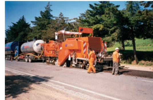
**Traitement en place à l'émulsion d'un corps de chaussée**
