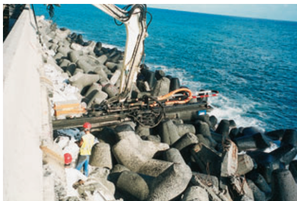
Photo 2 Mise en œuvre de l'armature au marteau Klemm
