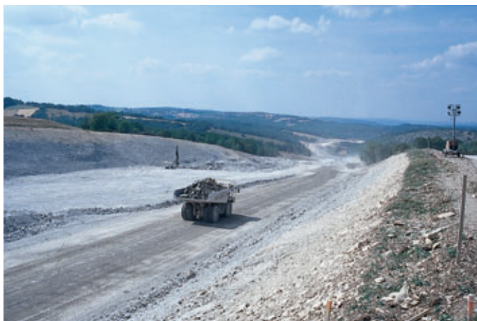
Photo 1 Le déblai de Villeneuve The Villeneuve cutting
