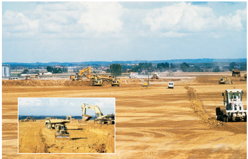
Terrassements en zone B et échelons de pelle-dumpers
