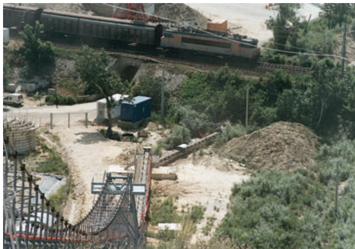
Le passage sous la voie ferrée Crossing under the railway
