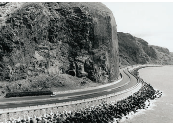
Vue générale du mur réparé General view of repaired wall
