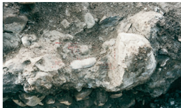
Photo 4 Les clous mis à nu The bared nails
