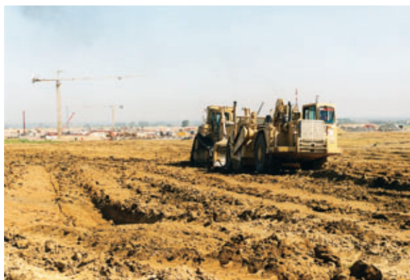
Terrassements aux motoscrapers en zone E. En arrière plan, travaux de fondation de la zone usine
