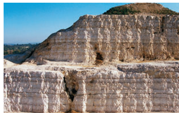
Talus de 20 m prédécoupé avec risbermes et présence de cheminées karstiques Slope of 20 m pre-split with berms and presence of karstic shafts
