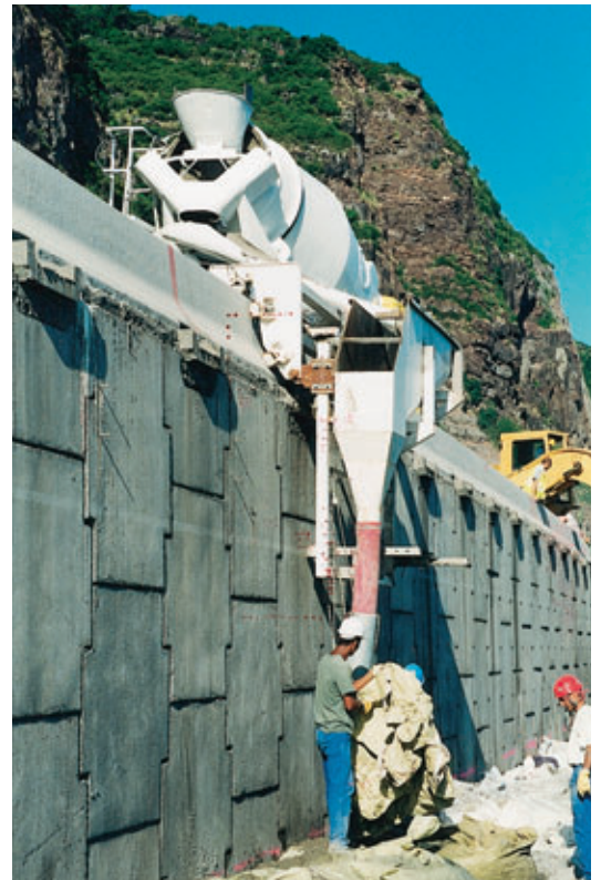
Photo 6 Mise en place des chaussettes Placing of stockings
