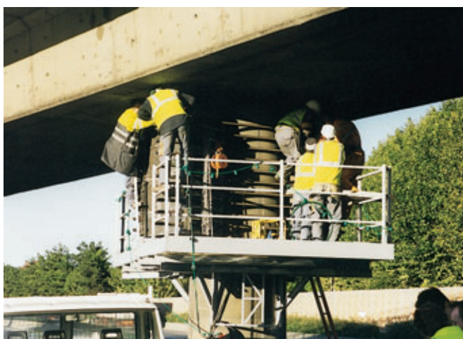
Mise en place des mâchoires du bossage de vérinage
