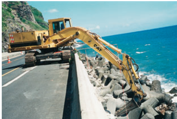
Photo 5 Démolition des tétrapodes Demolition of tetrapods
