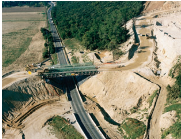
Photo 1 Pont provisoire au-dessus de la RD 541 entre le plateau des Echirouzes et la plaine de la Garde Adhémar Temporary bridge over highway RD 541 between the Echirouzes plateau and the Garde Adhémar plain
