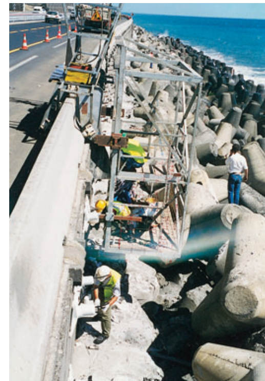
Photo 9 Mise en place des plaques de répartition
