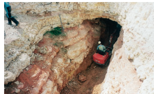
Nettoyage d'un karst sous l'arase avant remplissage et injection de béton Cleaning of karst under the levelling line before filling and grouting
