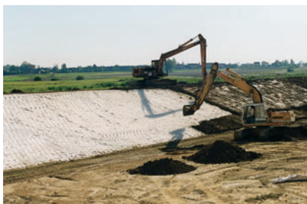
Végétalisation des talus du bassin. Géogrille sur un complexe d'étanchéité
