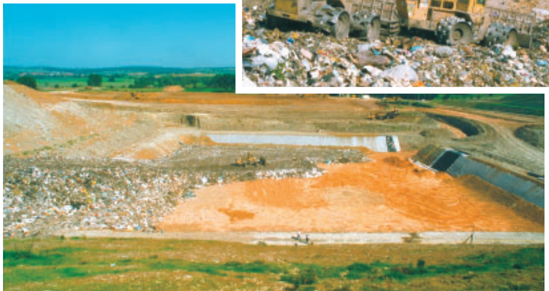
1 - Une alvéole creusée par des scrapers d'une entreprise de terrassement
