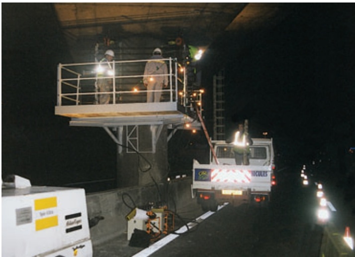
Vérinage de nuit de l'ouvrage Jacking of structure at night
