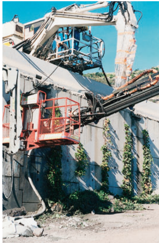
Photo 8 Forage et injection des clous
