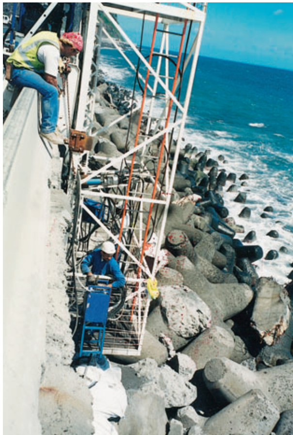
Photo 7 Carottage des écailles en béton Core drilling of concrete scales
