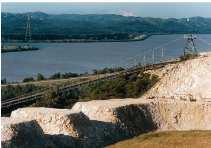
Falaise des Angles - Le transporteur suspendu Falaise des Angles cliff - The suspended conveyor
