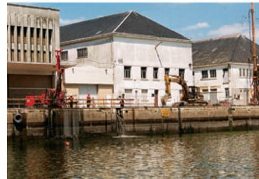
Les deux ateliers. A gauche : forage béton, à droite forage jet
