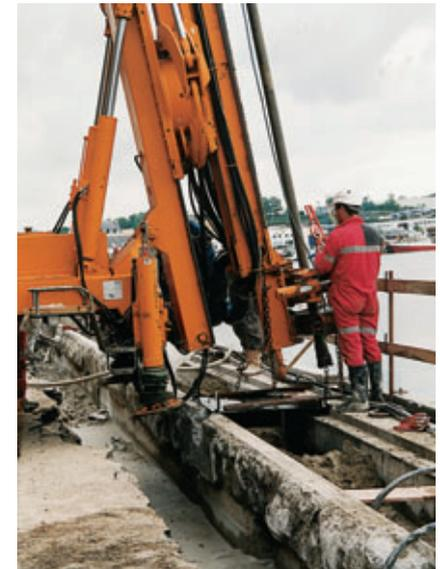
Foreuse jet. Réglage de l'inclinaison du forage
