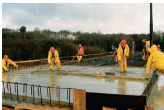
RN141, déviation de Taponnat. PS en B60. Bétonnage du tablier et lissage à règle vibrante (entreprise SNGC)
