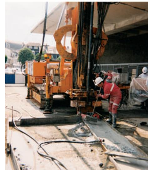
**Exécution de la colonne pour mesure indirecte du diamètre**
