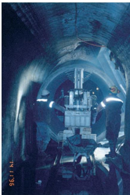
Mise en place des tuyaux de chemisage à âme en tôle
