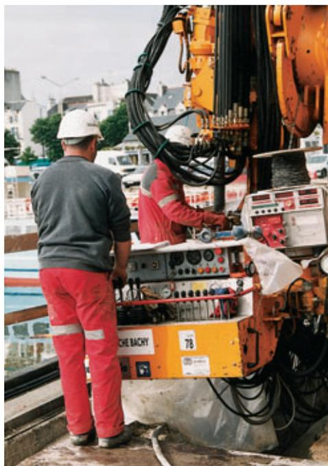
Tableau de pilotage des différents paramètres "jet"
