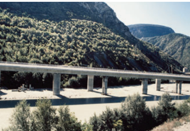
Vue depuis le Nord View from north
