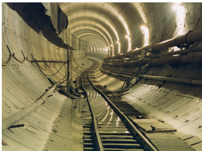
Photo 6 Le tunnel sous le bras principal du Nil
