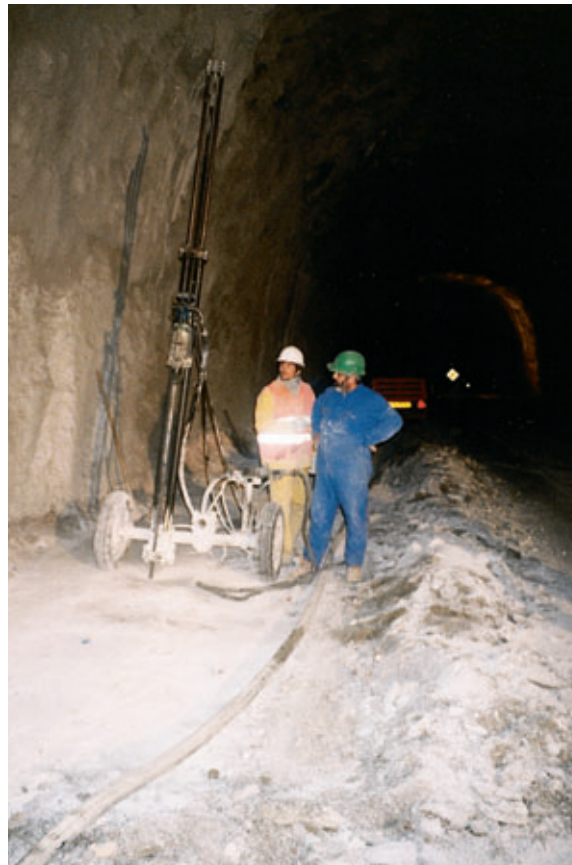
Le poste de forage caniveau
