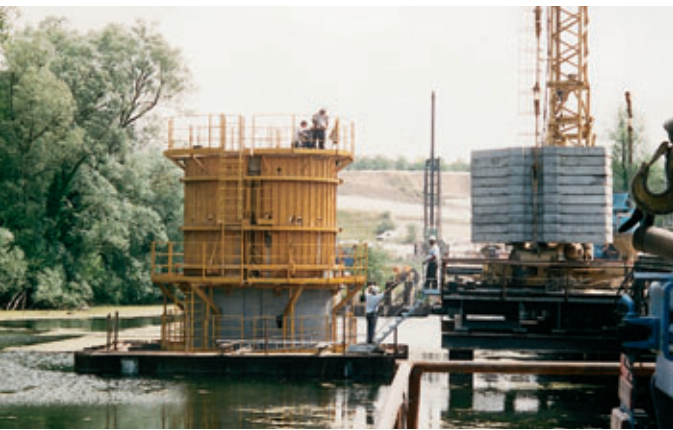
Photo 9 Estacade d'accès aux batardeaux dans l'étang pour assurer la non pollution des eaux, ainsi que la protection des berges et de leur environnement
