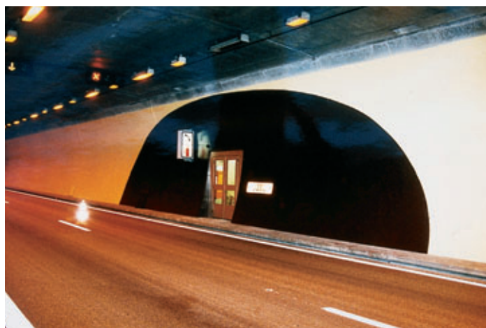
Photo 1 Motif autour d'une niche de sécurité dans le tunnel de Chamoise Motif around a safety niche in the Chamoise tunnel
