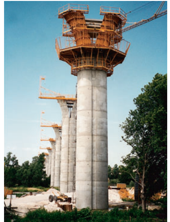
Photo 4 Coffrage outil spécifique des chevêtres en tête des piles
