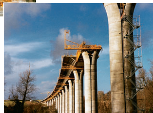
Photo 8 Le tablier en cours de poussage, au moment de l'accostage de l'avant-bec sur une pile
