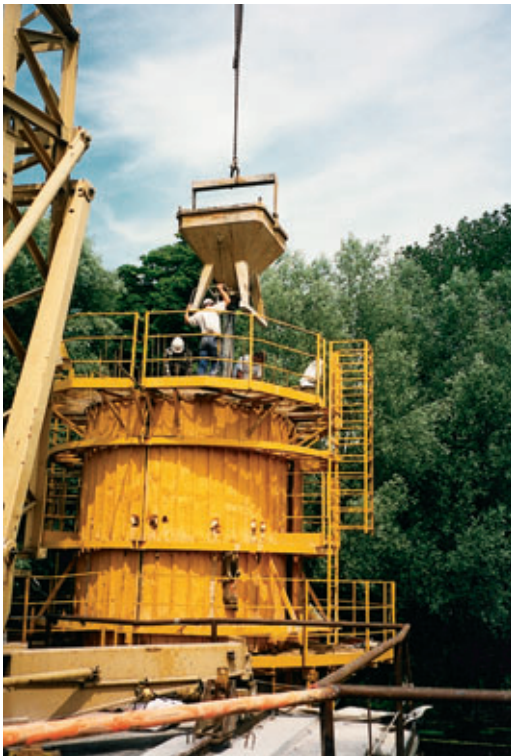
Photo 3 Coffrage des fûts de pile en partie courante par levées de 4,00 m
