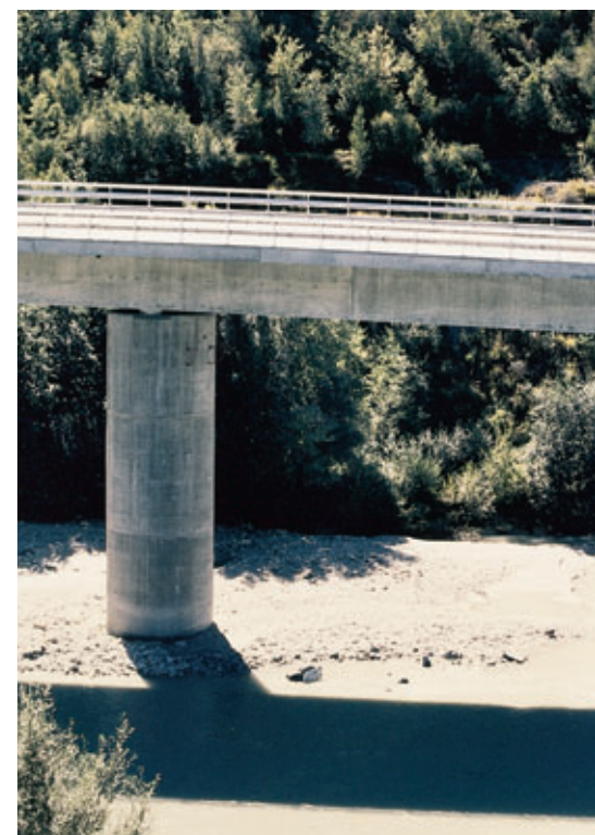
Détail pile cylindrique/tablier Detail of cylindrical pier/deck
