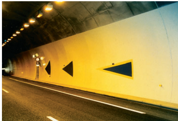
Photo 4 Expérimentations dans le tunnel de Monjézieu
