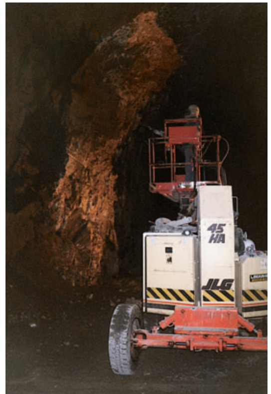
Le poste de béton projeté Pingon BRH in action
