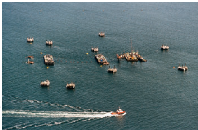
Immersion d'un élément. Vue des pontons d'immersion des îles d'ancrage et des bateaux d'assistance Immersion of an element. View of immersion pontoons of the anchoring islands and service boats
