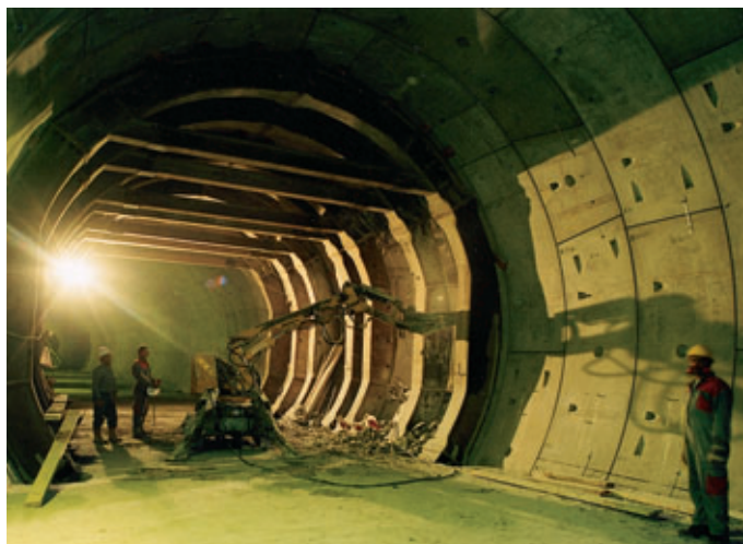
Photo 3 Lot 42A. Cintres temporaires en tunnel pendant l'exécution des rameaux
