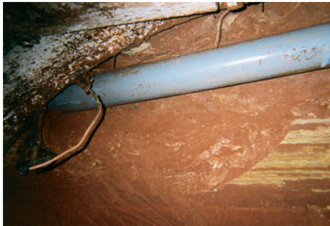
Branchement particulier eaux usées recoupé par le tunnelier
