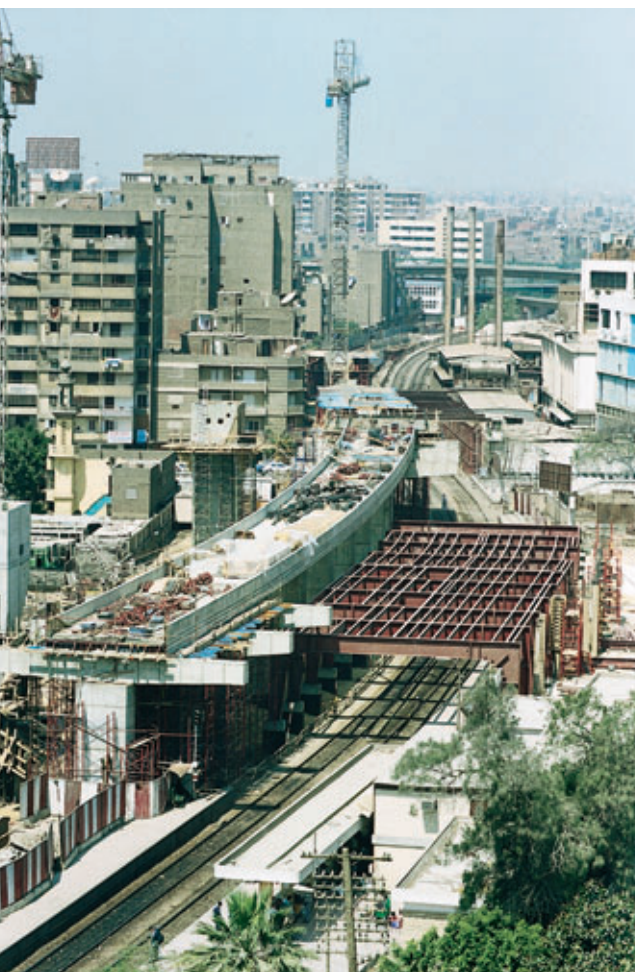
Photo 7 Phase 2B. Vue générale des travaux en cours Phase 2B. General view of works in progress
