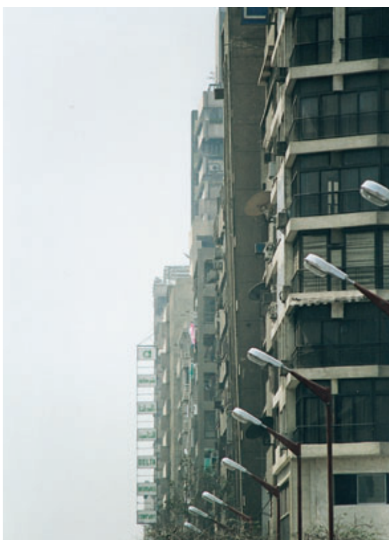
Photo 4 L'immeuble situé au 144 rue Tahrir accusait une forte inclinaison avant les travaux
