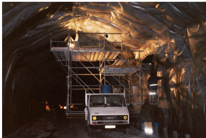
Pose de l'étanchéité du tunnel sur le fourgon échafaudage Placing the waterproofing of the tunnel on the scaffold van
