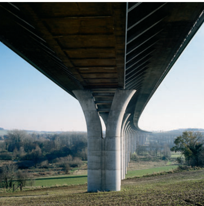
Photo 10 Vue d'ensemble de l'ouvrage terminé Overall view of completed structure
