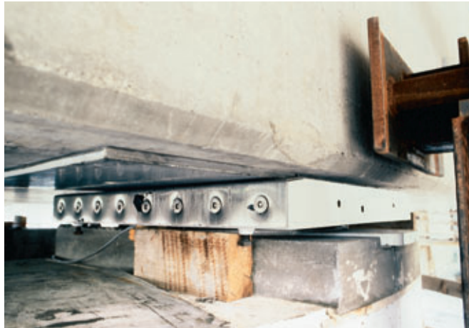
Appui provisoire type Freyssinet, plaque de glissement téflon Temporary Freyssinet-type bearing, Teflon sliding plate
