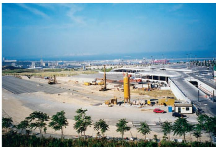
Forage de pieux autoforés à l'air en talus jusqu'à 55 m
