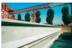
◆ Centrale EDF de Cattenom. Du béton de poudres réactives (BPR) pour le nucléaire
