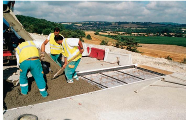
RN 141 - Déviation des Rassats-Favrauds. Bétonnage du joint lourd de type DG
