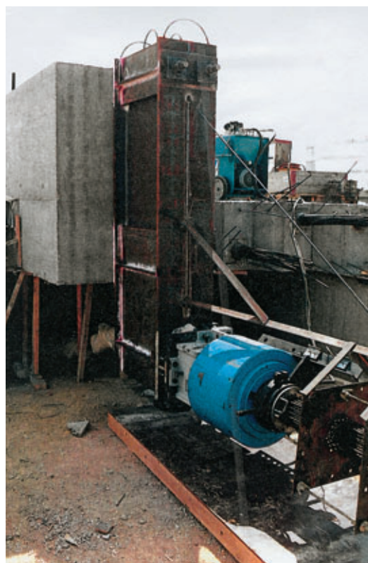
Photo 5 Bloc arrière de poussage et vérin Rear launching block and jack
