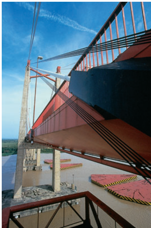
Photo 7 Torons auxiliaires et hauban endommagé avant dépose et remplacement
