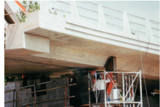
Photo 8 Tour d'étaie sur pile pour guidage latéral Support tower on pier for lateral guiding
