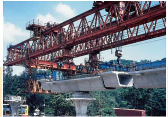
Photo 2 Pose des voussoirs préfabriqués avec la poutre de lancement Placing of precast segments with the launching beam
