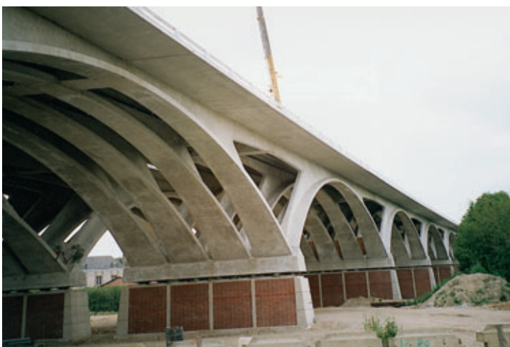
Vue générale du tablier achevé General view of completed deck
