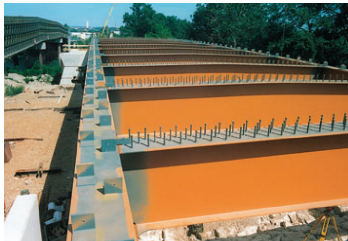
Photo 7 Types de connecteurs utilisés sur la travée d'accès Types of connectors used on the access section
