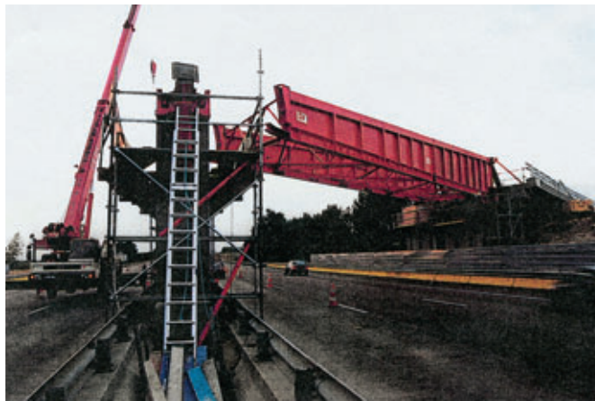
Photo 8 Tour d'étaie sur pile pour guidage latéral Support tower on pier for lateral guiding
