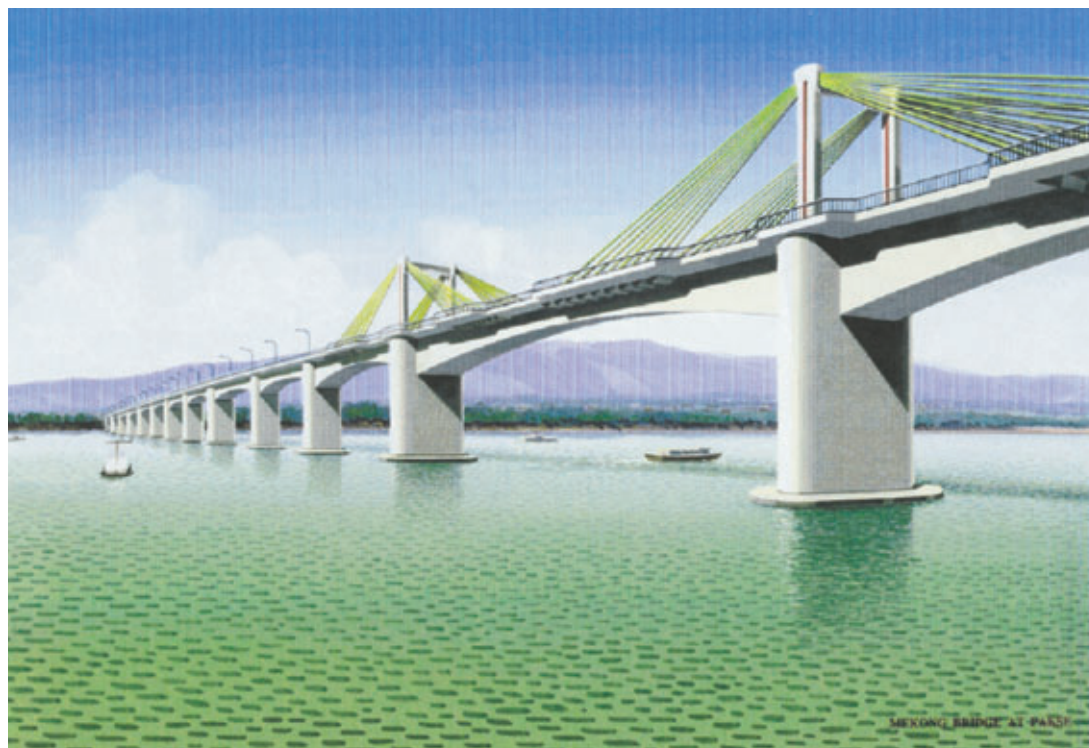
Photo 3 Maquette générale avec la partie centrale haubanée
