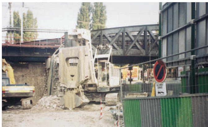
Photo 3 Outil à flèche courte pour la réalisation des barrettes sous tabliers auxiliaires Tool with short jib for making strips under auxiliary decks
