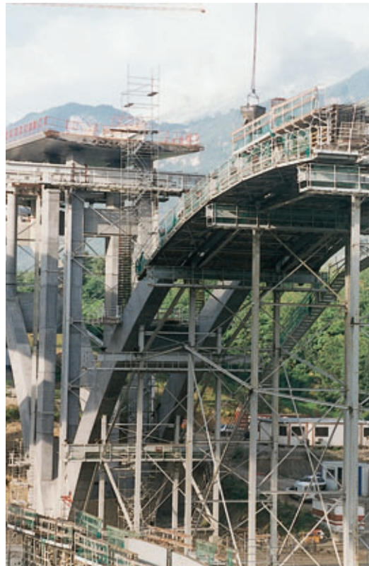
Photo 3 Etaieiment et équipage d'arc Arch bracing and shuttering
