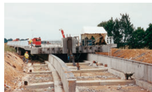
Photo 4 Longrines de poussage et tôles de glissement sur longrines Launching sills and slide plates on sills
