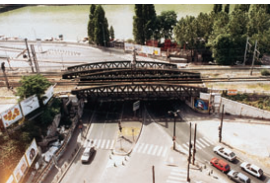
Photo 1 Ouvrage avant travaux Structure before works
