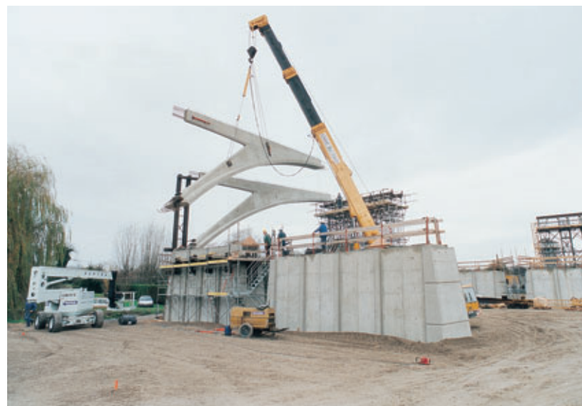
Pose des demi-arcs préfabriqués des travées courantes à l'aide d'une grue de 120 tonnes
