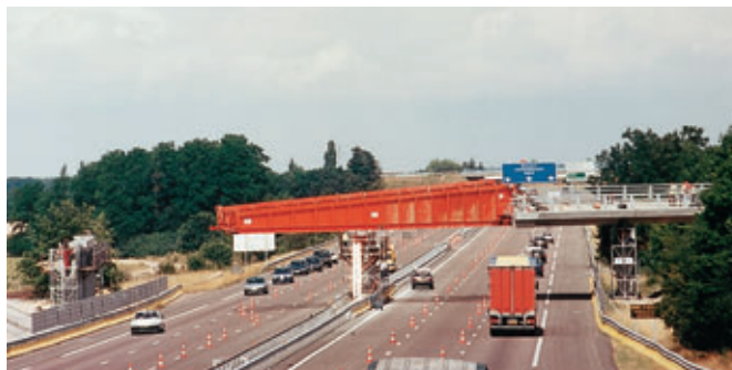
Photo 10 Poussage du tablier sous circulation Launching of deck under traffic
