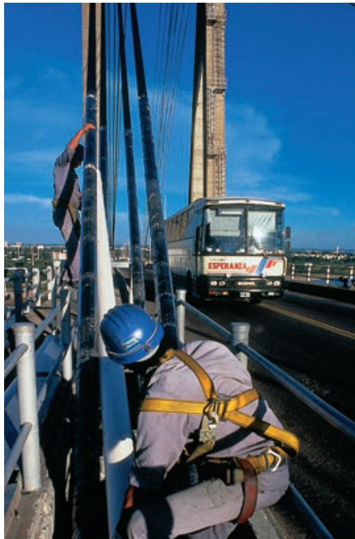
Photo 5 Trafic non interrompu pendant les travaux
