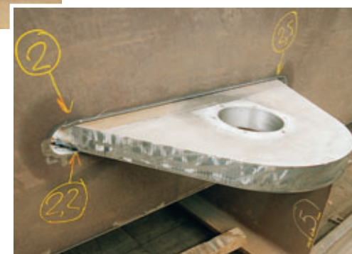
Photos 2 et 3 Détails de l'oreille d'ancrage des suspentes Details of suspender anchoring lug
