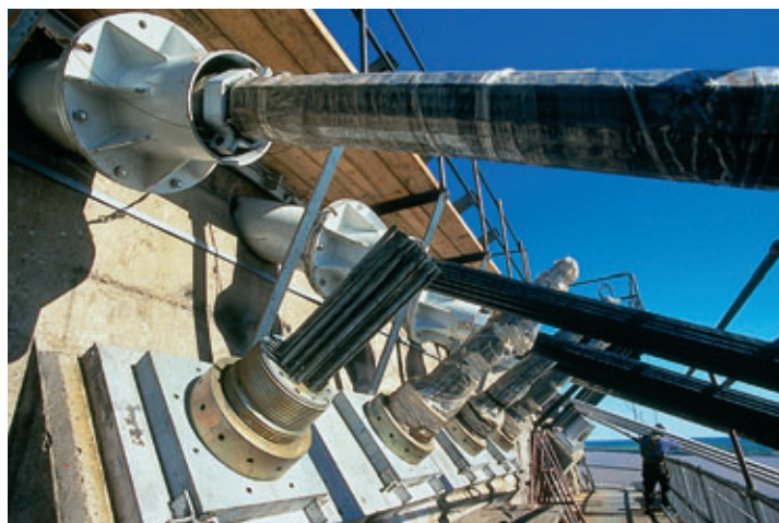
Photo 4 Haubans auxiliaires en tête de pylône Temporary stay in top of tower
