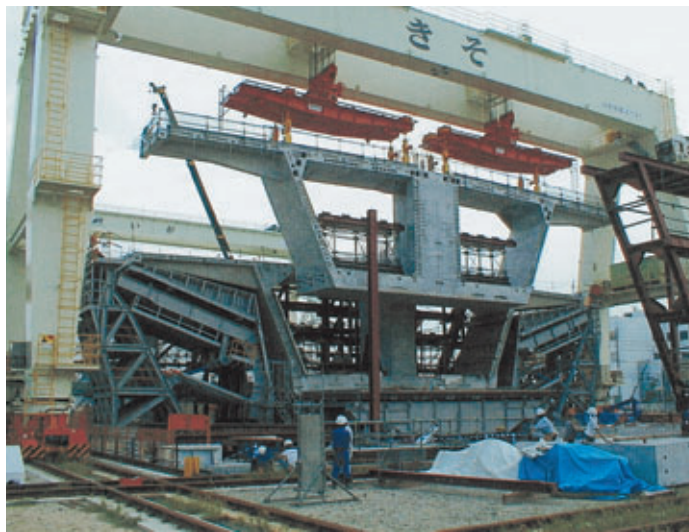
Photo 3 Préfabrication des voussoirs sur pile Precasting of pier segments
