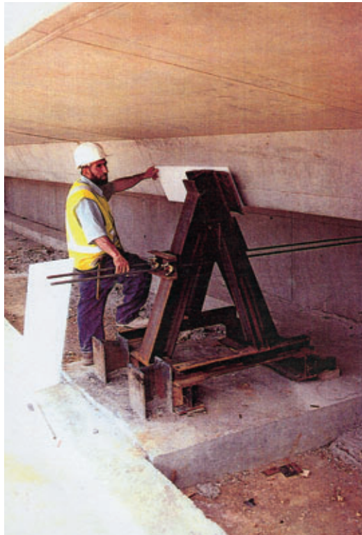
Photo 7 Guidage latéral sur longrines de poussage Lateral guiding on launching sills
