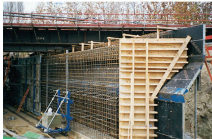
Photo 4 Outil de coffrage Shuttering tool
