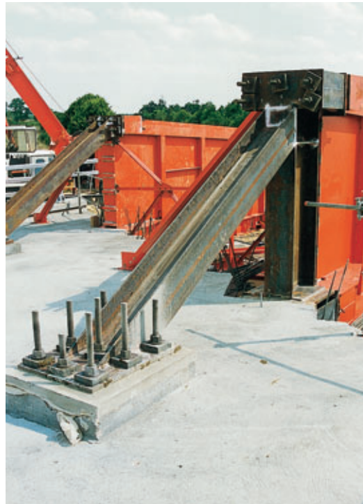
Photo 1 Fixation de l'avant-bec sur le tablier Attachment of cutwater on deck
