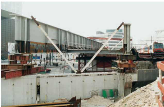
Photo 5 Tablier deux voies en cours de montage
