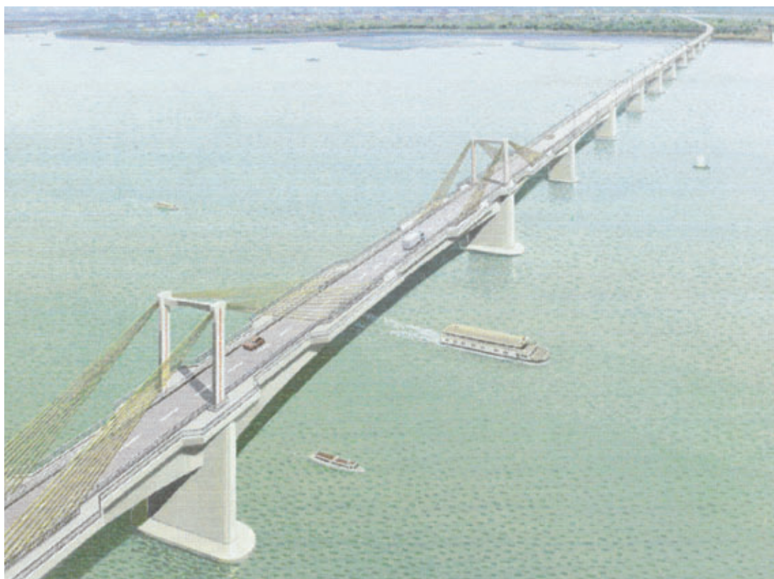
Photo 1 Vue générale de l'ouvrage General view of structure
