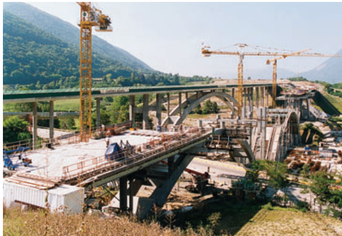
Photo 1 Vue générale. Au premier plan : le viaduc Ouest du Crozet, au second plan le viaduc Est General view. In foreground : the Crozet west viaduct ; in background, the east viaduct
