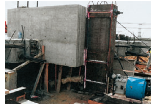
Photo 2 Bloc de poussage arrière Rear launching block
