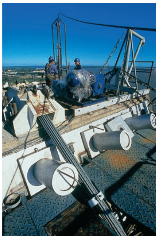
Photo 4 Haubans auxiliaires en tête de pylône Temporary stay in top of tower
