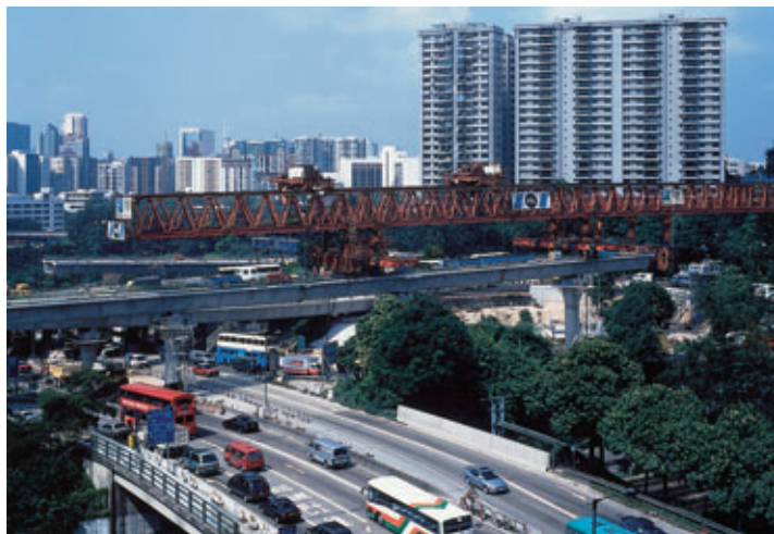
Photo 1 Vue générale du pont en cours de construction General view of bridge during construction
