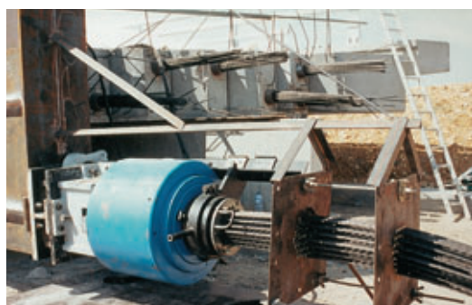
Photo 6 Vérin de poussage et câble Launching jack and cable
