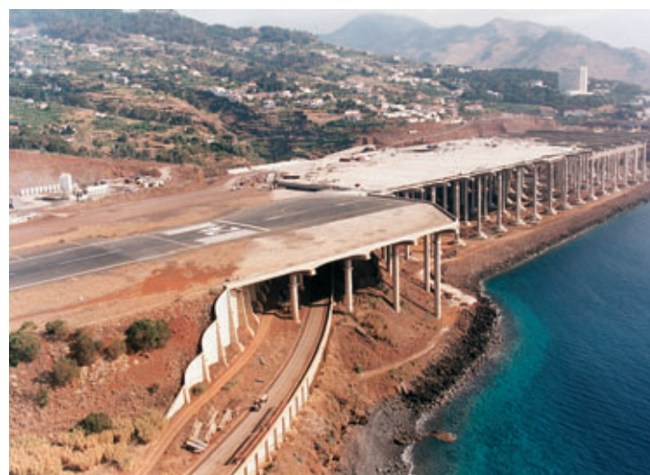
Photo 2 Vue de la jonction entre la structure existante et la nouvelle View of junction between existing and new structure
