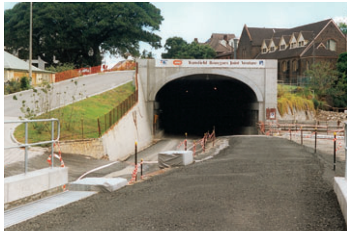
Photo 1 Portail du tunnel au Prince Albert Park. Connection nord entre le NSR et le système de chemin de fer existant, en attente de mise en œuvre du ballast
