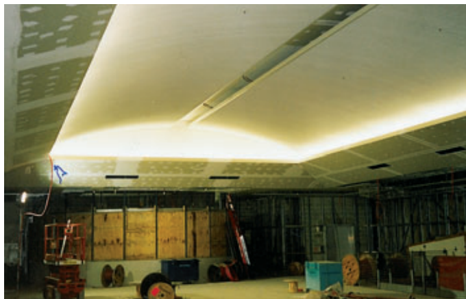
Photo 9 Station Terminal International. Niveau hall, installation des plafonds architecturaux, des panneaux de mur et de l'éclairage
