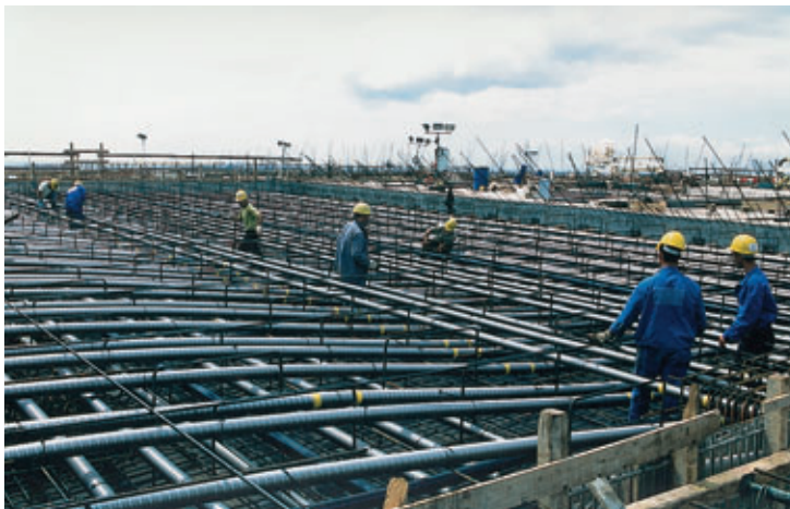
Photo 7 Pose des gaines de précontrainte transversale et longitudinale sur la dalle
