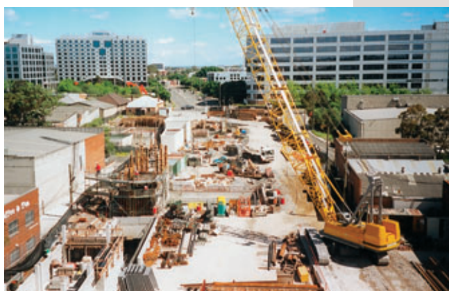
Photo 12 Station Mascot. Vue du chantier encombré par les immeubles existants et les approvisionnements réservés au tunnelier
