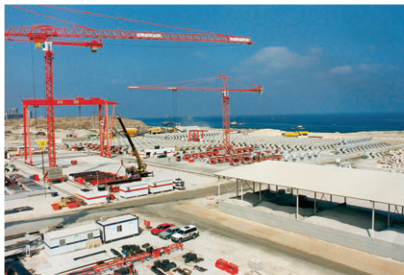
Photo 2 Les installations de chantier Job-site installations
