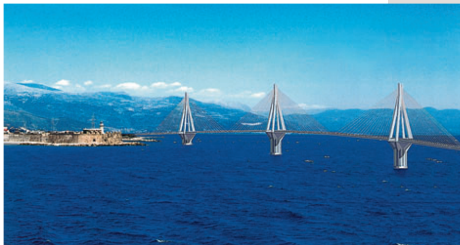
Photomontage de l'ouvrage réalisé
