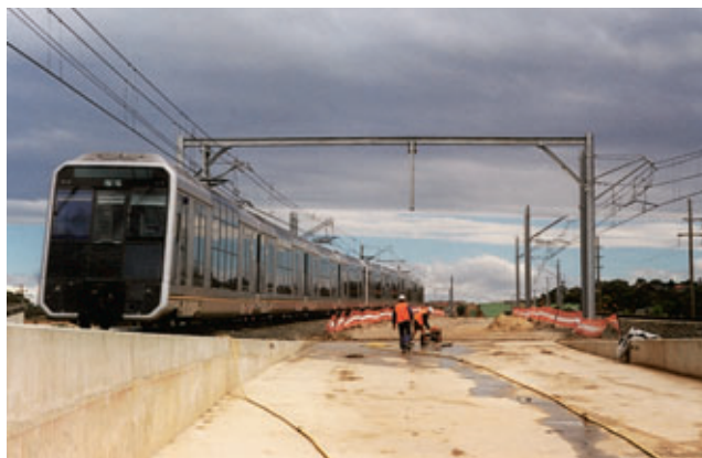
Photo 6 Rampe de East Hills. Extrémité de la structure béton proche des lignes existantes
