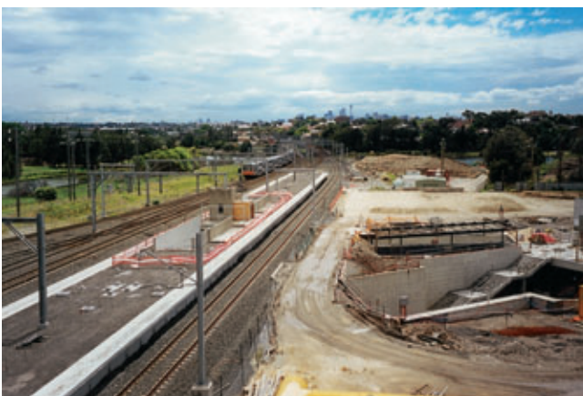
Photo 4 Station d'interconnection de Wollri Creek. Ligne d'Illawarra avec le cadre enterré des quais du NSR en dessous
