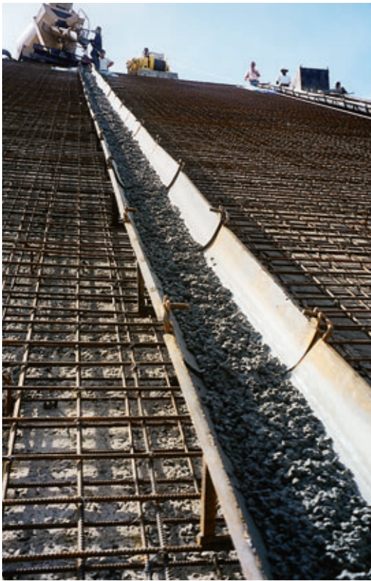
Photo 3 Bétonnage par goulottes Concreting by use of chutes
