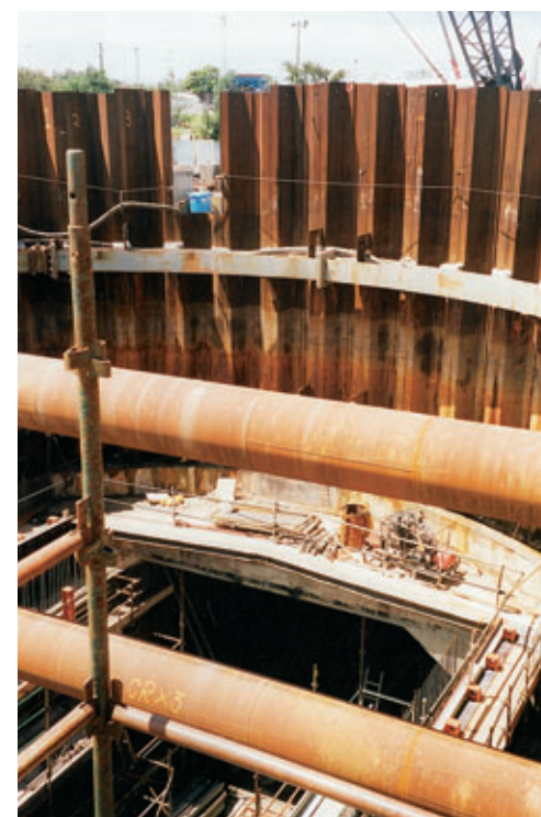
Photo 8 Traversée de Cooks River. Travaux de tunnel dans les batardeaux circulaires
