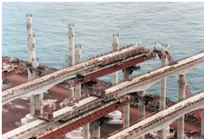
Photo 3 Exécution des poutres-portiques : vue des cintres auto-lanceurs
