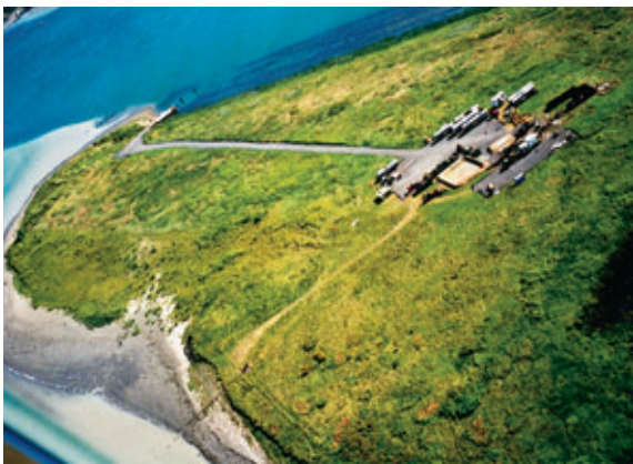
Installation des équipements de forage dirigé sur l'île aux Fermiers
