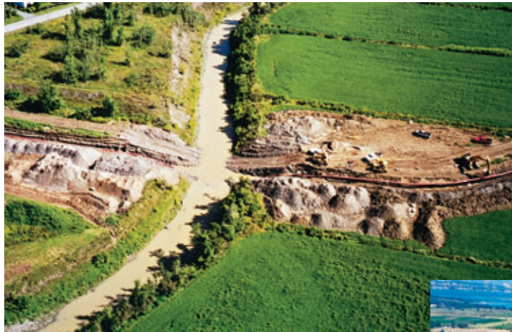
Traversée de la rivière des Hurons à ciel ouvert Crossing the Hurons river in the open
