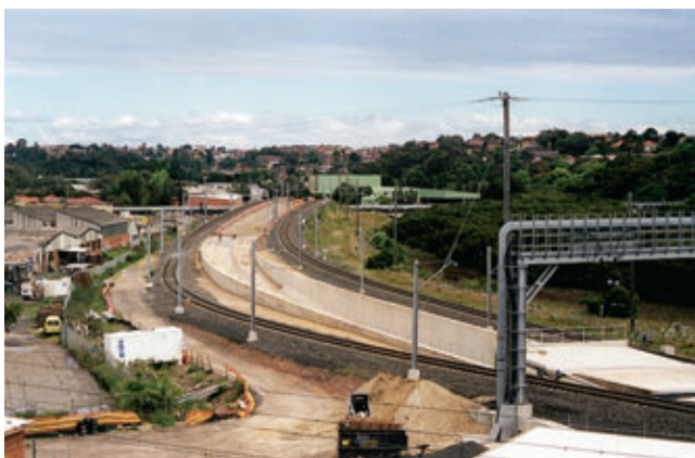
Photo 5 Rampe de East Hills. Connection sud entre le NSR et le système existant. Le NSR émerge de dessous des lignes d'Illawarra
