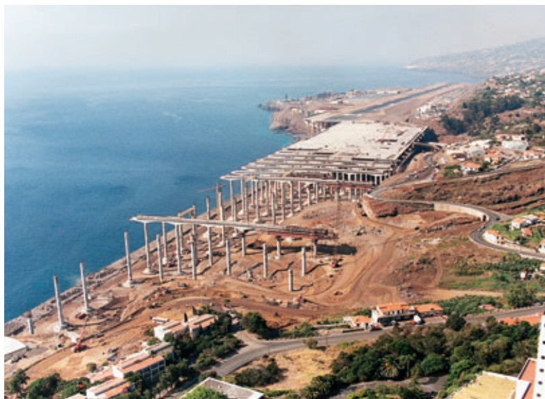
Photo 1 Vue générale en cours de travaux General view of works in progress
