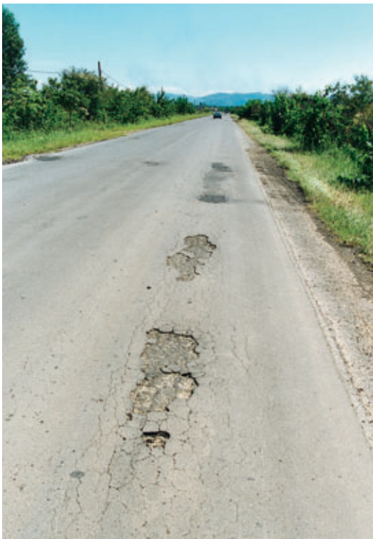
Photo 2 Pelade (enrobés coulés à froid sur grave non traitée) Peeling (slurry surfacing systems over untreated granular material)
