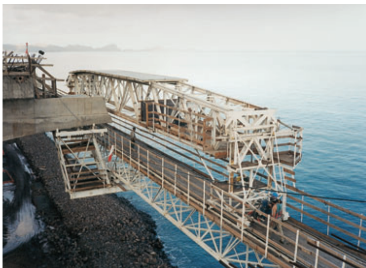
Photo 6 Transfert d'un élément de cintre coffrant entre deux travées
