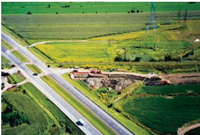
Traversée d'une autoroute par forage horizontal
