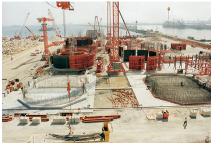
Photo 4 Ligne de préfabrication des caissons Caisson prefabrication line
