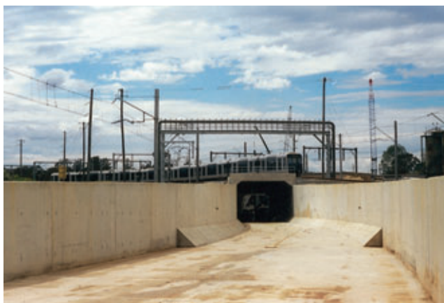
Photo 7 Rampe de East Hills. Le tunnel émerge de dessous des lignes d'Illawarra
