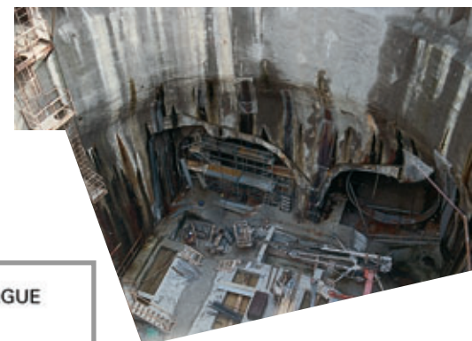
Photo 2 Vue du fond du puits Havnegade View of Havnegade excavation
