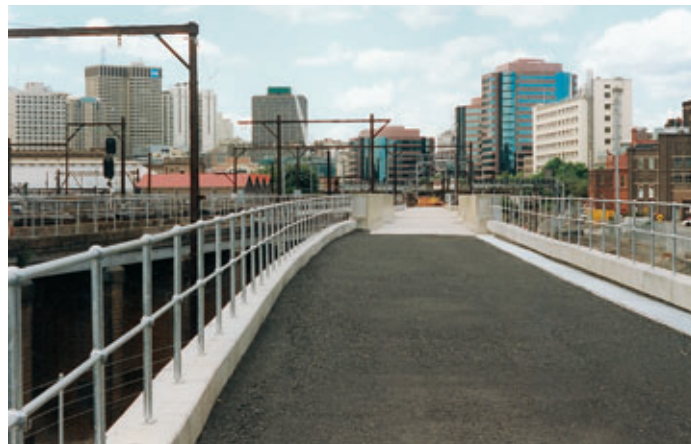
Photo 2 Central Junction. Connection entre le NSR et le système existant
