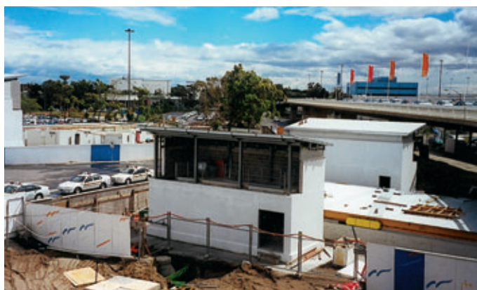
Photo 10 Station Terminal International. Structure externe contenant les machines et la chambre des moteurs d'ascenseurs
