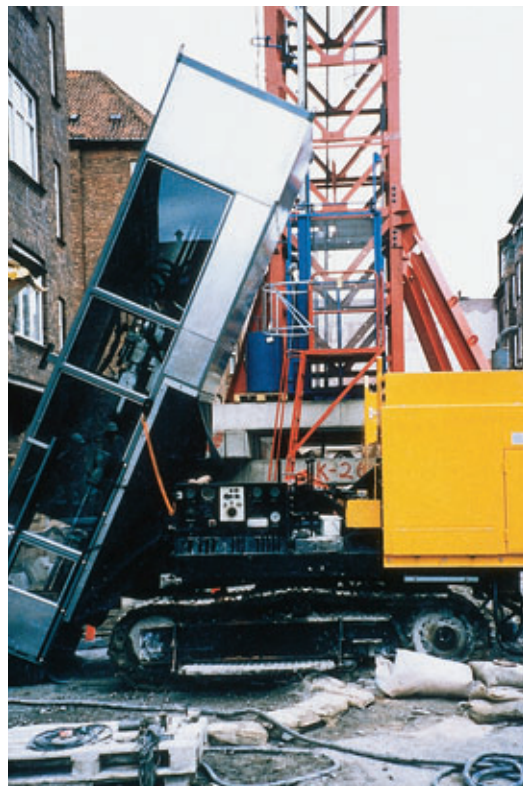
Photo 8 Capotage d'une foreuse pour injections
