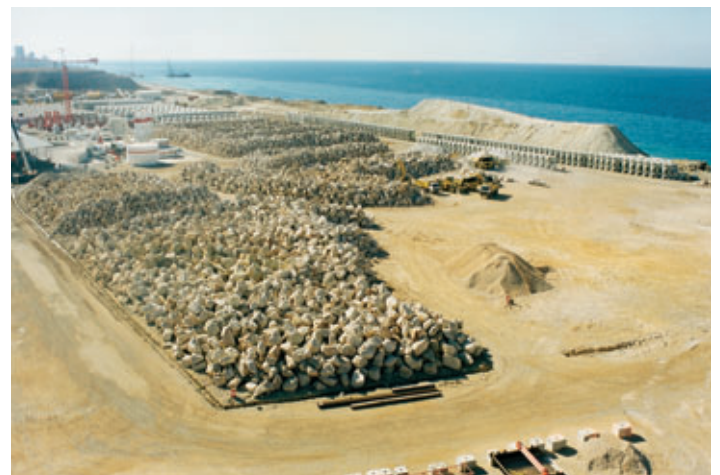
Photo 10 Stockage des enrochements Stocking of rip-rap
