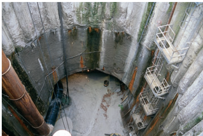
Photo 5 Puits Stadsgraven Stadsgraven shaft
