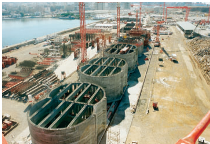
Photo 3 Ligne de préfabrication des caissons Caisson prefabrication line
