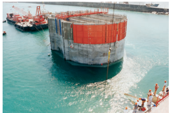
Photo 8 Mise à l'eau du premier caisson Sinking of first caisson
