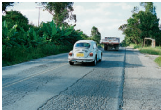
Photo 1 Faïençage généralisé par bandes (de construction) General phasing in strips (construction)
