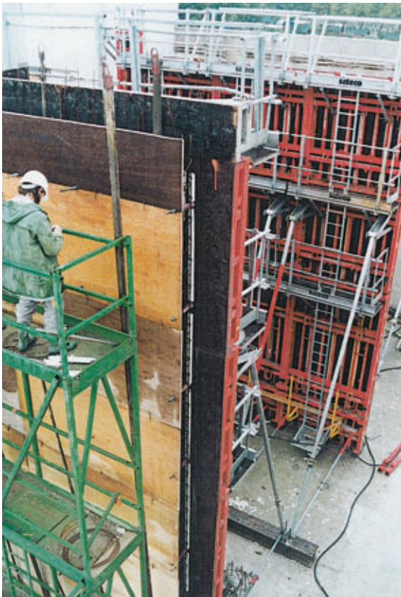
Photo 10 Elévation d'un double voile. Mise en place des profilés écarteurs avant le ferrailage de la deuxième nappe
