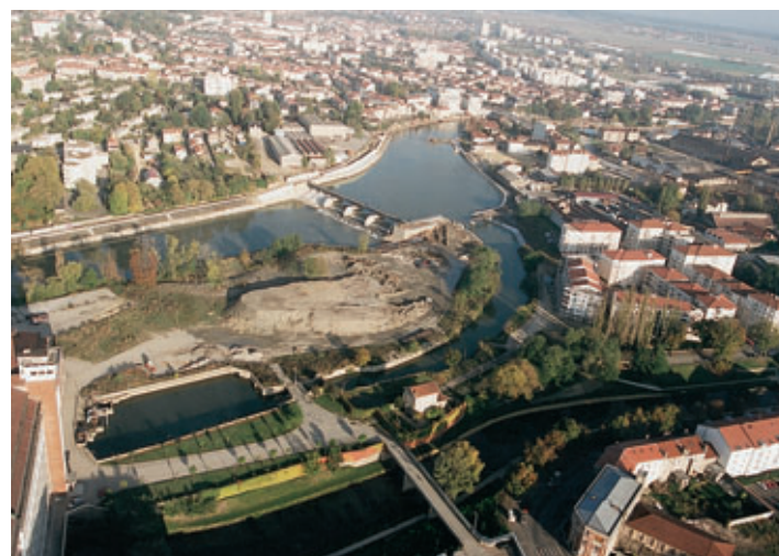
Photo 1 Le nouveau barrage inscrit dans son environnement urbain
