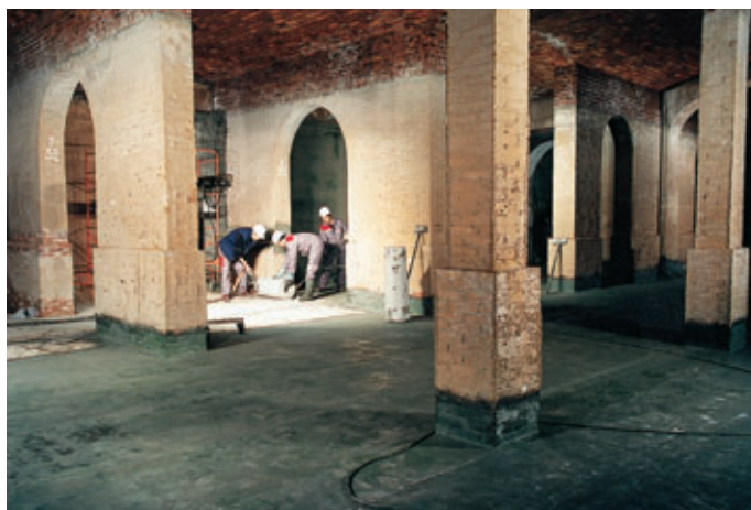
Photo 4 Application du produit d'étanchéité (K2)
