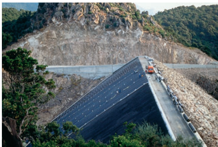
Photo 1 Vue générale du barrage. Etanchéité amont en cours de pose
