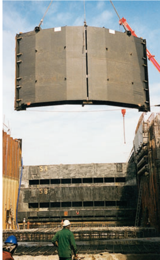
Photo 4 Mise en œuvre des deux vantaux de la porte busquée pré-réglée sur un gabarit durant la période de "chômage" Installation of the two leaves of the mitred door pre-adjusted on a gauge during the "idle" period
