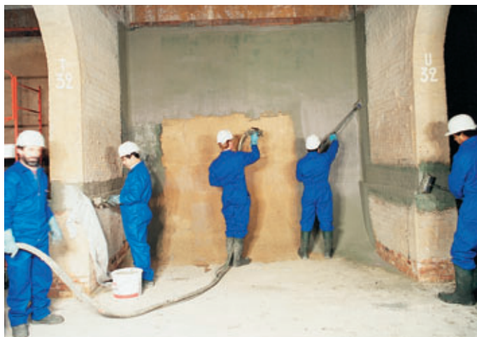
Photo 5 Application du produit d'étanchéité (K2)
