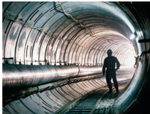
Vue intérieure de l'ouvrage en phase creusement avant la mise en place du revêtement définitif
