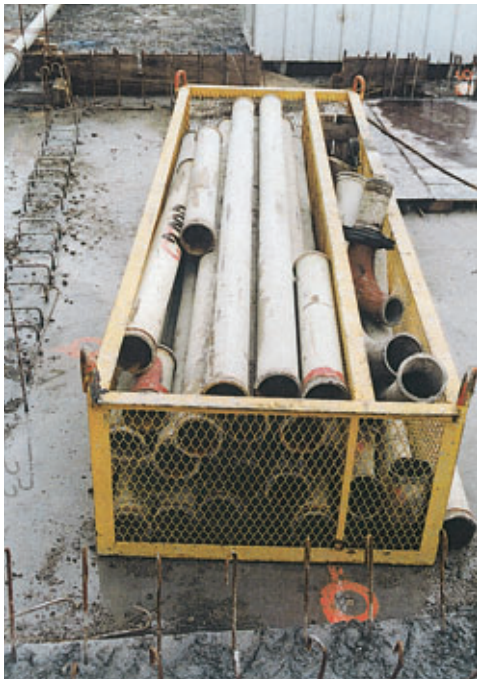
Photo 3 Panier de manutention des tuyauteries avec ses trois compartiments : tuyaux droits, coudés, colliers et joints Pipe handling basket with its three compartments : straight pipes, elbows, clamps and joints
