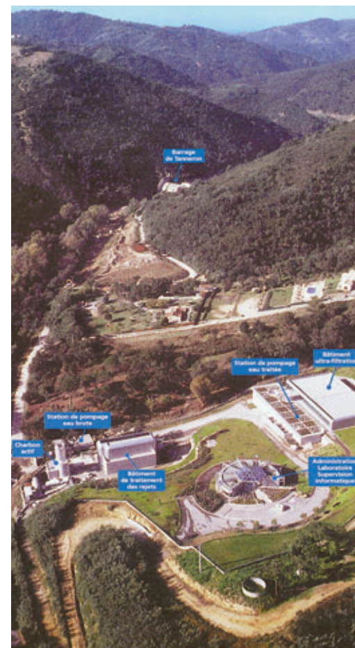
Figure 1 Usine de l'Apié et barrage de Tanneron Apié plant and Tanneron dam
