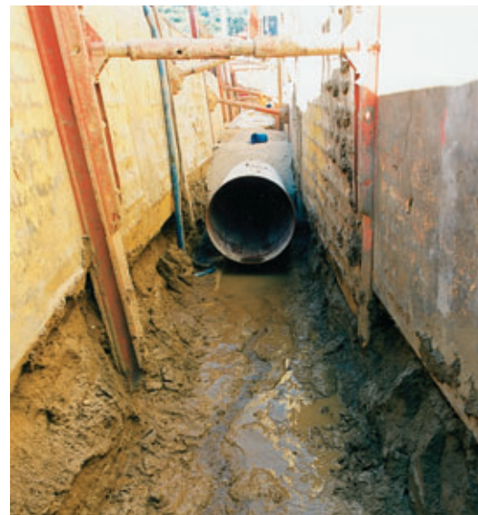
Photo 2 Blindage par havage Sheathing and trenching
