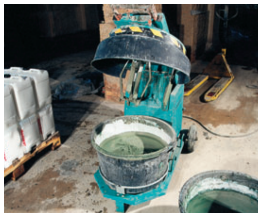
Photo 3 Malaxage du produit d'étanchéité (K2)
