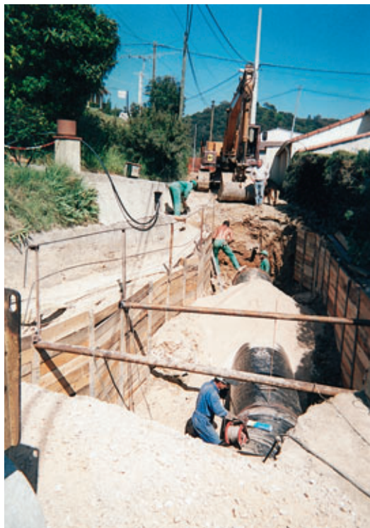
Photo 1 Réalisation des berlinoises Berlin-type structures
