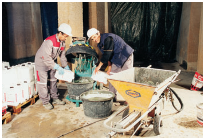
Photo 2 Préparation du produit d'étanchéité (K2)
