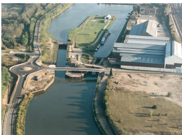
Photo 5 L'écluse de Clévant dans sa configuration actuelle constitue une nouvelle porte qui permet aux convois poussés de 3 000 t et aux automoteurs rhénans de 110 m de long d'accéder au port de Nancy-Frouard
