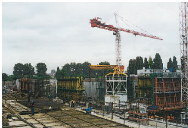
Photo 5 Le mât M22 positionné pour pouvoir bétonner trois voiles sans être déplacé The M22 mast positioned to be able to pour concrete for three load-bearing walls without being moved
