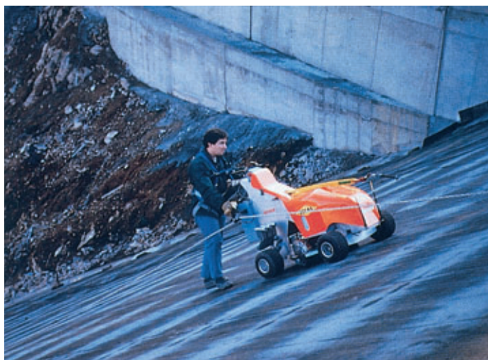
Photo 6 Contrôle automatique des joints par la machine à ultrasons
