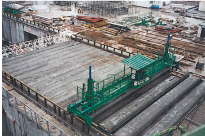
Photo 6 En cours de pose, la passerelle de finitions fait fonction de garde-corps pour la dernière dalle posée
