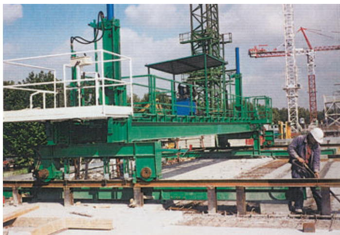
Photo 7 Le portique de pose sur son chemin de roulement
