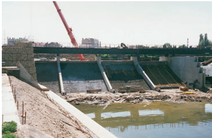
Photo 6 Le seuil fixe pendant sa construction
