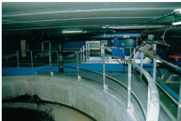
Dessableur - Déshuileur Sand traps and oil traps
