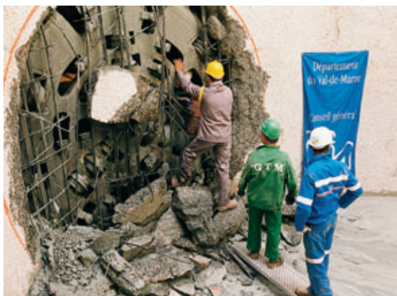
Arrivée du tunnelier dans le puits 17 Arrival of tunnel boring machine in shaft 17
