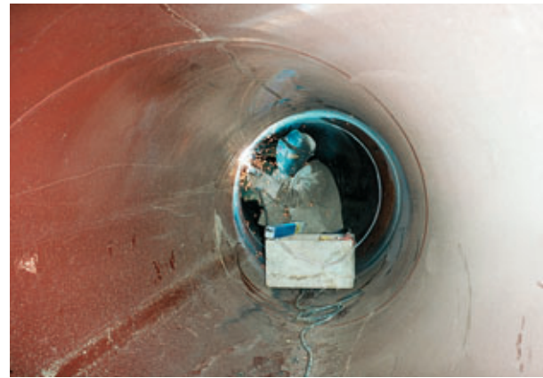
Soudure intérieure sur diamètre 1100 Internal welding on 1,100-mm diameter
