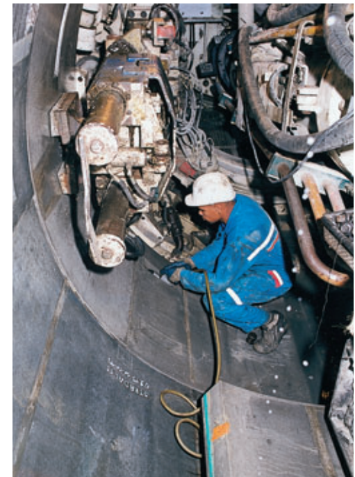
La pose des voussoirs
