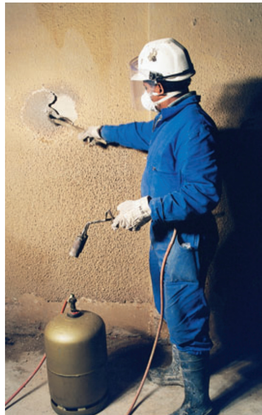
Photo 1 Décapage de la calcite Stripping of calcite
