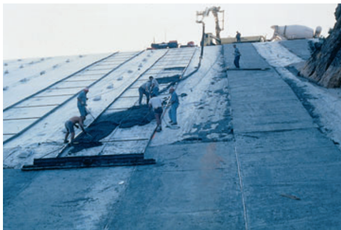
Photo 3 Mise en œuvre du béton
