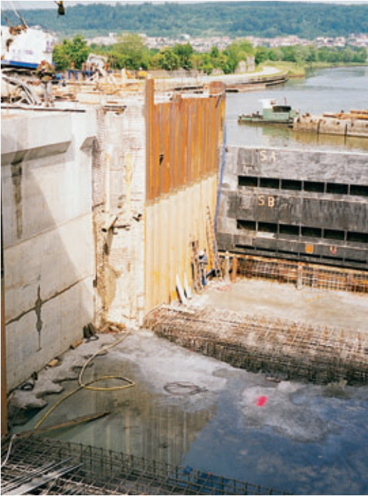
Photo 3 Réalisation du radier durant la période de "chômage" et après mise à sec du sas Construction of foundation during the "idle" period and after dewatering the lock
