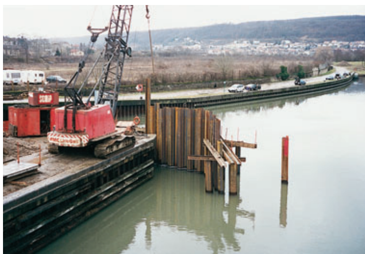
Photo 2 Rive gauche. Mise en œuvre des palplanches en eau Left bank. Placing sheet piles in the water
