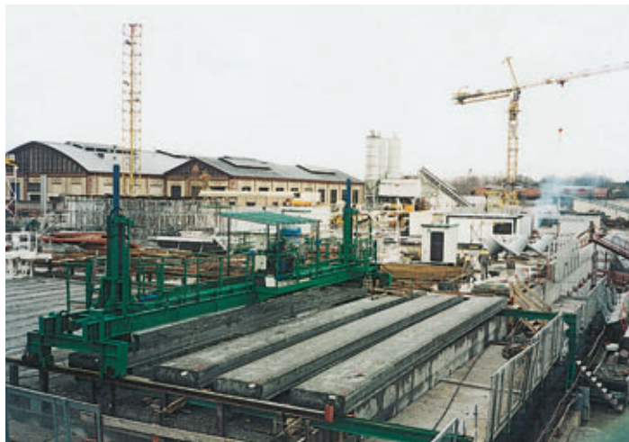
Photo 8 Le râtelier de stockage des dalles et le portique en cours d'approvisionnement
