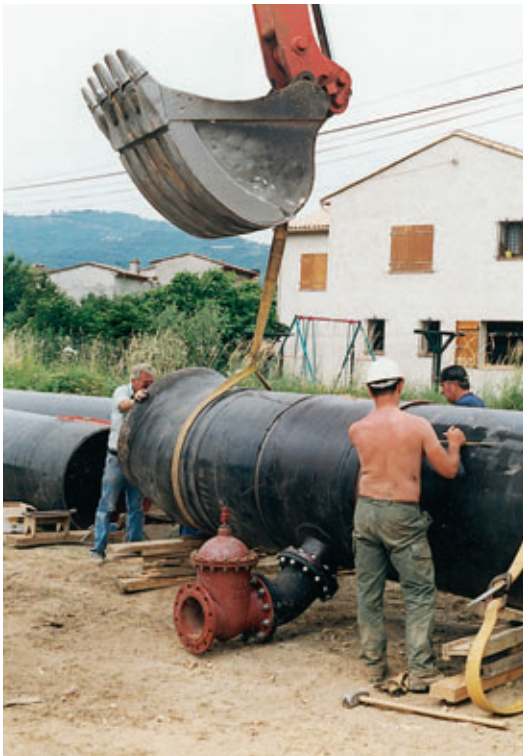
Pose de coude sur conduite de diamètre 1100 Placing a 1,100-mm diameter pipe elbow
