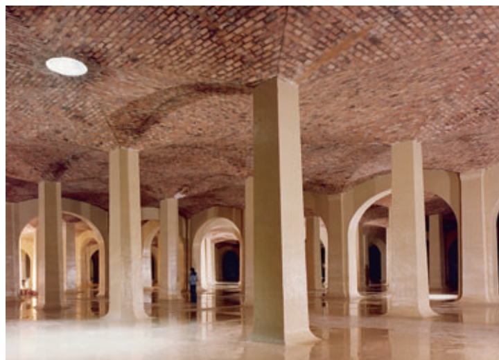
Photo 1 Le réservoir de Ménilmontant construit en 1865 Ménilmontant reservoir built in 1865
