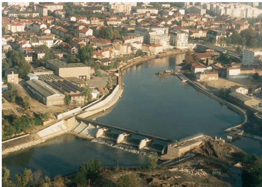
Photo 7 Après démolition de l'ancien barrage et la suppression de la corne des Tricoteries, le plan d'eau créé par le nouvel ouvrage et l'aménagement des berges forment un ensemble revalorisant pour les quartiers environnants. En arrière plan, travaux d'enlèvement du seuil fixe provisoire en limite amont du chantier
