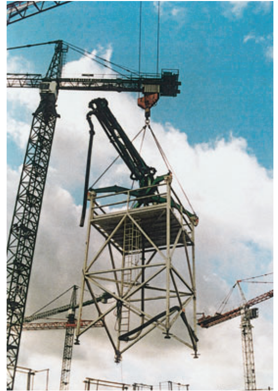
Photo 2 Déplacement d'un Cicmat 3.14 avec sa tour de bétonnage Moving a Cicmat 3.14 with its concreting tower
