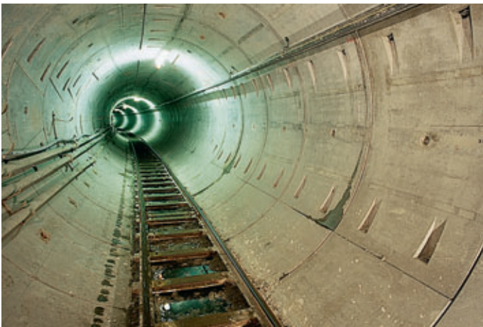
Photo 9 Galerie avec le revêtement terminé
