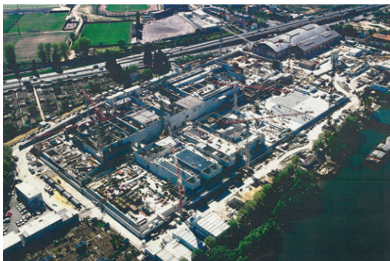
Photo 1 Vue aérienne du chantier Aerial view of the site
