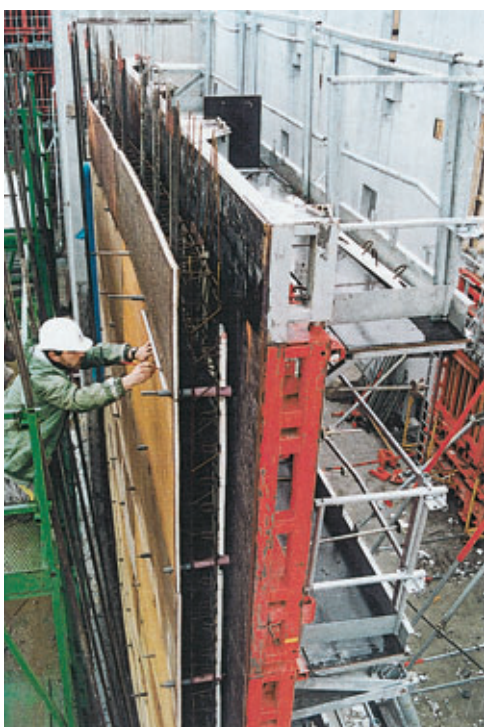
Photo 9 Double voile en phase d'exécution Double load-bearing wall during the works
