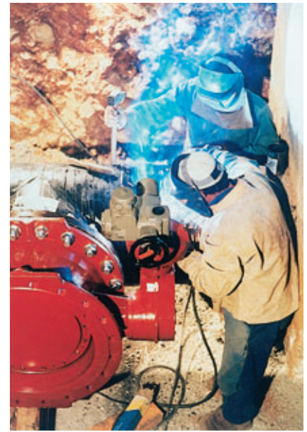
Réalisation de raccordement dans une chambre de vannes Making a connection in a valve chamber
