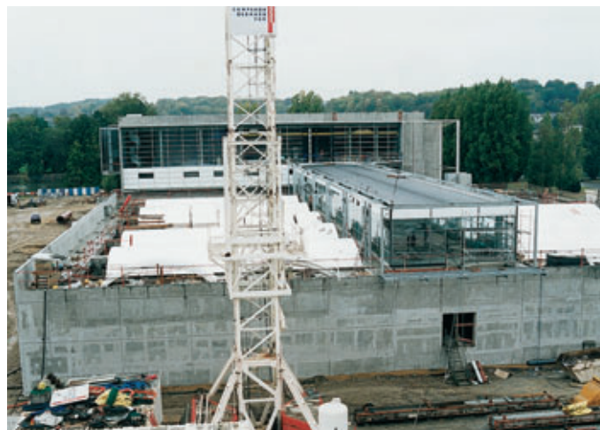
Photo 2 Extension tranche 1. Bâtiment des filtres (couverture en coque polyester)
