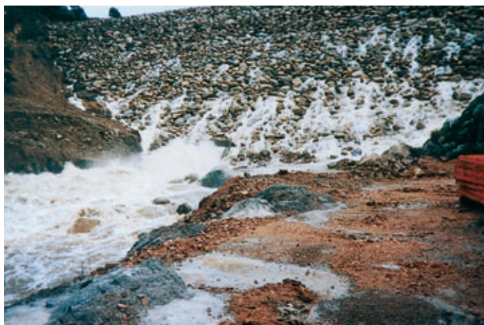
Photo 5 Crue de chantier. Résurgences et bouillonnement sur le parement aval
