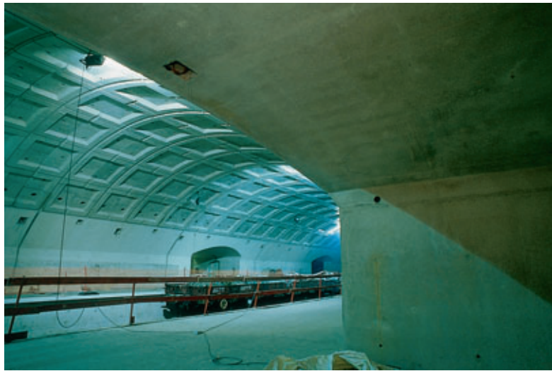
Photo 6 Vue du tunnel central depuis une loge
