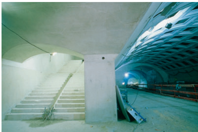
Photo 4 Départ d'escalier fixe depuis une loge Fixed stairway from a lodge
