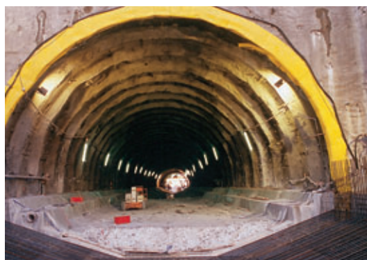
Photo 1 Avant-plan : réalisation de la contre-voûte et des banquettes
