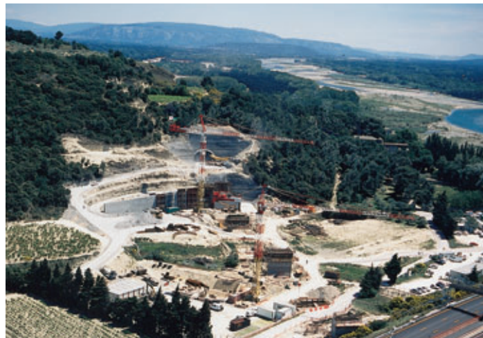
Photo 3 Vue aérienne de l'entrée en souterrain Aerial view of entrance underground
