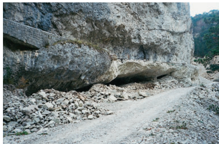
Photo 1 RD 148 après l'éboulement Highway RD 148 after the landslide
