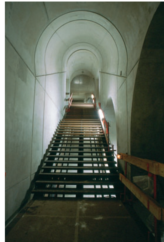
Photo 9 Galerie Demarquay - Escalier latéral nord
