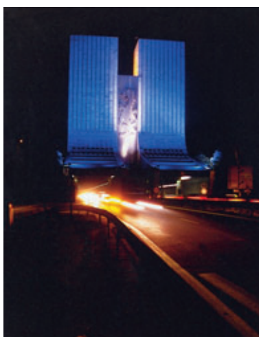
Photo 1 Tunnel sous Fourvière Fourvière tunnel
