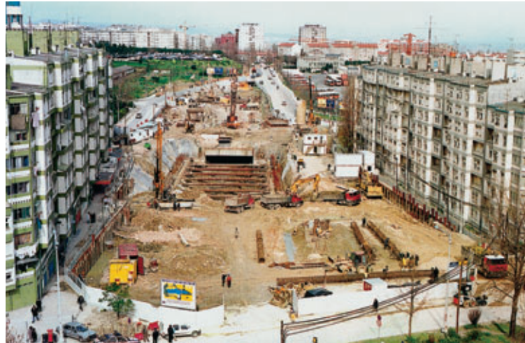
Photo 1 Station Chelas construite entre deux rangées d'immeubles
