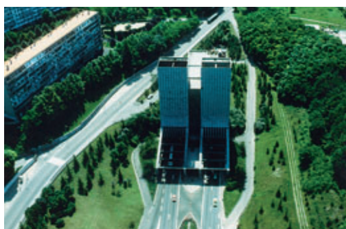
Photo 2 Tunnel sous Fourvière, tête Saône Fourvière tunnel, Saône head
