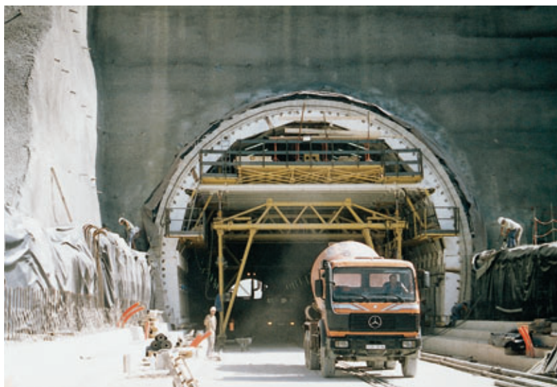
Photo 5 Revêtement définitif du tunnel plot 1
