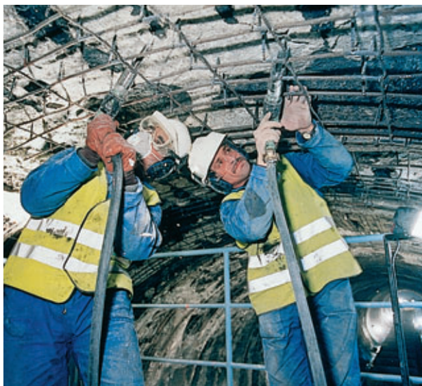
Piquage du béton Chipping of concrete
