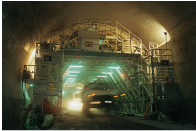
Photo 7 Coffrage de la voûte Shuttering for the crown
