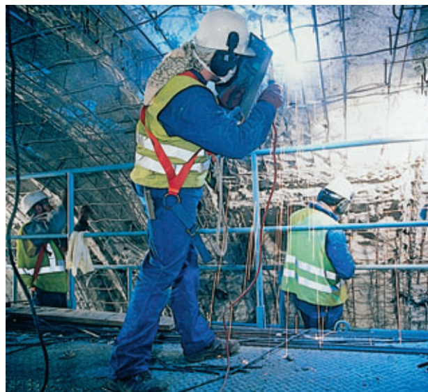
Soudure des croisements de barres
