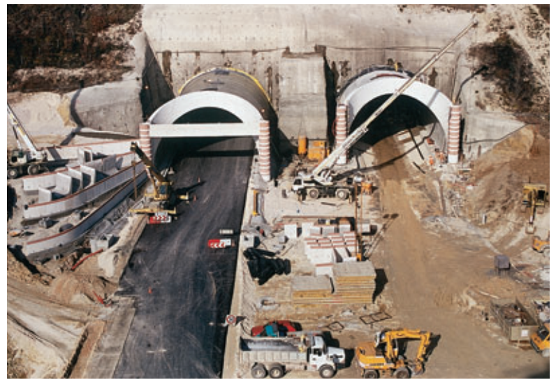
Photo 2 Têtes sud en cours de réalisation South heads under construction
