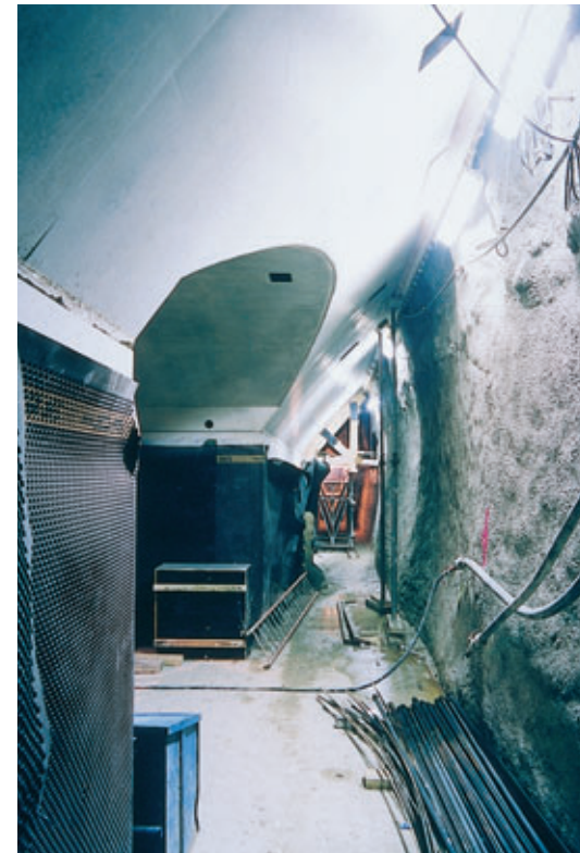
Photo 8 Culée centrale coulée en galerie souterraine
