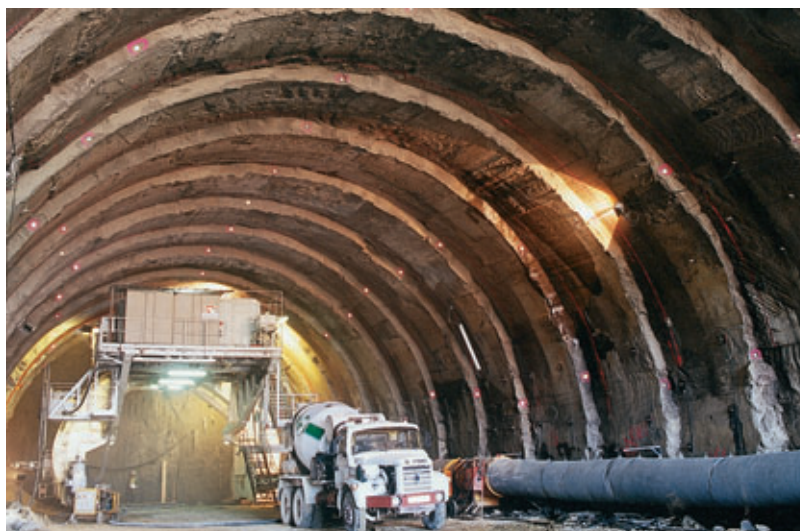
Photo 4 Tube Est en cours d'excavation East tube during excavation
