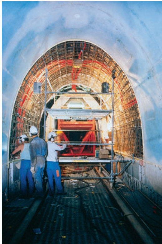
Photo 7 Bétonnage d'un déambuloire à l'aide d'un coffrage-outil
