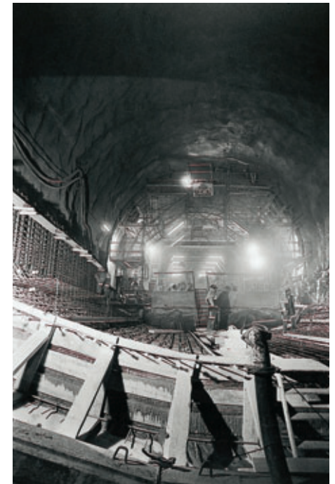
Photo 9 Bétonnage du radier incurvé dans la zone anhydrite Concreting the invert in the anhydrite zone
