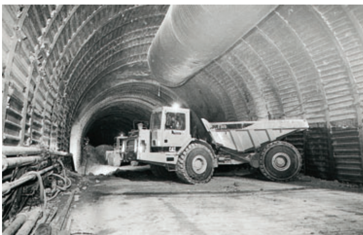
Photo 4 Opérations de marouflage. Dumper D30 en manœuvre de demi-tour
