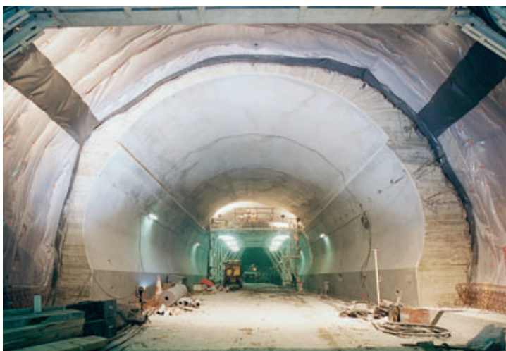
Photo 6 Vue du revêtement View of lining
